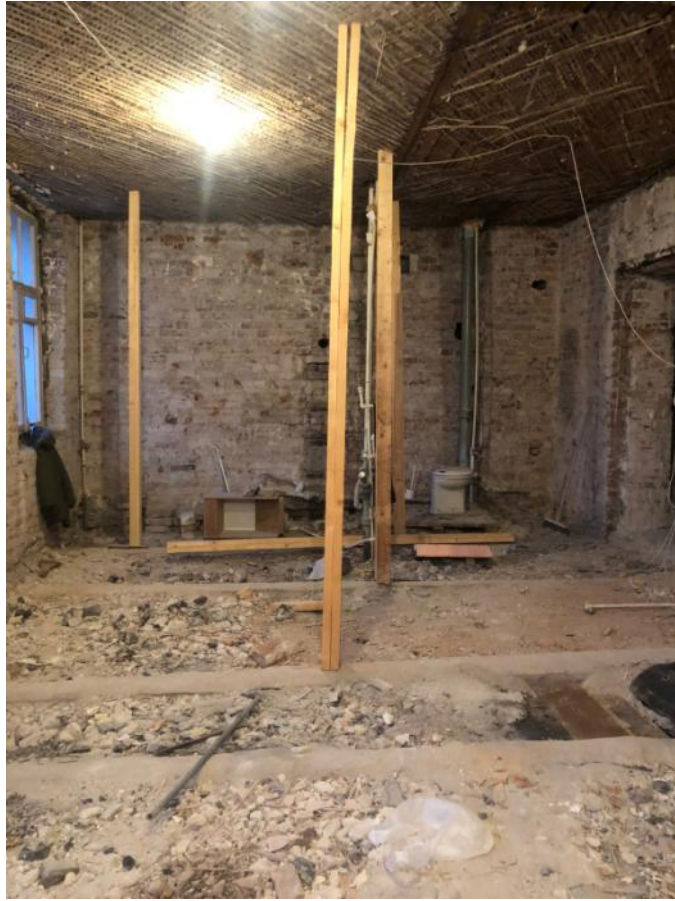
Фото 5 Интерьер квартиры № 300 объекта культурного наследия регионального значения «Жилой дом», расположенного по адресу: Санкт-Петербург, Диагональная улица, дом 8, лит. Е (Диагональная ул., 8, лит. Е), входящего в состав объекта культурного наследия регионального значения «Жилой комплекс Товарищества борьбы с жилищной нуждой («Выборгский рабочий городок»)
