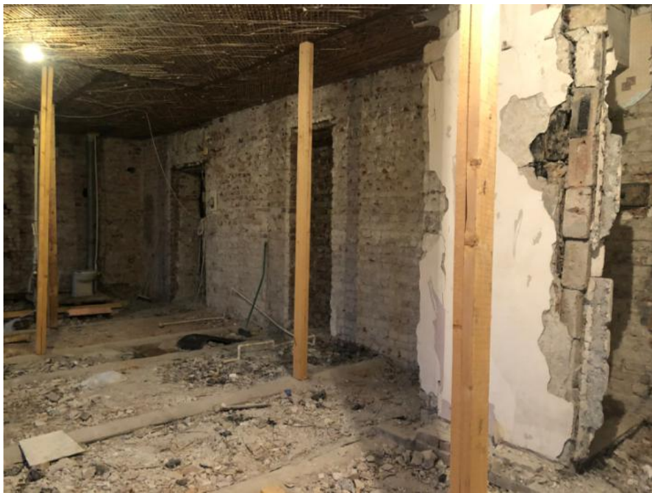
Фото 6 Интерьер квартиры № 300 объекта культурного наследия регионального значения «Жилой дом», расположенного по адресу: Санкт-Петербург, Диагональная улица, дом 8, лит. Е (Диагональная ул., 8, лит. Е), входящего в состав объекта культурного наследия регионального значения «Жилой комплекс Товарищества борьбы с жилищной нуждой («Выборгский рабочий городок»)
