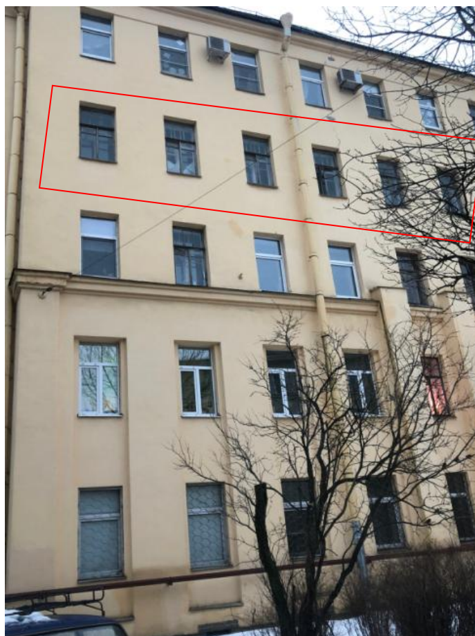
Фото 2 Фрагмент фасада объекта культурного наследия регионального значения «Жилой дом», расположенного по адресу: Санкт-Петербург, Диагональная улица, дом 8, лит. Е (Диагональная ул., 8, лит. Е), входящего в состав объекта культурного наследия регионального значения «Жилой комплекс Товарищества борьбы с жилищной нуждой («Выборгский рабочий городок»)), окна квартиры №300
