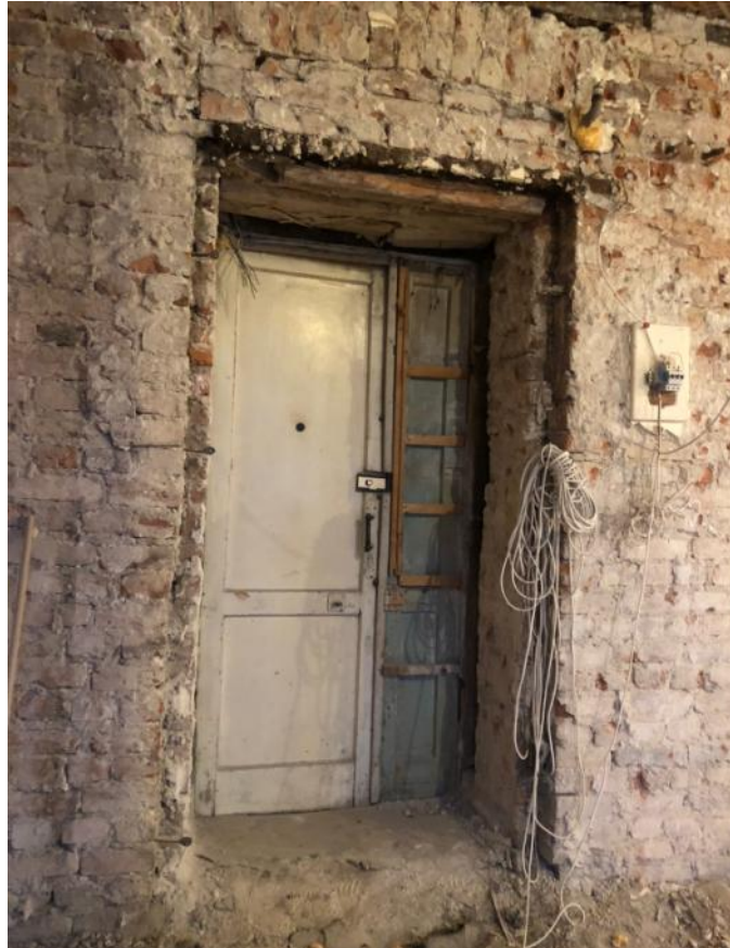
Фото 4 Интерьер квартиры № 300 объекта культурного наследия регионального значения «Жилой дом», расположенного по адресу: Санкт-Петербург, Диагональная улица, дом 8, лит. Е (Диагональная ул., 8, лит. Е), входящего в состав объекта культурного наследия регионального значения «Жилой комплекс Товарищества борьбы с жилищной нуждой («Выборгский рабочий городок»)»
