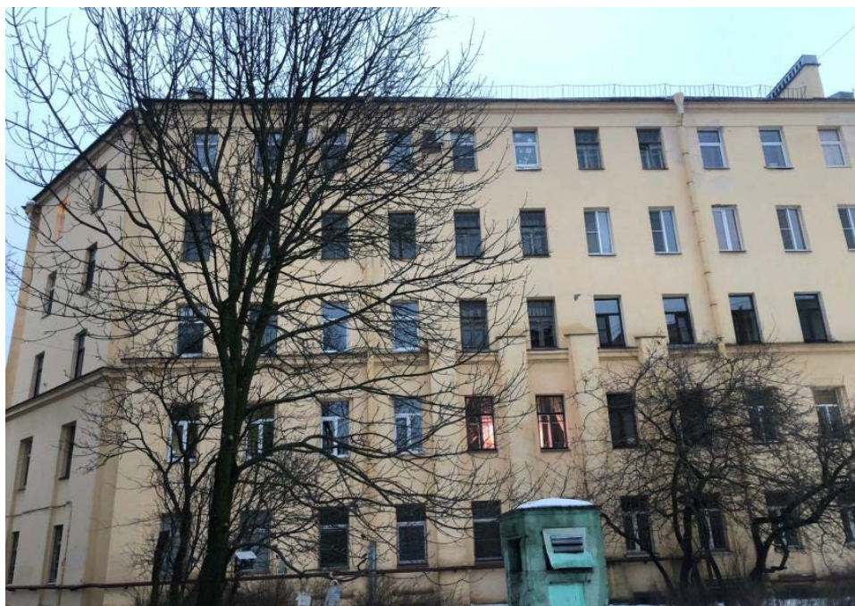
Фото 1 Фрагмент фасада объекта культурного наследия регионального значения «Жилой дом», расположенного по адресу: Санкт-Петербург, Диагональная улица, дом 8, лит. Е (Диагональная ул., 8, лит. Е), входящего в состав объекта культурного наследия регионального значения «Жилой комплекс Товарищества борьбы с жилищной нуждой («Выборгский рабочий городок»)
