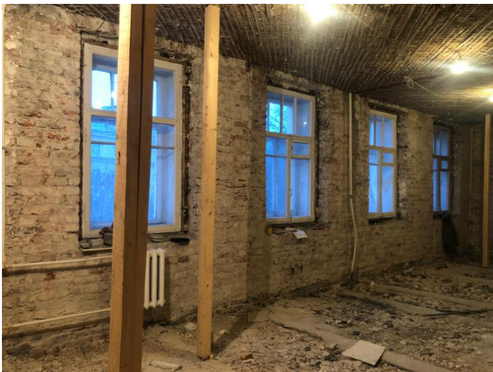
Фото 9 Интерьер квартиры № 300 объекта культурного наследия регионального значения «Жилой дом», расположенного по адресу: Санкт-Петербург, Диагональная улица, дом 8, лит. Е (Диагональная ул., 8, лит. Е), входящего в состав объекта культурного наследия регионального значения «Жилой комплекс Товарищества борьбы с жилищной нуждой («Выборгский рабочий городок»)»
