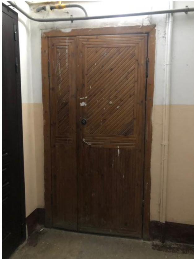
Фото 3 Интерьер квартиры № 300 объекта культурного наследия регионального значения «Жилой дом», расположенного по адресу: Санкт-Петербург, Диагональная улица, дом 8, лит. Е (Диагональная ул., 8, лит. Е), входящего в состав объекта культурного наследия регионального значения «Жилой комплекс Товарищества борьбы с жилищной нуждой («Выборгский рабочий городок»)», вид со стороны лестничной клетки
