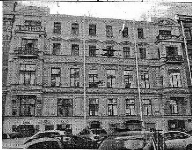
Общий вид выявленного объекта культурного наследия «Дом Н.К. Бороздина» со стороны Малой морской ул. Съемка 24.04.2012. К.С. Евтеев
