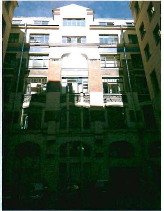
Фото 7. Северный дворовой фасад.
