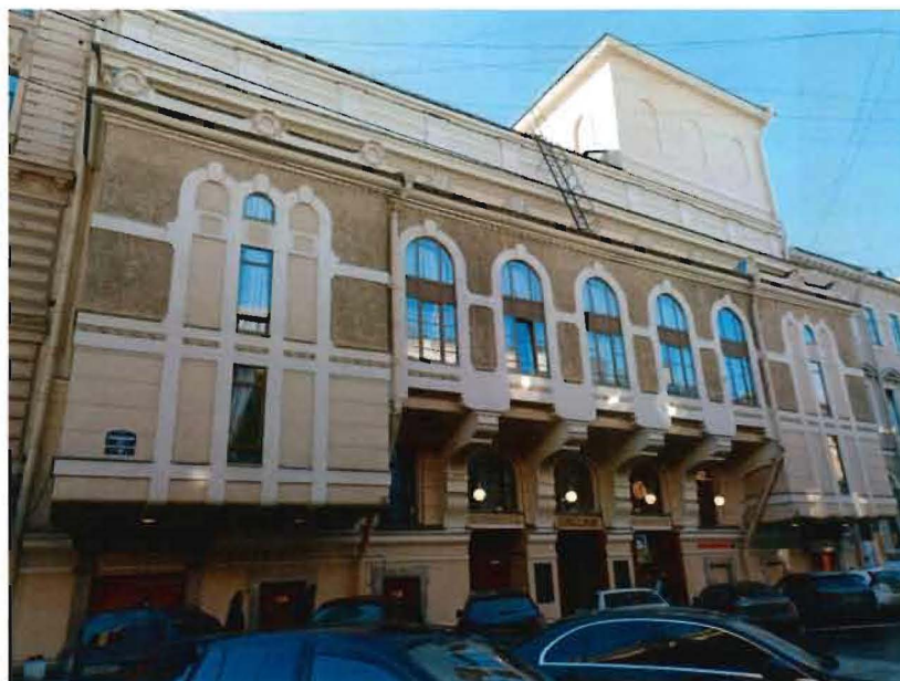
2. Общий вид. Фасад по Итальянской ул. объекта культурного наследия. (фото от 28.02.2023)
