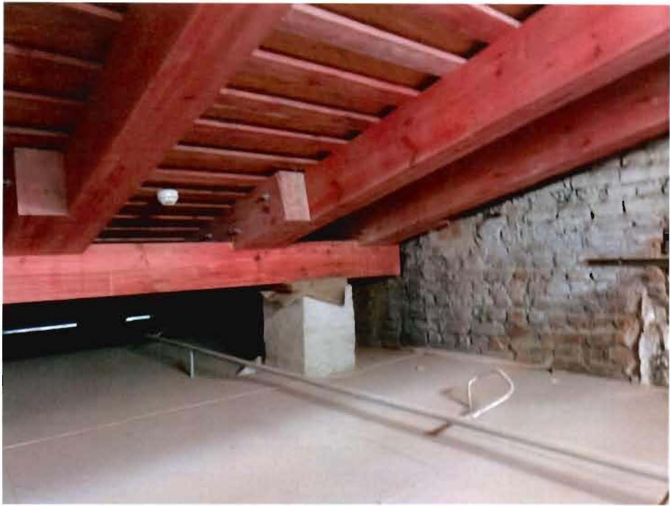
15. Чердачное пространство объекта культурного наследия. (фото от 28.02.2023)
