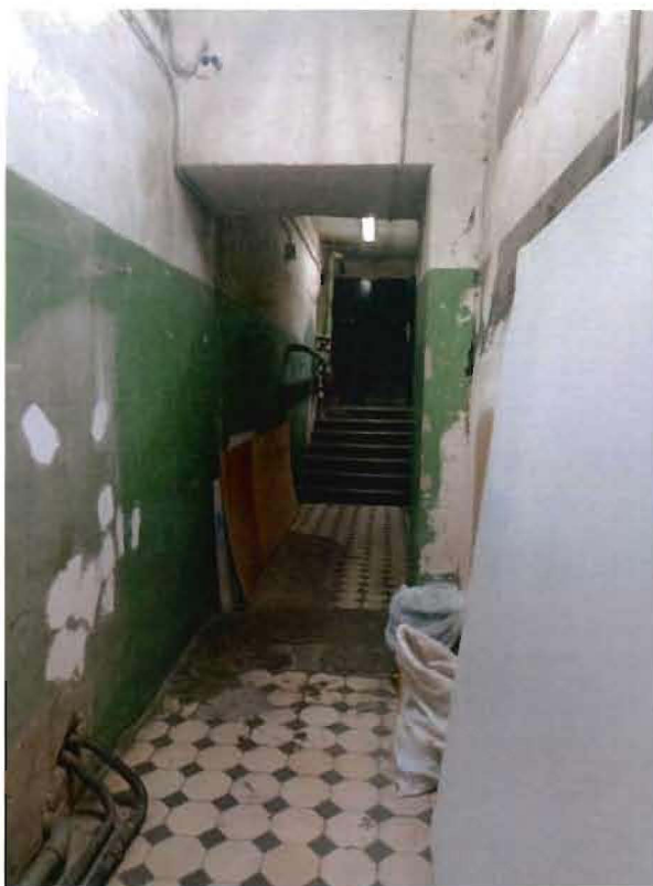
13. Интерьер объекта культурного наследия. Помещение 2-Н(35). (фото от 17.02.2023)
