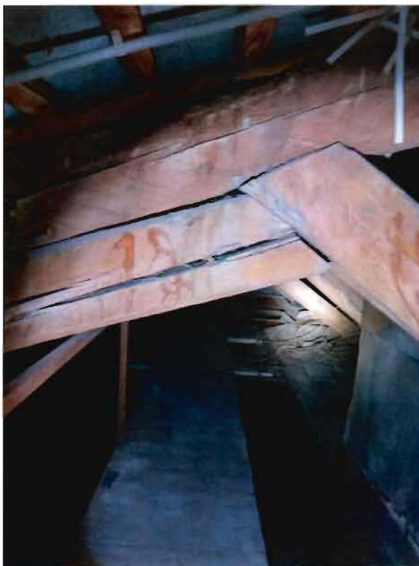
14. Чердачное пространство объекта культурного наследия. (фото от 17.02.2023)
