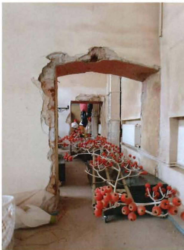
9. Интерьер объекта культурного наследия. Помещение 1-Н(115). (фото от 28.02.2023)
