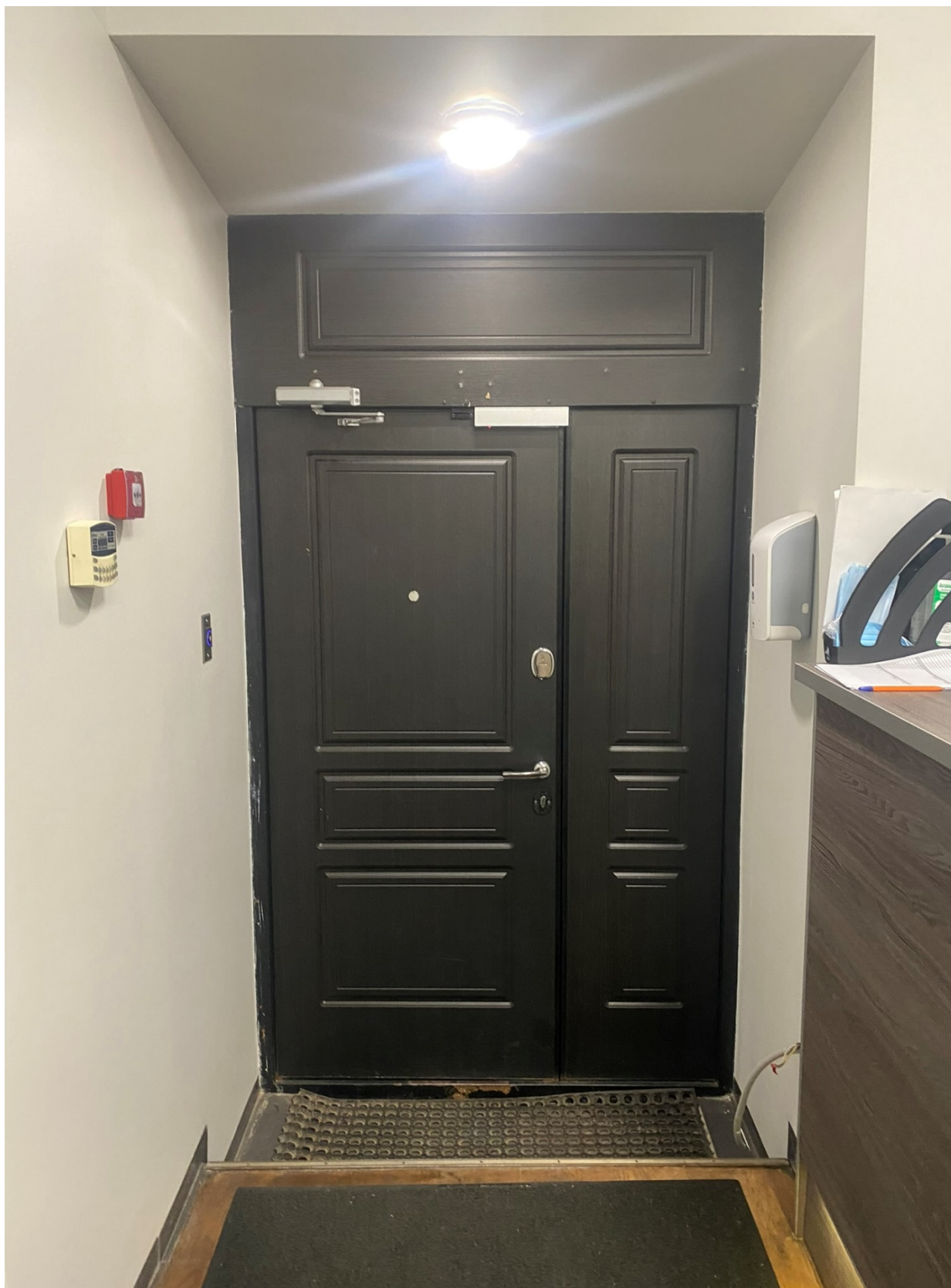
8. Вид на входную дверь в помещении 1-Н;
