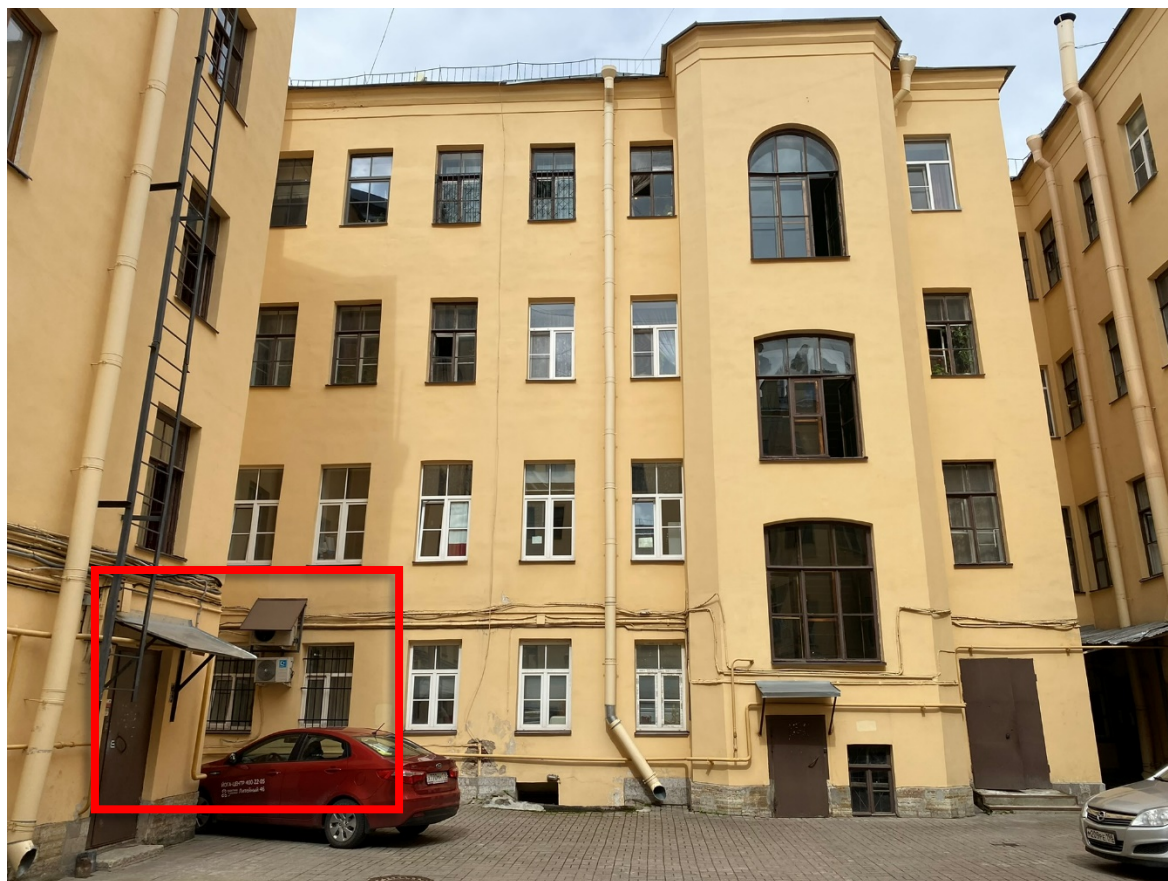
5. Вид на дворовой фасад здания и окна помещения 1-Н;
