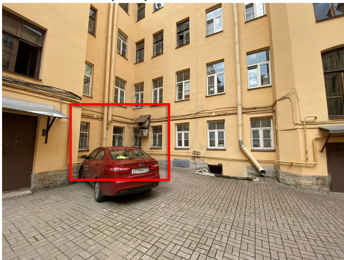
6. Вид на дворовой фасад здания и окна помещения 1-Н;
