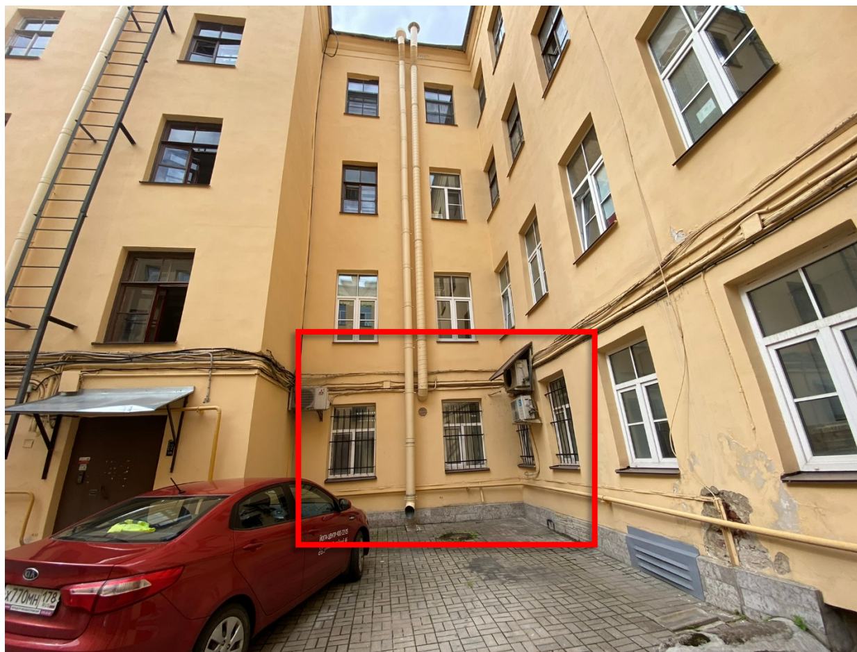
7. Вид на дворовой фасад здания и окна помещения 1-Н;
