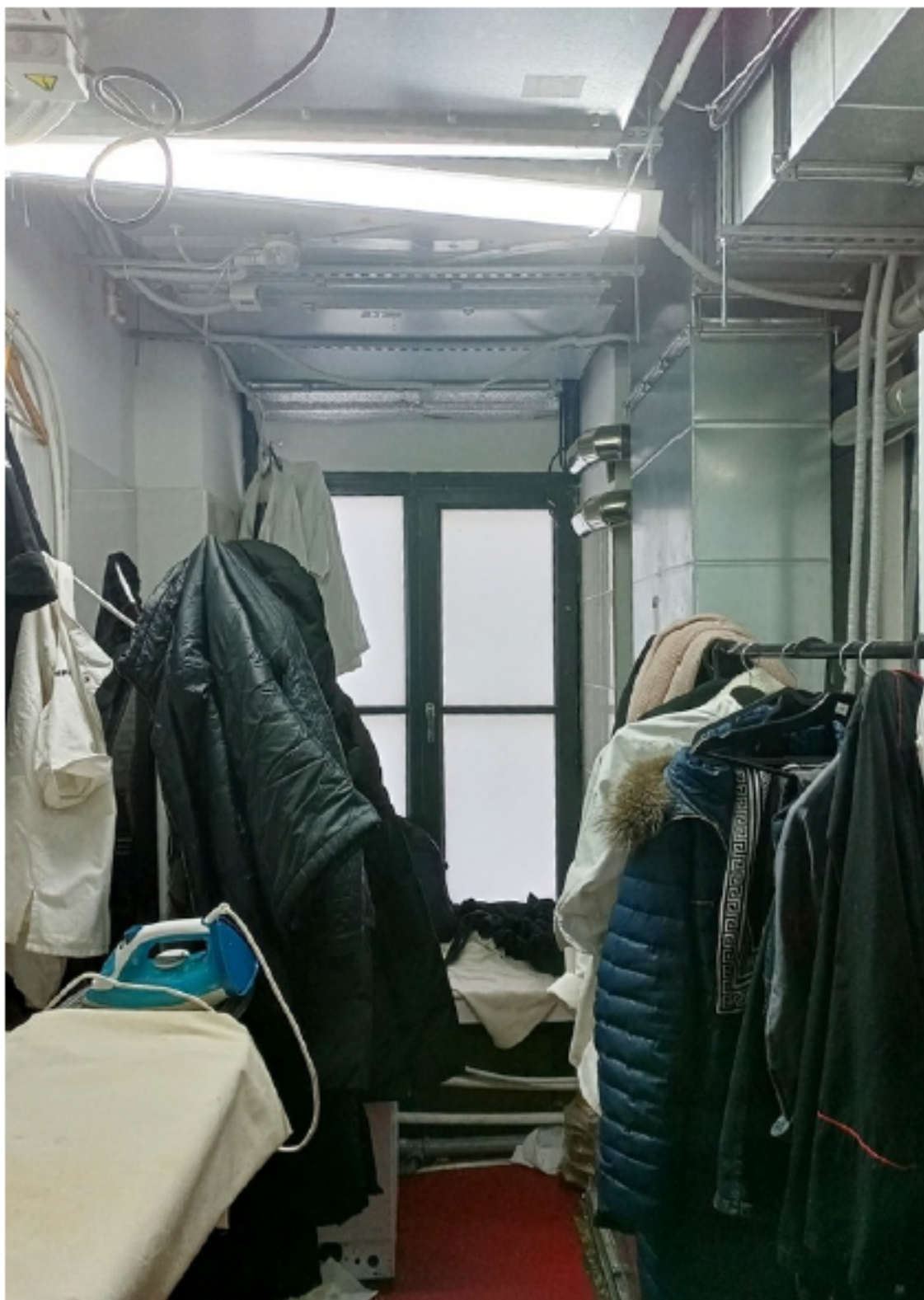
Фото 18. Помещение 11-Н. Техническое помещение.
