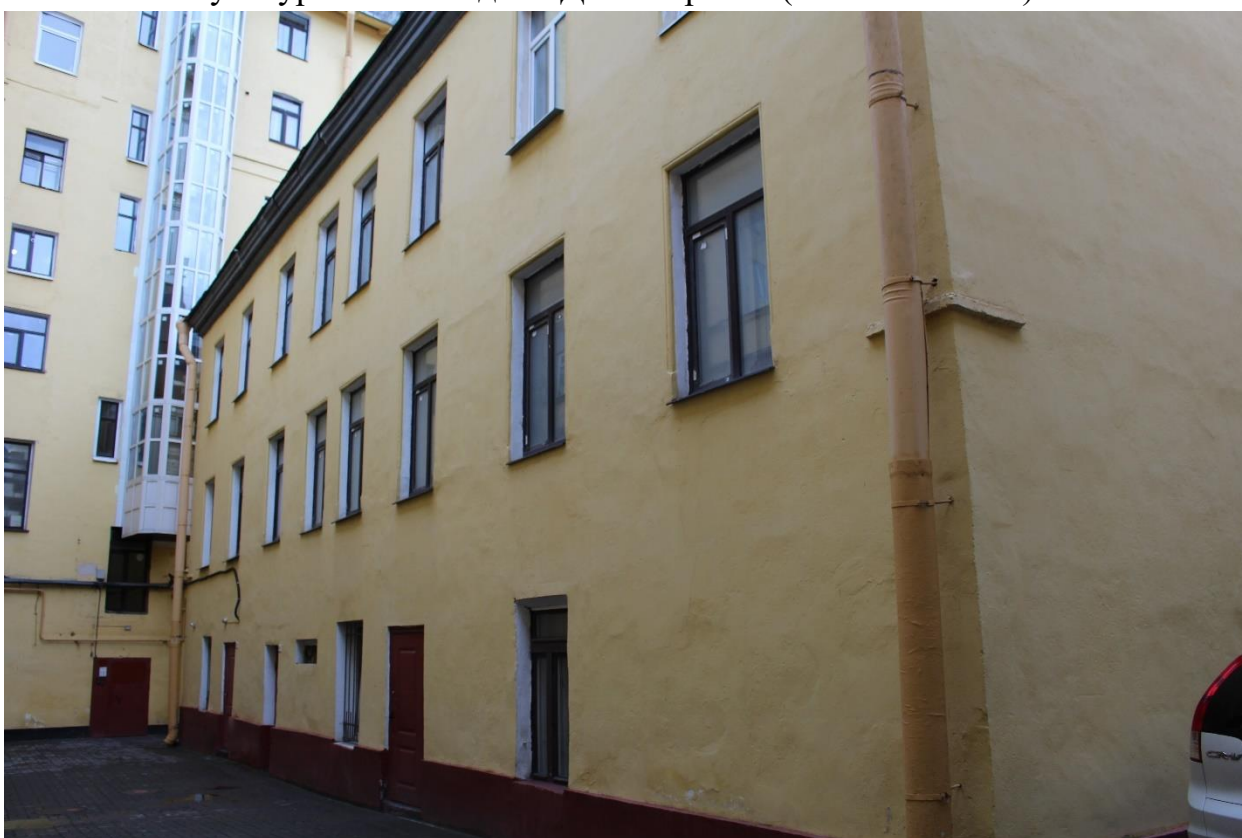
Фото 20. Вид на восточный фасад дворового флигеля выявленного объекта культурного наследия «Дом Зверкова (И.С. Никитина)».
