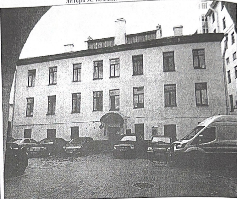
Описание: Вид на Объект
