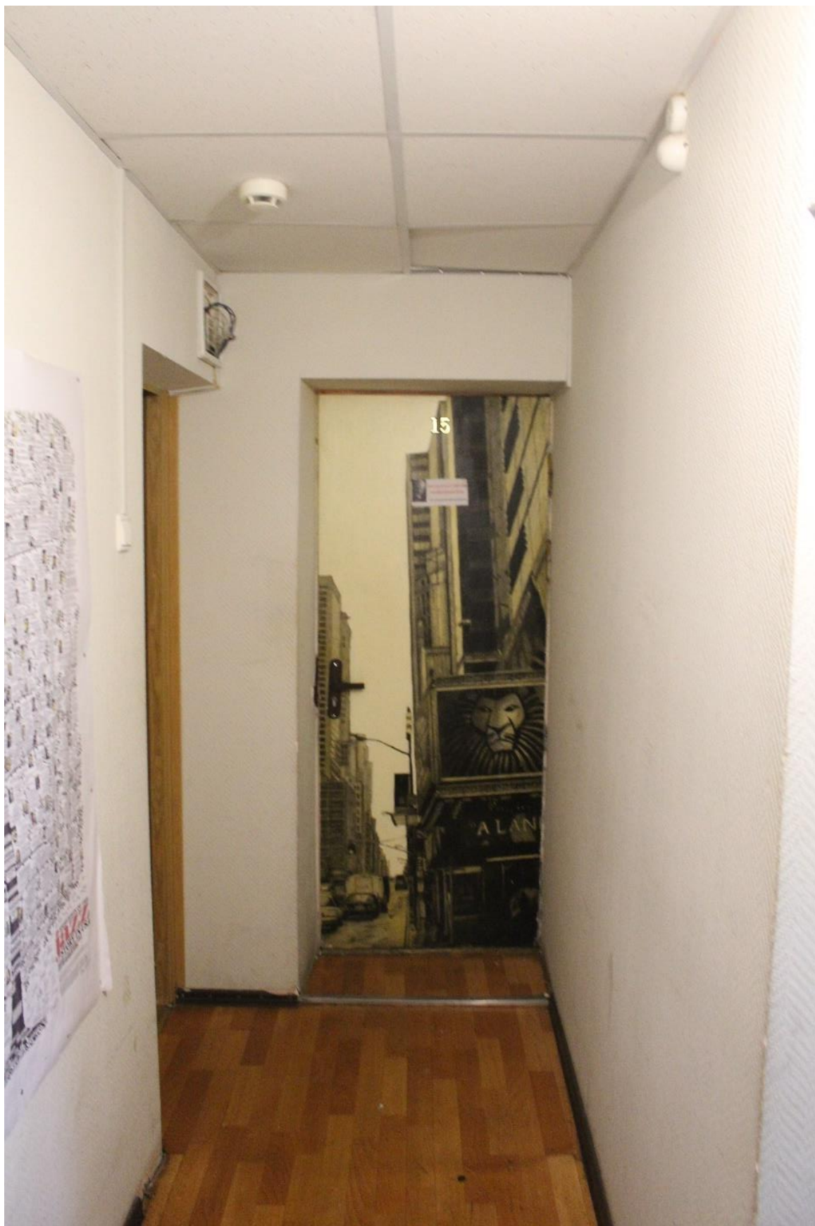
Фото 36. Внутренние помещения дворового флигеля выявленного объекта культурного наследия «Дом Зверкова (И.С. Никитина)». Нежилое помещение 34-Н. Помещение 9.
