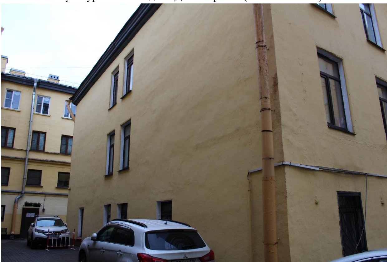
Фото 22. Вид на северный фасад дворового флигеля выявленного объекта культурного наследия «Дом Зверкова (И.С. Никитина)».
