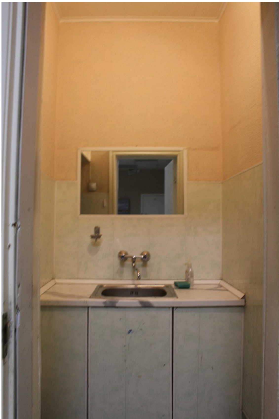
Фото 95. Внутренние помещения дворового флигеля выявленного объекта культурного наследия «Дом Зверкова (И.С. Никитина)». Нежилое помещение 34-Н. Помещение 62.
