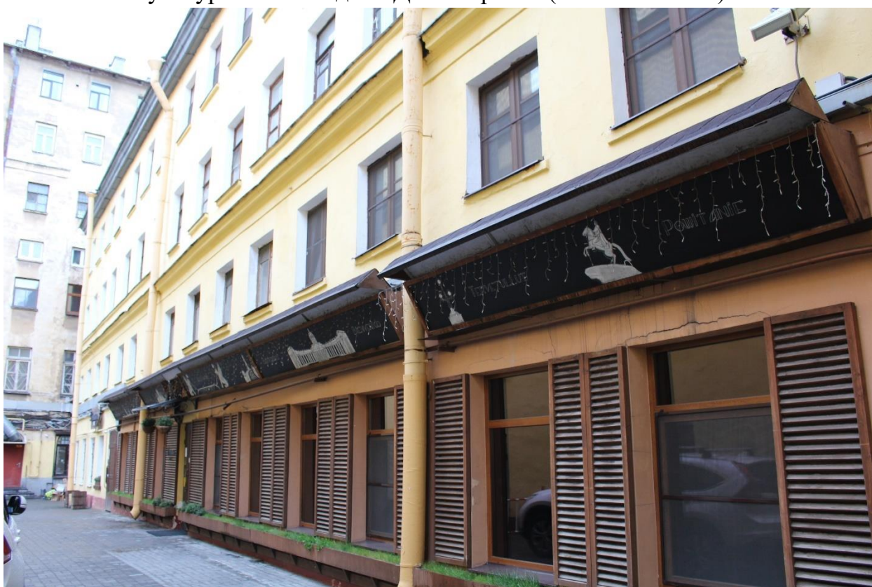
Фото 13. Вид на фасад северного дворового корпуса выявленного объекта культурного наследия «Дом Зверкова (И.С. Никитина)».
