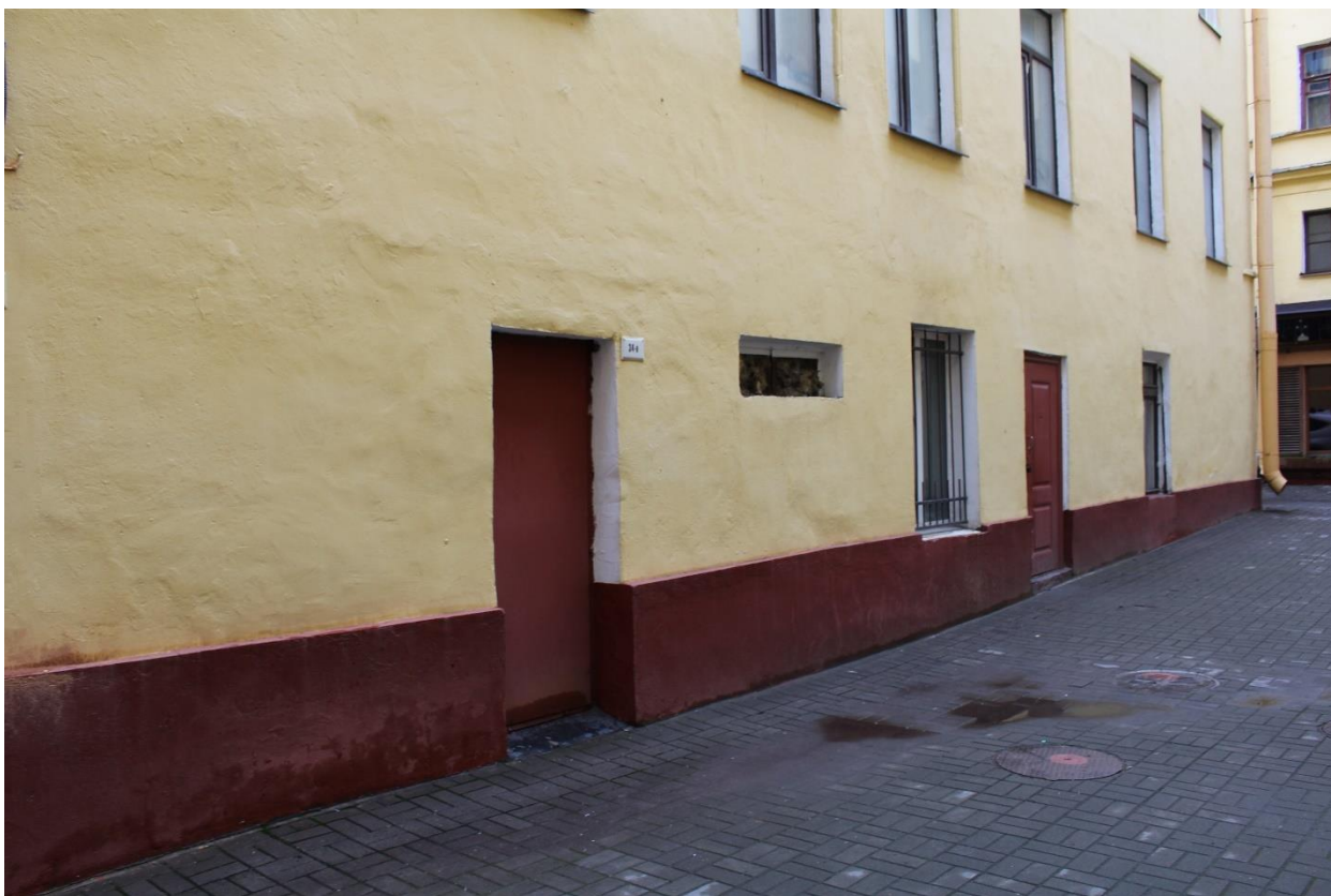
Фото 19. Вид на восточный фасад дворового флигеля выявленного объекта культурного наследия «Дом Зверкова (И.С. Никитина)».
