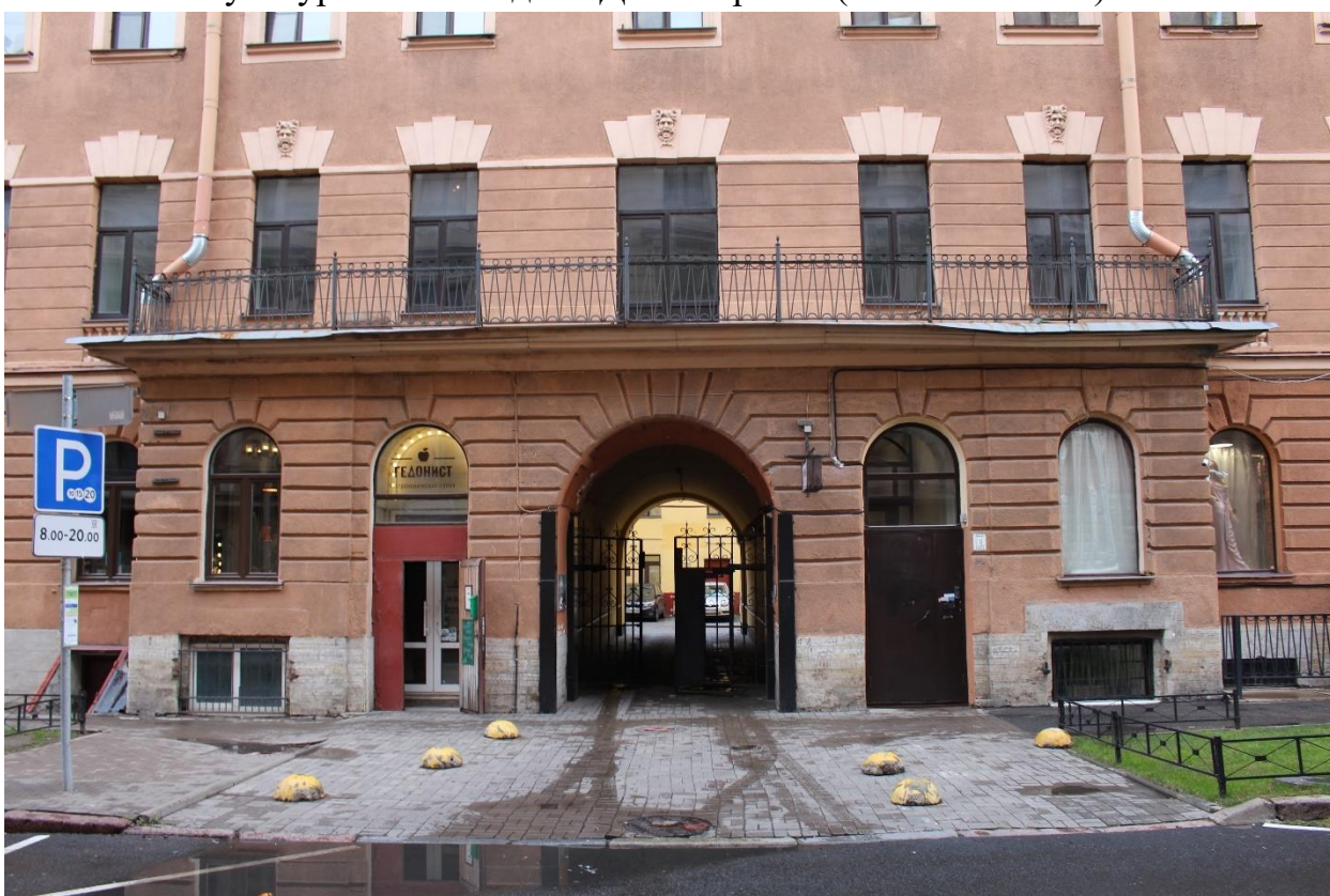
Фото 6. Вид на воротный проезд в западном лицевом корпусе выявленного объекта культурного наследия «Дом Зверкова (И.С. Никитина)».
