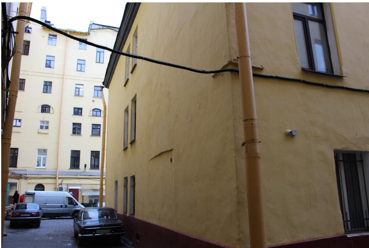
Фото 17. Вид на южный фасад дворового флигеля выявленного объекта культурного наследия «Дом Зверкова (И.С. Никитина)».
