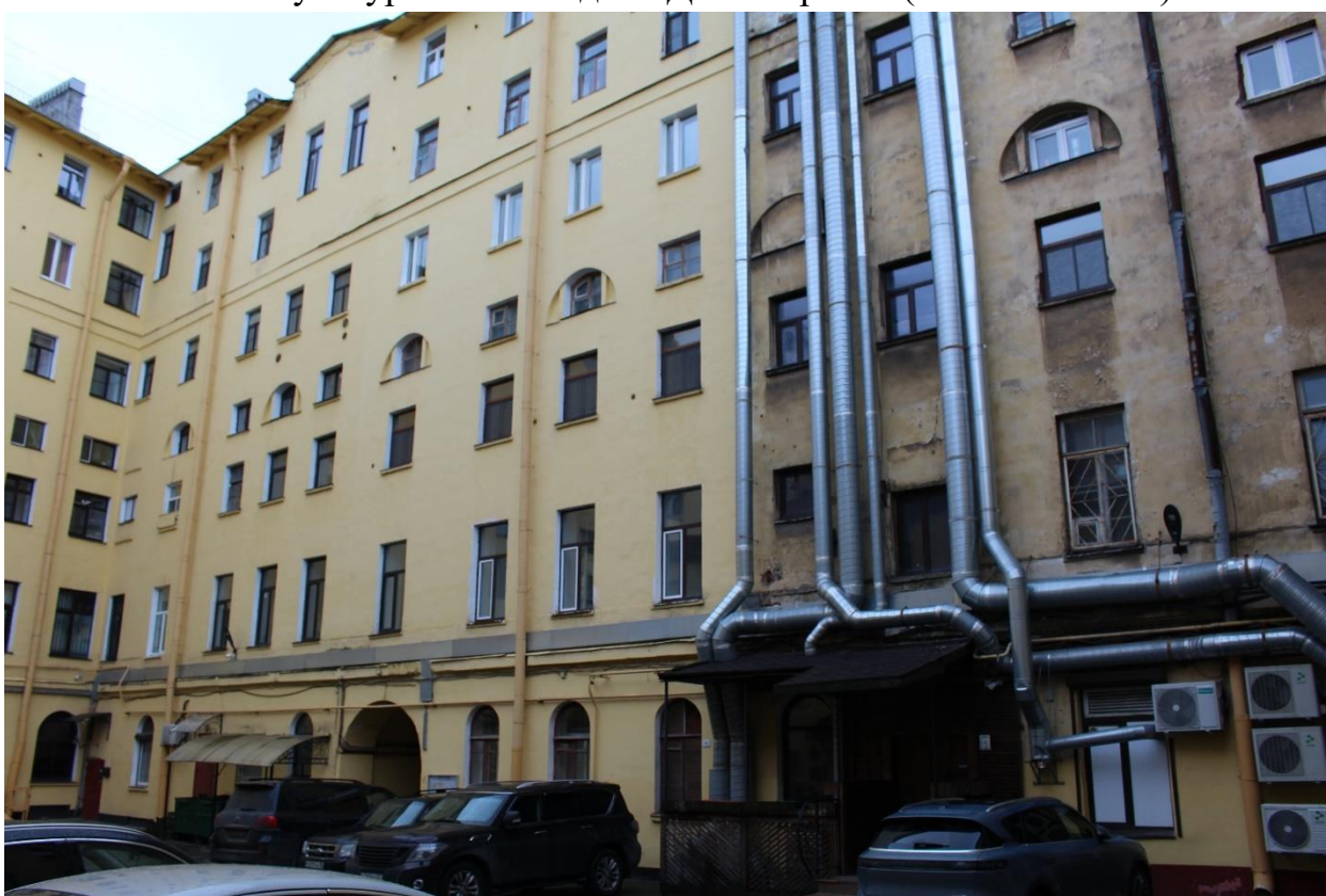
Фото 8. Вид на дворовый фасад западного лицевого корпуса выявленного объекта культурного наследия «Дом Зверкова (И.С. Никитина)».
