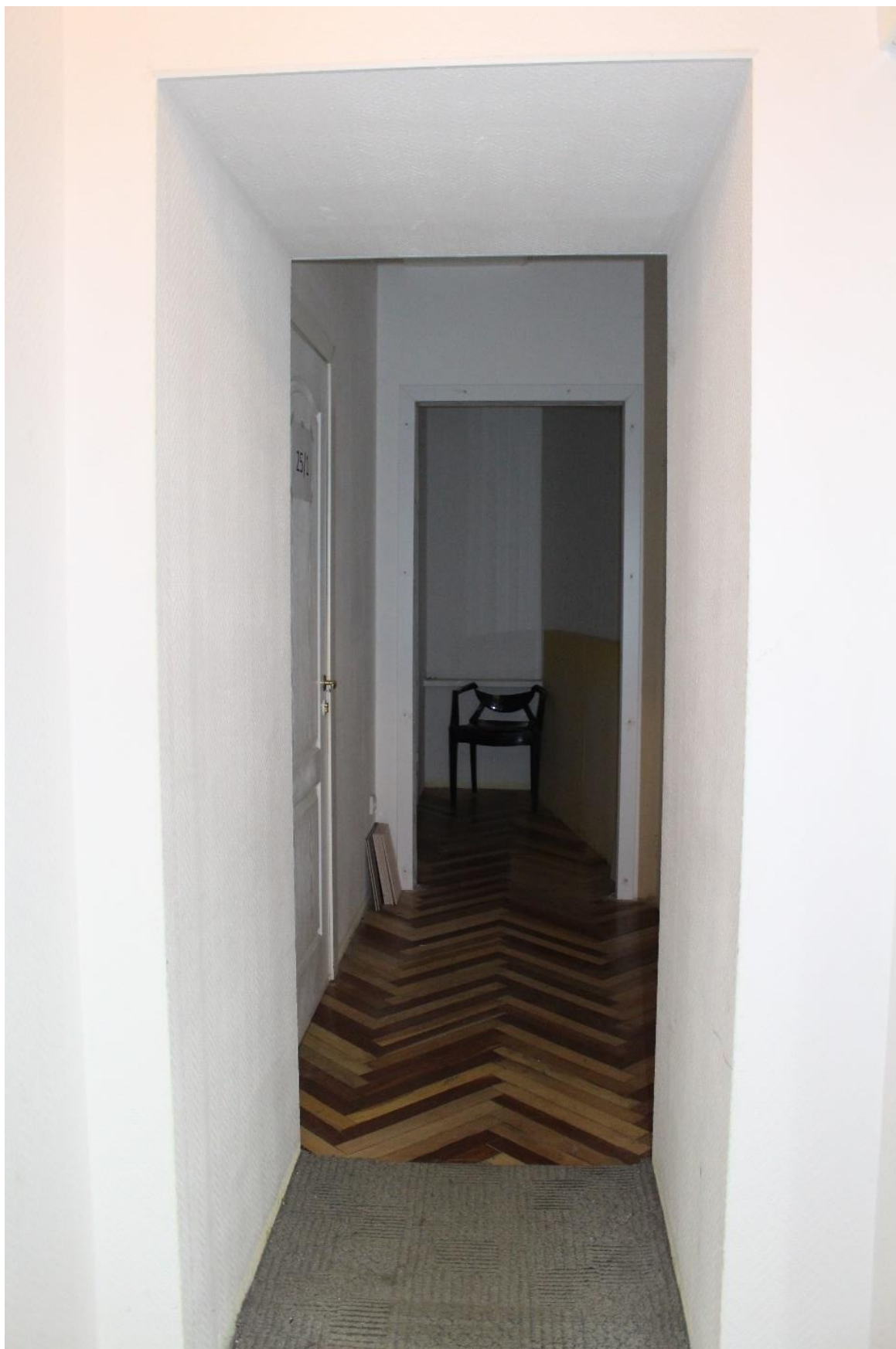
Фото 69. Внутренние помещения дворового флигеля выявленного объекта культурного наследия «Дом Зверкова (И.С. Никитина)». Нежилое помещение 34-Н. Помещения 38, 34.
