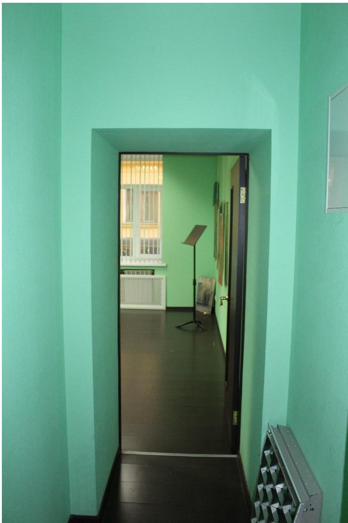
Фото 52. Внутренние помещения дворового флигеля выявленного объекта культурного наследия «Дом Зверкова (И.С. Никитина)». Нежилое помещение 34-Н. Помещение 27.
