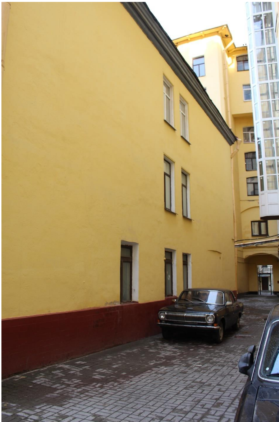
Фото 16. Вид на южный фасад дворового флигеля выявленного объекта культурного наследия «Дом Зверкова (И.С. Никитина)».
