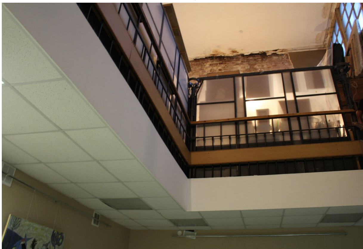
Фото 99. Внутренние помещения дворового флигеля выявленного объекта культурного наследия «Дом Зверкова (И.С. Никитина)». Нежилое помещение 34-Н. Вид на чердачный этаж с 3-го этажа.
