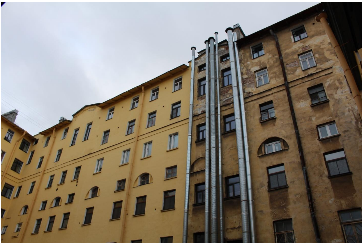
Фото 9. Вид на дворовый фасад западного лицевого корпуса выявленного объекта культурного наследия «Дом Зверкова (И.С. Никитина)».
