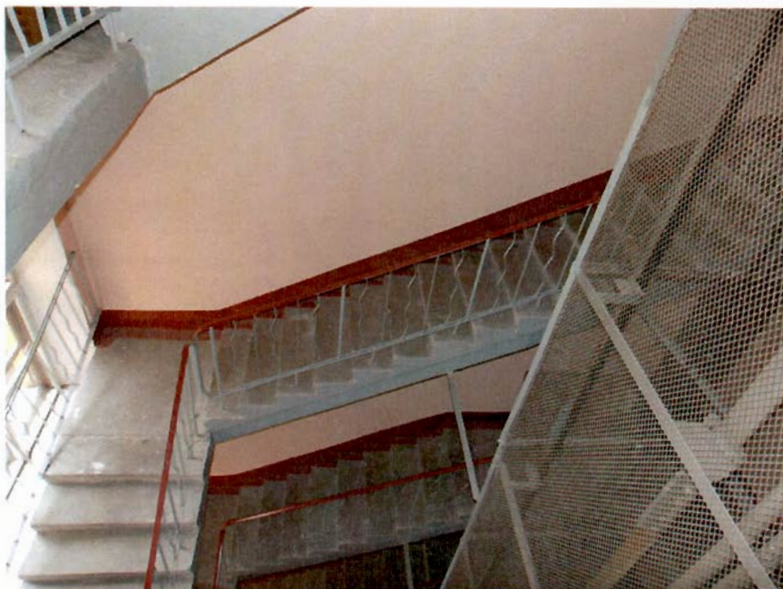
17. Лестница дворового флигеля.
