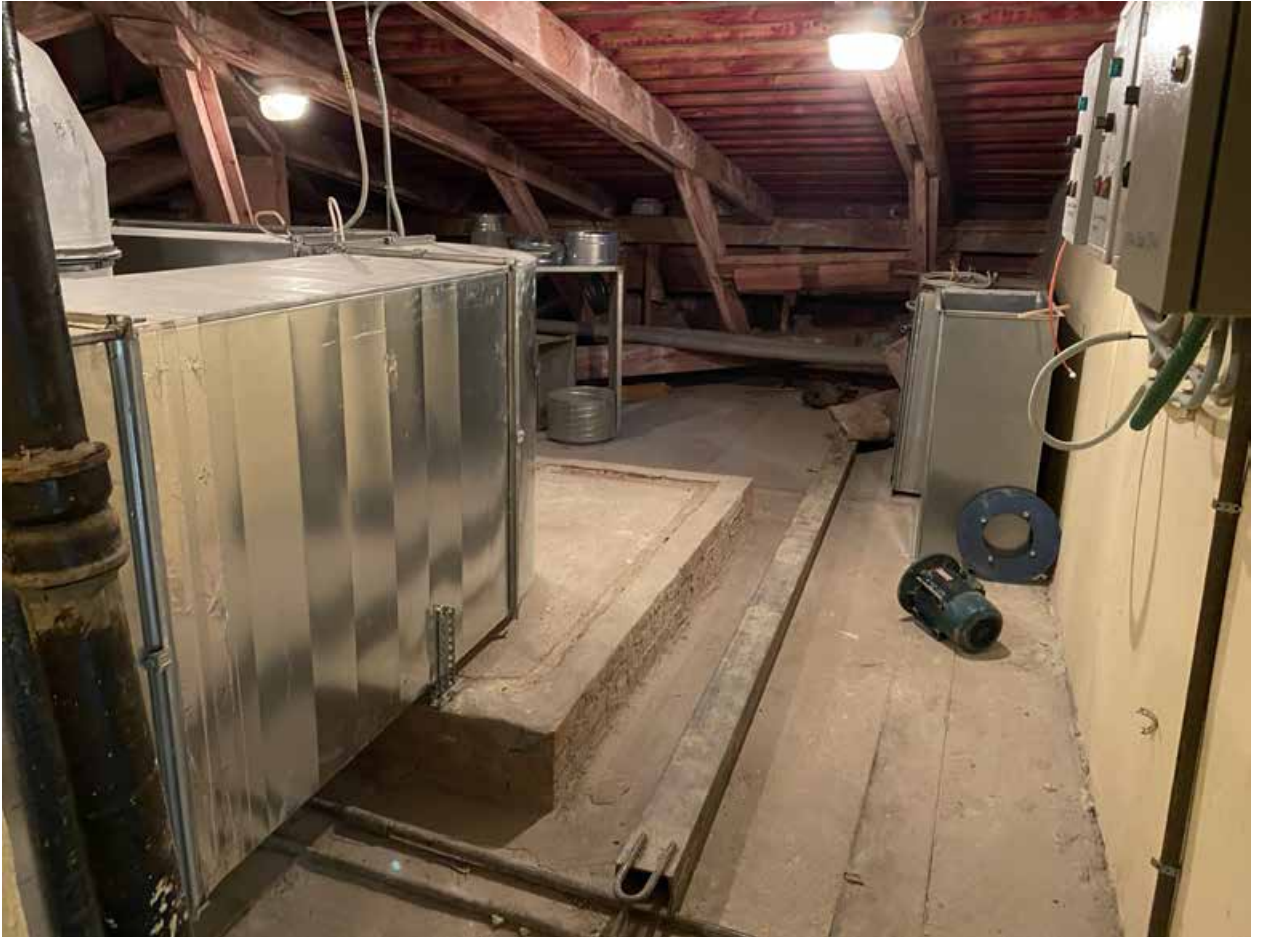
Фото 241. Невский пр. д 40-42 лит. А. Помещение 41-Н(5).
