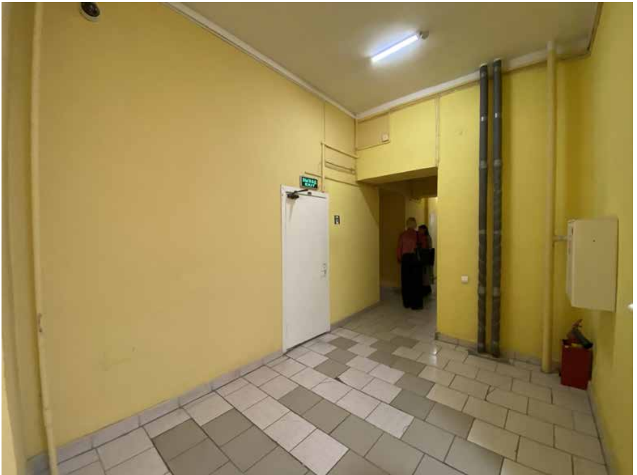
Фото 169. Невский пр. д 40-42 лит. А. Помещение 19-Н(62).
