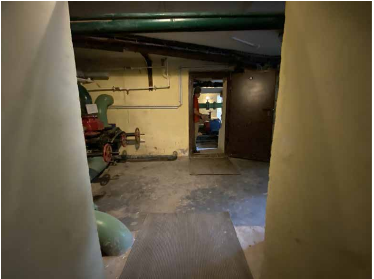
Фото 84. Невский пр. д 40-42 лит. А. Помещение 14-Н(1).
