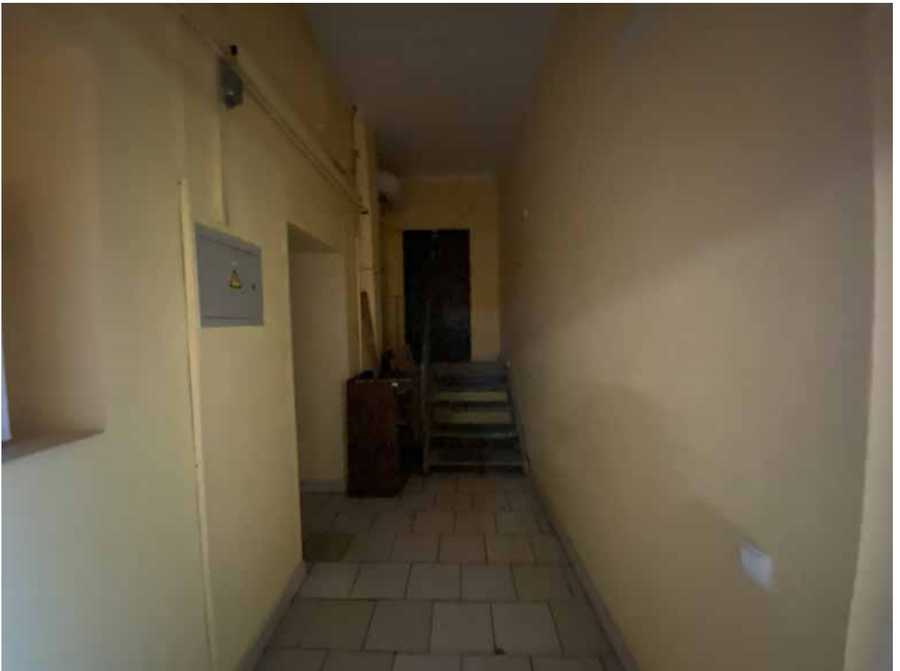
Фото 179. Невский пр. д 40-42 лит. А. Помещение 19-Н(52).
