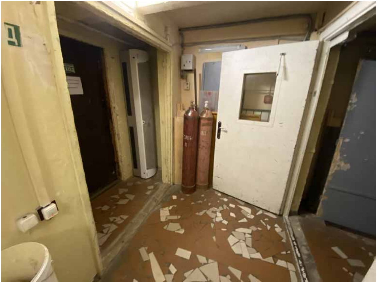
Фото 68. Невский пр. д 40-42 лит. А. Помещения 14ЛК.
