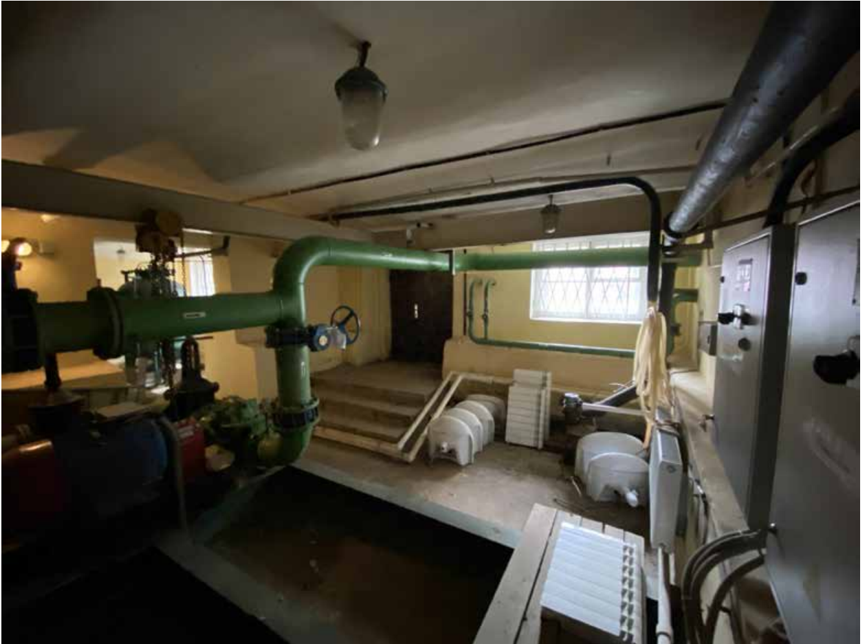
Фото 87. Невский пр. д 40-42 лит. А. Помещение 15-Н(2).
