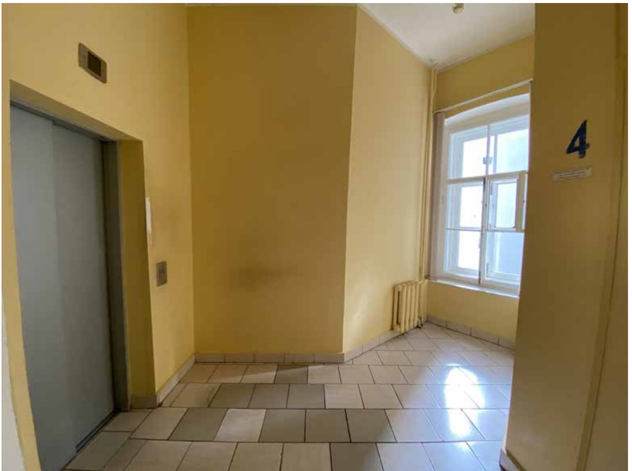
Фото 168. Невский пр. д 40-42 лит. А. Помещение 19-Н(63).
