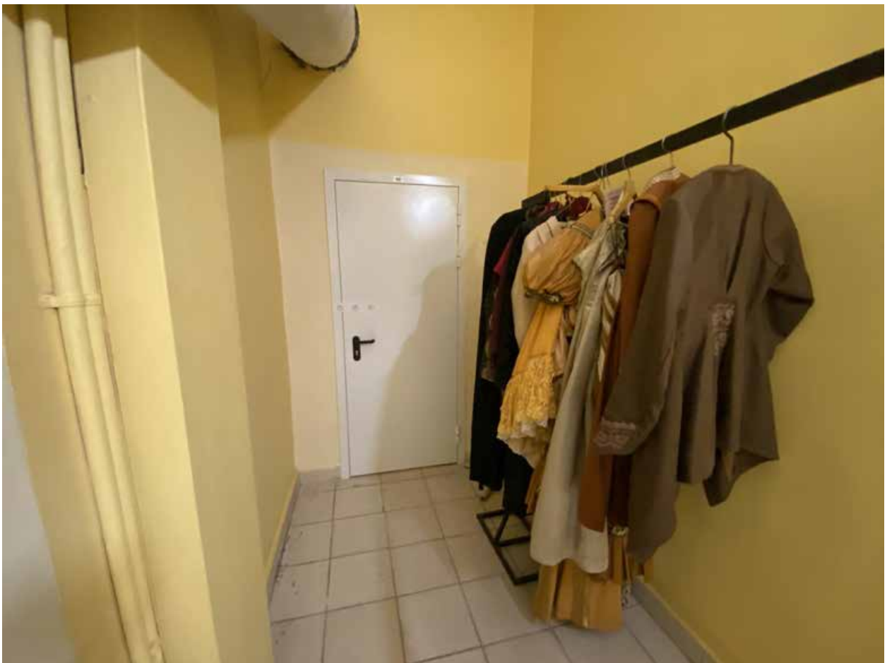
Фото 203. Невский пр. д 40-42 лит. А. Помещение 19-Н(78).
