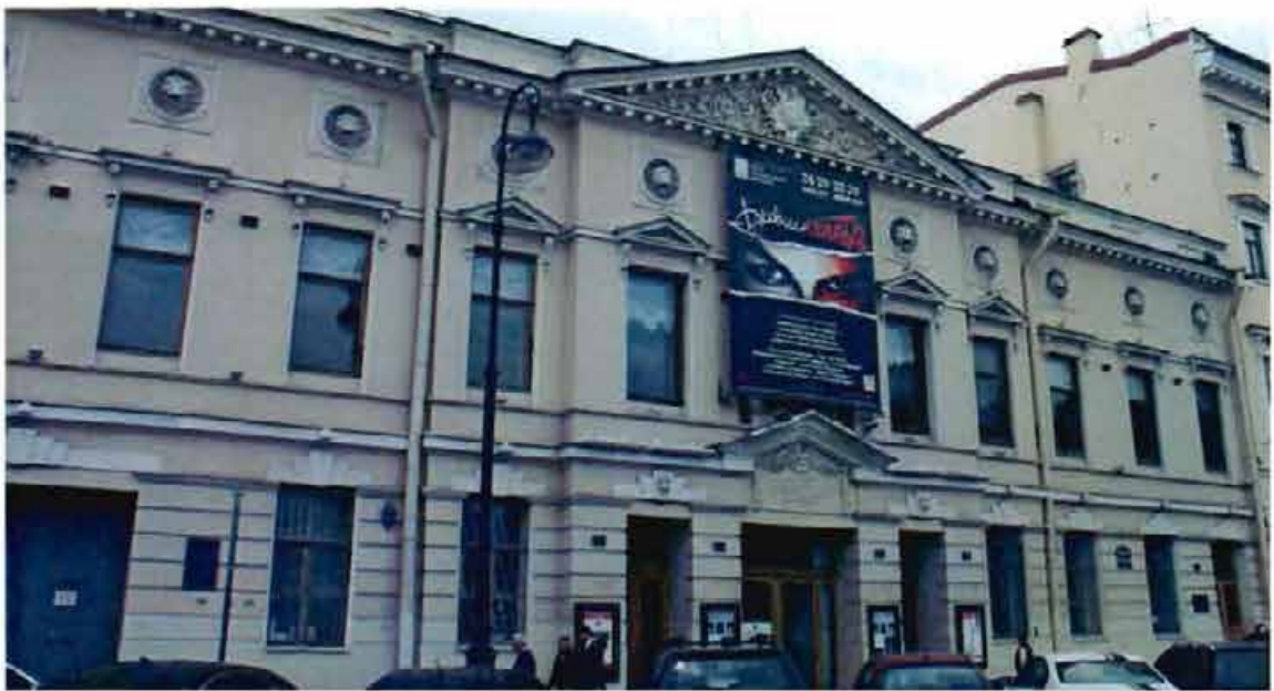
Фото №1. Вид на лицевой фасад со стороны ул. Итальянской.
