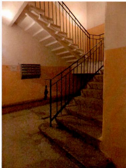
18. Лестница дворового флигеля.
