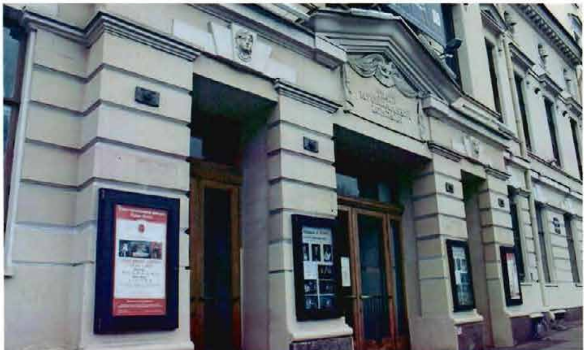
Фото №2. Парадный вход лицевого фасада.
