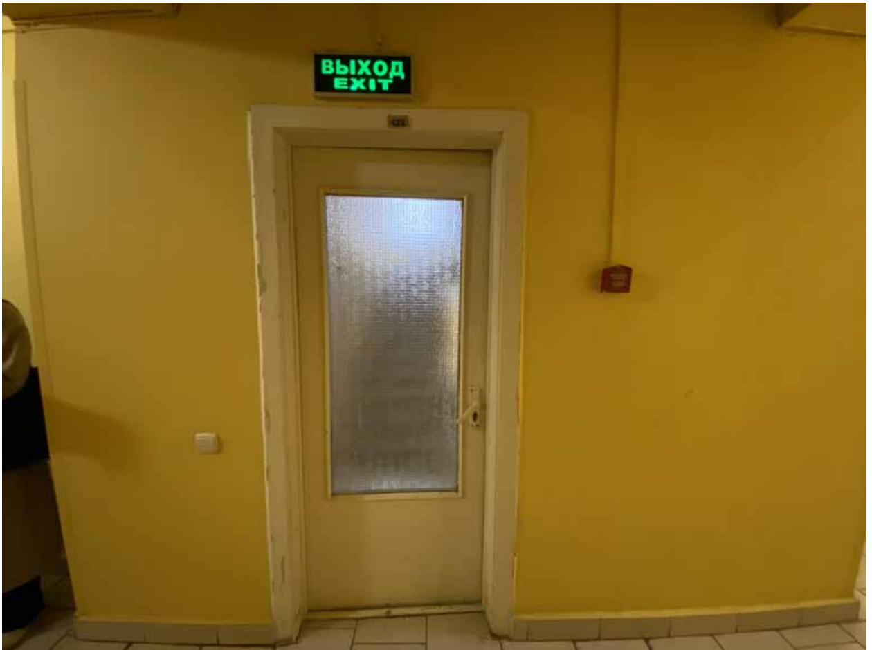
Фото 171. Невский пр. д 40-42 лит. А. Помещение 19-Н(62).
