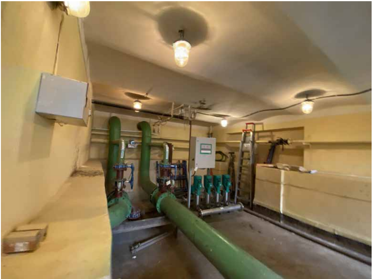
Фото 88. Невский пр. д 40-42 лит. А. Помещение 15-Н(3).
