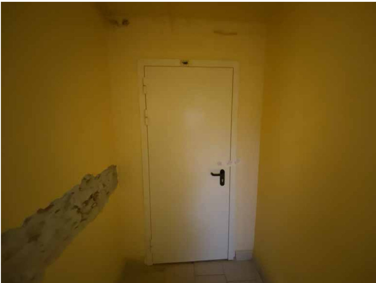
Фото 170. Невский пр. д 40-42 лит. А. Помещение 19-Н(62).
