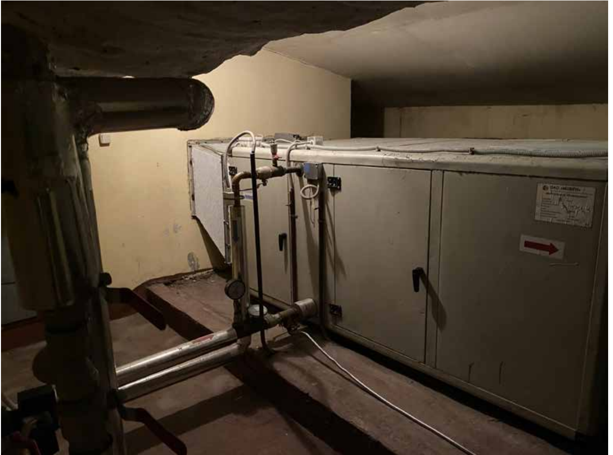
Фото 240. Невский пр. д 40-42 лит. А. Помещение 41-Н(2).
