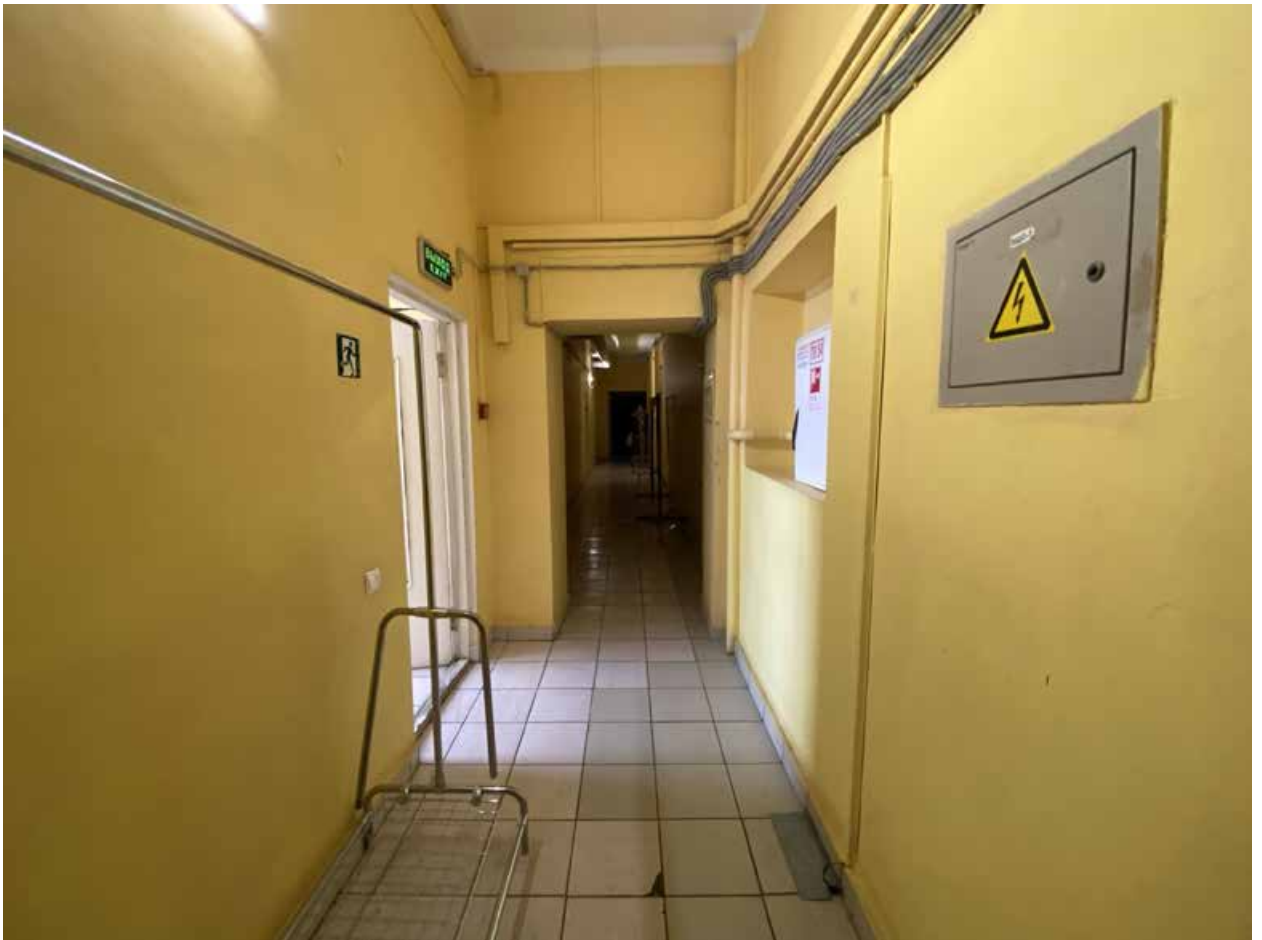
Фото 204. Невский пр. д 40-42 лит. А. Помещение 19-Н(78).
