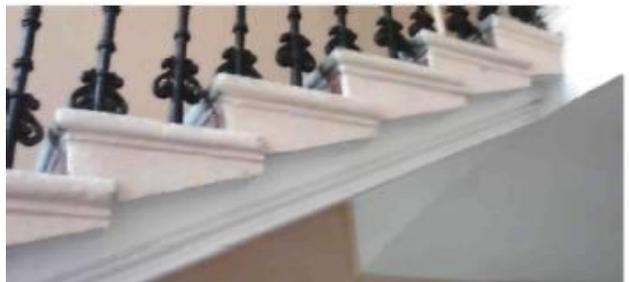
историческое ограждение лестниц (утрачено в 1 марше) и верхних площадок – материал (металл), техника исполнения (литье), рисунок (вертикальные стойки с ажурным рисунком в верхней и нижней частях, угловые - со спиралевидной верхней частью), профилированный поручень: материал (дерево);
