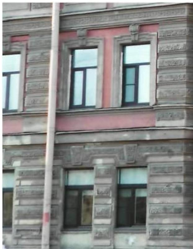
профилированные междуэтажные тяги и карнизы, включая тягу с поясом меандра – в уровне между 2-м и 3-м этажами;
