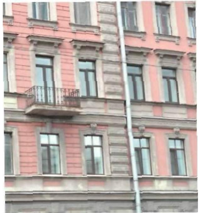
балконы на южном фасаде: местоположение (по 4, 14 световым осям в уровне 3 этажа, по 8-10 световым осям в уровне 2 этажа), габариты, конфигурация (прямоугольные в плане); ограждение (материал – металл, техника – литьё, рисунок – с ажурными элементами в верхней и нижней части);
