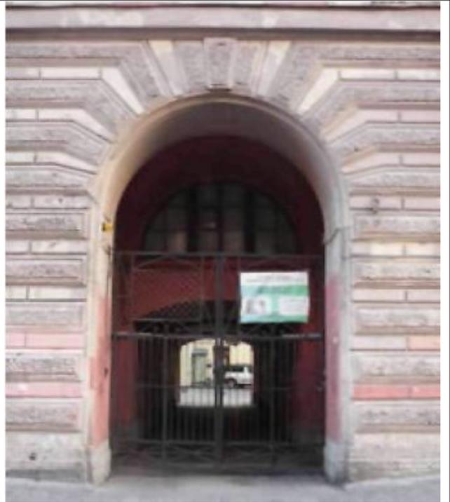
историческое заполнение воротных проемов (по 11-12, 22-23 световым осям), расположенные непосредственно за лицевыми арками проездов– конструкция (ворота двухстворчатые), материал (металл), техника исполнения (литье), рисунок;
