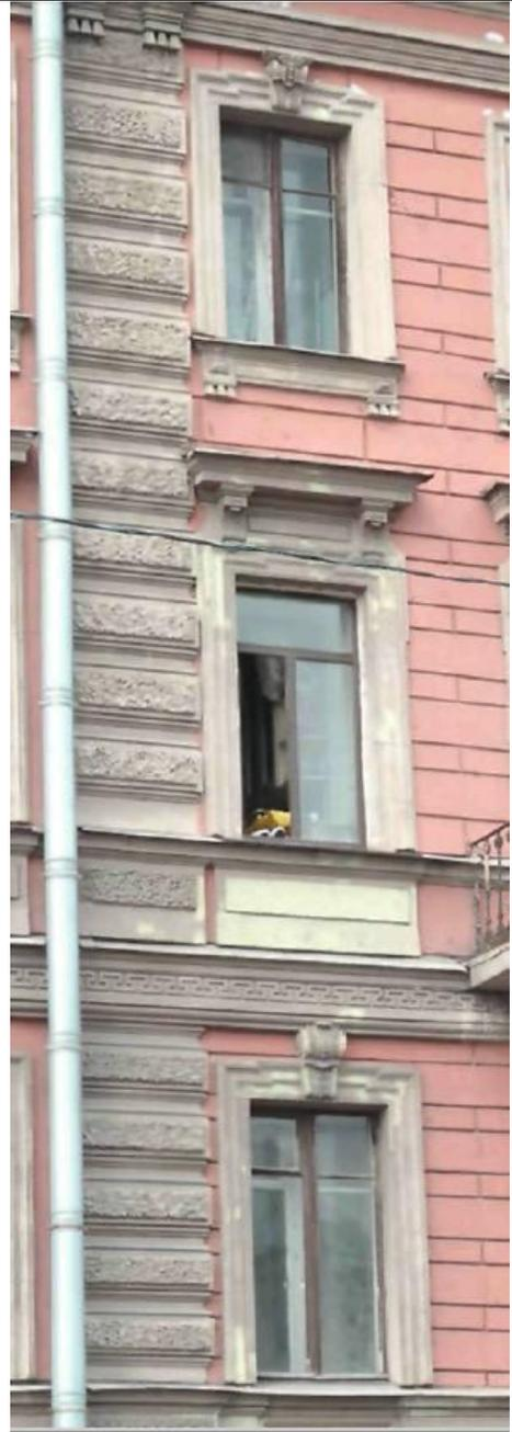
профилированные междуэтажные тяги и карнизы, включая тягу с поясом меандра – в уровне между 2-м и 3-м этажами;
