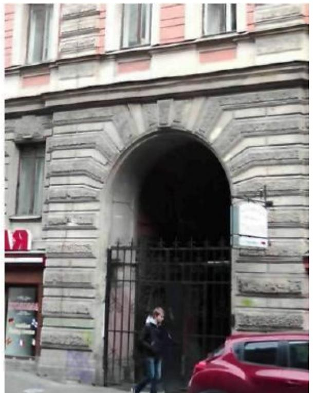
историческое заполнение воротных проемов (по 9-10, 20-21 световым осям), расположенные непосредственно за лицевыми арками проездов – конструкция (ворота двухстворчатые), материал (металл), техника исполнения (литье), рисунок;
