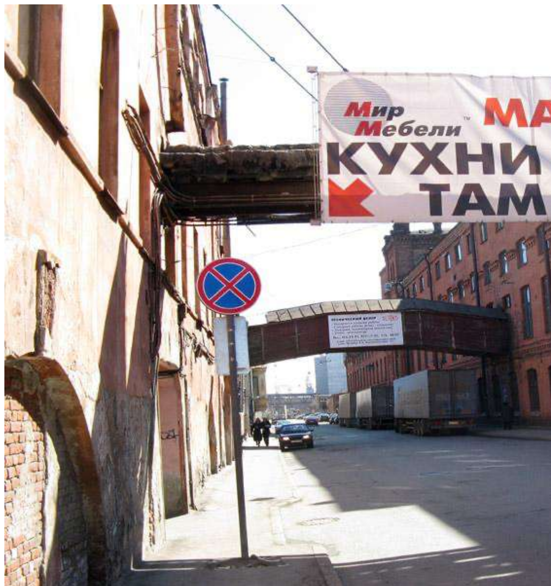
58. Перспектива Кожевенной линии. Фотография. Автор неизвестен. 2010-е гг. // Источник: https://p1.citywalls.ru/photo_54-56089.jpg?mt=1285962204 (дата обращения: 31.10.2023).
