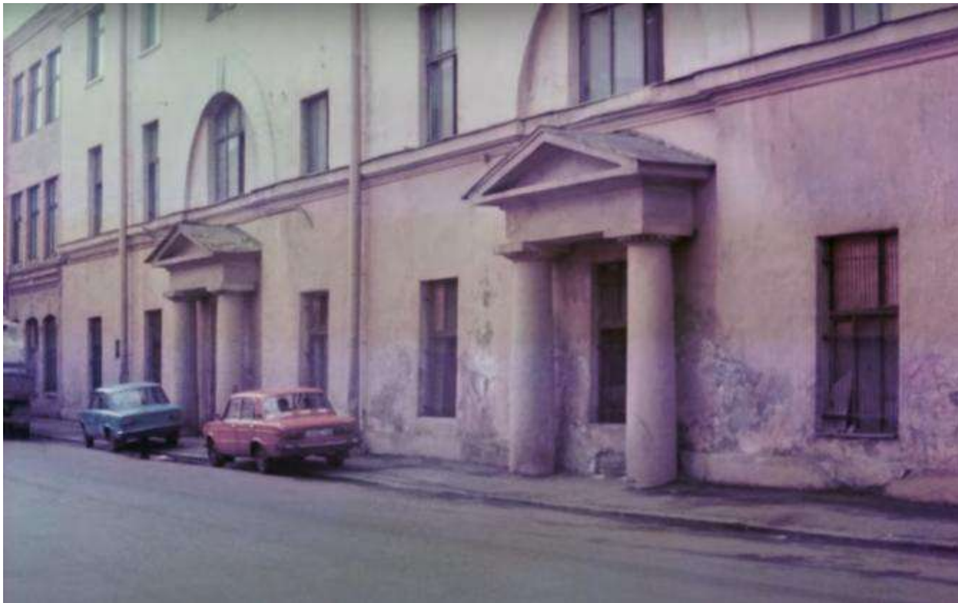
71. Кожевенная линия В.О., дом 30. Фотография. Автор неизвестен. 1991–1992 гг. // Источник: URL: https://www.citywalls.ru/photo619069.html (дата обращения: 31.10.2023).
