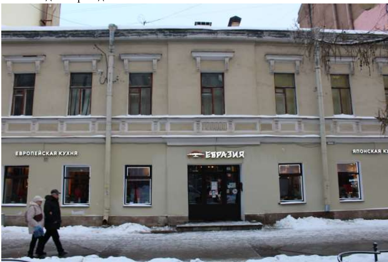
2. Выявленный объект культурного наследия «Дом В.И. Миллера». Вид на юго-западный фасад.
