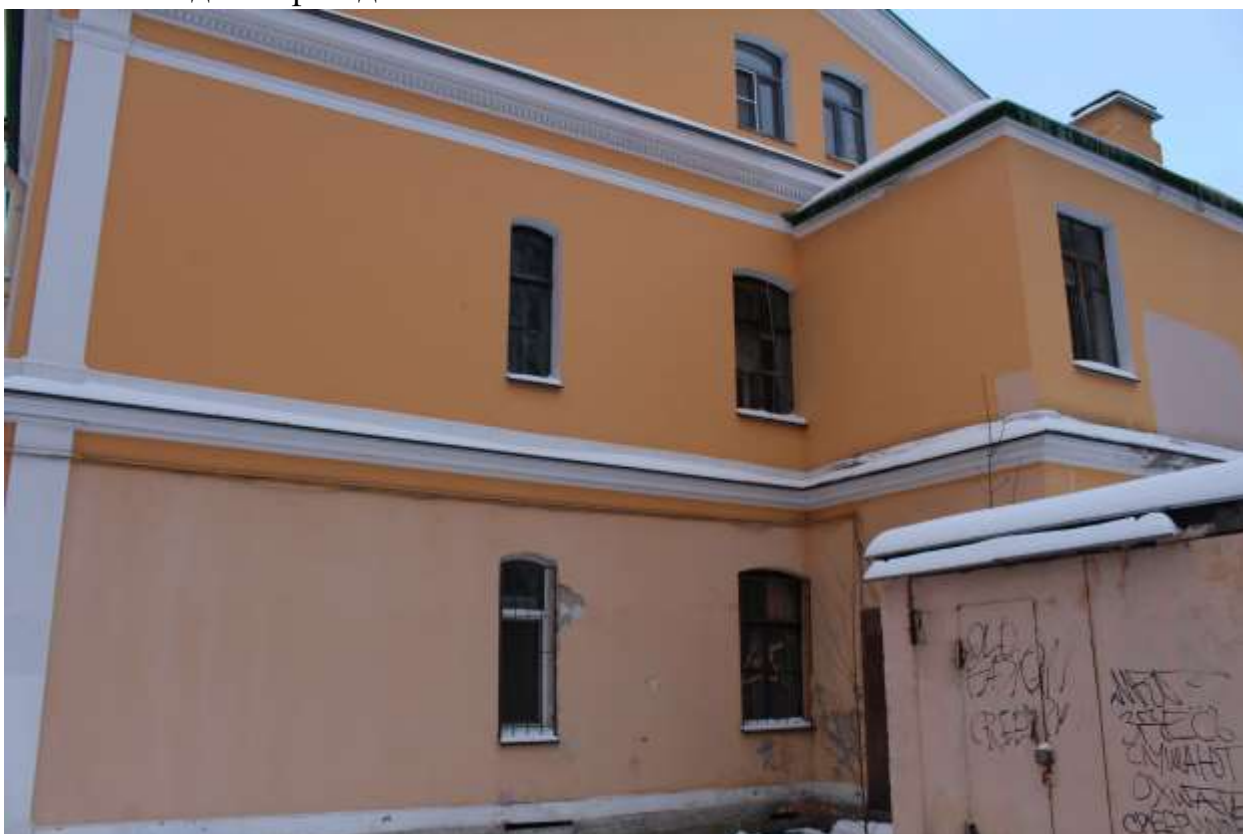
72. Выявленный объект культурного наследия «Богдельня для женщин». Вид на юго-восточный фасад.
