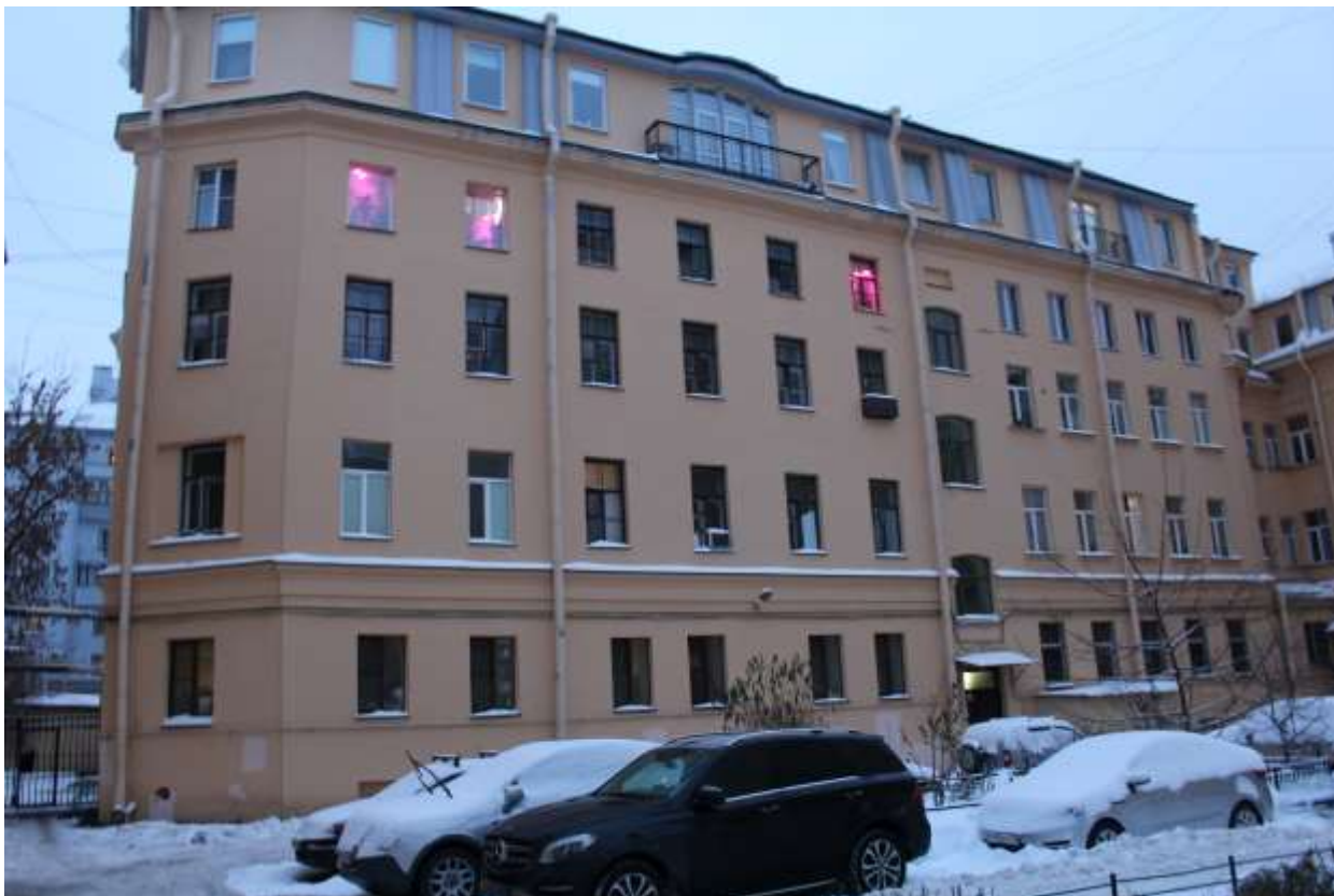
33. Выявленный объект культурного наследия «Дом В.А. Квасникова». Вид на фасад северо-западного дворового корпуса.
