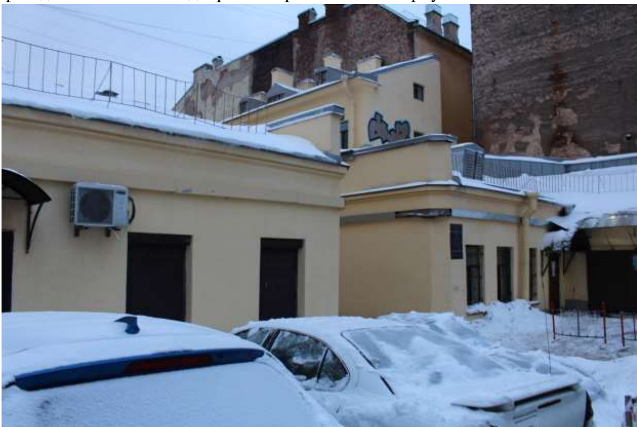
20. Выявленный объект культурного наследия «Дом И. Ковригина». Вид на северо-восточный фасад одноэтажных корпусов.
