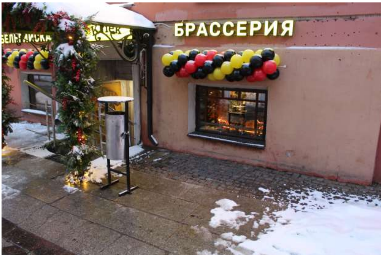
27. Выявленный объект культурного наследия «Дом К. Штрауха». Вид на ввод теплосети со стороны 6-й линии В.О.
