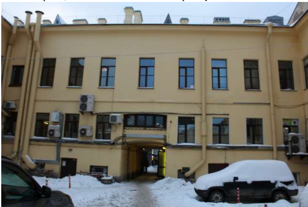
16. Выявленный объект культурного наследия «Дом И. Ковригина». Вид на юго-западный фасад. Вид на северо-восточный фасад лицевого корпуса.
