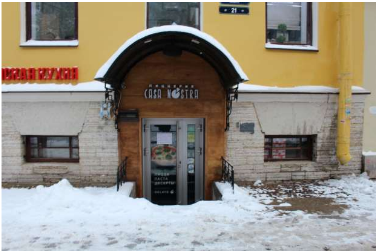
15. Выявленный объект культурного наследия «Дом И. Ковригина». Юго-западный фасад, вид на ввод теплосети со стороны улицы.
