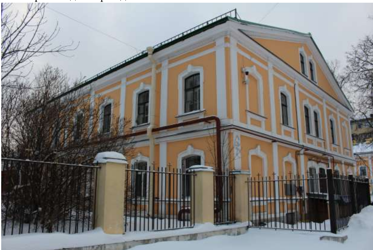
74. Выявленный объект культурного наследия «Богадельня для женщин». Вид на северо-западный и северо-восточный фасады.
