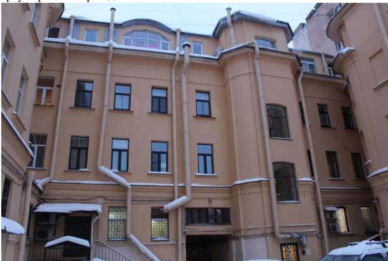
32. Выявленный объект культурного наследия «Дом В.А. Квасникова». Вид на юго-западный фасад лицевого корпуса.
