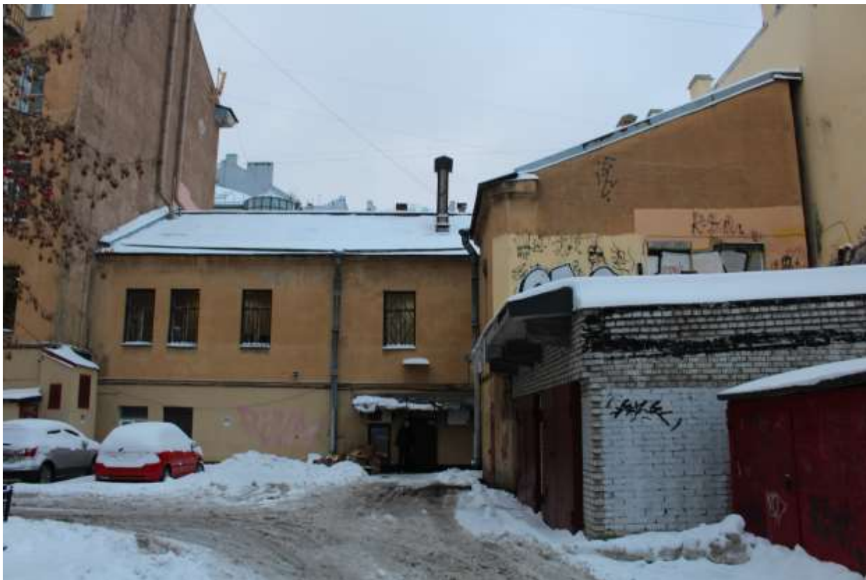
5. Выявленный объект культурного наследия «Дом В.И. Миллера». Вид на дворовые фасады.
