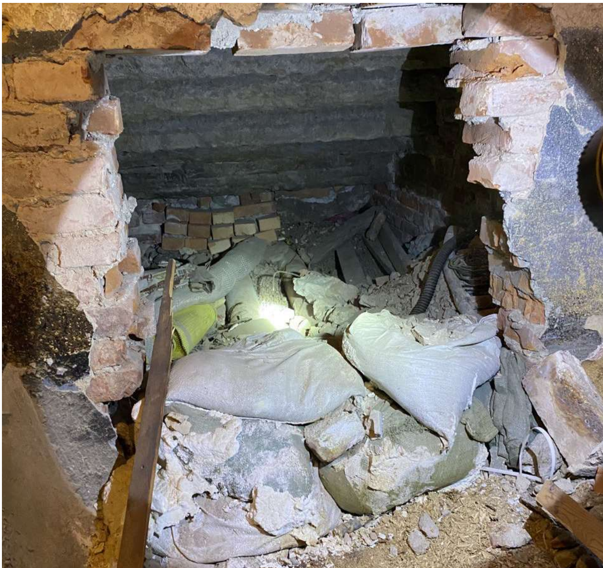
40. Выявленный объект культурного наследия «Дом В.А. Квасникова». Вид на трубы теплосети в подпольном канале лицевого корпуса.
