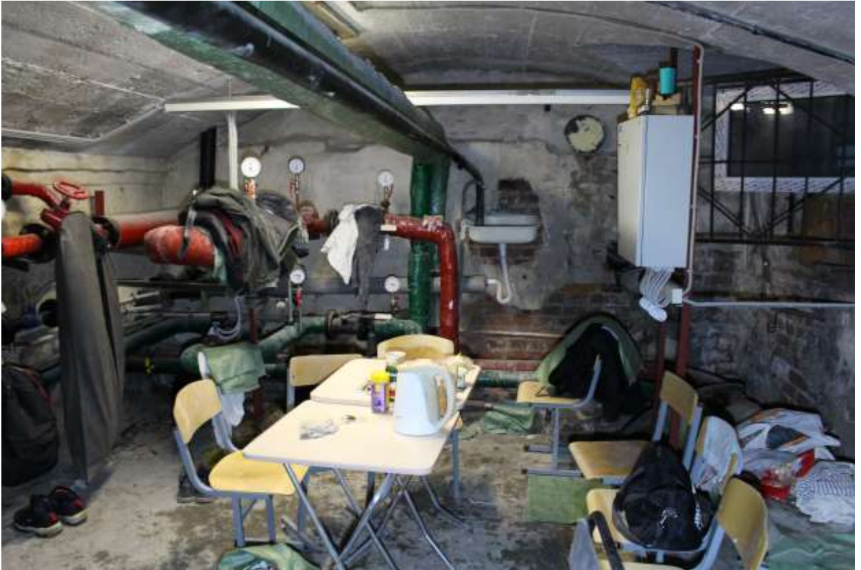
54. Выявленный объект культурного наследия «Городской дом 1-го Василеостровского начального народного училища». Вид на теплоцентр в подвальном помещении.
