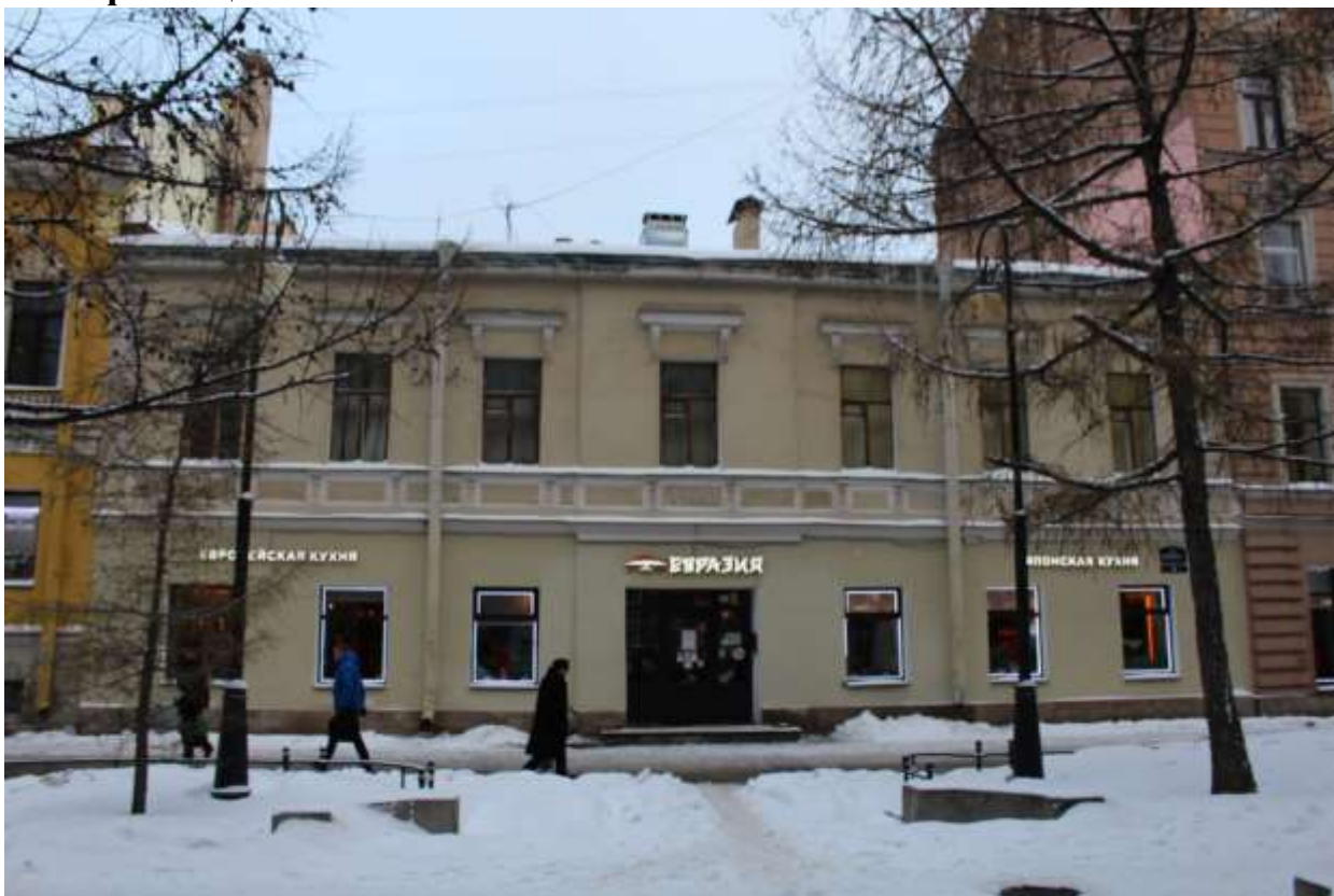
1. Выявленный объект культурного наследия «Дом В.И. Миллера». Вид на юго-западный фасад.
