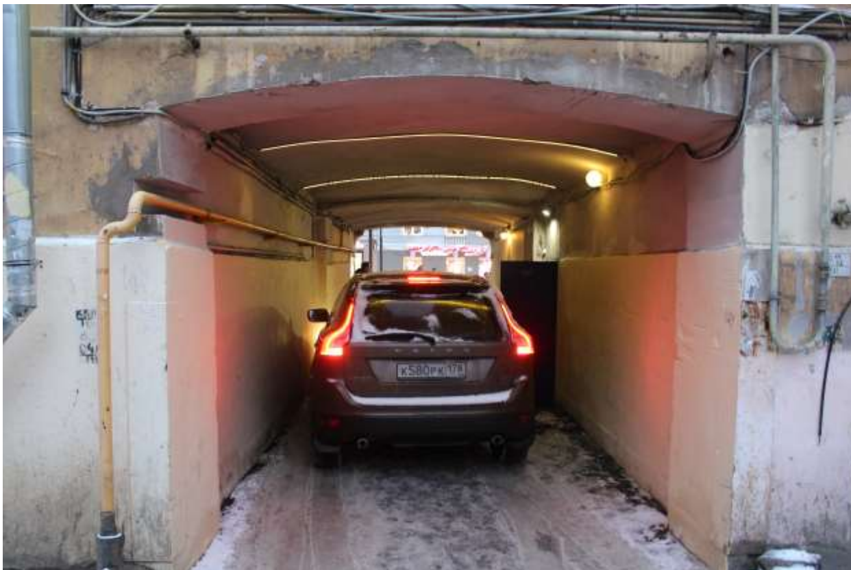
23. Выявленный объект культурного наследия «Дом К. Штрауха». Вид на арку воротного проезда.
