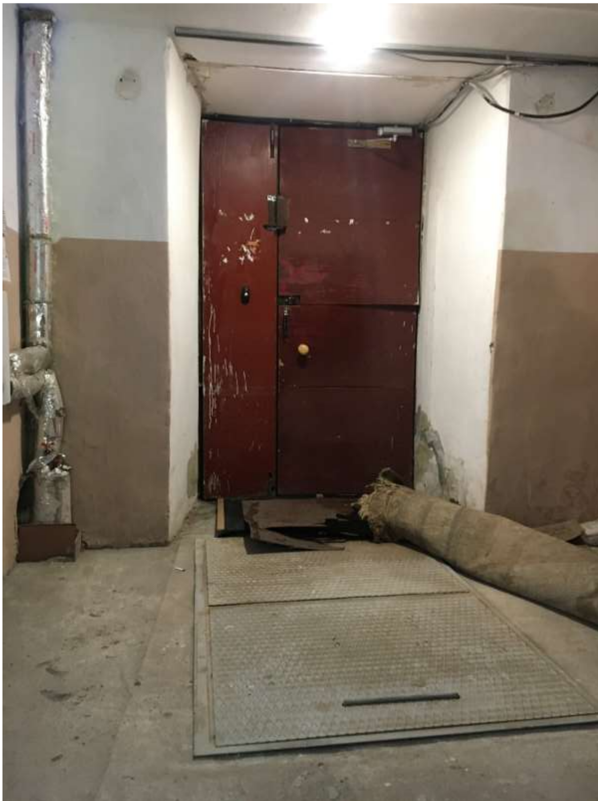
37. Выявленный объект культурного наследия «Дом В.А. Квасникова». Лестничная клетка отдельно стоящего дворового корпуса, вид на люк подпольного канала.
