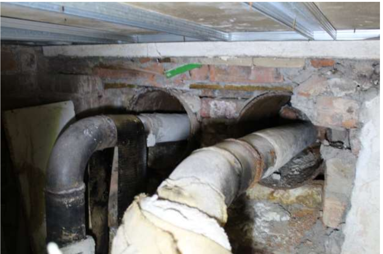
51. Выявленный объект культурного наследия «Городской дом 1-го Василеостровского начального народного училища». Подвальное помещение, вид на ввод теплосети.
