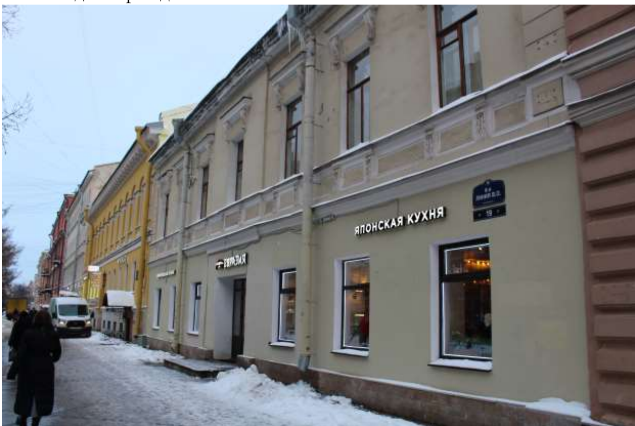
4. Выявленный объект культурного наследия «Дом В.И. Миллера». Вид на юго-западный фасад.
