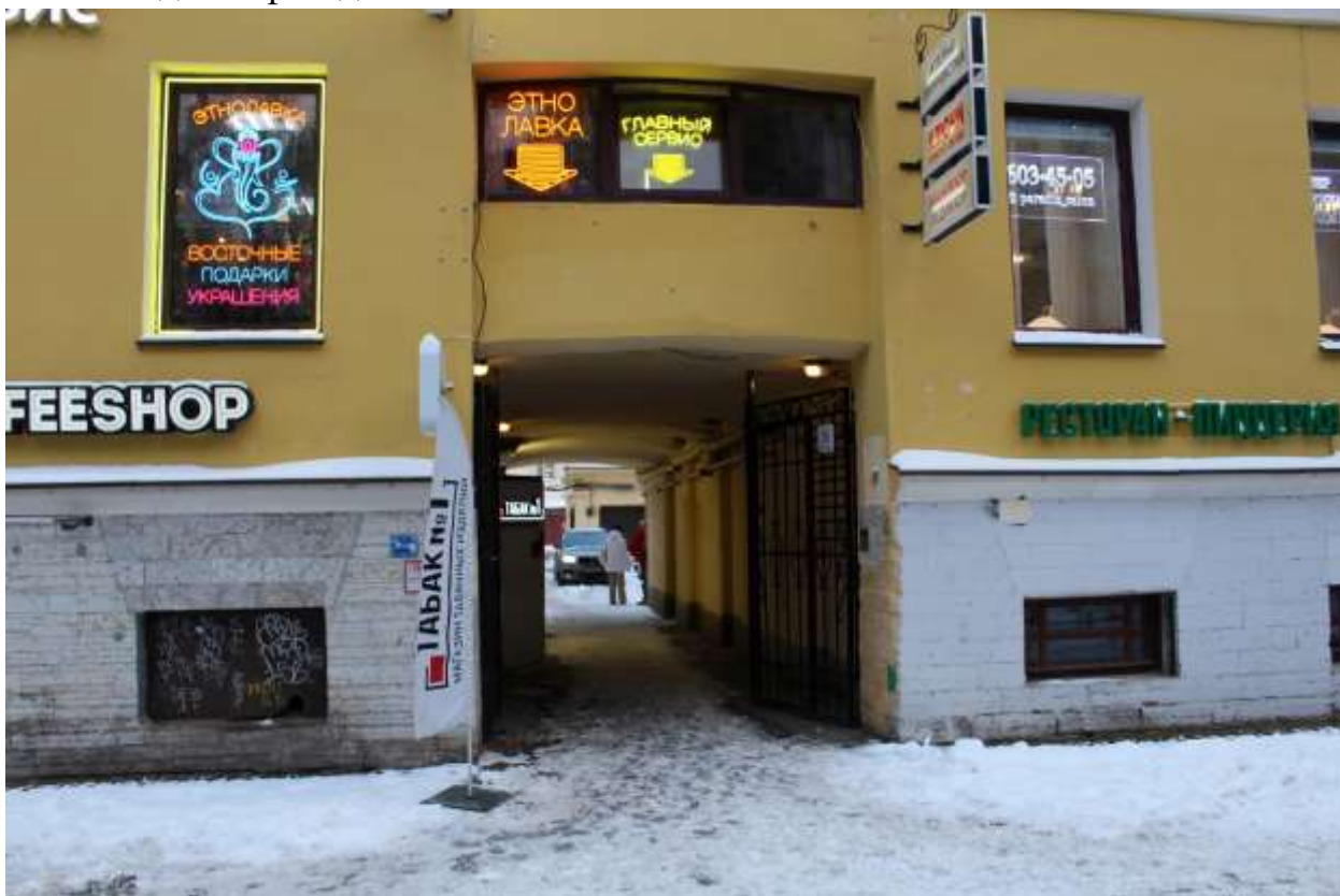
14. Выявленный объект культурного наследия «Дом И. Ковригина». Вид на арку воротного проезда.
