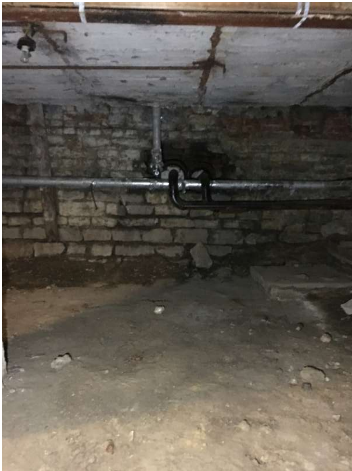
77. Выявленный объект культурного наследия «Богадельня для женщин». Вид на ввод теплосети в подвальном помещении.
