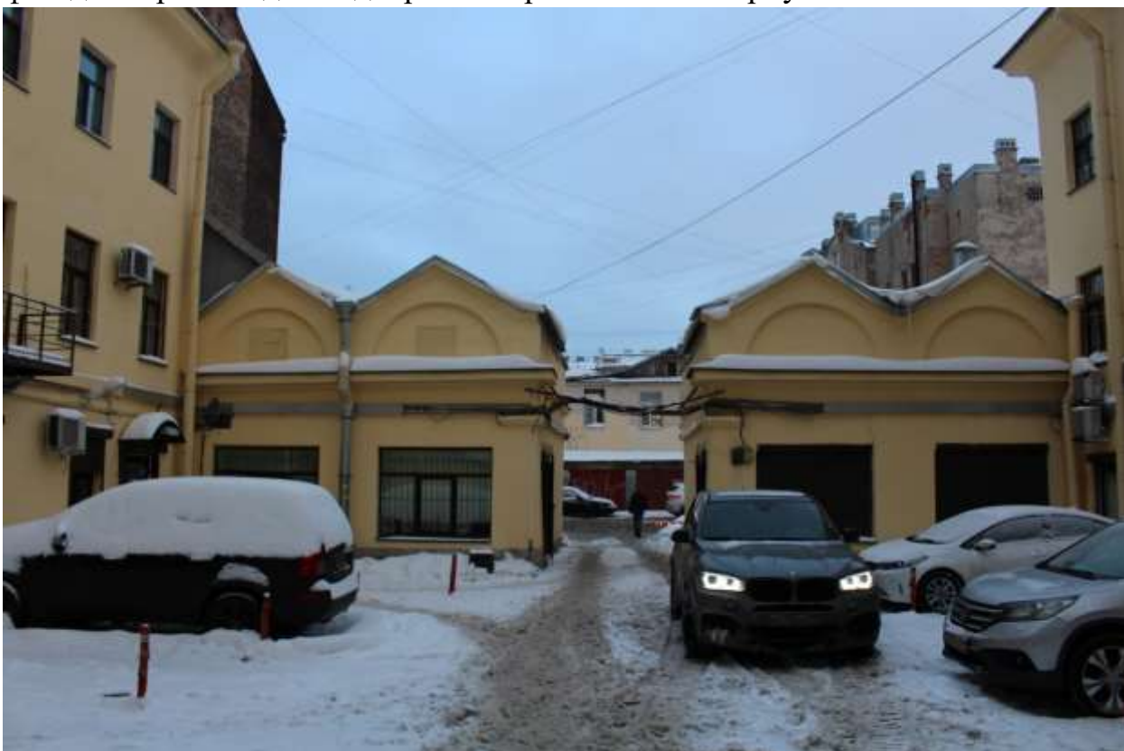
18. Выявленный объект культурного наследия «Дом И. Ковригина». Вид на юго-западный фасад одноэтажных корпусов.
