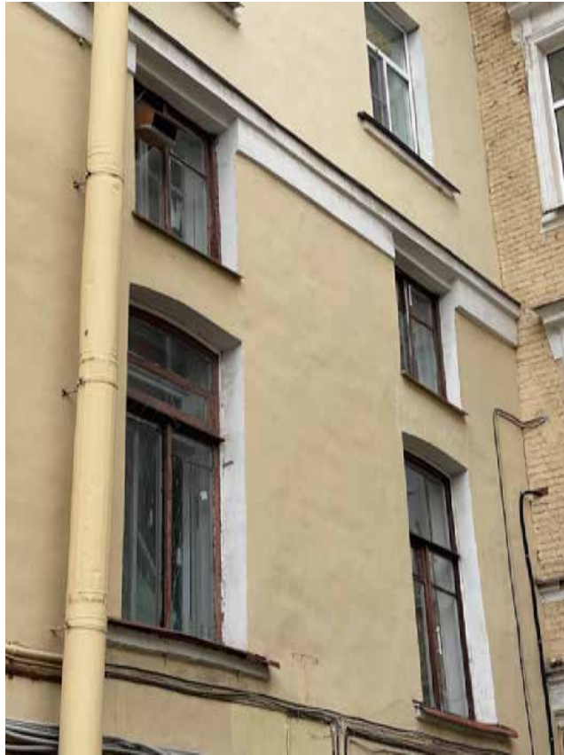
17. Дворовый фасад лицевого корпуса в световых осях 12, 13 в уровне 2 этажа. Выявленный объект культурного наследия «Дом Ю. Н. Адельсон», расположенный по адресу: г. Санкт-Петербург, Гороховая ул, дом 33, литера А
