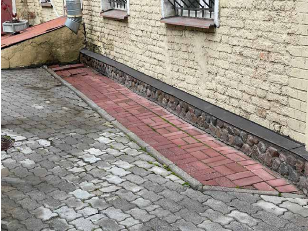
33. Дворовый корпус, второй двор (фрагмент цоколя). Выявленный объект культурного наследия «Дом Ю. Н. Адельсон», расположенный по адресу: г. Санкт-Петербург, Гороховая ул, дом 33, литера А
