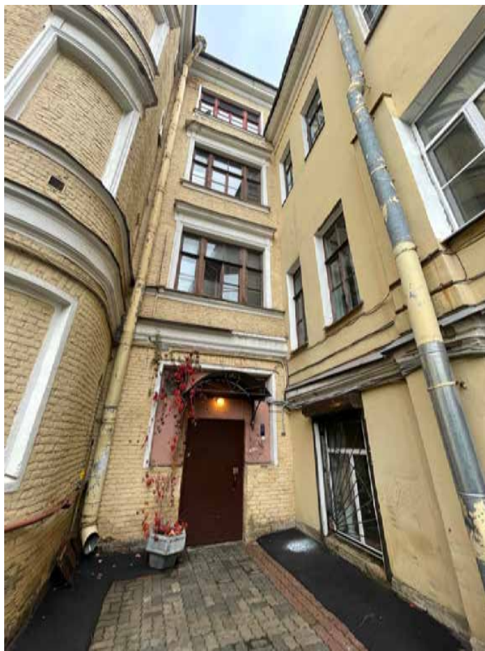
20. Дворовый фасад лицевого корпуса (фрагмент по световым осям 1, 2). Дворовый корпус в месте примыкания к лицевому. Выявленный объект культурного наследия «Дом Ю. Н. Адельсон», расположенный по адресу: г. Санкт-Петербург, Гороховая ул, дом 33, литера А
