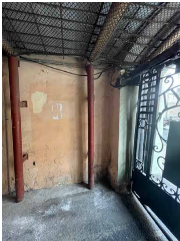
36. Проездная арка лицевого корпуса (фрагмент). Выявленный объект культурного наследия «Дом Ю. Н. Адельсон», расположенный по адресу: г. Санкт-Петербург, Гороховая ул, дом 33, литера А
