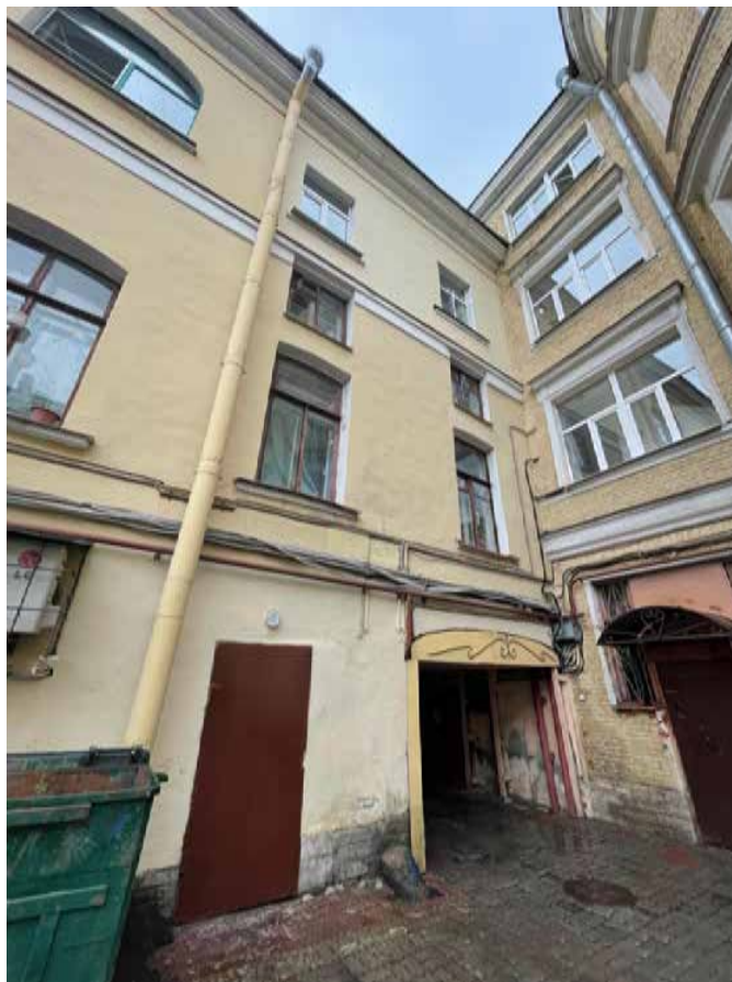
14. Дворовый фасад лицевого корпуса (фрагмент по световым осям 12–13). Дворовый корпус в месте примыкания к лицевому. Выявленный объект культурного наследия «Дом Ю. Н. Адельсон», расположенный по адресу: г. Санкт-Петербург, Гороховая ул, дом 33, литера А
