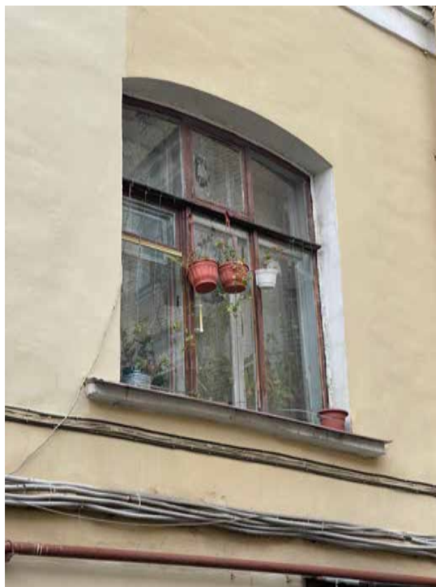
16. Дворовый фасад лицевого корпуса. Деревянное заполнение оконного проема с лучковым завершением по световой оси 11 в уровне 2 этажа. Выявленный объект культурного наследия «Дом Ю. Н. Адельсон», расположенный по адресу: г. Санкт-Петербург, Гороховая ул, дом 33, литера А
