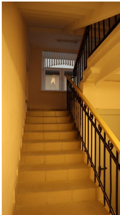
Фото 1.22. 1 этаж, лестница, помещение 1Н
