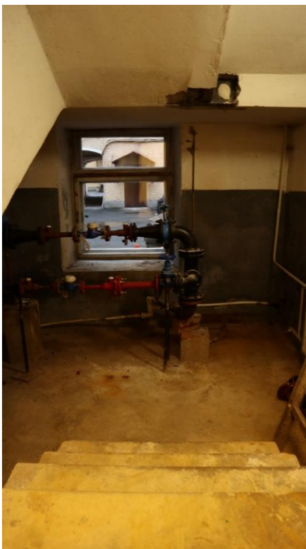
Фото 1.4. 1 этаж, помещение 1Н (9).
