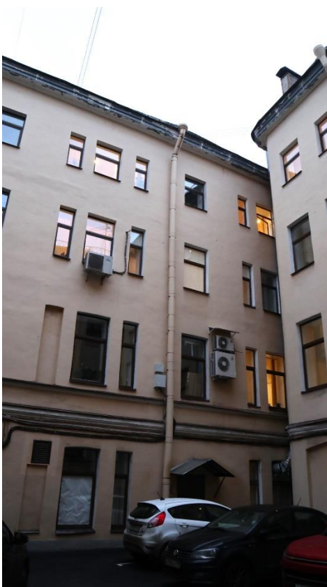
Фото 18. Дворовый фасад здания, фрагмент, вид на запад.
