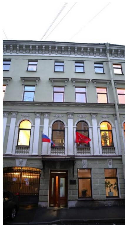
Фото 2. Лицевой фасад с переулка Антоненко, фрагмент.
