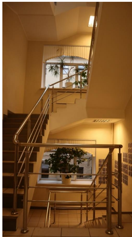
Фото 2.2. 2 этаж, лестница, помещение 1Н (63).
