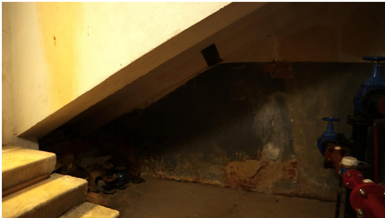
Фото 1.6. 1 этаж, помещение 1Н (9).
