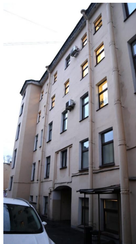
Фото 8. Восточный (дворовой) фасад здания, фрагмент.
