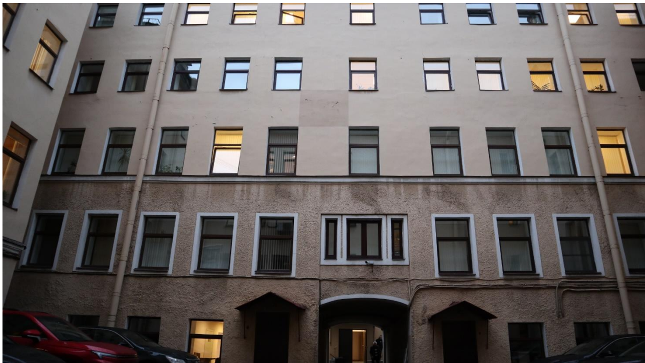
Фото 15. Дворовый фасад здания, фрагмент, вид на северо-восток.
