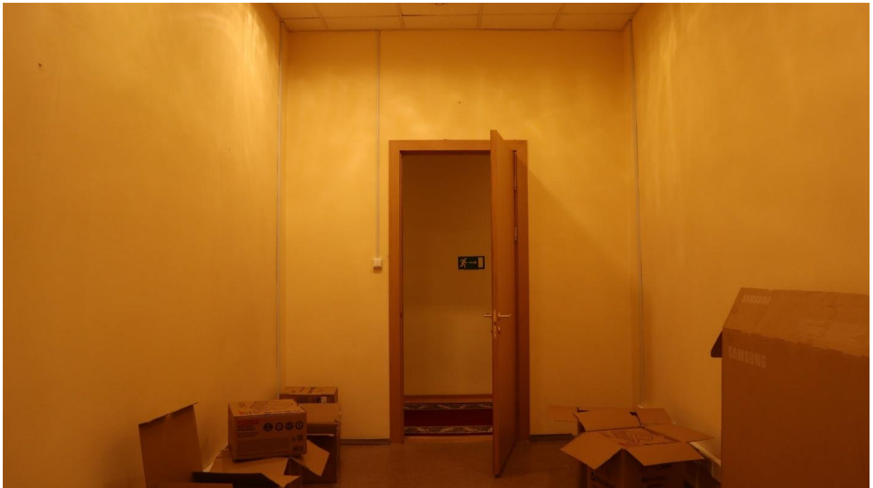
Фото 2.20. 2 этаж, помещение 1Н (67).
