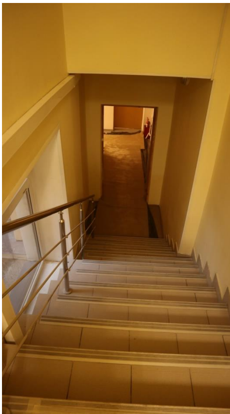
Фото 3.54. 3 этаж, помещение 1Н (158).
