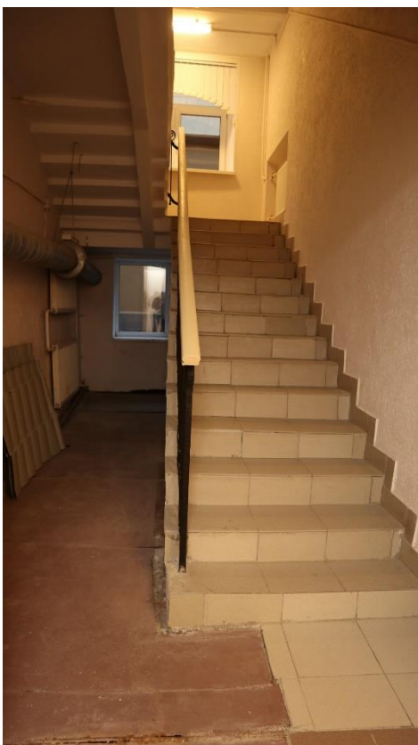
Фото 1.31. 1 этаж, помещение 1Н (33).
