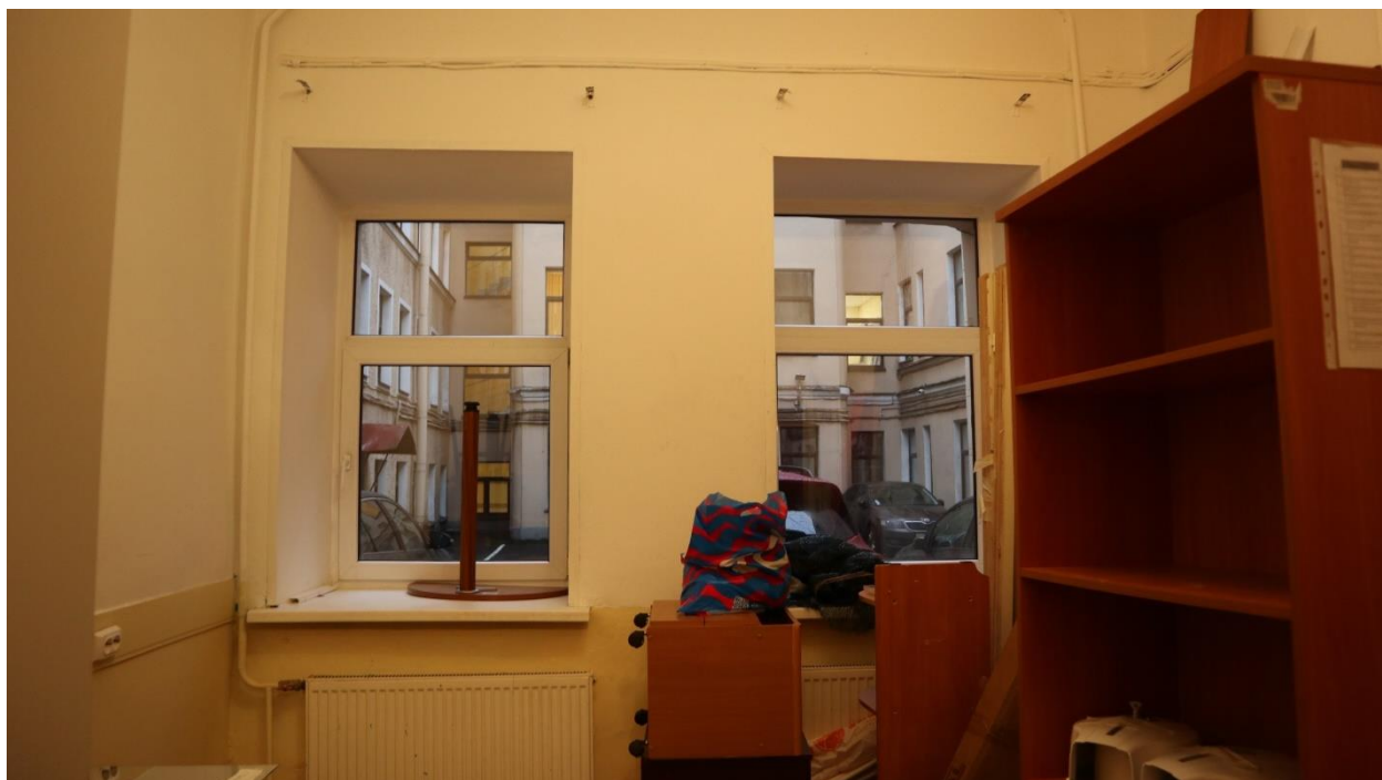
Фото 1.35. 1 этаж, помещение 1Н (44).
