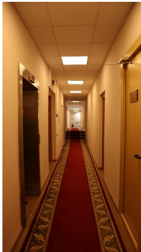
Фото 2.39. 2 этаж, помещение 1Н (87).
