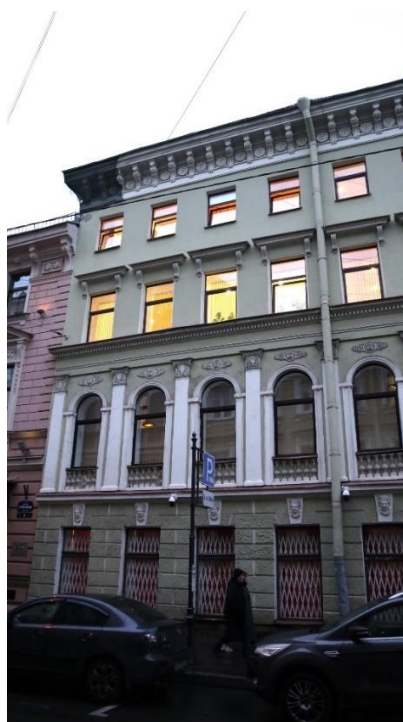
Фото 3. Лицевой фасад с переулка Антоненко, фрагмент.
