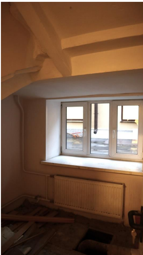
Фото 1.21. 1 этаж, помещение 1Н (22). (22).
