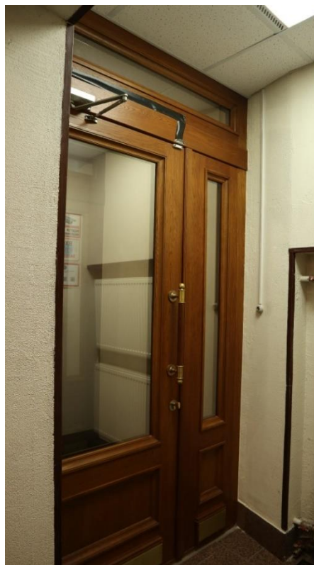
Фото 1.12. 1 этаж, помещение 1Н (2).
