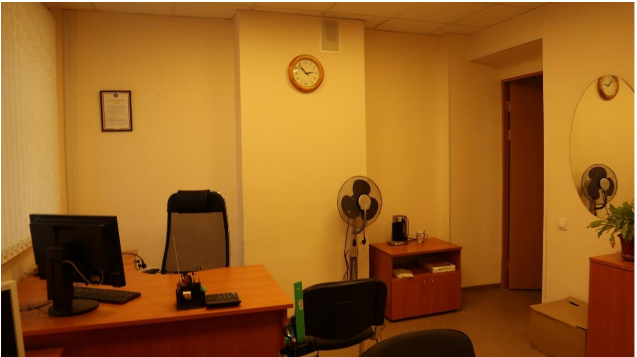
Фото 4.24. 4 этаж, помещение 1Н (202).
