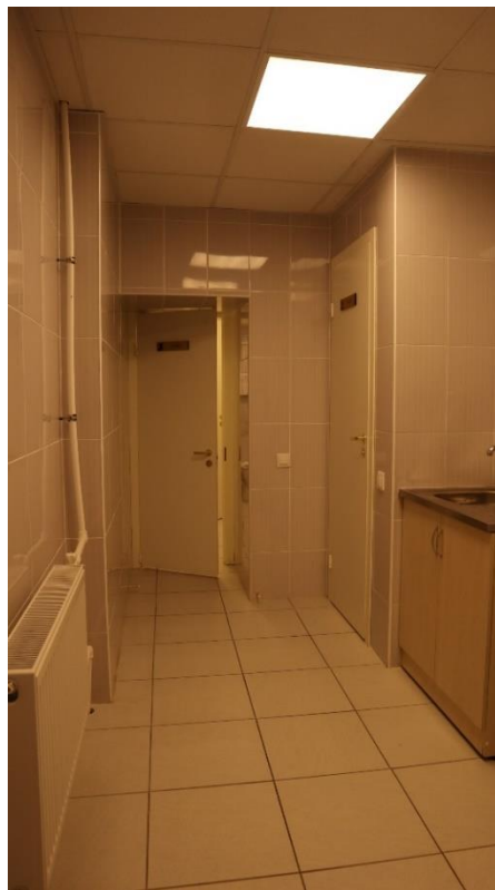
Фото 5.2. 5 этаж, помещение 1Н (236).
