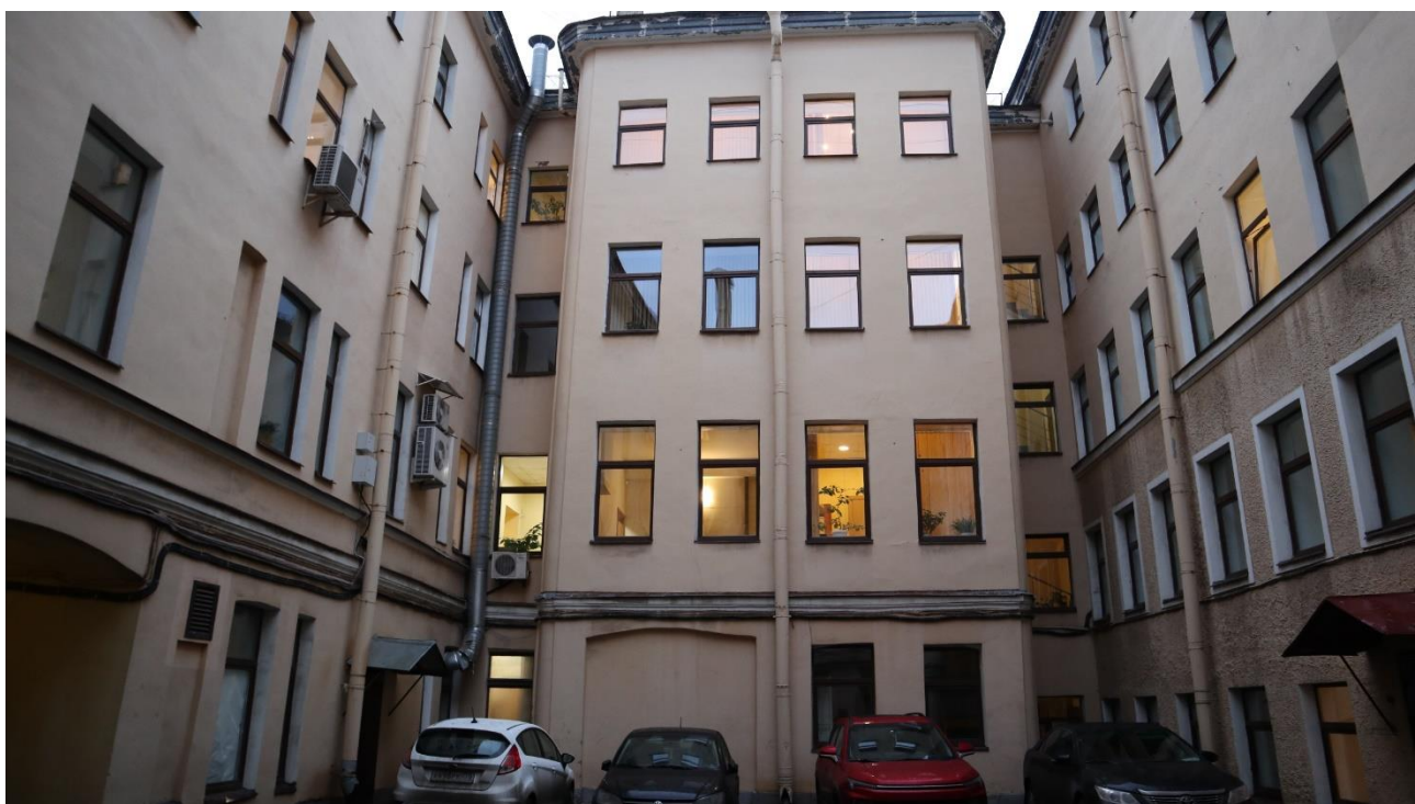
Фото 14. Дворовый фасад здания, фрагмент, вид на северо-запад.
