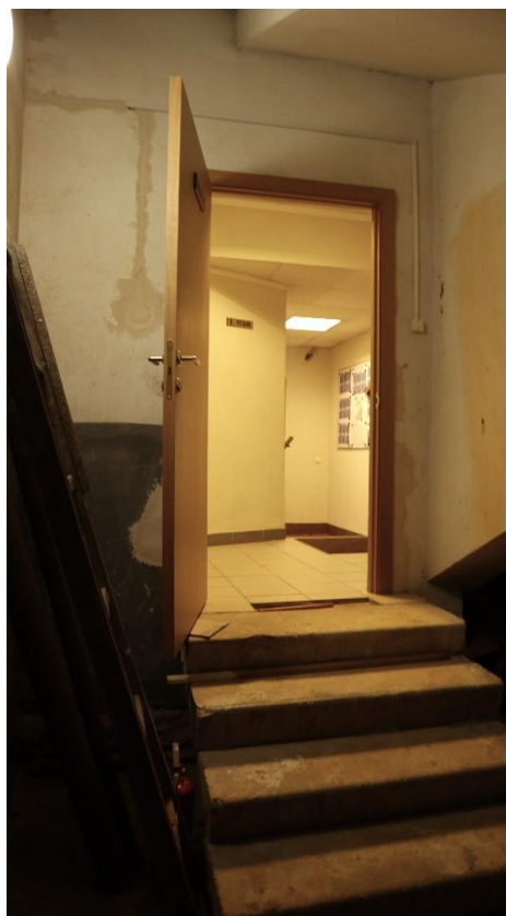
Фото 1.5. 1 этаж, помещение 1Н (9).
