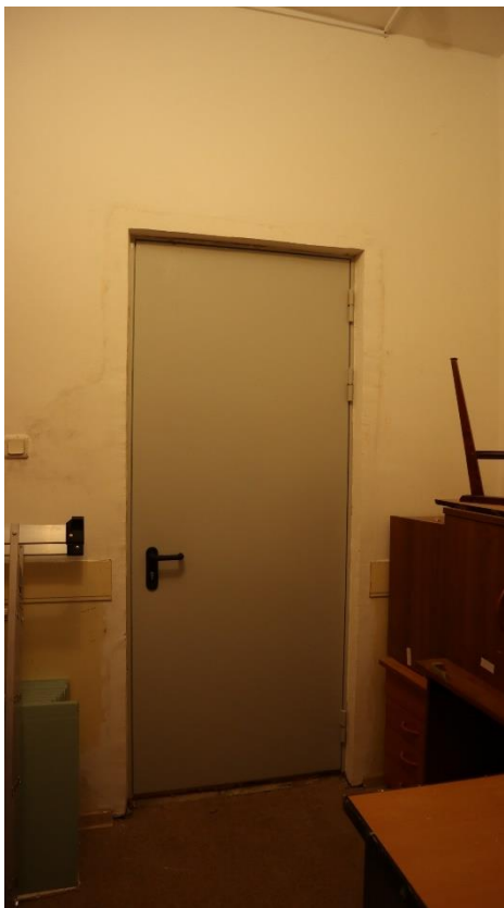
Фото 1.36. 1 этаж, помещение 1Н (44).
