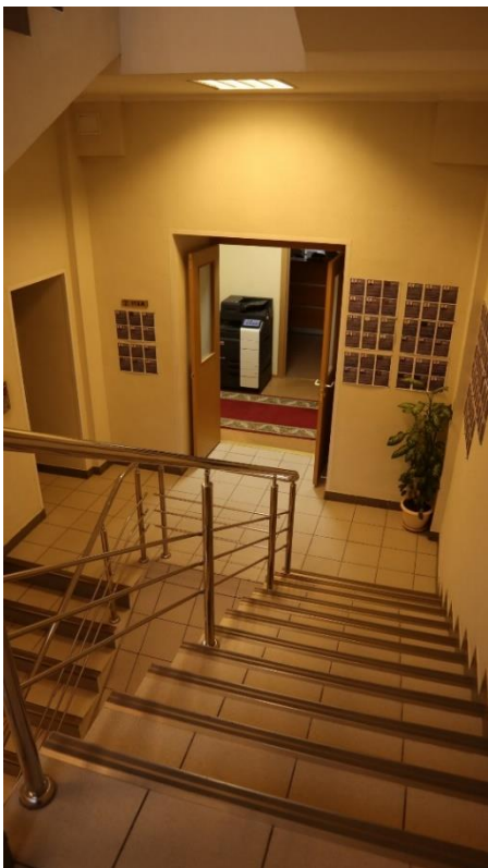
Фото 2.1. 2 этаж, лестница, помещение 1Н (63).
