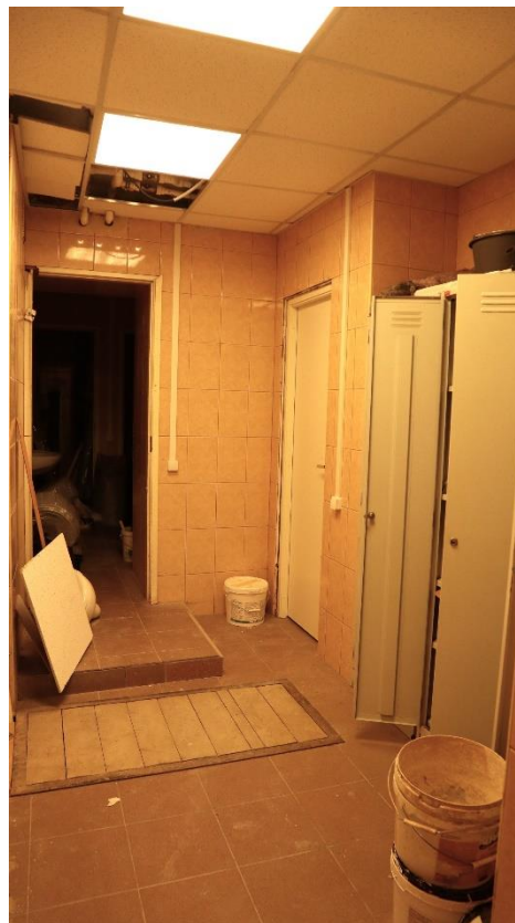
Фото 1.34. 1 этаж, помещение 1Н (37).
