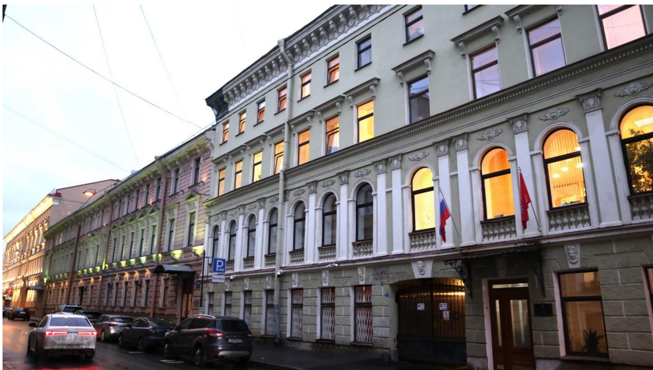
Фото 5. Лицевой фасад с переулка Антоненко, фрагмент.
