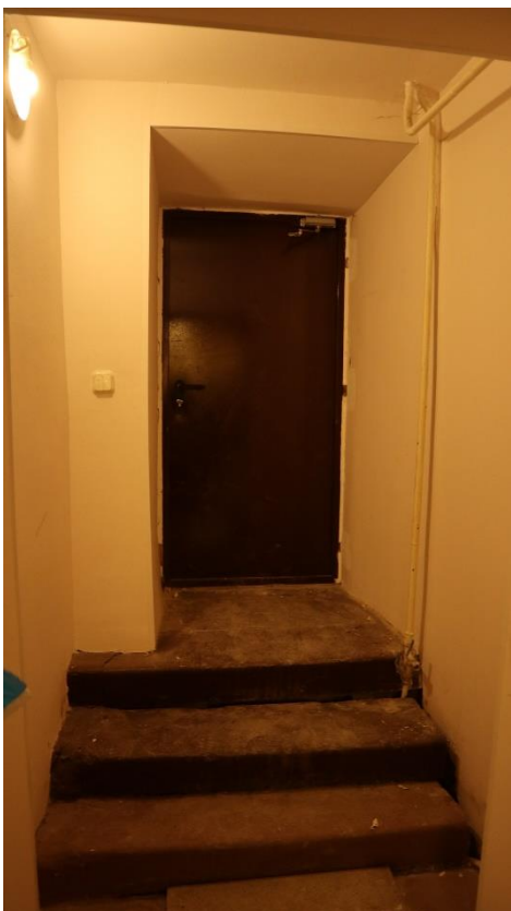
Фото 1.23. 1 этаж, помещение 1Н (27).
