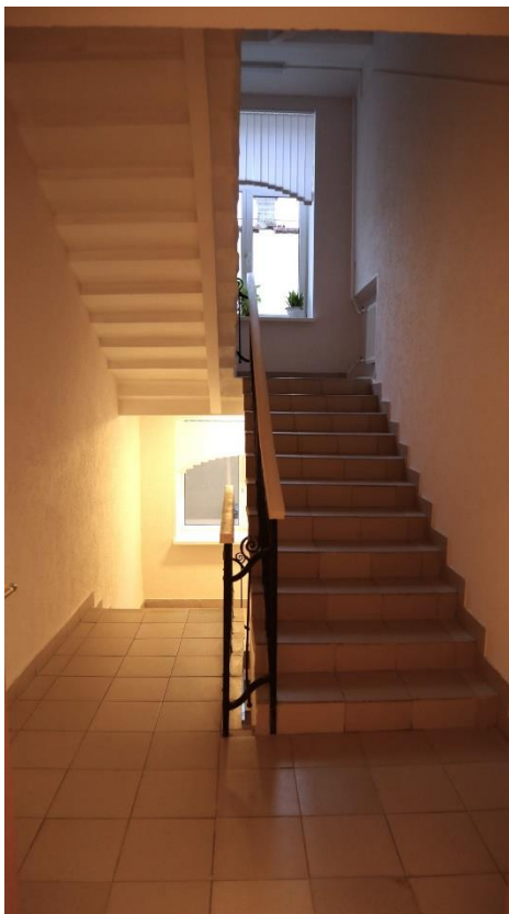
Фото 2.42. 2 этаж, лестница, помещение 1Н (85).
