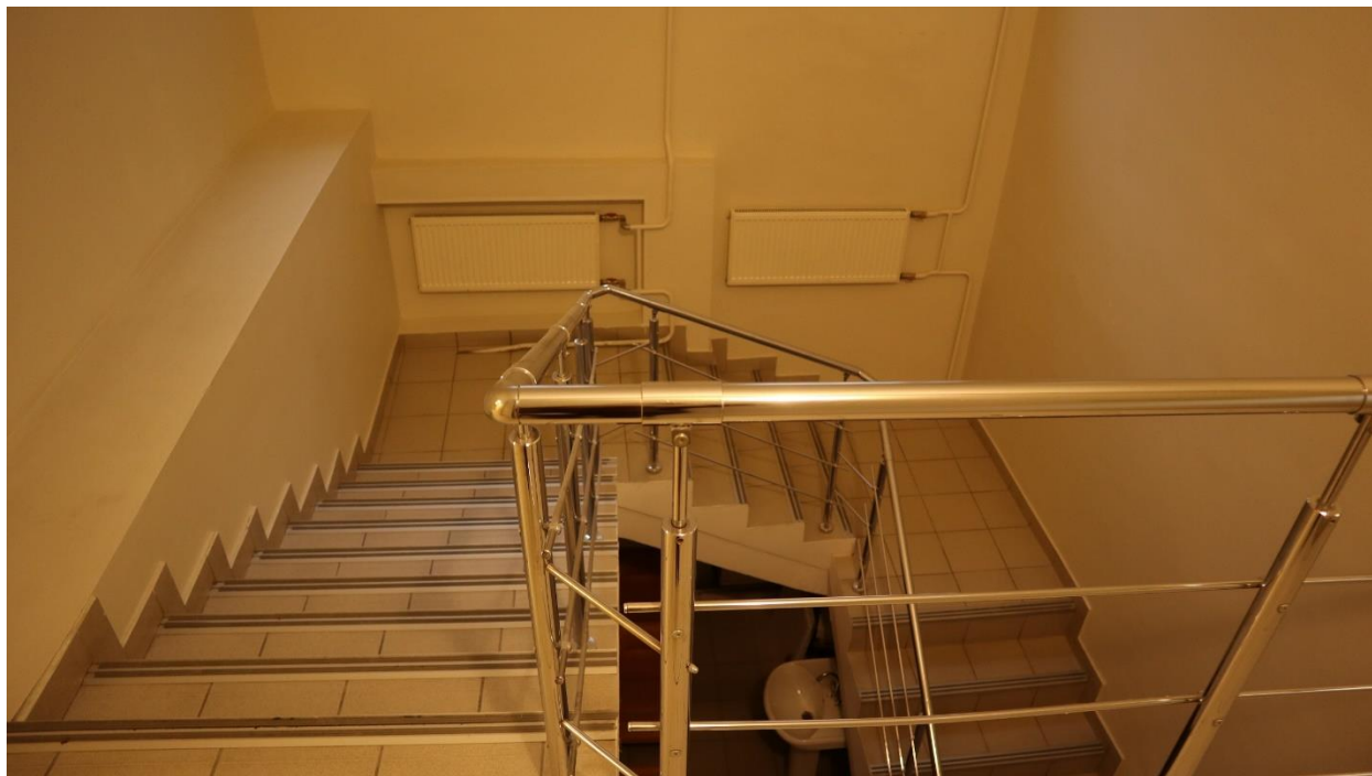
Фото 2.33. 2 этаж, лестница, помещение 1Н (78).
