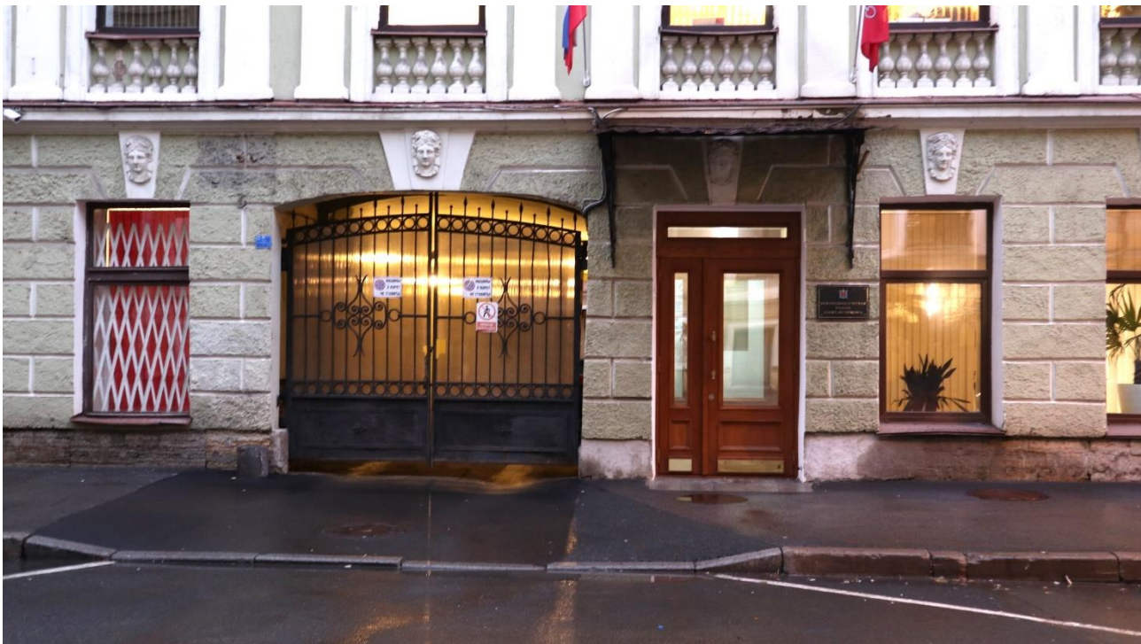
Фото 6. Лицевой фасад с переулка Антоненко, фрагмент.
