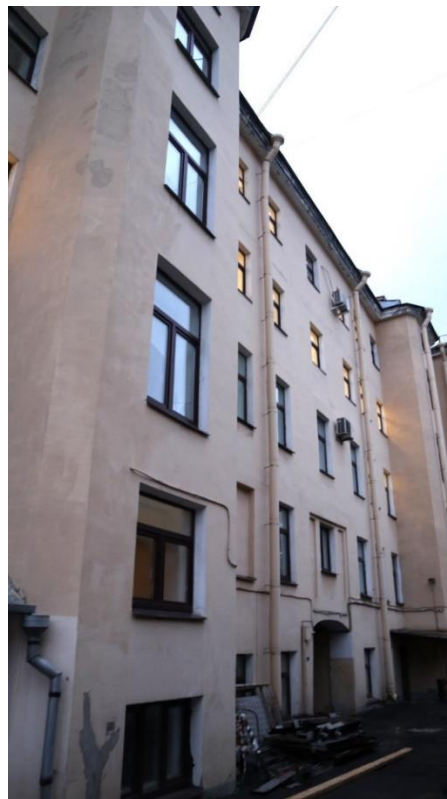
Фото 10. Восточный (дворовый) фасад здания, фрагмент.
