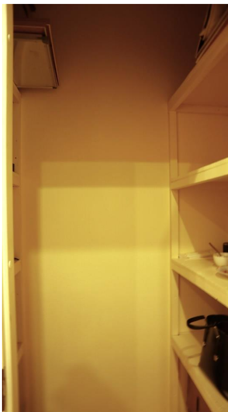
Фото 3.11. 3 этаж, помещение 1Н (171-172).
