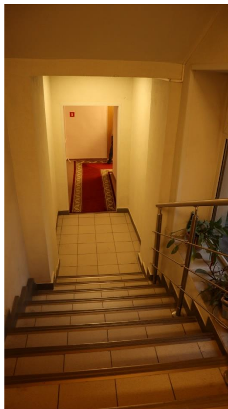
Фото 2.37. 2 этаж, помещение 1Н (79).
