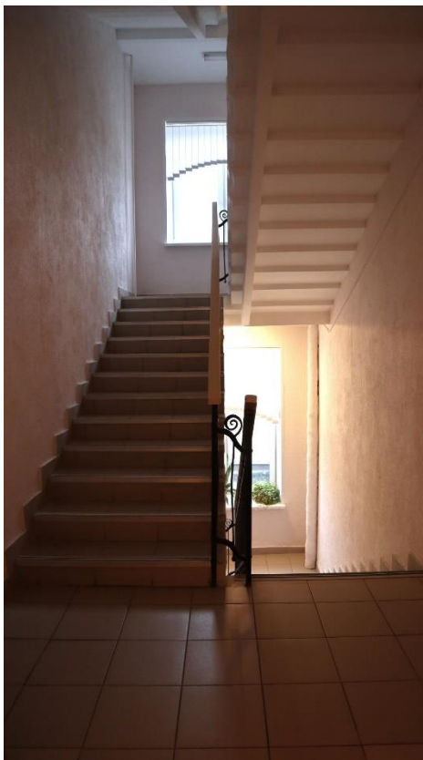
Фото 4.18. 4 этаж, лестница, помещение 1Н (201).
