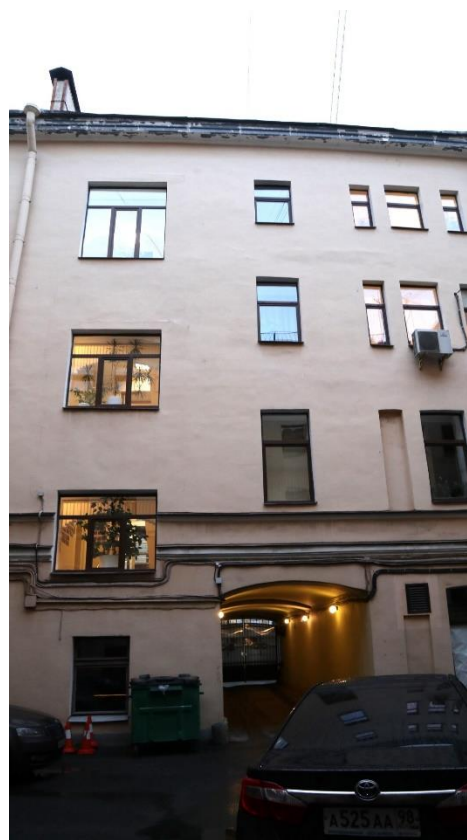
Фото 19. Дворовый фасад здания, фрагмент, вид на запад.
