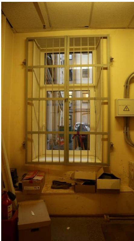
Фото 1.16. 1 этаж, помещение 1Н (15).
