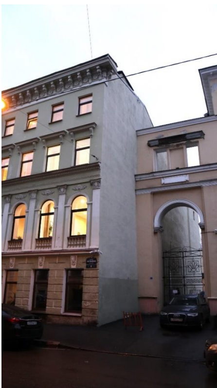
Фото 7. Лицевой фасад с переулка Антоненко, фрагмент.
