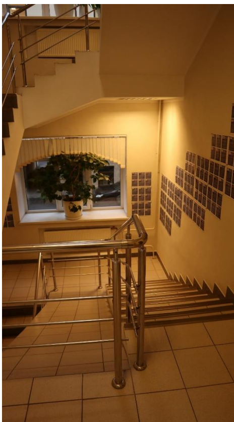
Фото 2.3. 2 этаж, лестница, помещение 1Н (63).
