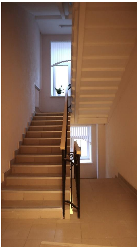
Фото 2.64. 2 этаж, лестница, помещение 1Н (96).
