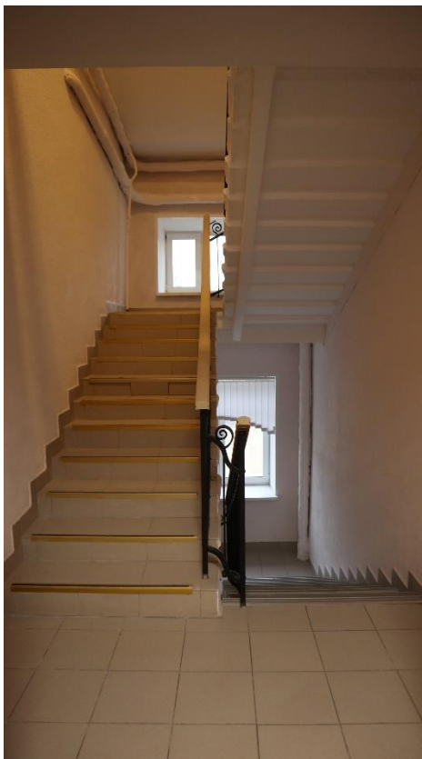
Фото 5.23. 5 этаж, лестница, помещение 1Н (226).
