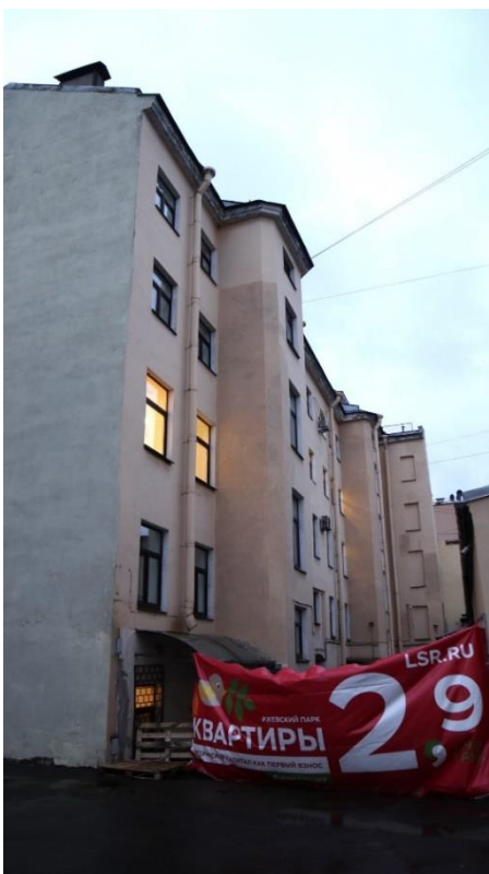
Фото 11. Восточный (дворовый) фасад здания, фрагмент.
