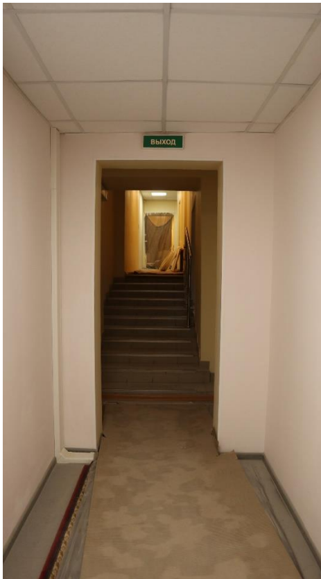
Фото 2.55. 2 этаж, помещение 1Н (102).
