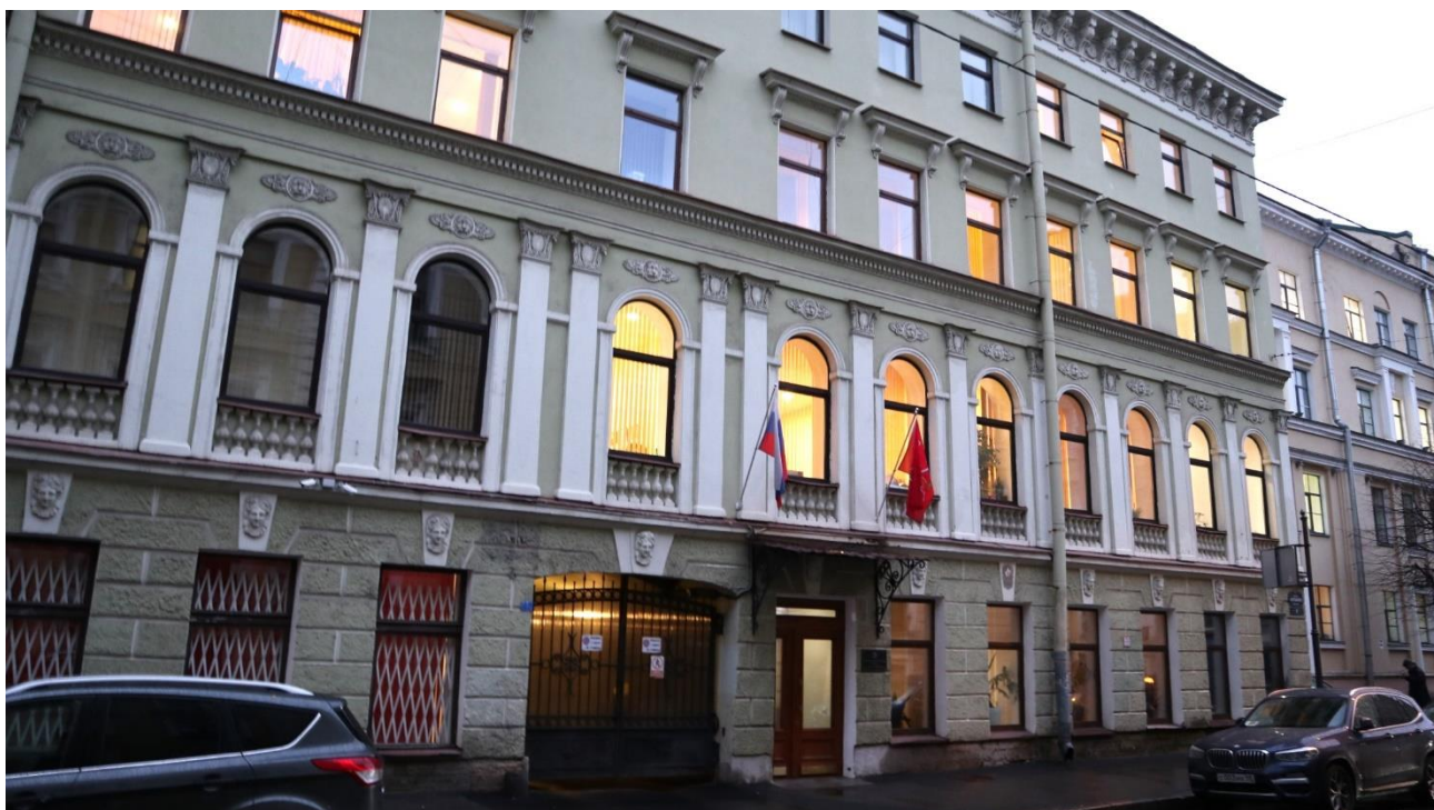
Фото 4. Лицевой фасад с переулка Антоненко, фрагмент.
