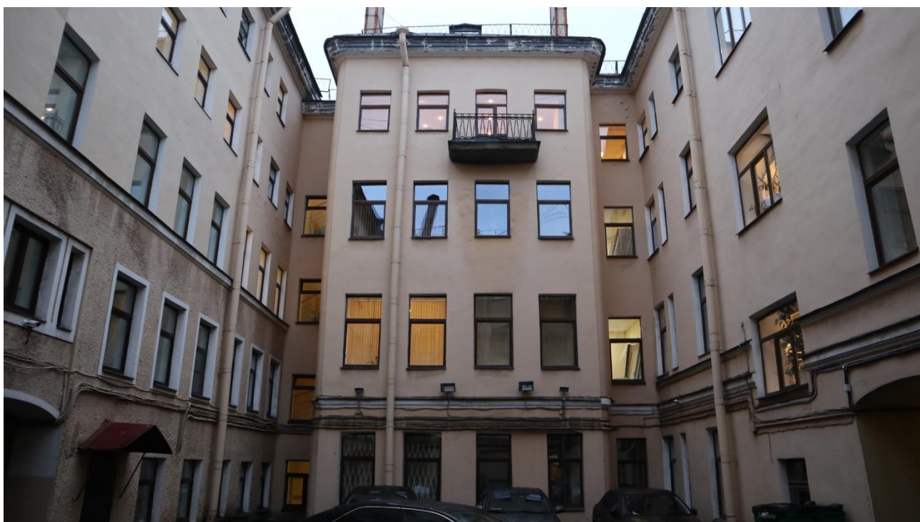
Фото 16. Дворовый фасад здания, фрагмент, вид на юго-восток.
