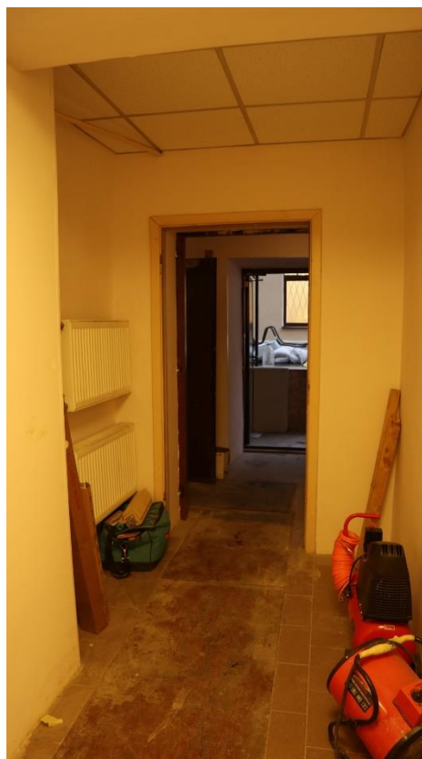
Фото 1.20. 1 этаж, помещение 1Н (19).
