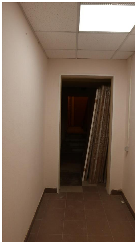
Фото 1.32. 1 этаж, помещение 1Н (40).
