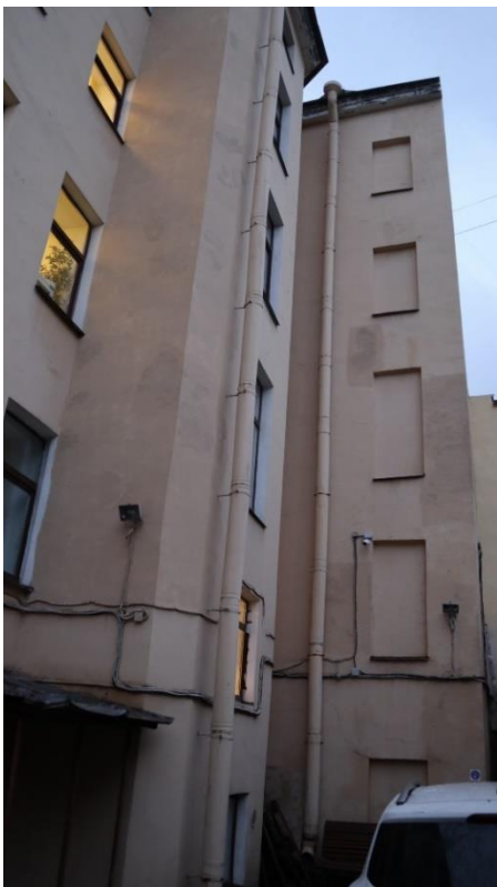
Фото 9. Восточный (дворовый) фасад здания, фрагмент.
