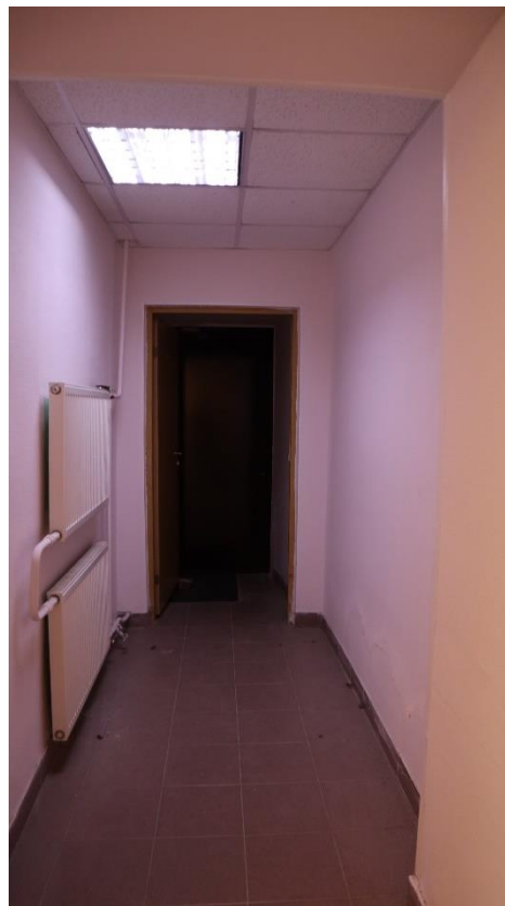
Фото 1.30. 1 этаж, помещение 1Н (32).
