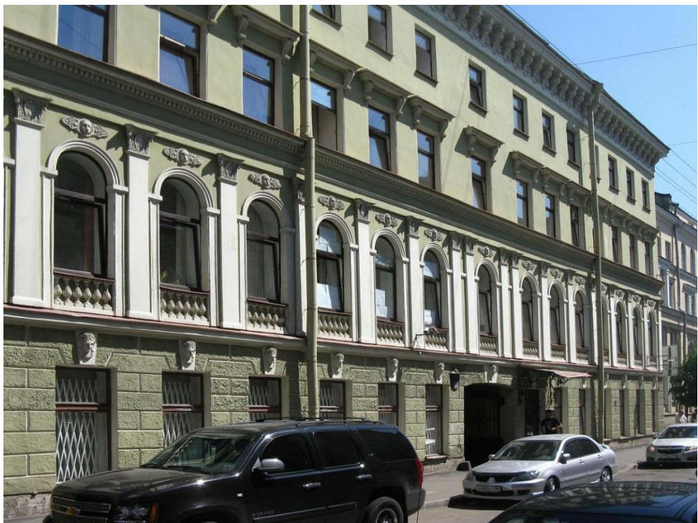
63. Общий вид здания по переулку Антоненко, 6. 2022 г.
