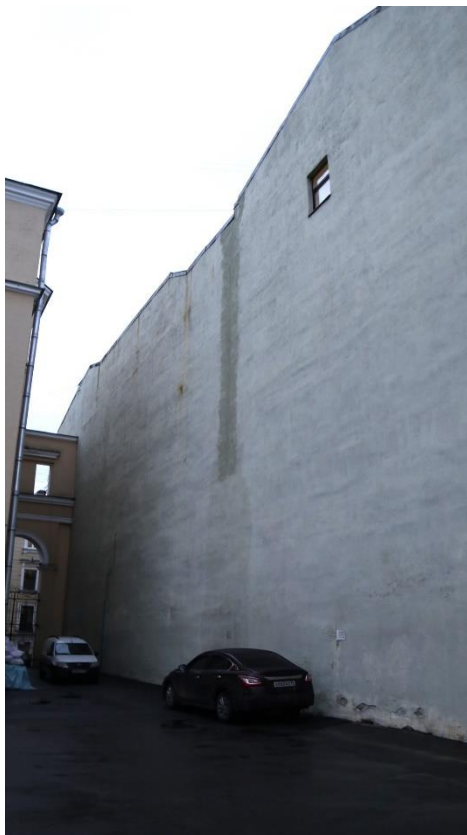
Фото 13. Южный фасад здания (брандмауэр), фрагмент.
