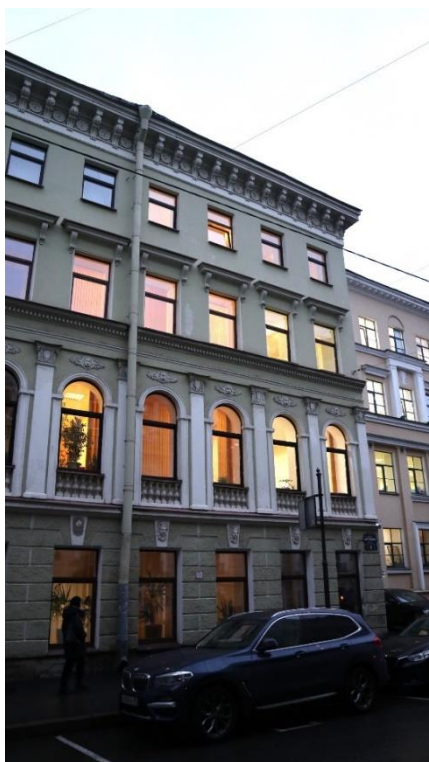
Фото 1. Лицевой фасад с переулка Антоненко, фрагмент.
