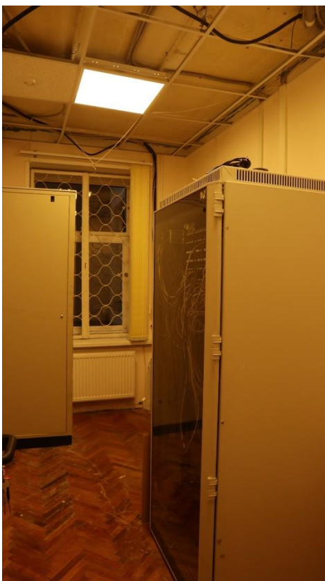
Фото 2.40. 2 этаж, помещение 1Н (88).
