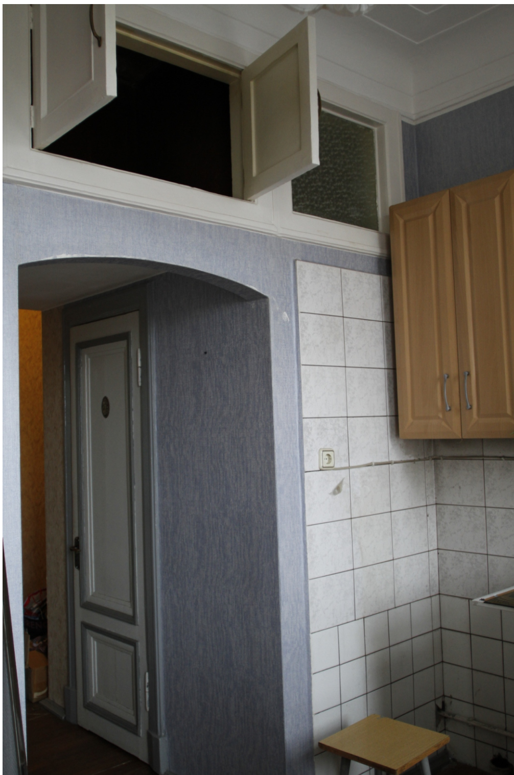
20. «Жилой дом театральных работников». Санкт-Петербург, Бородинская ул., дом 13, лит. А. Фрагмент помещения кв.№ 11. Кухня. Фото: 18.12.2023.
