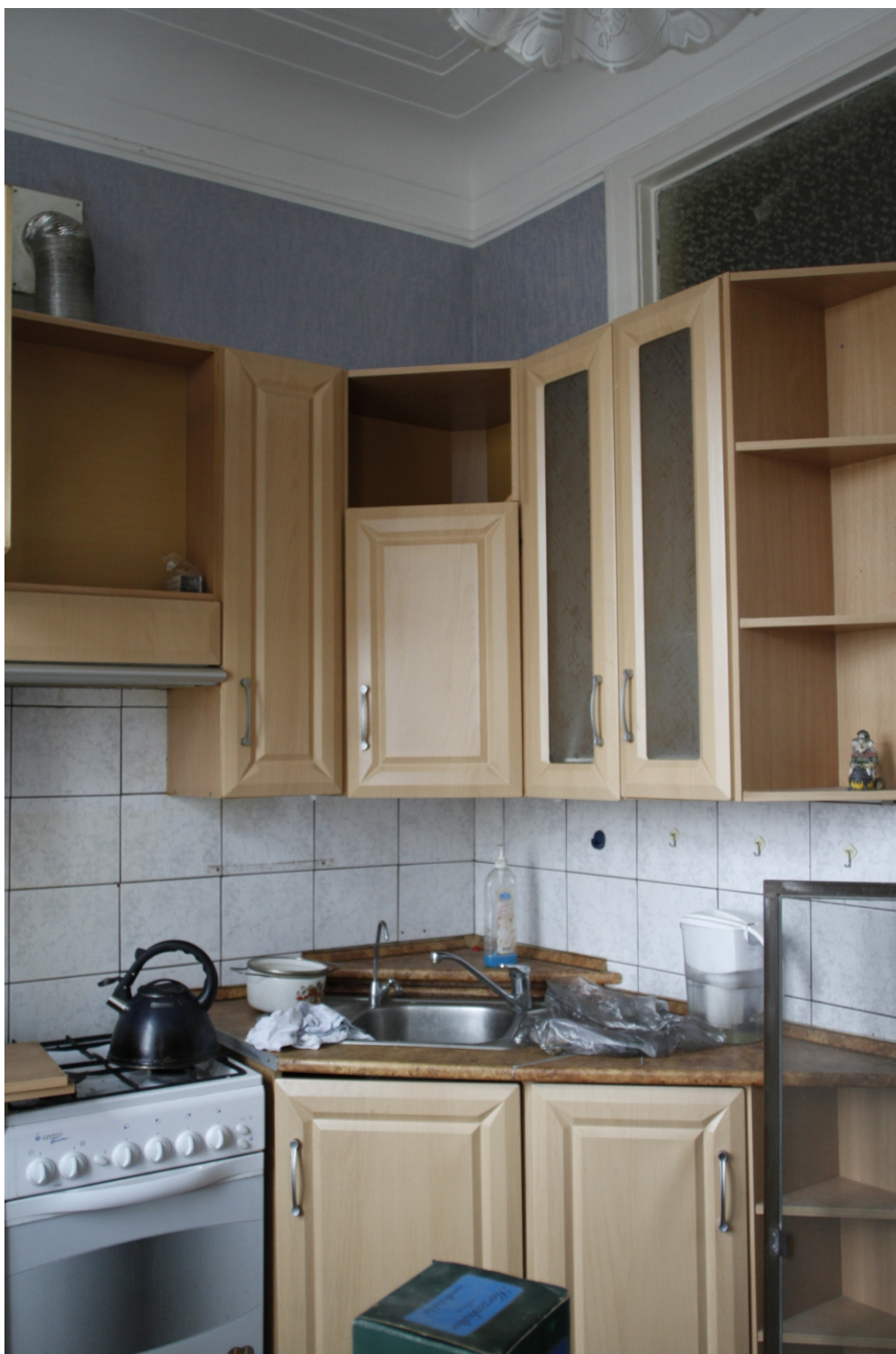
21. «Жилой дом театральных работников». Санкт-Петербург, Бородинская ул., дом 13, лит. А. Фрагмент помещения кв.№ 11. Кухня. Фото: 18.12.2023.
