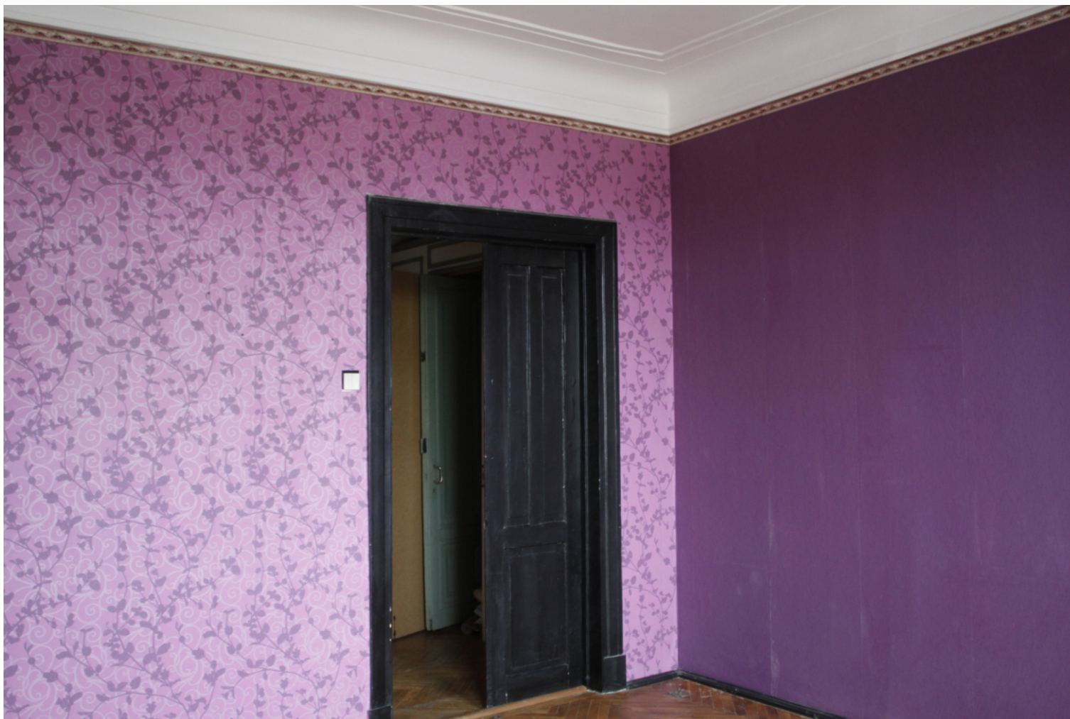
17. «Жилой дом театральных работников». Санкт-Петербург, Бородинская ул., дом 13, лит. А. Фрагмент помещения кв.№ 11. Комната. Фото: 18.12.2023.
