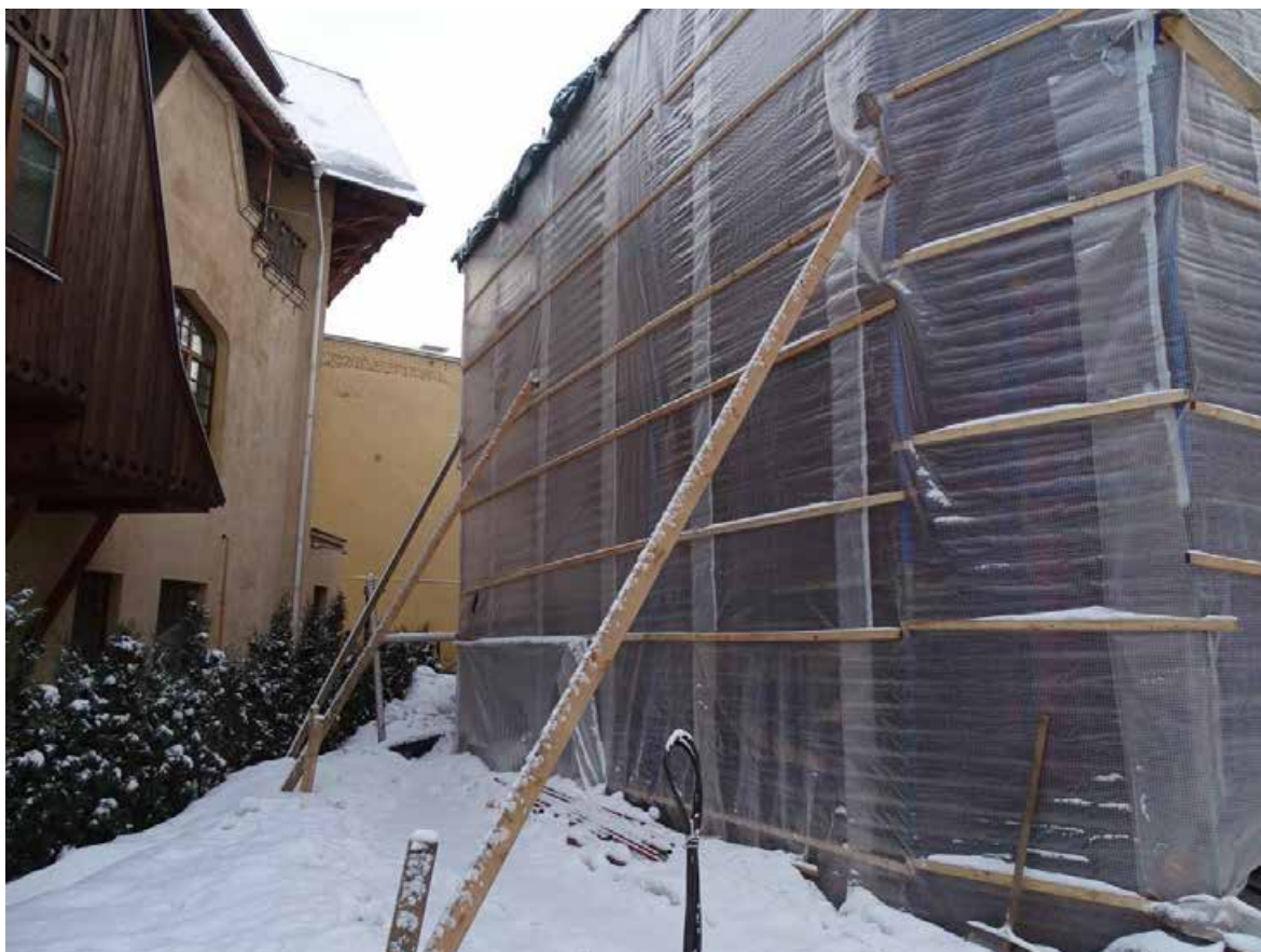
Илл. 9. Дом Гоце Г.И. Северный фасад. Противоаварийные работы. Служебный флигель. Фрагмент. Съемка 26.12.2023 г. Трушковский В.Э.
