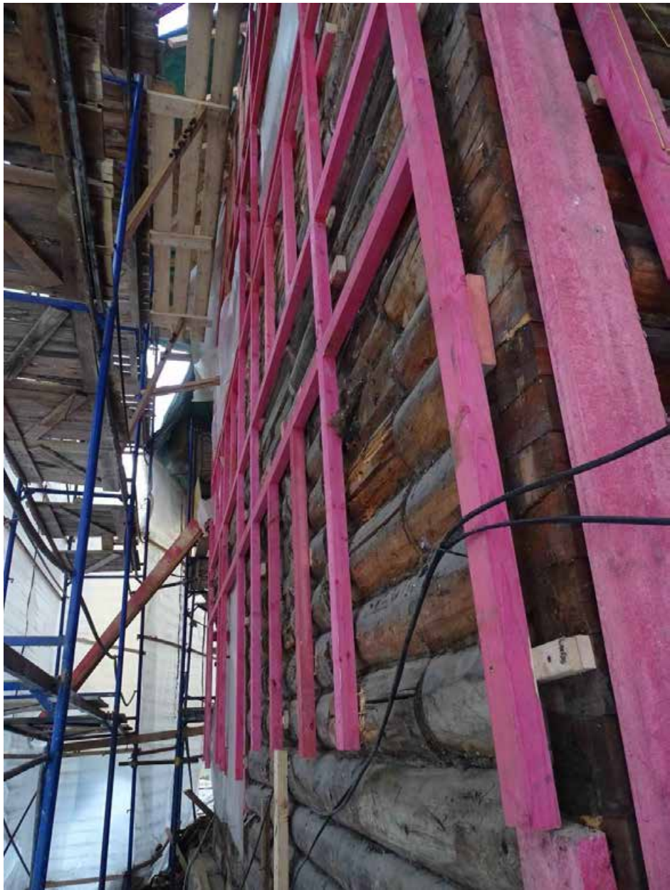
Илл. 10. Дом Гоце Г.И. Северный фасад. Фрагмент. Противоаварийные работы. Съемка 26.12.2023 г. Трушковский В.Э.
