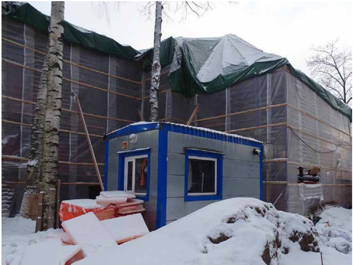
Илл. 7. Дом Гоze Г.И. Западный фасад. Противоаварийные работы. Съемка 26.12.2023 г. Трушковский В.Э.
