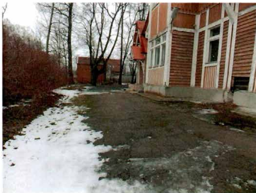
Фото 21. Вид территории объекта культурного наследия с юго-востока.
