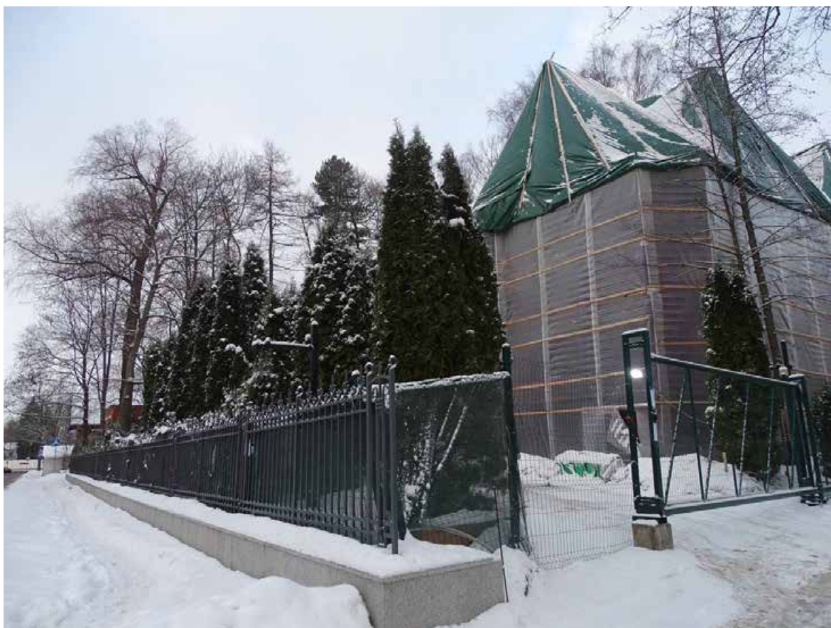
Илл. 4. «Дом Гоце с участком парка». Вид с Боковой аллеи на западную часть объекта культурного наследия. Съемка 26.12.2023 г. Трушковский В.Э.
