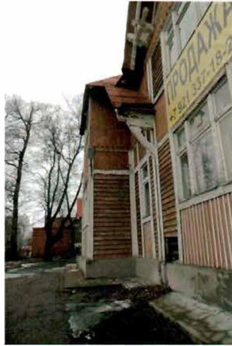
Фото 6. Фрагмент южного фасада.
