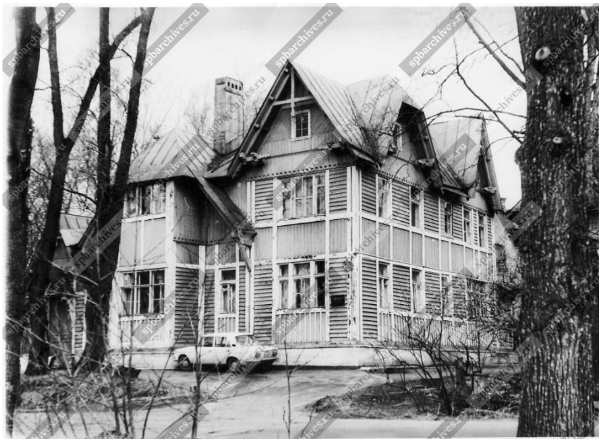
Илл. 36. Общий вид деревянного дачного дома по Боковой аллее, 11. 20.04.1981 г. Фото К. В. Овчинникова. ЦГАКФФД СПб. Фотодокумент Ар 226091
