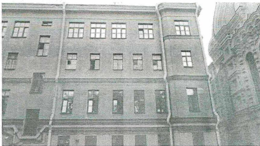
8. Фрагмент западного фасада объекта культурного наследия.
