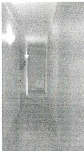
11. Внутренняя планировочная структура объекта культурного наследия. Помещение третьего этажа.
