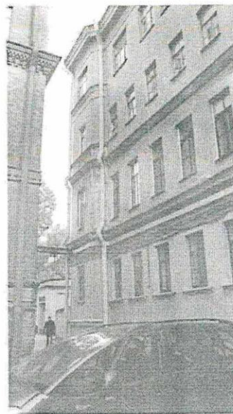
6. Фрагмент западного фасада объекта культурного наследия.
