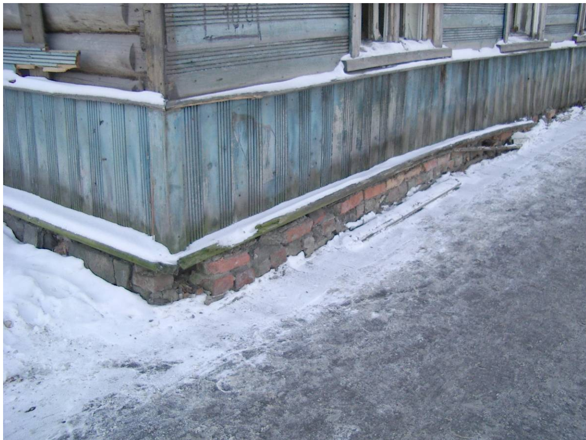
Илл. 20. Оформление цоколя по периметру здания. Фотография. 2004 г.
