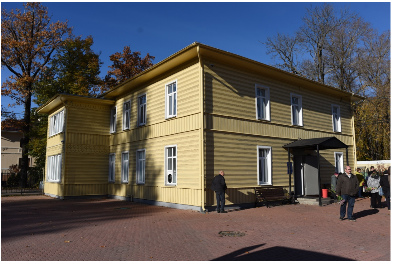
3.Общий вид здания с юго-восточной стороны.
