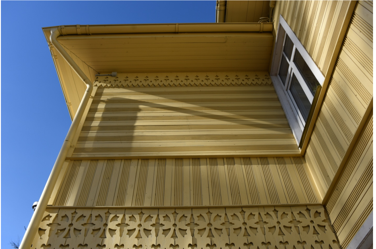
8. Резной декор веранды здания.
