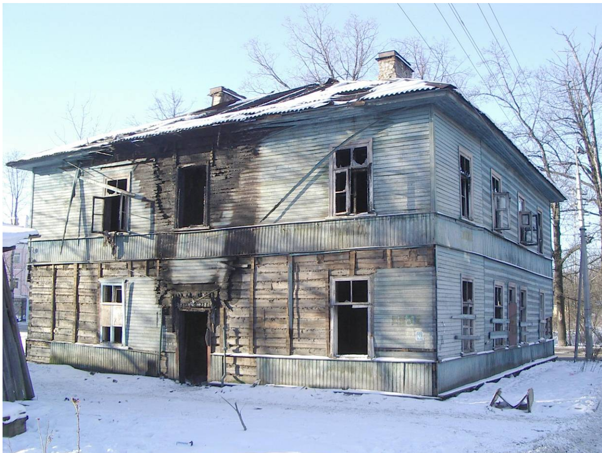
Илл. 14. Общий вид здания с северо-восточной стороны. Фотография. 2004 г.
