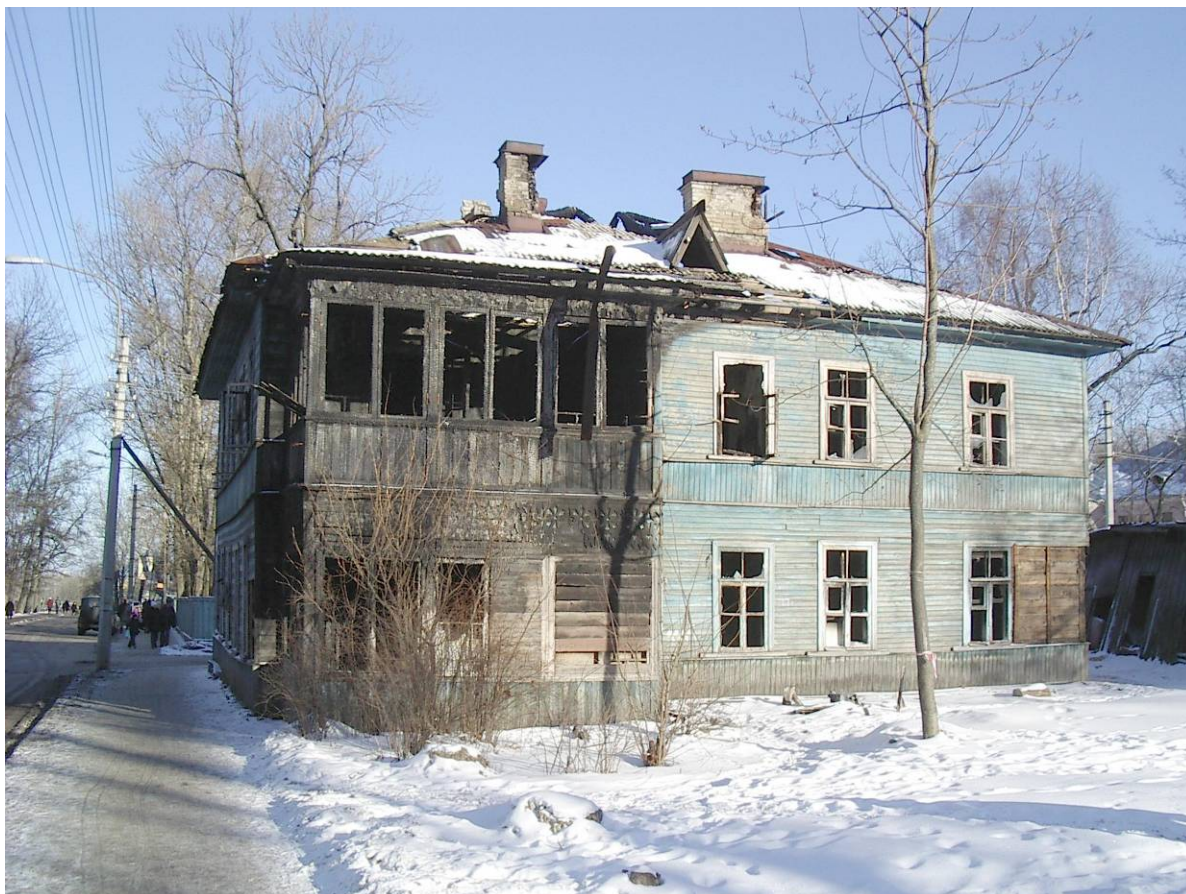
Илл. 15. Общий вид здания с южной стороны. Фотография. 2004 г.
