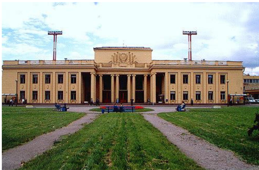
18. Пулково-2. Здание аэровокзала. Фотография. 2004 г. https://www.citywalls.ru/
