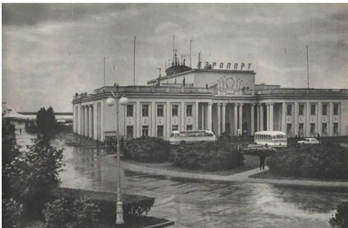
9. Ленинград. Аэровокзал «Шоссейная». Общий вид. Фотография. 1963 г. https://www.citywalls.ru/
