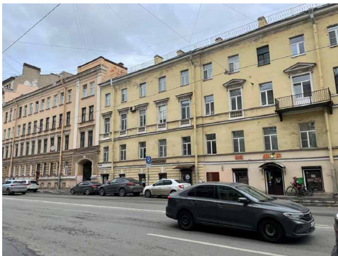
Фото 2. Лицевой фасад выявленного объекта культурного наследия «Дом Н. Протопопова» (со стороны Лермонтовского проспекта)
