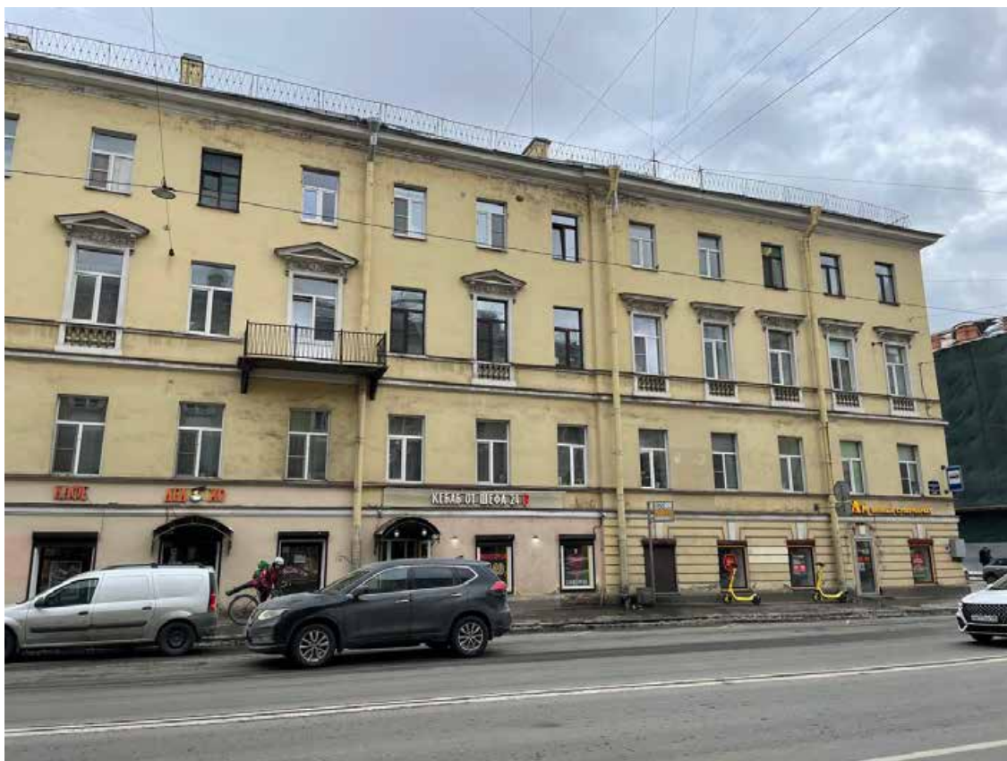
Фото 1. Лицевой фасад выявленного объекта культурного наследия «Дом Н. Протопопова» (со стороны Лермонтовского проспекта)
