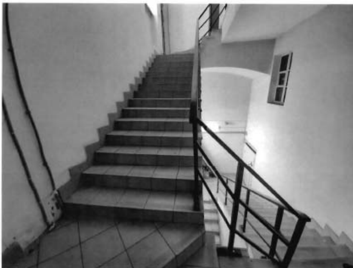
16. Лестница в пом. 1-Н (102; 160; 210) объекта культурного наследия
