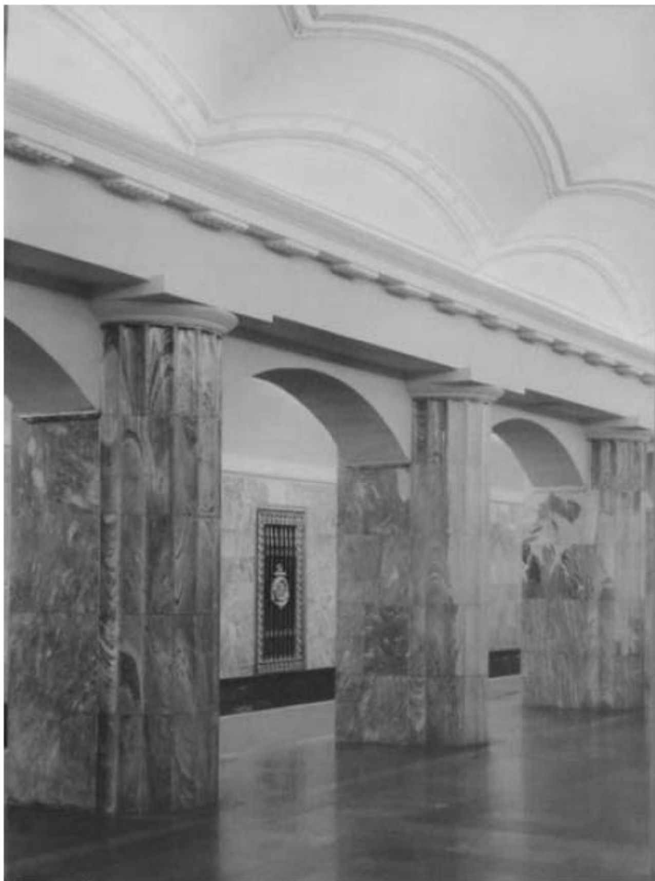
63. Часть интерьера подземного вестибюля станции «Балтийская». Сер. 1950-х гг. // Источник: ФГБУК «Государственный научно-исследовательский музей архитектуры имени А.В. Щусева». ГНИМА ОФ-5863/4.
