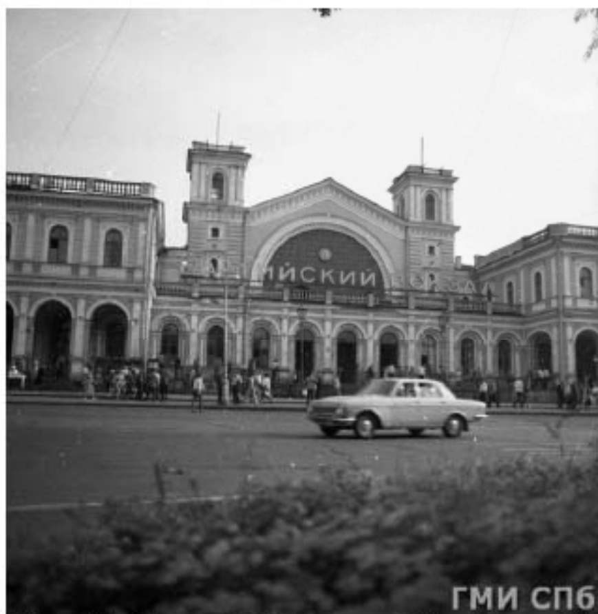
76. Барановский В. М., фотограф. Видны Ленинграда. Вид Балтийского вокзала. 1970-е гг. // Источник: ГМИ СПб Илл. №-П-Б-9623 и.
