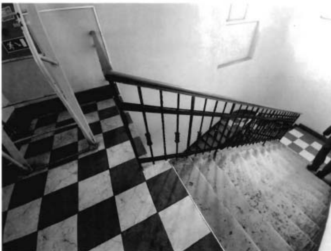
17. Лестница в пом. 1-Н (145; 266) объекта культурного наследия
