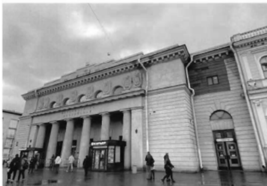
1. Общий вид на объект культурного наследия.
