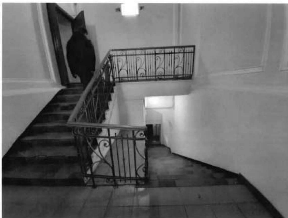
18. Лестница в пом. 3 ЛК (3–4) объекта культурного наследия
