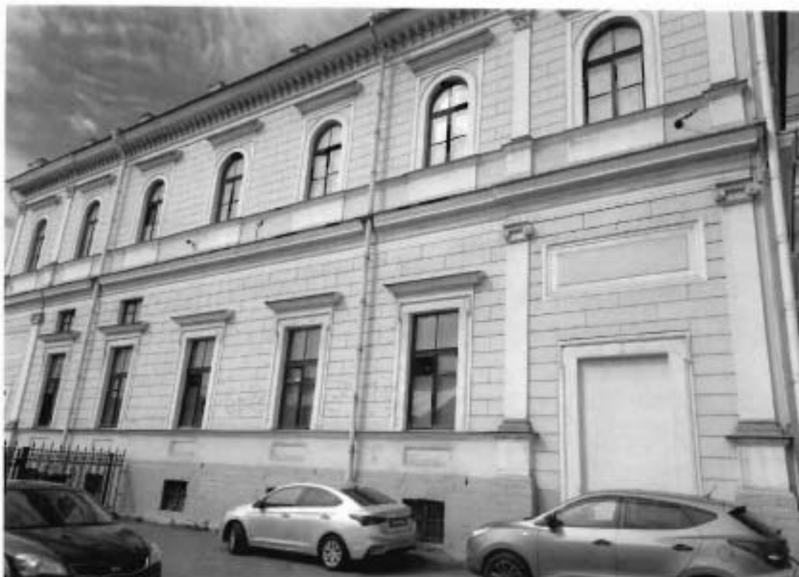
2. Фрагмент восточного фасада объекта культурного наследия
