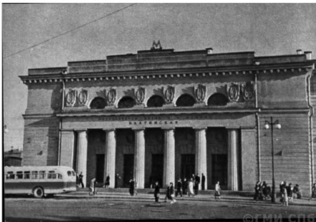
67. Ленинградский метрополитен имени В. И. Ленина. Станция «Балтийская». Наземный павильон. 1956 г. // Источник: СПб ГБУК «Государственный музей истории Санкт-Петербурга». ГМИ СПб Изв. №-1-Б-3754 р.
