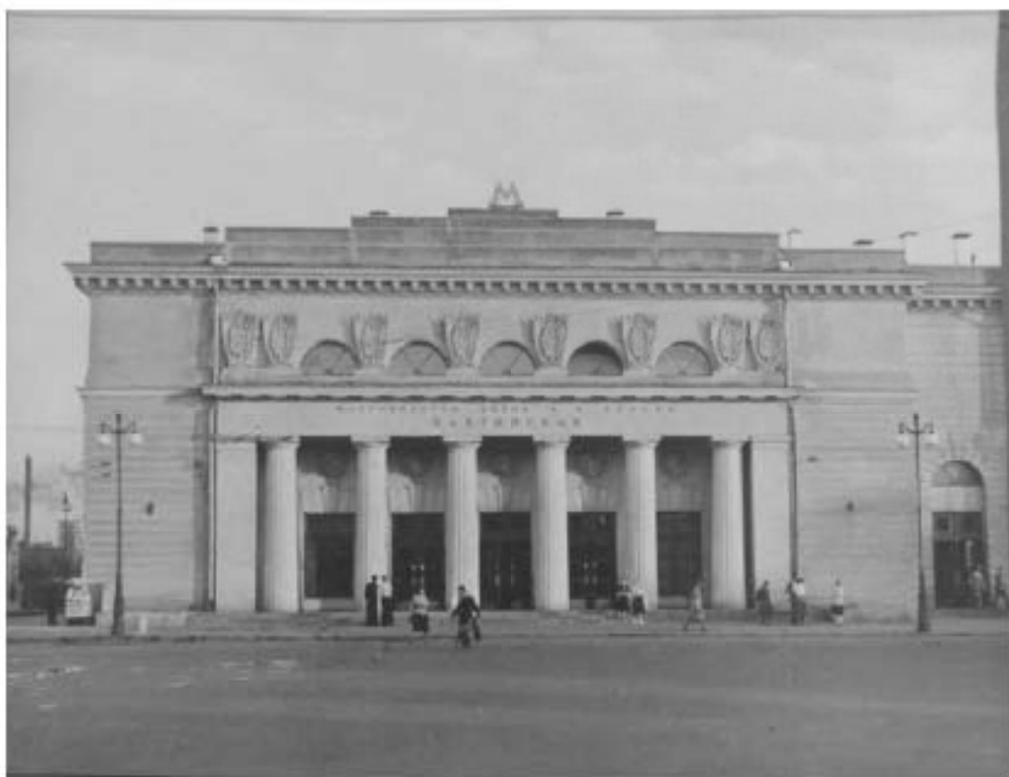
36. Наземный вестибюль станции «Балтийская». Фасад на площадь у Балтийского вокзала. Около 1955 г. // Источник: ФГБУК «Государственный научно-исследовательский музей архитектуры имени А.В. Щусева». ГНИМА ОФ-5863/5.
