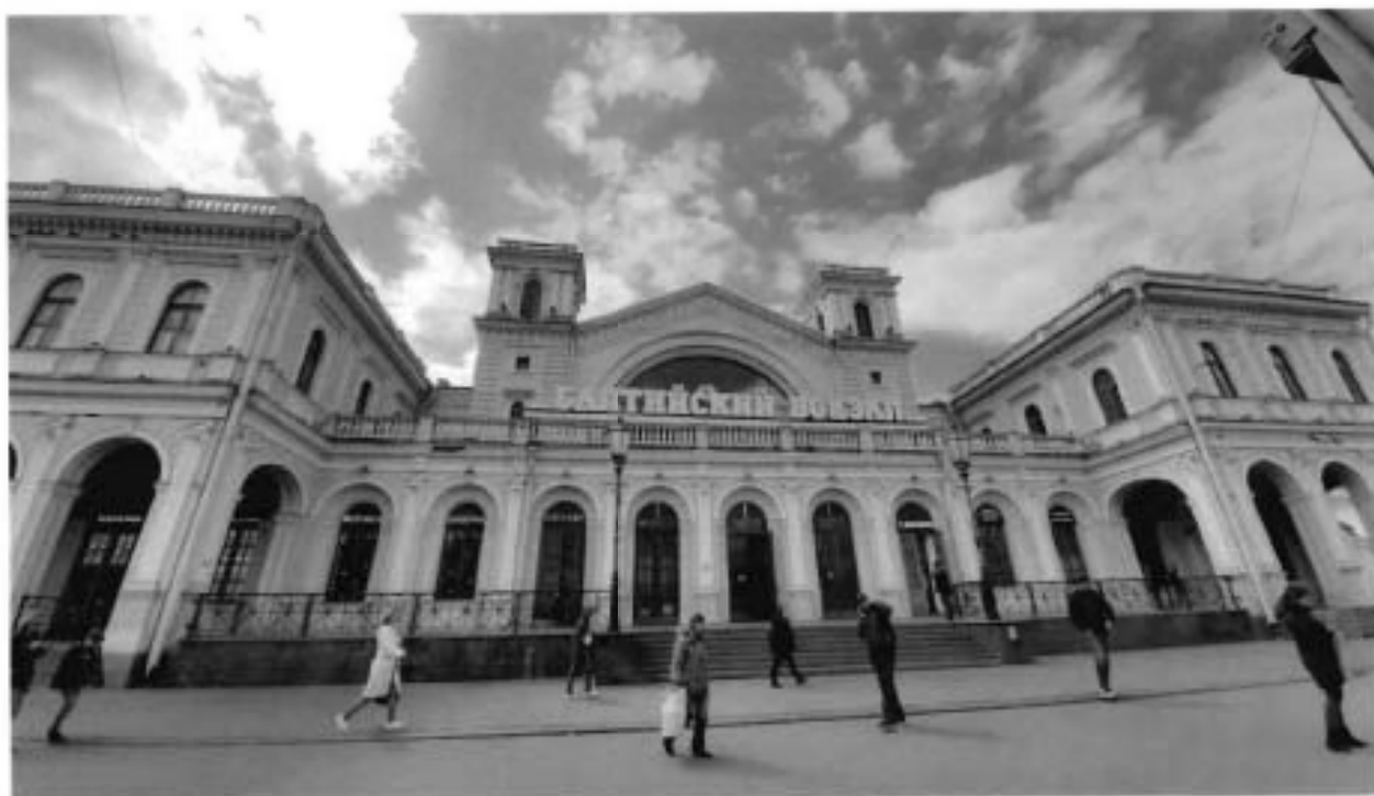
1. Общий вид северного фасада объекта культурного наследия
