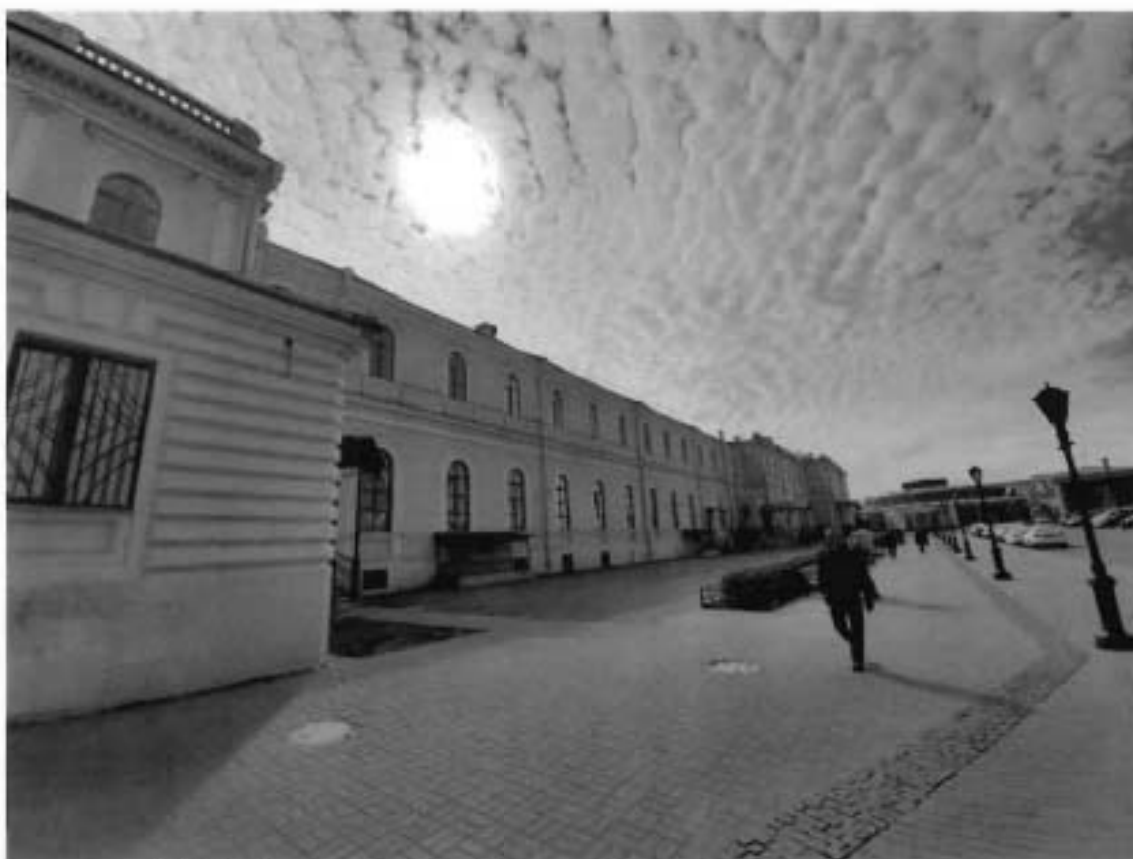
5. Общий вид западного фасада объекта культурного наследия
