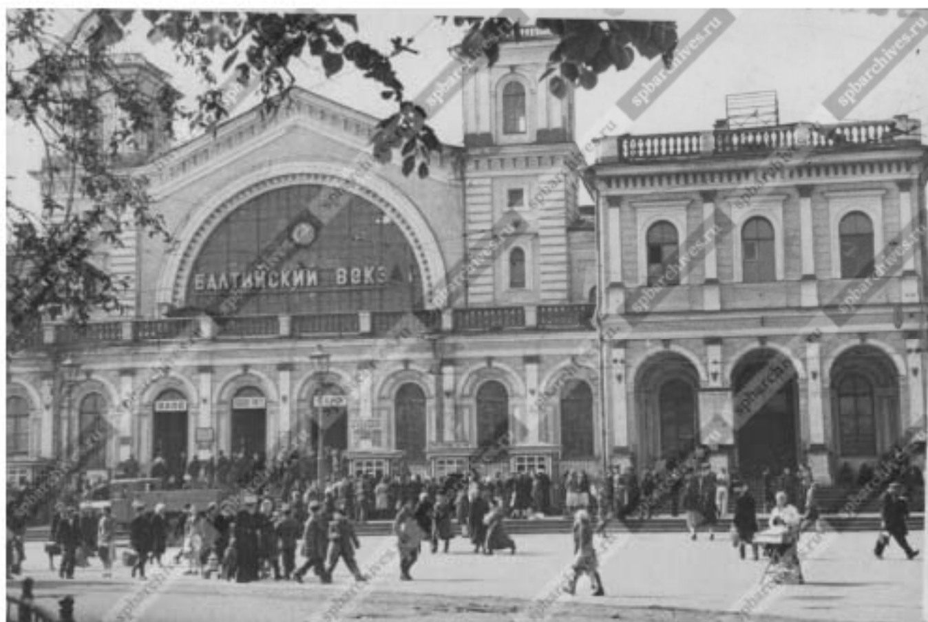
50. Фасад здания Балтийского вокзала. Фотография. Автор фото – Михайлов Александр Алексеевич. 1950-е гг. // Источник: ЦТАКФФД СПб Ар 68143.
