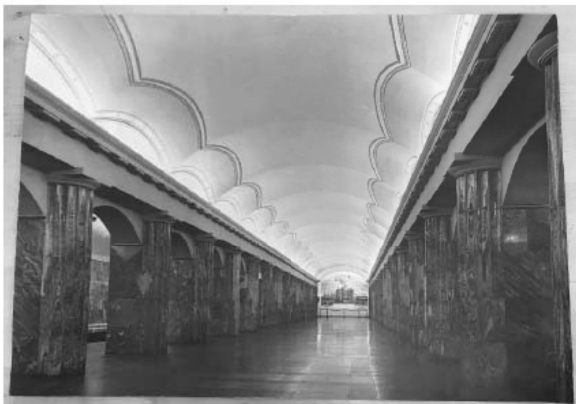
58. Перронный зал станции метро «Балтийская». 1955 г. // Источник: ФГБУК «Государственный научно-исследовательский музей архитектуры имени А.В. Щусова». ГНИМА ОФ-1478/15381.
