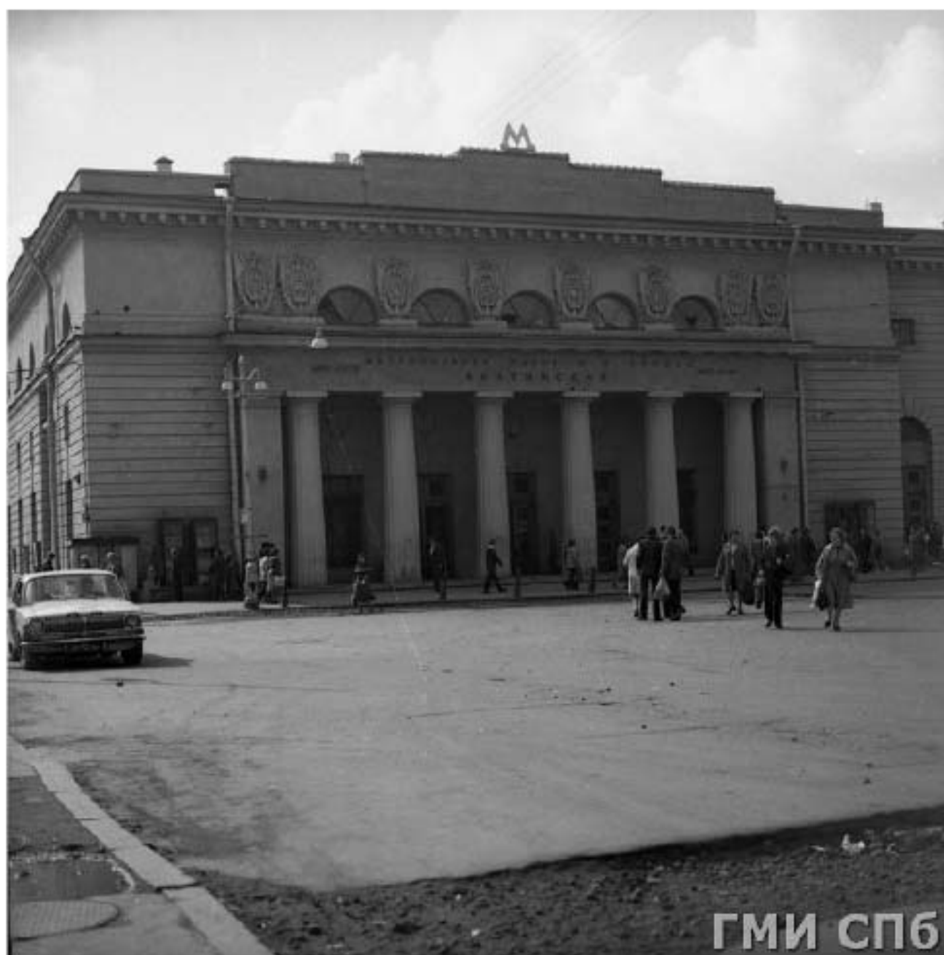
80. Наземный вестибюль станции «Балтийская». 1981 г. // Источник: СПб ГБУК «Государственный музей истории Санкт-Петербурга». ГМИ СПб Инв.№-П-Б-13544 н.
