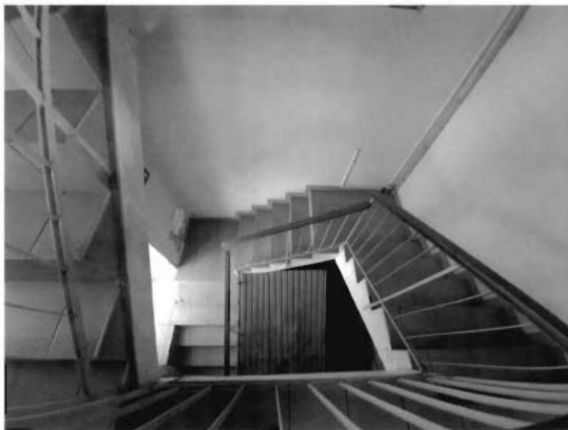
15. Лестница в пом. 1-Н (42; 154; 167; 281) объекта культурного наследия
