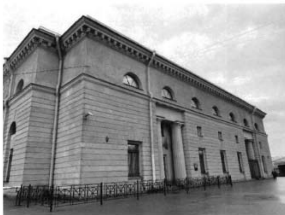
2. Общий вид на объект культурного наследия.
