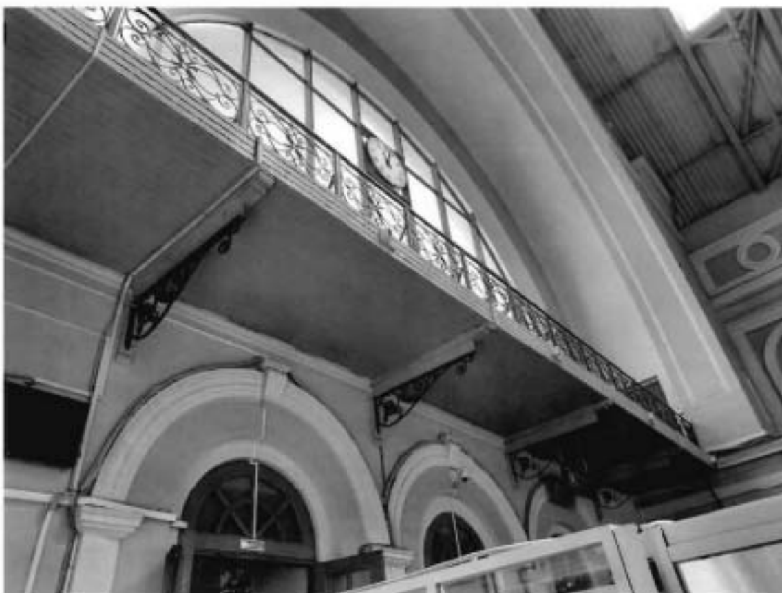
7. Интерьеры объекта культурного наследия, 1 этаж (пом. 1-Н (88))
