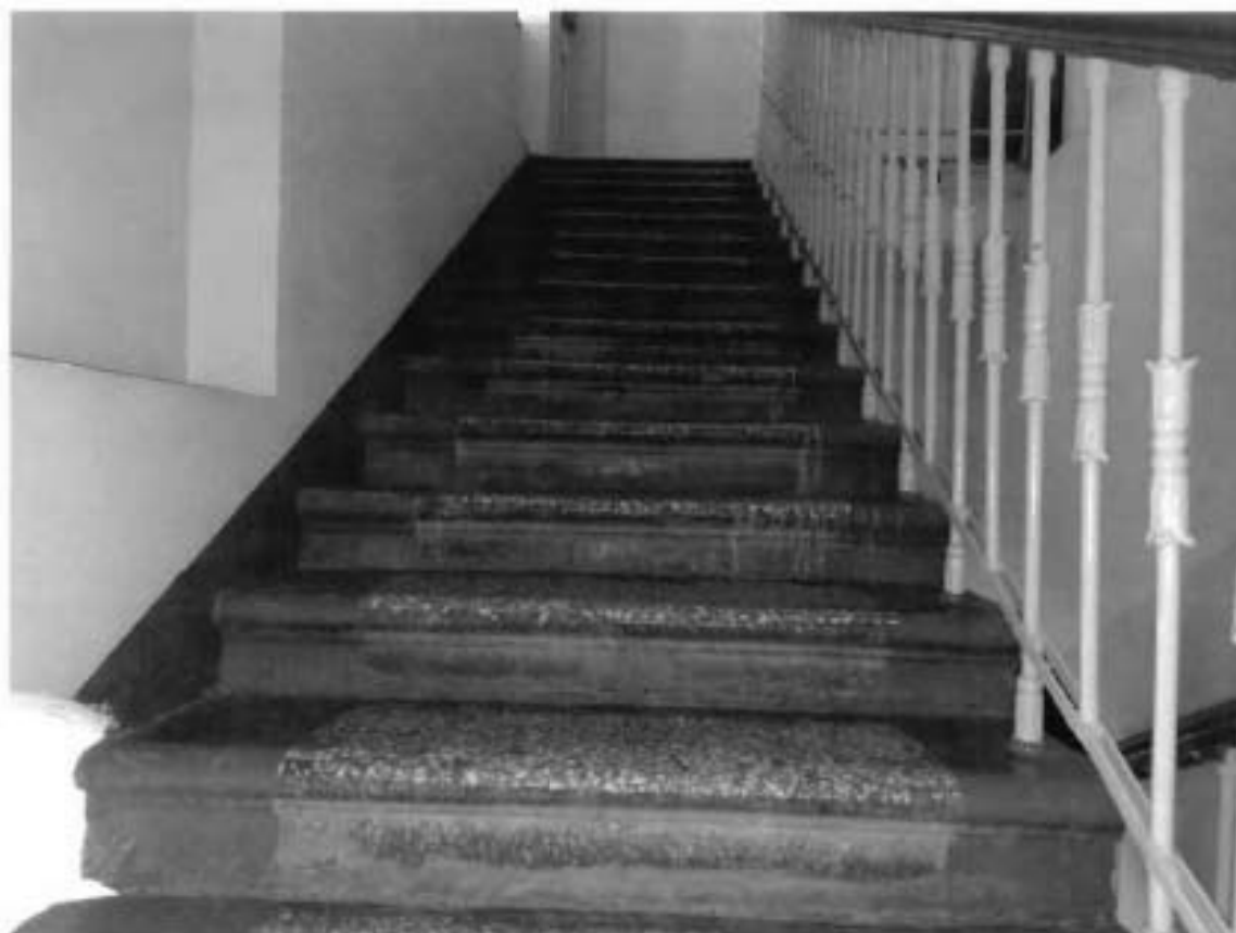
14. Лестница в пом. 1-Н (30; 144; 265) объекта культурного наследия
