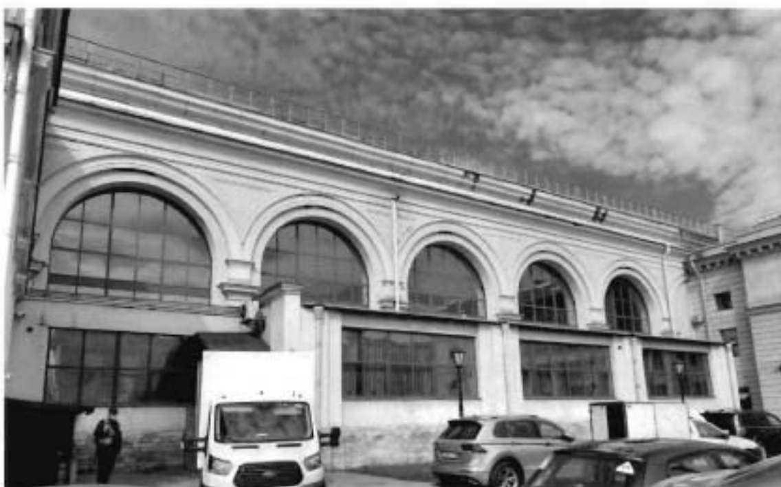
3. Фрагмент восточного фасада объекта культурного наследия
