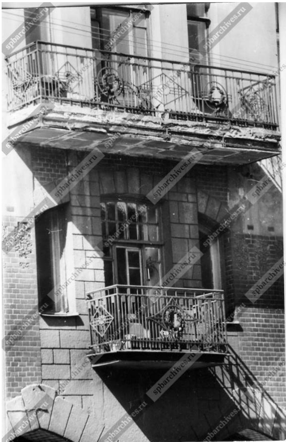
19. Дом Ф. В. Шеффера. Вид декоративных решеток балконов на центральном фасаде жилого дома № 58 по 9-й линии Васильевского острова. 12 июня 1987 г. ЦГАКФФД СПб Ар 225808.
