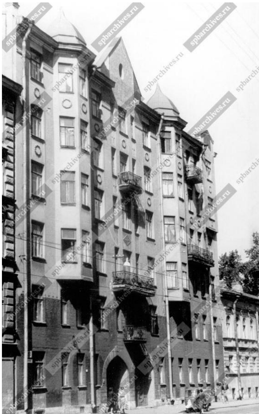
17. Дом Ф. В. Шеффера. Общий вид центрального фасада жилого дома № 58 по 9-й линии Васильевского острова, оформленного многоугольными эркерами (архитектор Н.И.Алексеев, 1911-1912 гг). Дата съёмки: 12 июня 1987 г. ЦГАКФФД СПб Ар 217321.
