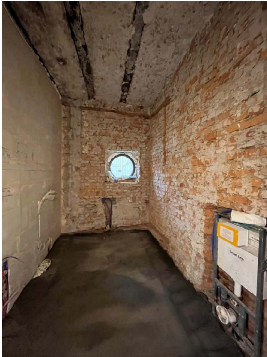
Фото №8. Помещения №№ 5, 6. Перегородка между помещениями демонтирована.
