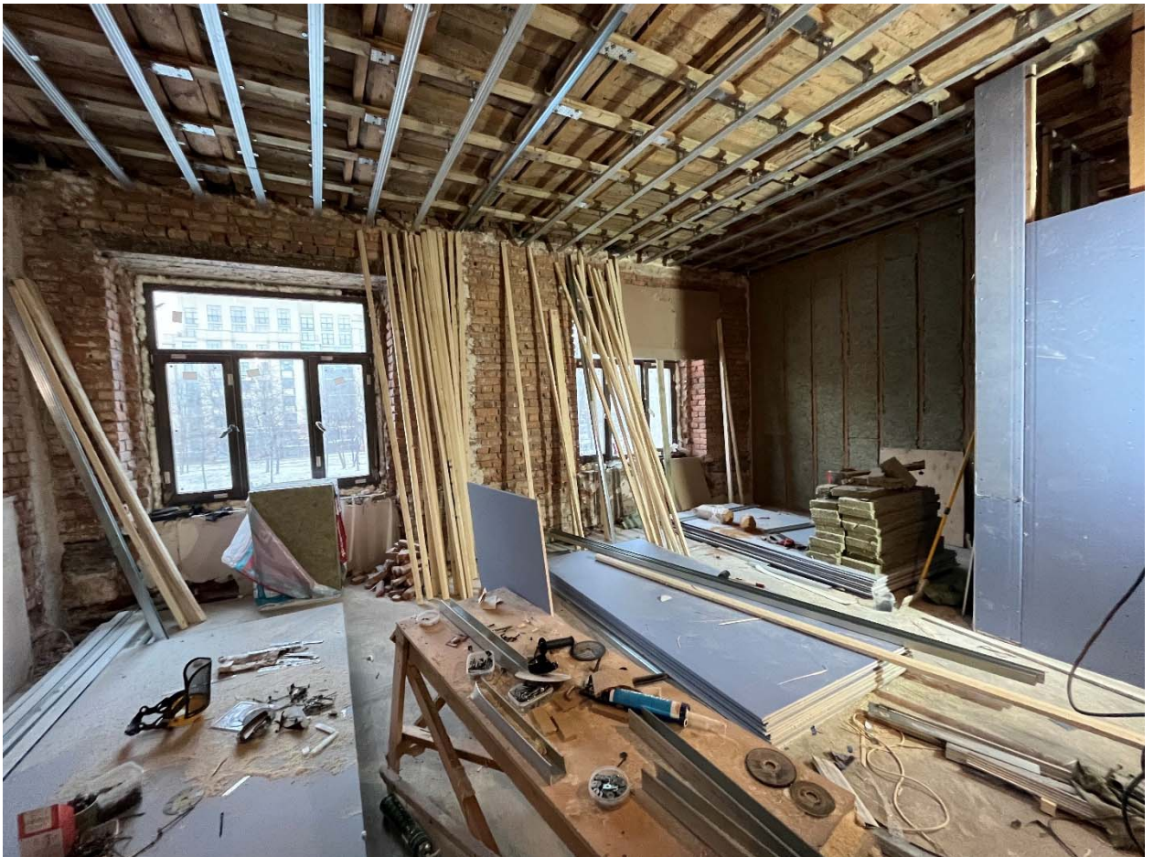
Фото №6. Помещения №№ 9,10. Перегородка между помещениями демонтирована.
