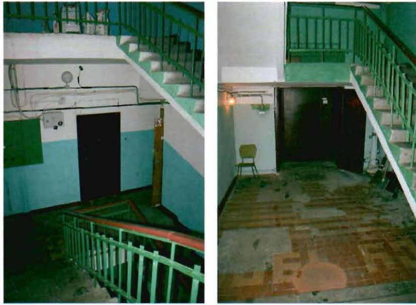
Фото №5, б. Лестничные клетки.
