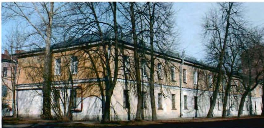
Фото №1. Вид на лицевой (восточный) и торцевой (южный) фасады со стороны Коммунистической ул.
