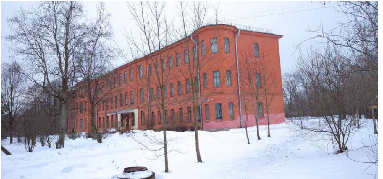
2. Вид на здание с юго-востока.
