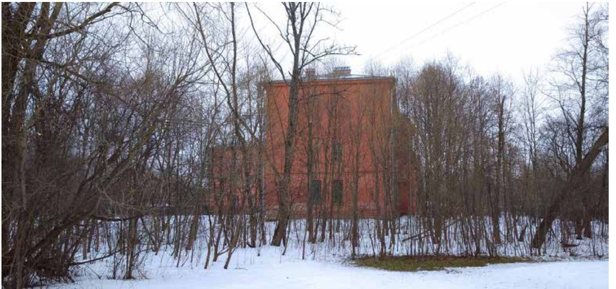
5. Вид на здание с запада.
