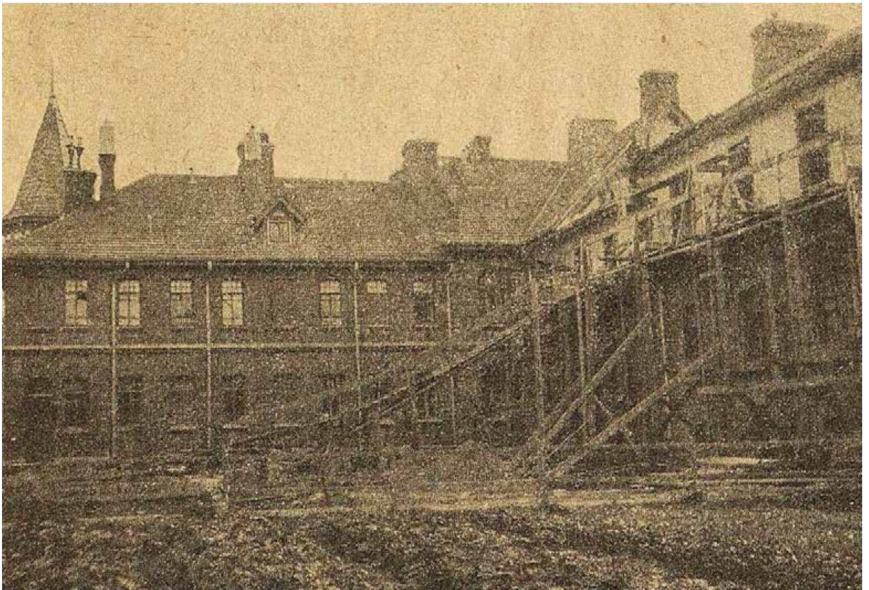
16. Школа нянь Е. В. Госуд. Императрицы Александры Федоровны. Восточная часть северного фасада. Фото 1910-1912 гг. https://pastvu.com/p/1800132
