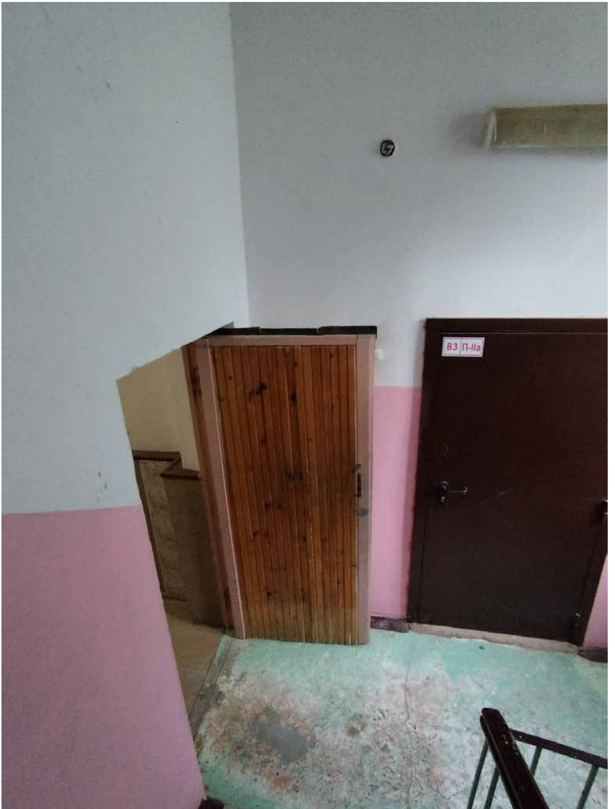
34. 2-й этаж, лестница в западной части здания, помещение №35.
