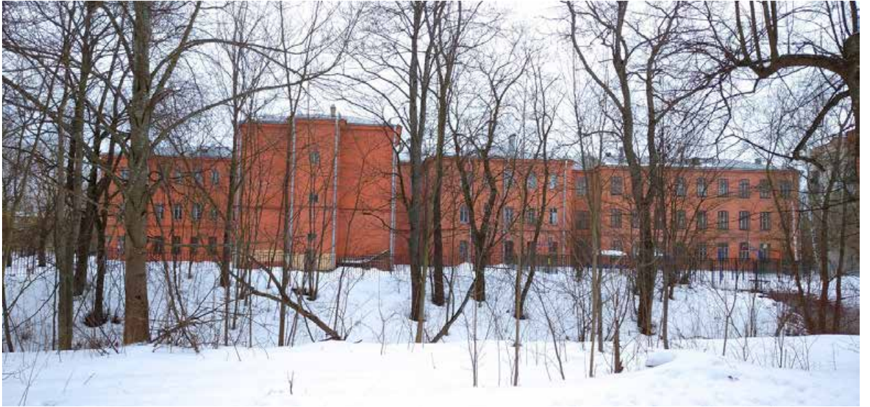
9. Вид на здание с севера.
