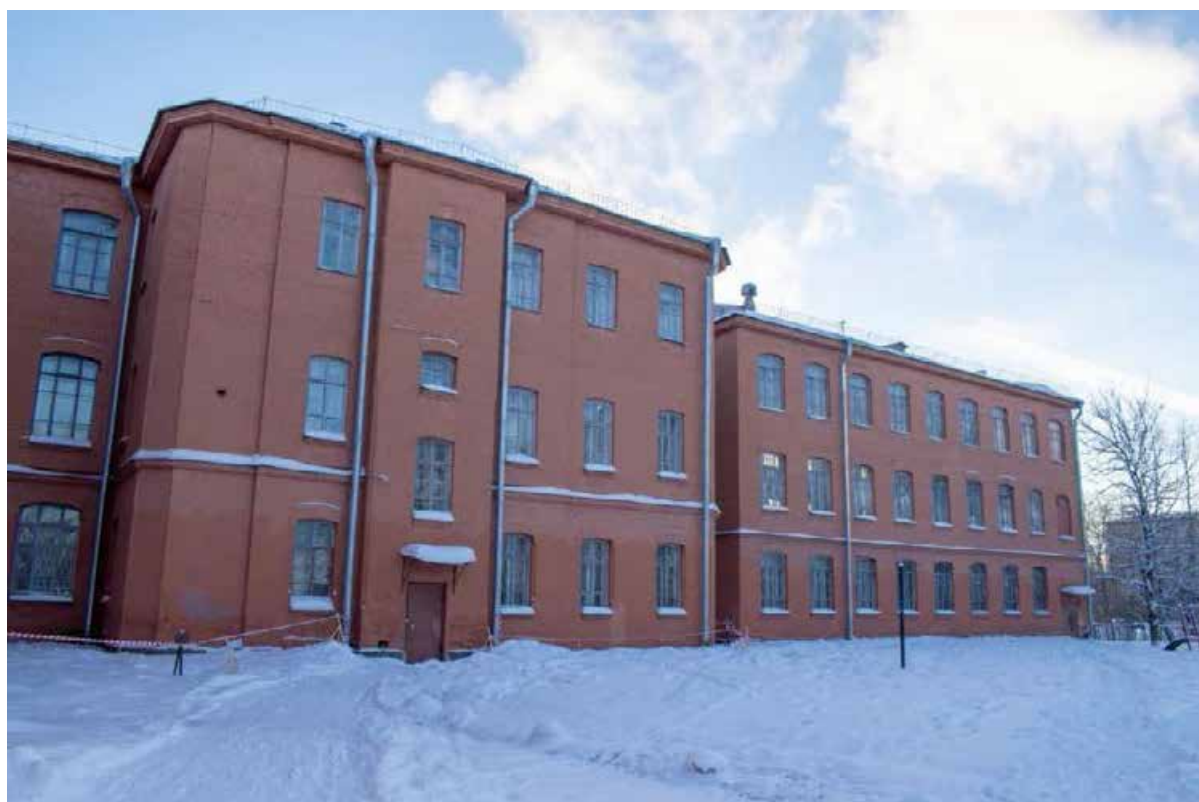
19. Здание бывшей Школы нянь после восстановления 1958 г. Вид на западную часть северного фасада. Фото 2019 г. https://www.citywalls.ru/house18236.html?s=Ino68vuhjfk01vti65m9j9d4b
