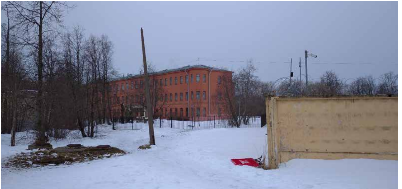
1. Вид на здание с юго-востока.
