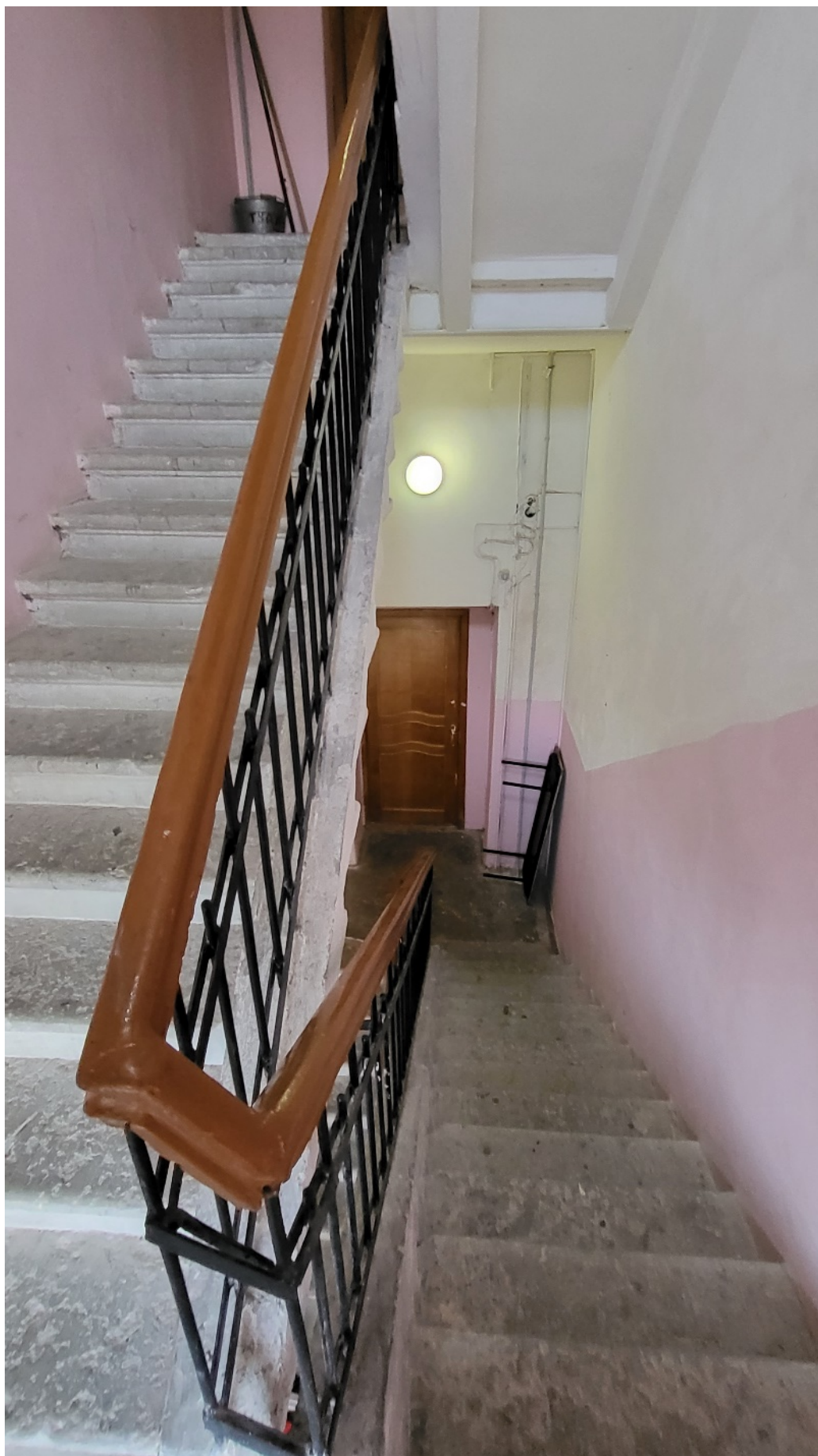
20. 1-й этаж, лестница в западном ризалите северного фасада, помещение №49.
