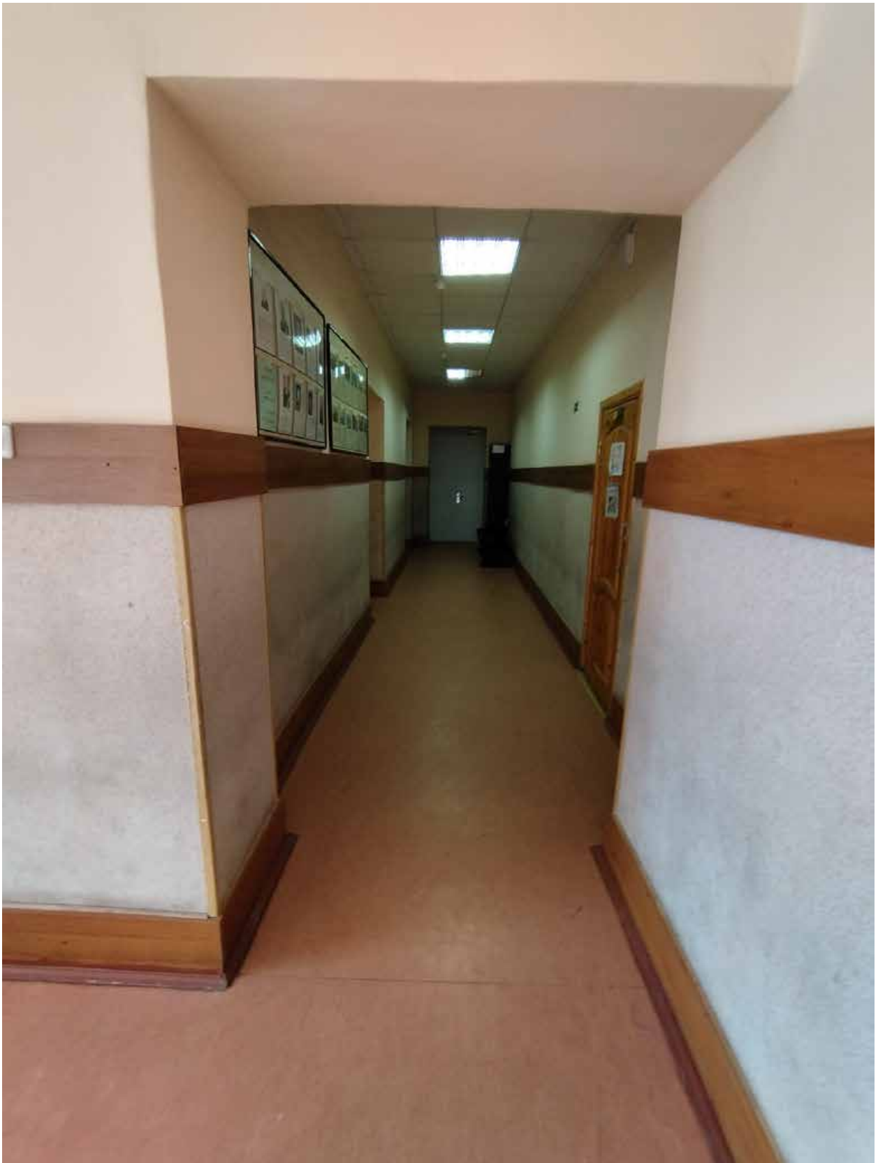
26. 2-й этаж, помещение №29.
