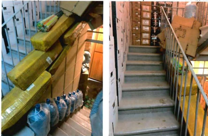
Фото 14, 15. Фрагменты ходовой части лестницы, северо-восточная часть здания.
