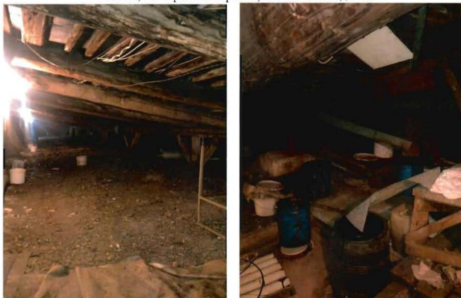
Фото 27, 28. Фрагмент крыши, южная часть здания.
