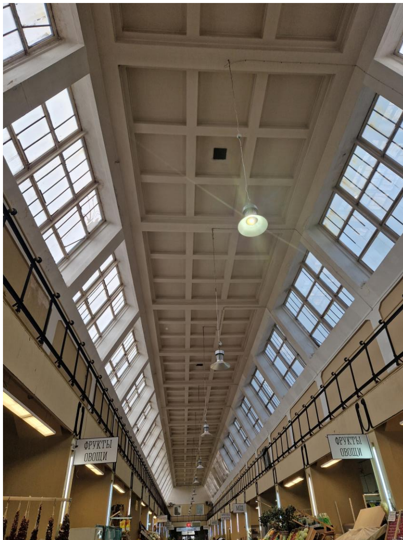
11. Объект культурного наследия регионального значения «Здание Сытного рынка» по адресу: г. Санкт-Петербург, Сытнинская ул., д. 5, литера А. Световой фонарь. Вид из интерьера в южном направлении.
