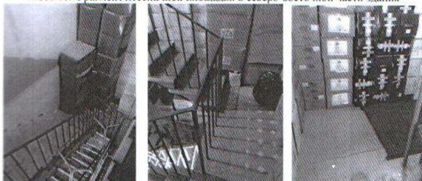
Фото 18. Фрагмент лестничной площадки в северо-восточной части здания
