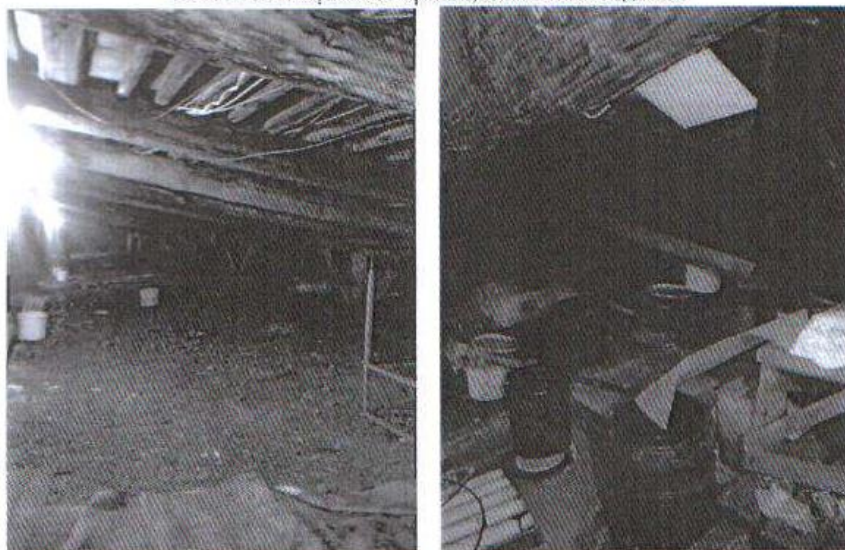
Фото 27, 28. Фрагмент крыши, южная часть здания.
