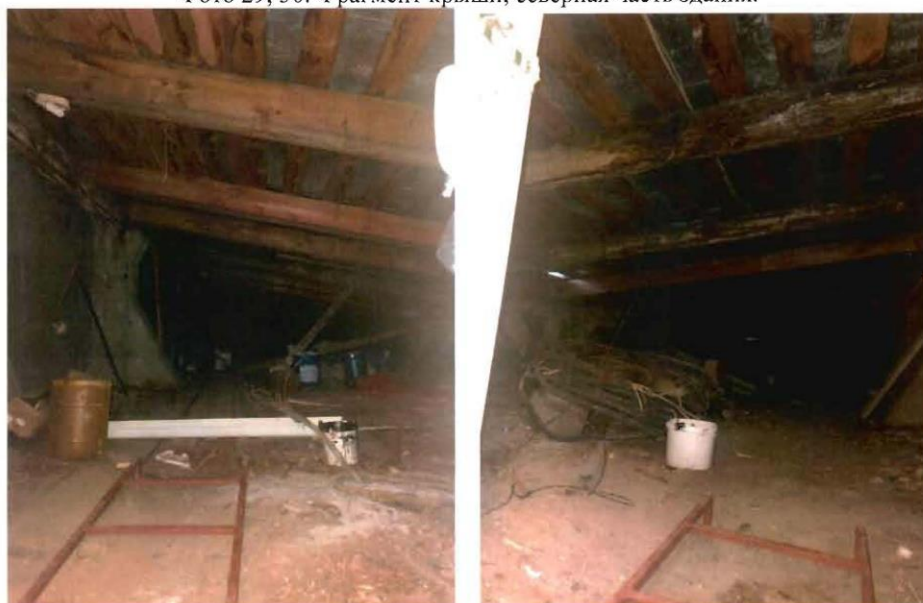
Фото 29, 30. Фрагмент крыши, северная часть здания.
