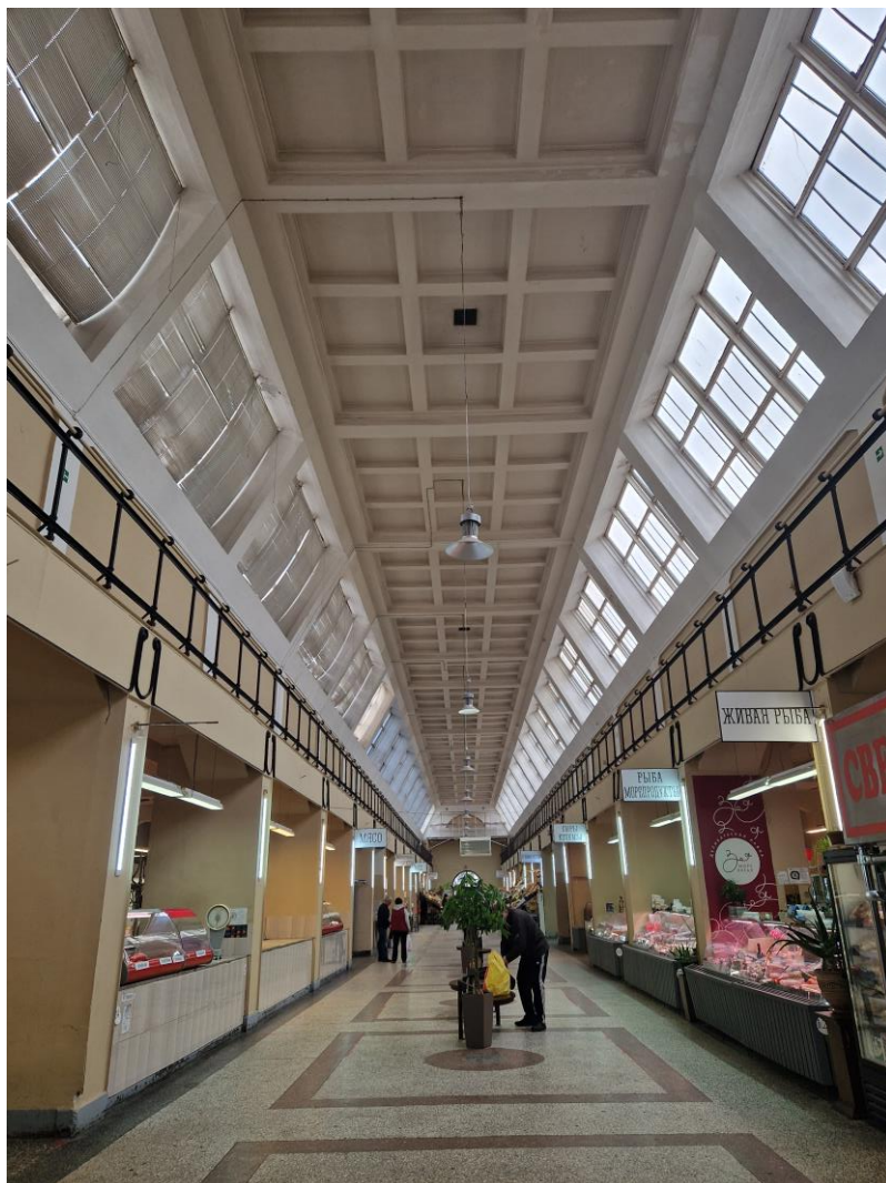
10. Объект культурного наследия регионального значения «Здание Сытного рынка» по адресу: г. Санкт-Петербург, Сытнинская ул., д. 5, литера А. Интерьер торгового зала. Общий вид в северном направлении.
