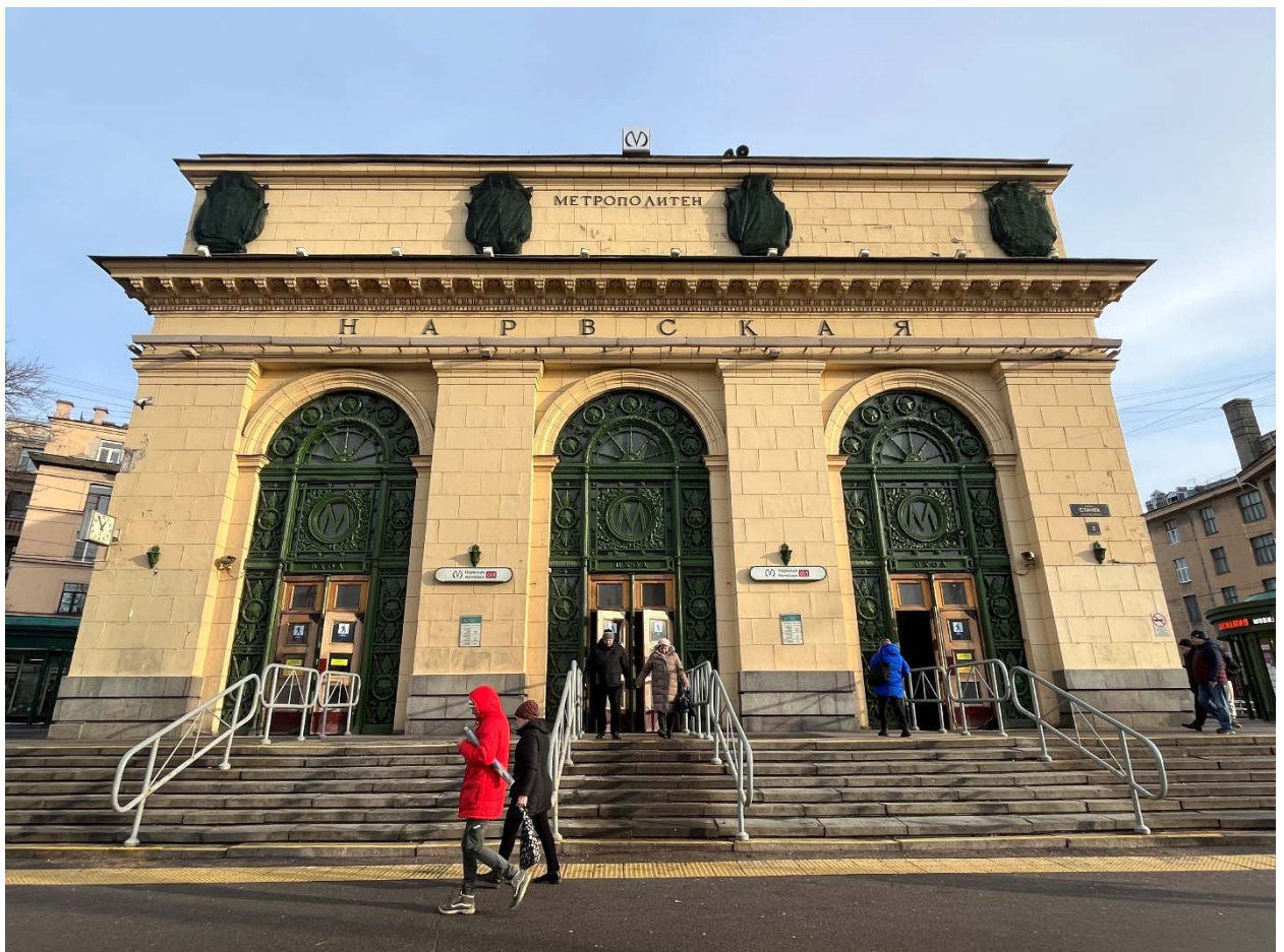
Фото №7. Западный фасад, вход в метро.
