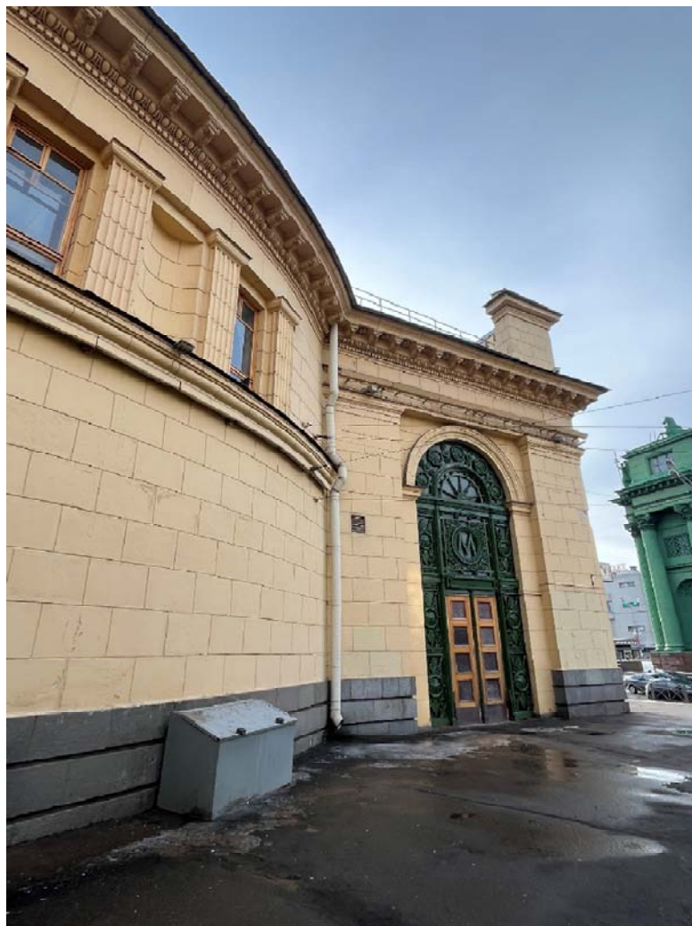
Фото №6. Северный фасад.
