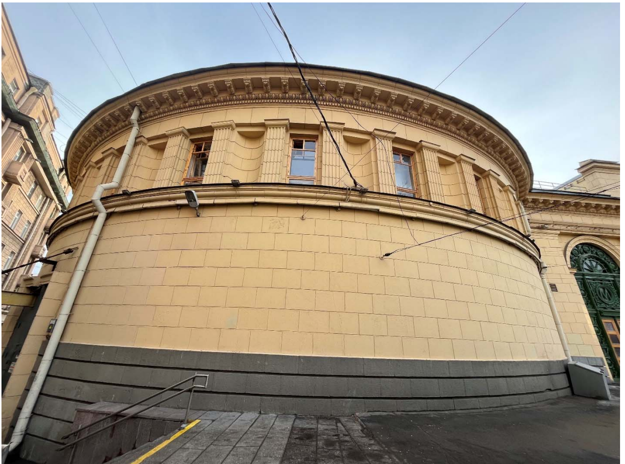
Фото №5. Северный фасад.
