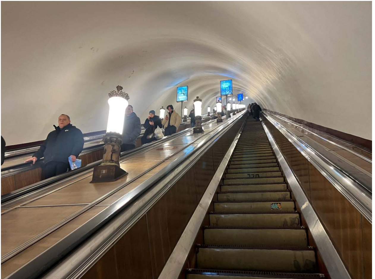
Фото №26. Наклонный ход.
