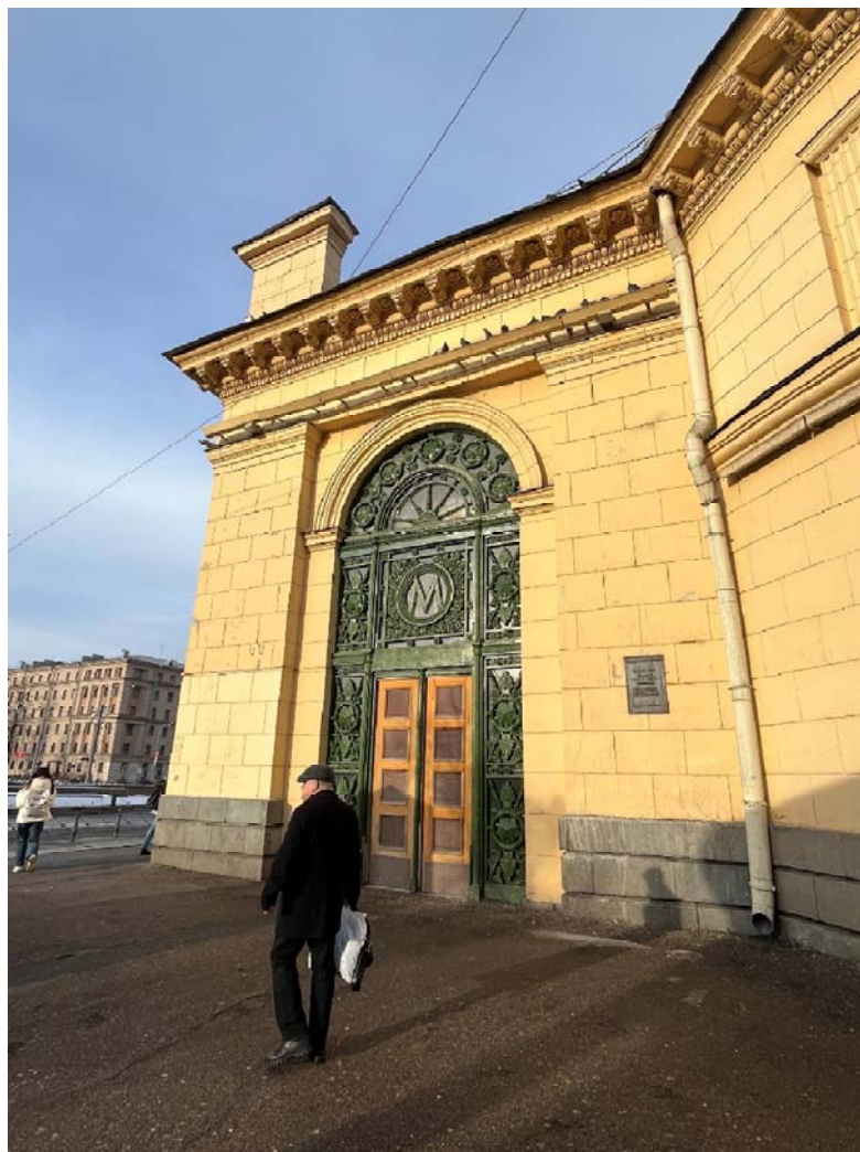
Фото №8. Западный фасад, вход в метро.
