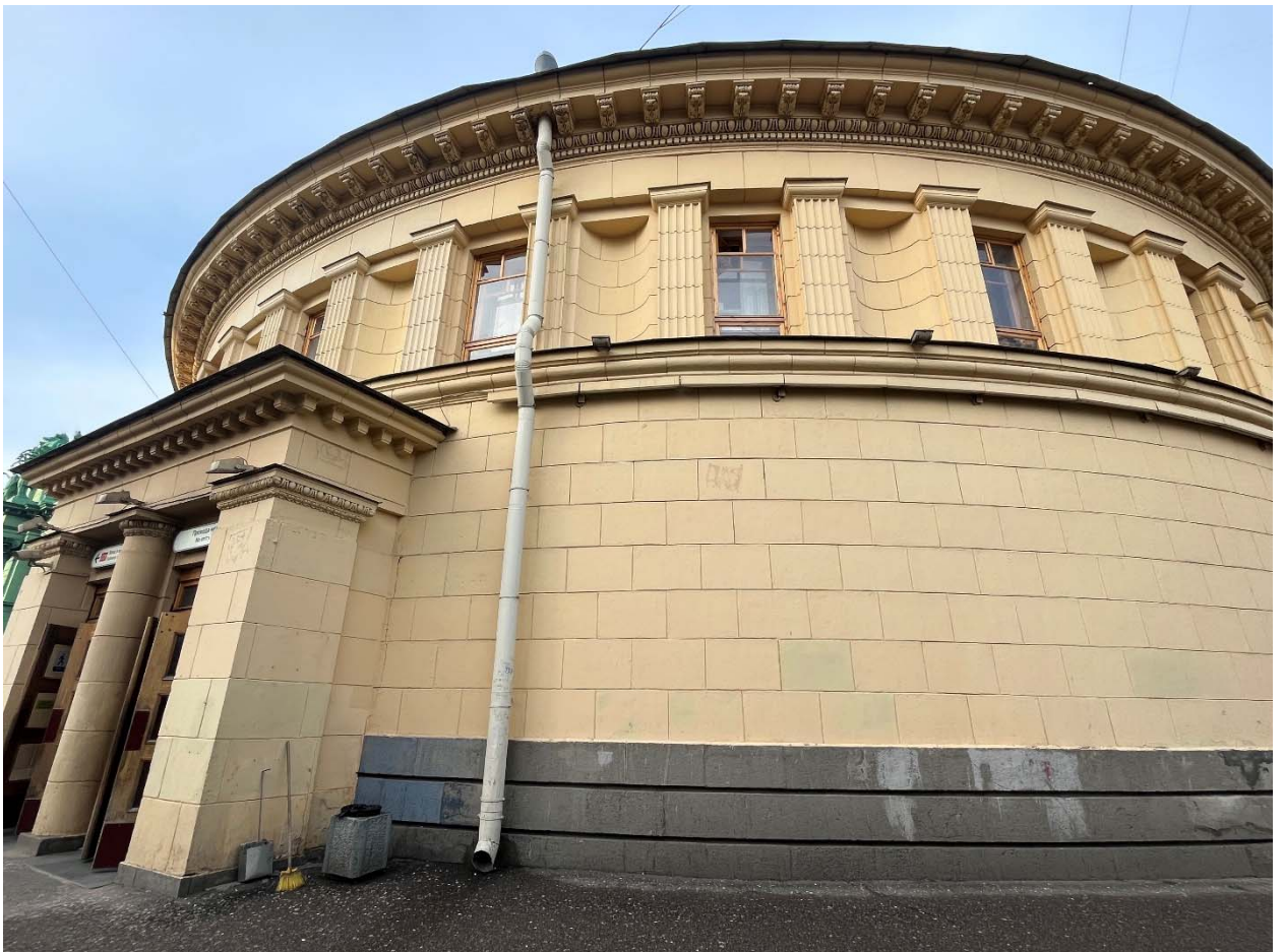
Фото №2. Южный фасад.
