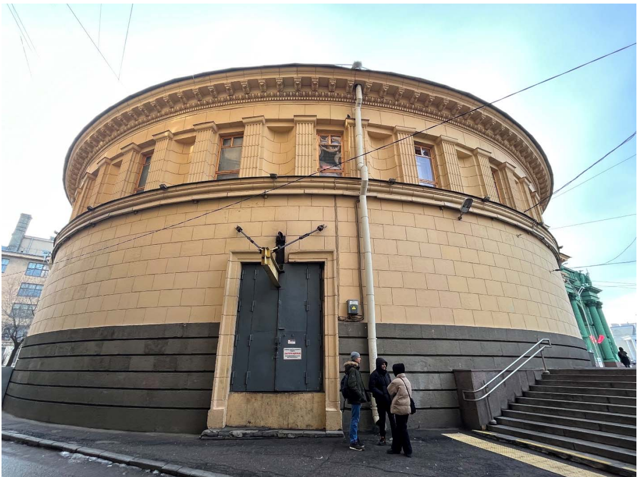
Фото №4. Северо-восточный фасад.
