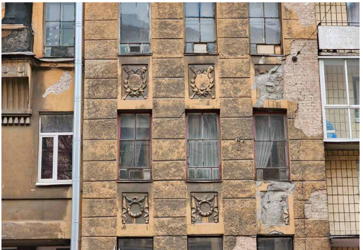
Фото 2. Лицевой фасад. Декор в прямоугольных нишах боковой раскреповки.
