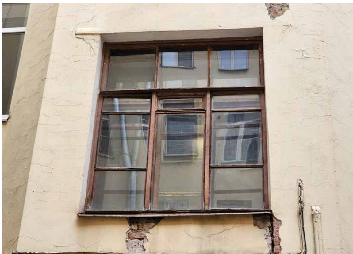
Фото 14. Дворовой фасад лицевого корпуса. Оконное заполнение лестницы.
