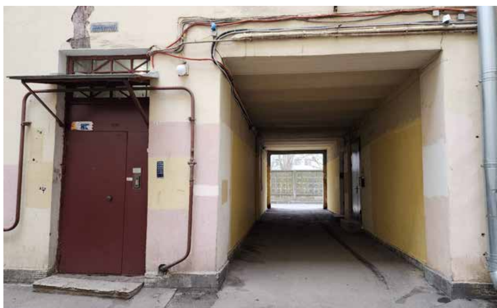
Фото 11. Фрамуга дверного проема. Арочный проезд во второй двор.
