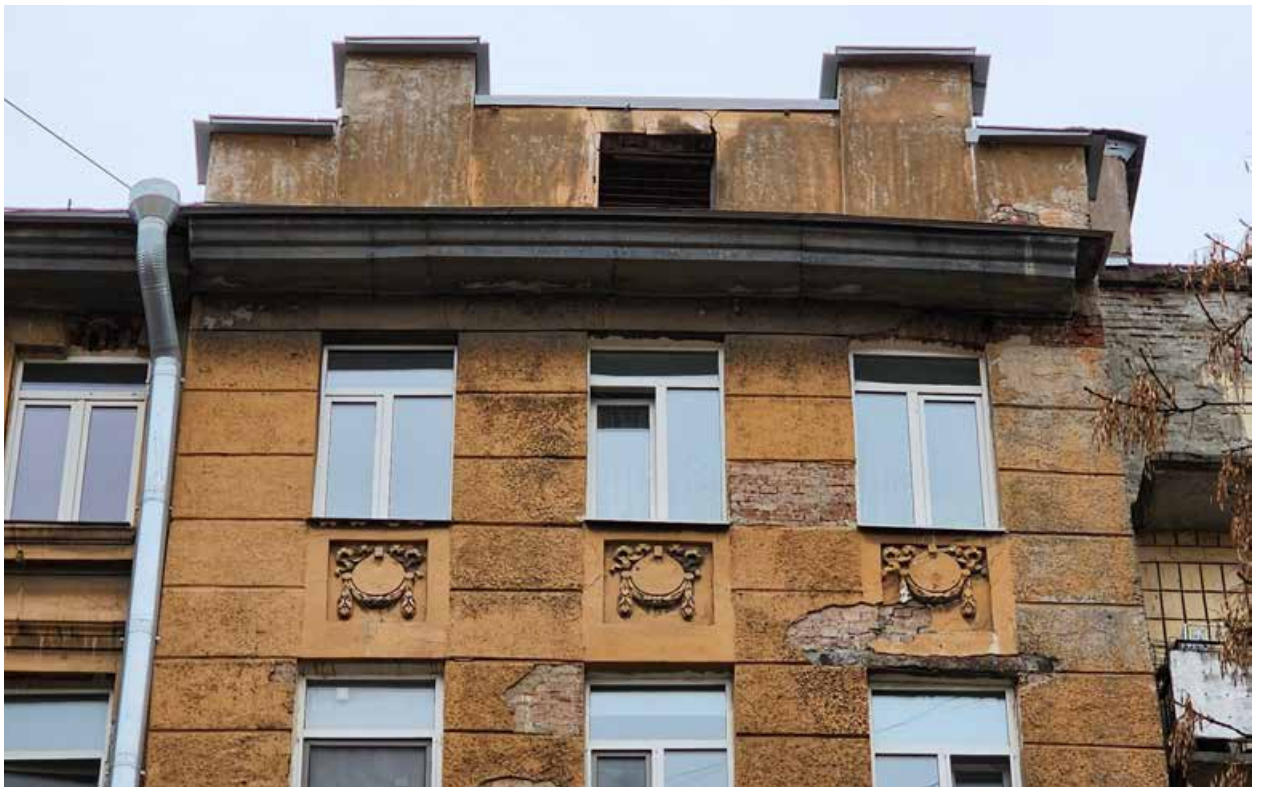
Фото 3. Лицевой фасад. Ступенчатый аттик боковой раскреповки.
