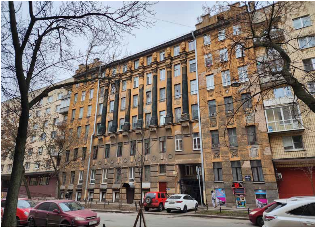
Фото 1. Лицевой фасад. Общий вид с 15-ой линии.
