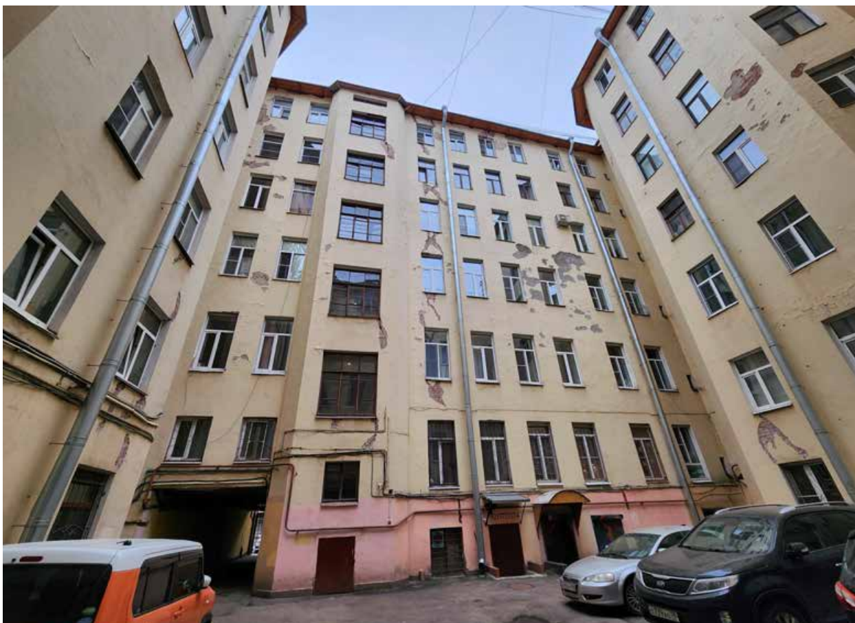
Фото 13. Дворовой фасад лицевого корпуса.
