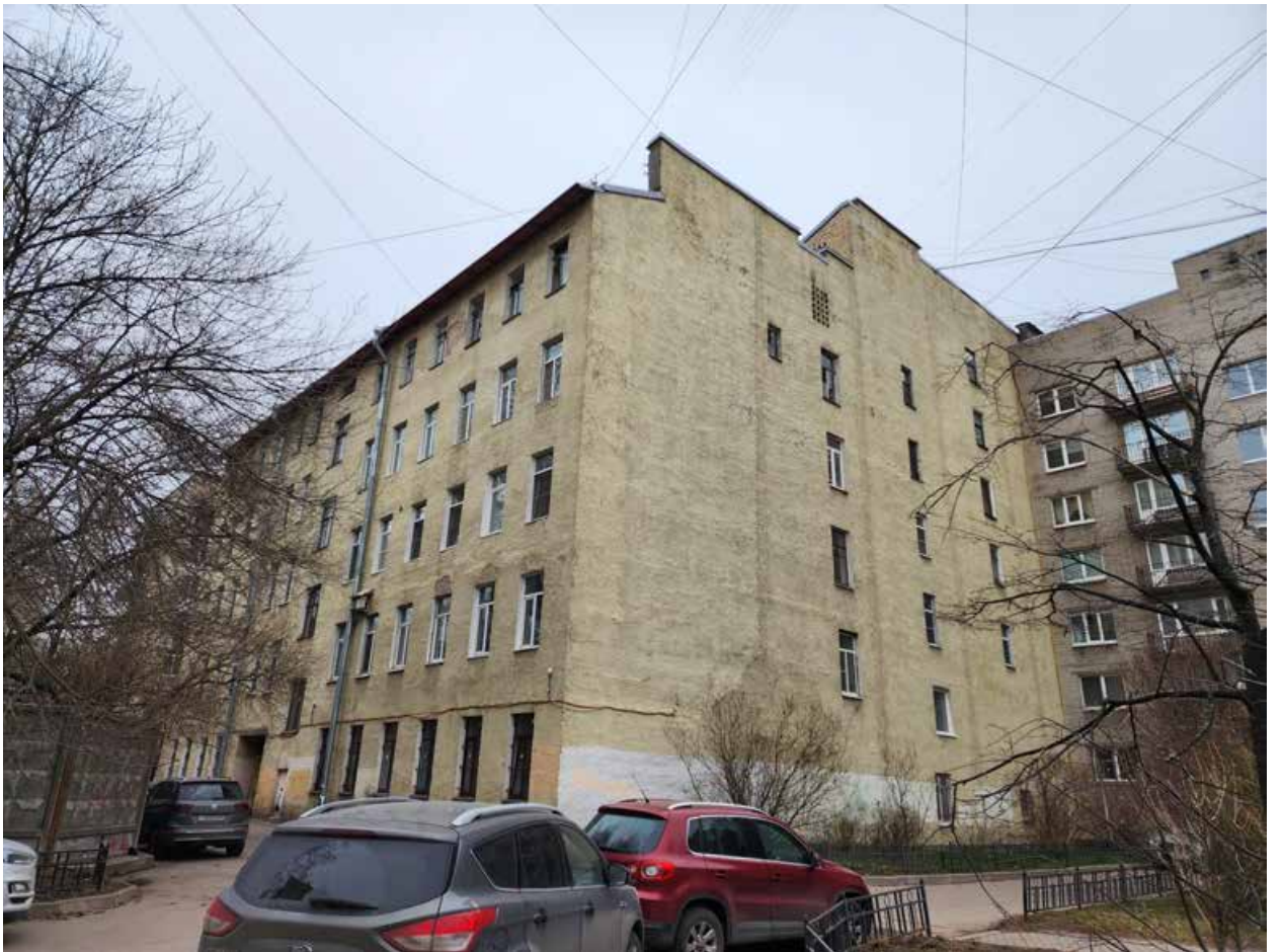
Фото 17. Брандмауэр. Дворовой фасад.
