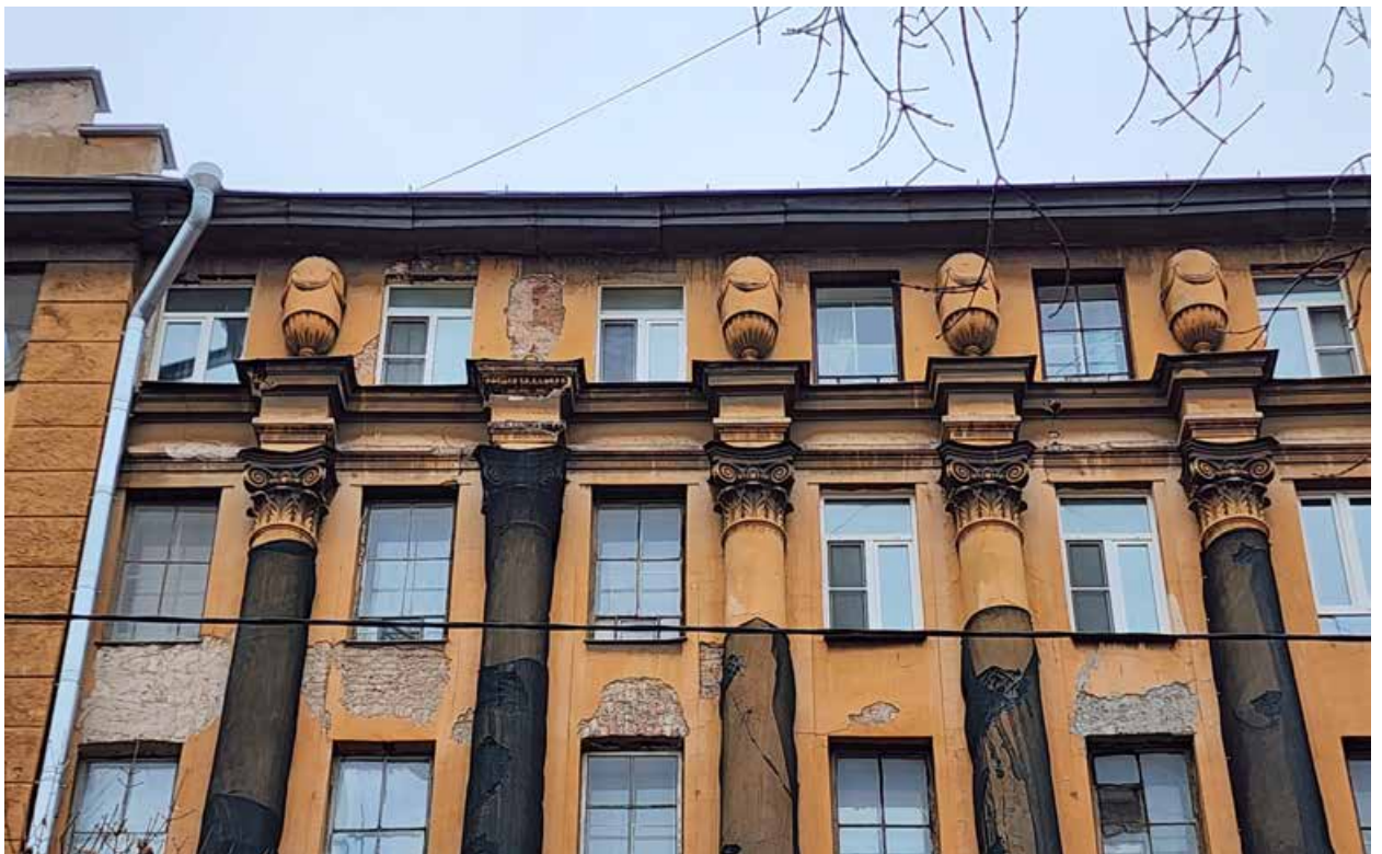
Фото 6. Лицевой фасад. Капители полуколонн, вазоны.
