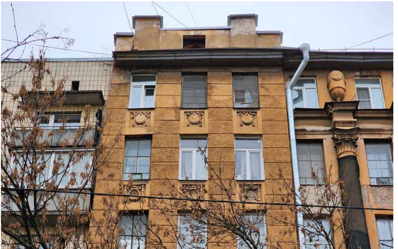
Фото 7. Лицевой фасад. Декор в прямоугольных нишах боковой раскреповки.
