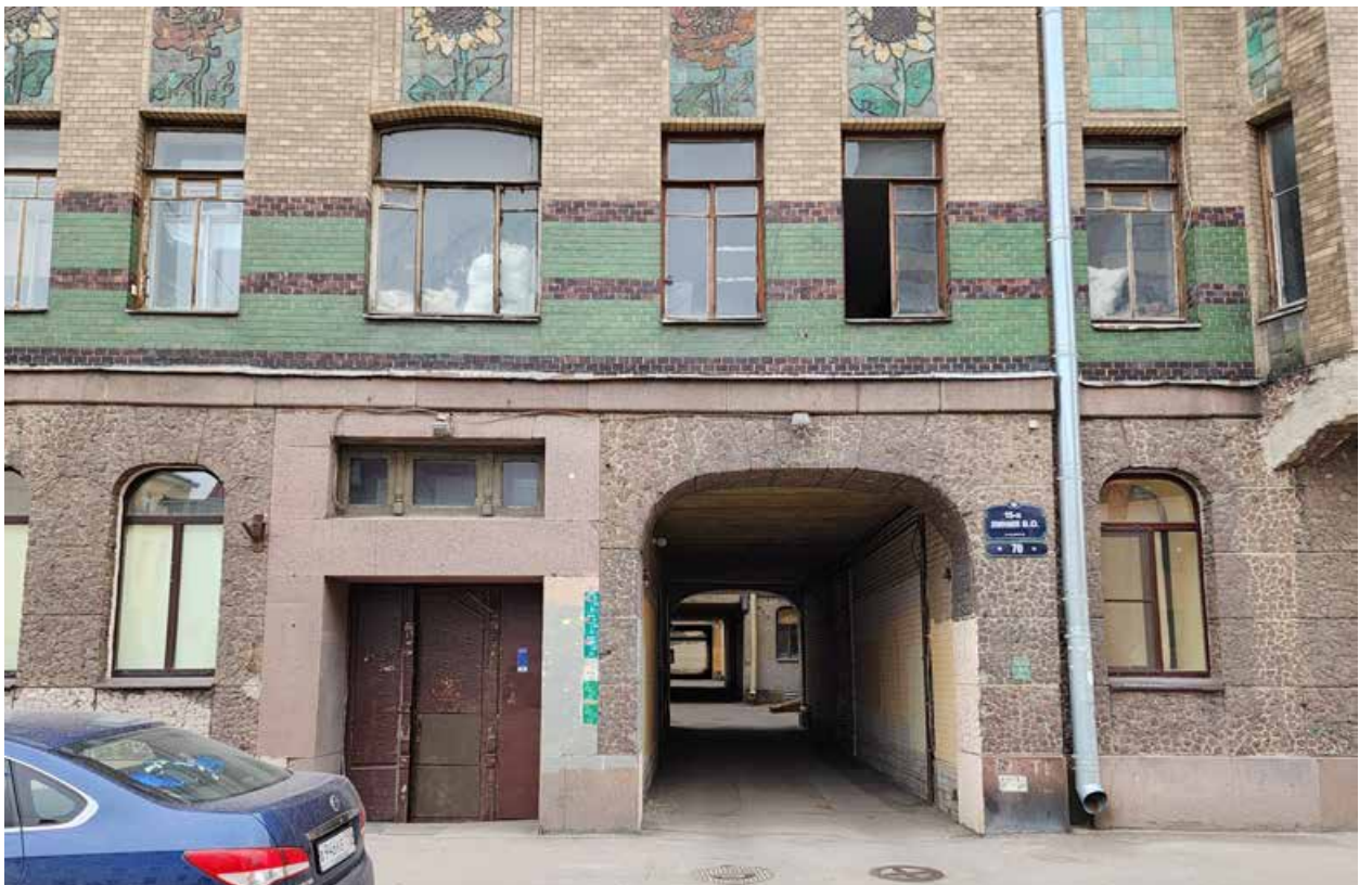
Фото 7. Лицевой фасад. Дверное заполнение. Арочный проезд.
