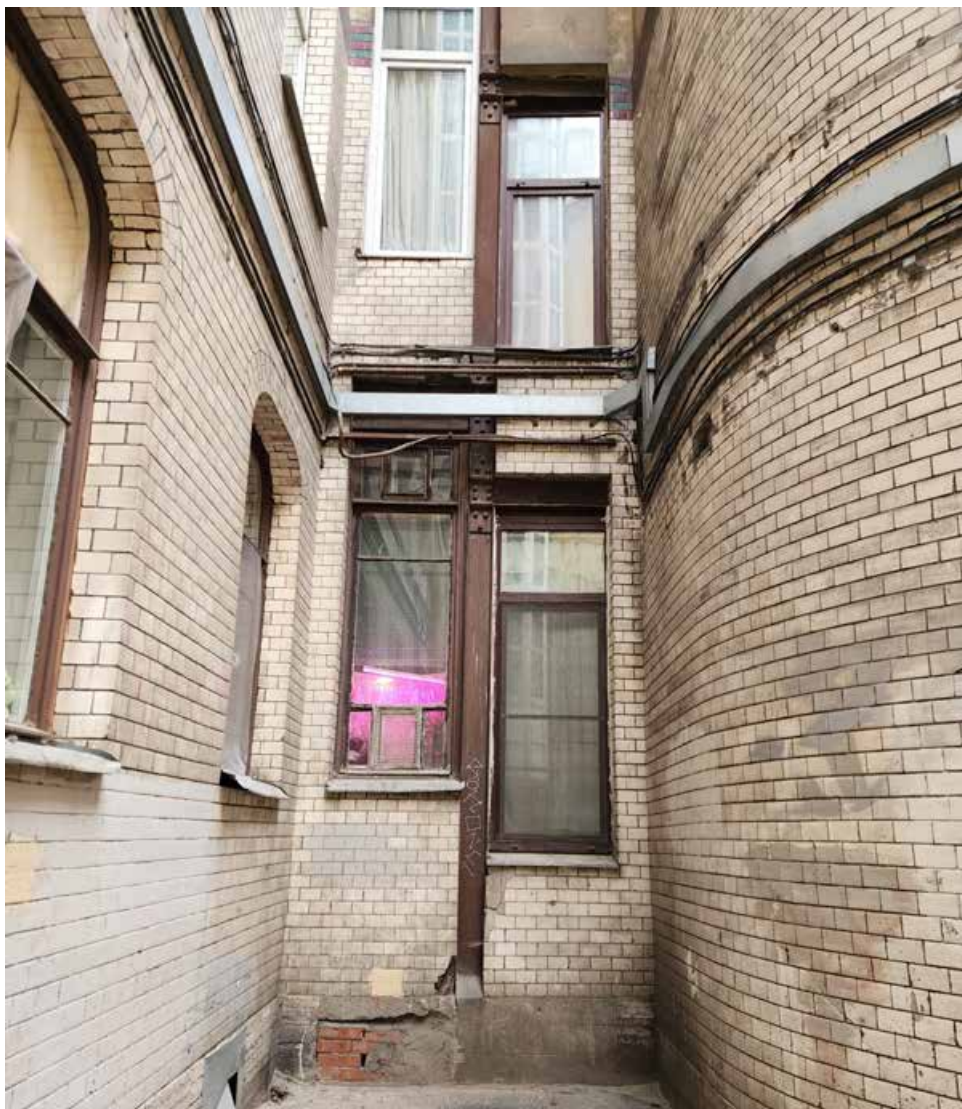
Фото 12. Дворовой фасад. Двухэтажные металлические балки.
