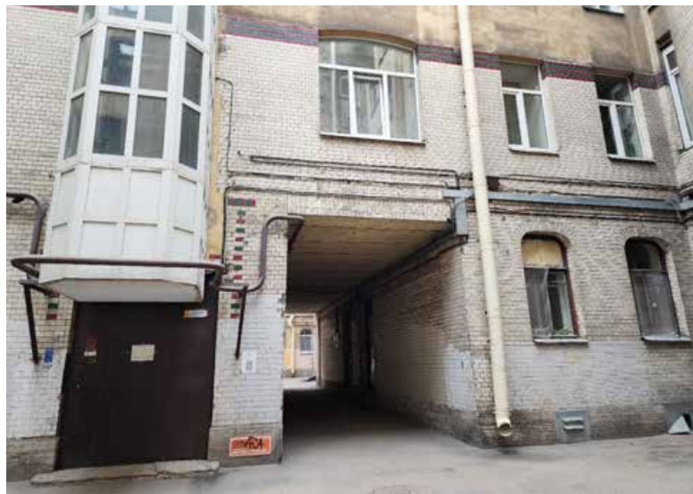
Фото 15. Дворовой фасад. Арочный проезд во 2-ой двор.
