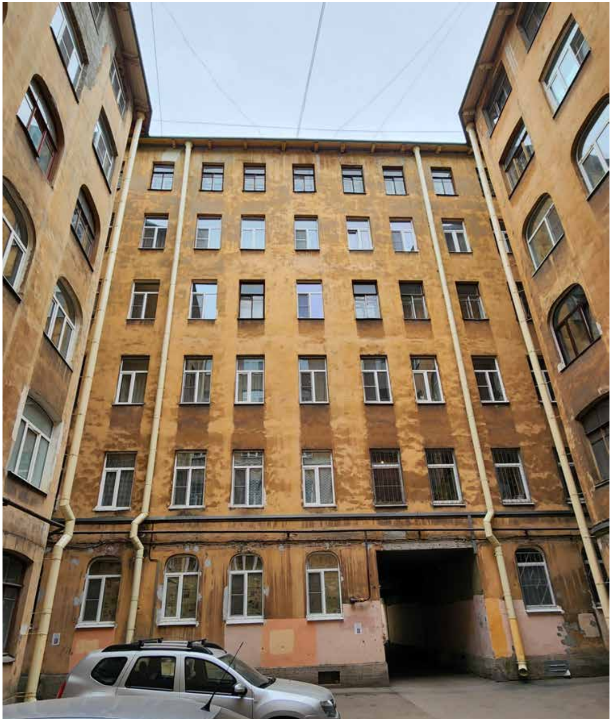
Фото 20. Дворовой фасад 2-го двора.
