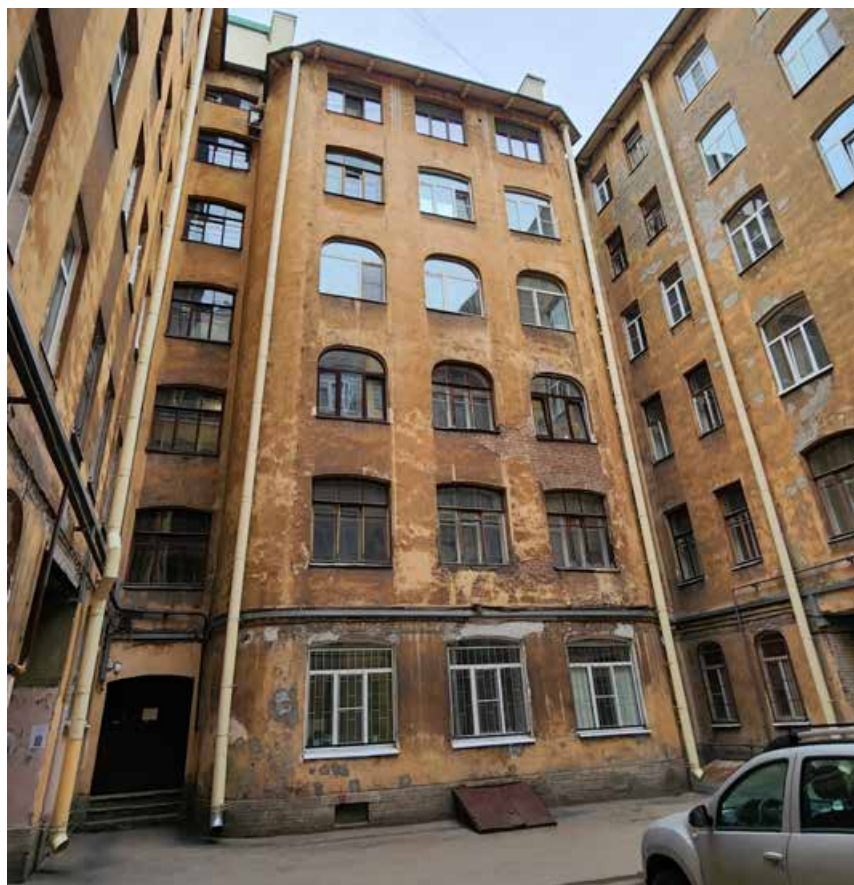
Фото 21 Дворовой фасад 2-го двора.
