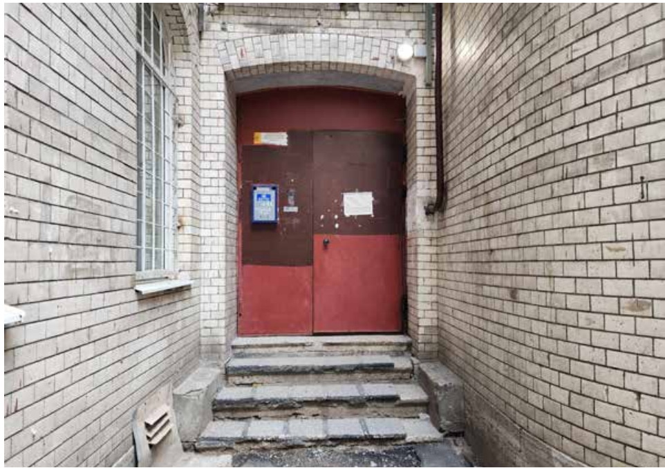
Фото 11. Дворовой фасад. Ступени. Дверное заполнение.
