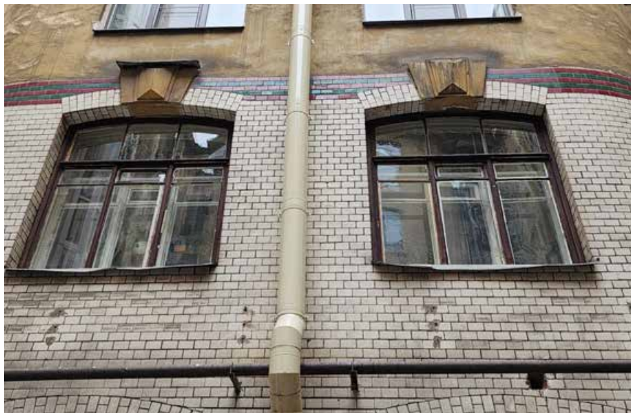
Фото 13. Дворовой фасад. Оконное заполнение в уровне 2 -го этажа.
