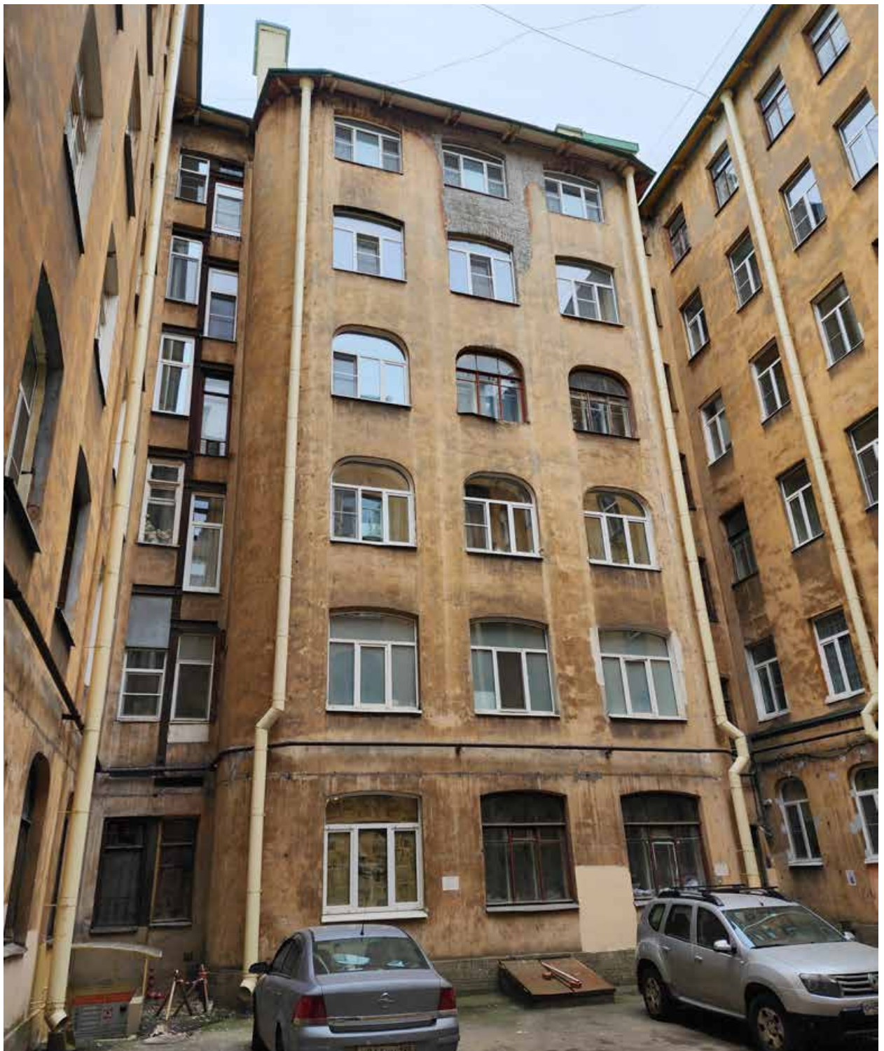
Фото 19. Дворовой фасад 2-го двора.
