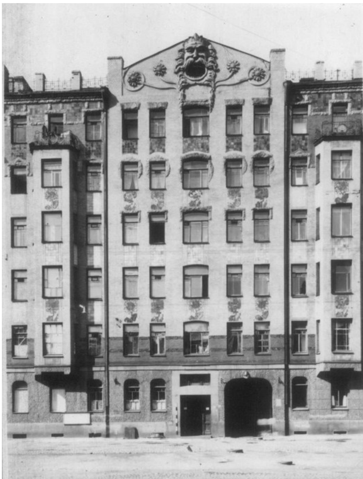
24. Фото 1949. ЦГАКФФД СПб. Гр 70083. Вид фасада дома №70 на 15-й линии Васильевского острова (бывший доходный дом М.М.Кудрявцева, архитектор М.Ф.Еремеев, 1910-1911 гг.).
