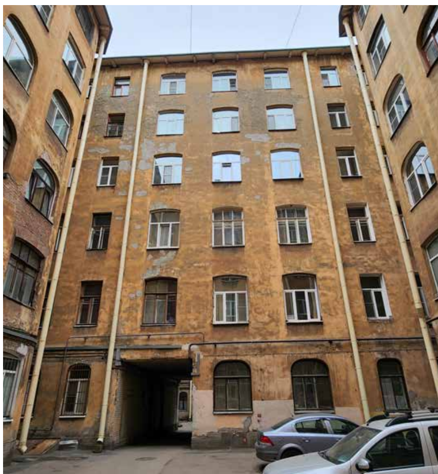
Фото 22 Дворовой фасад 2-го двора.
