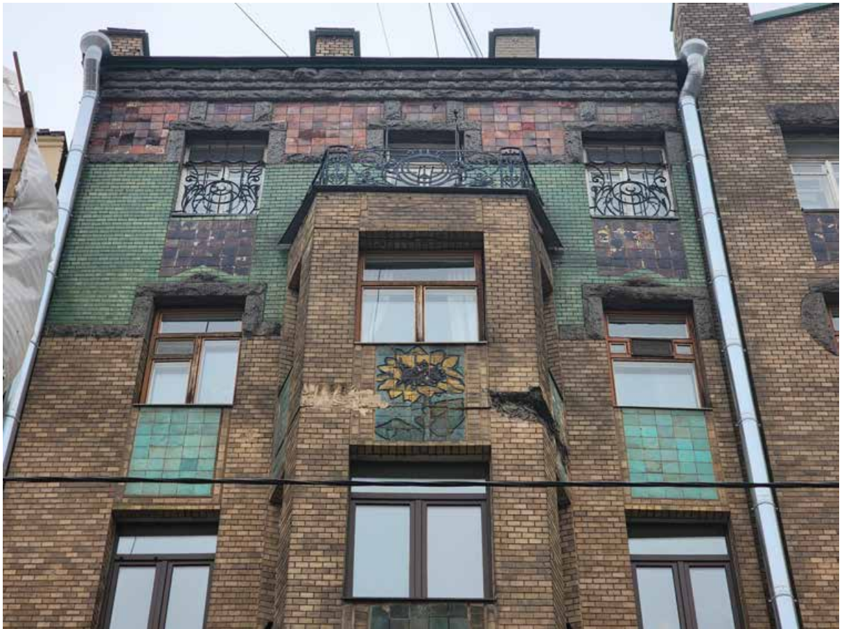
Фото 5. Лицевой фасад. Левый эркер. Балкон. Венчающий карниз из гранита.
