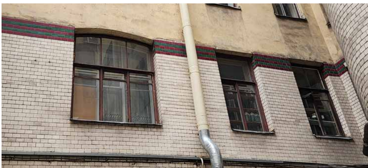
Фото 18. Дворовой фасад. Заполнение оконных проемов 2 -го этажа.
