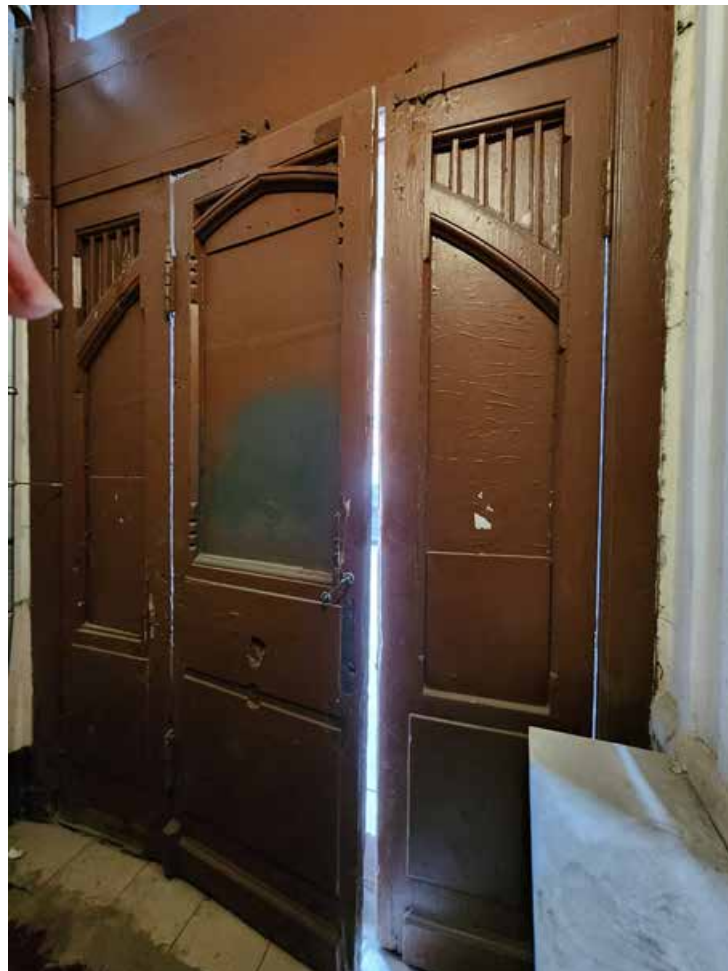
Фото 8. Лицевой фасад. Дверное заполнение со стороны тамбура.
