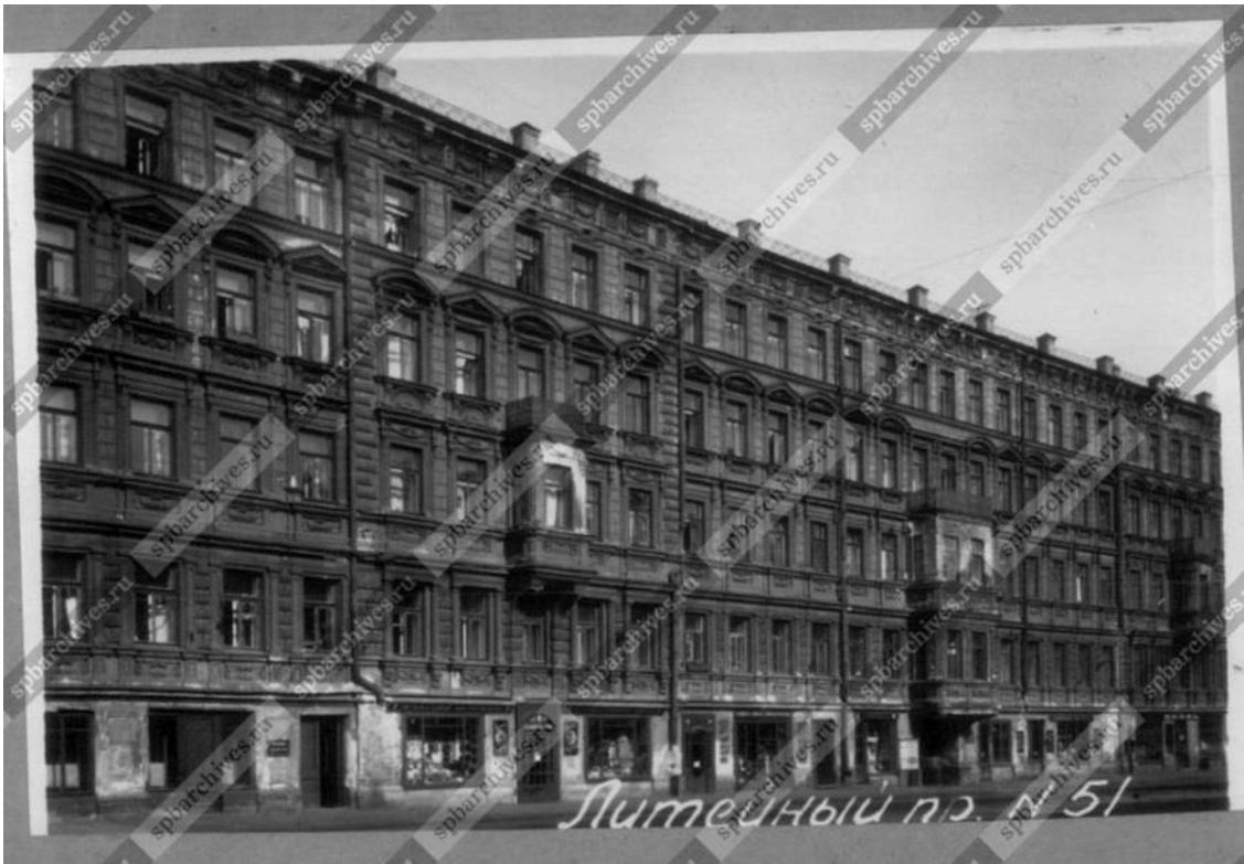
Илл. 19. Вид фасада дома №51 на Литейном проспекте. Дата съемки 1949 г. Автор съемки неизвестен. Направление съемки: северо-запад. // ЦГАКФФД СПб Гр 71983
