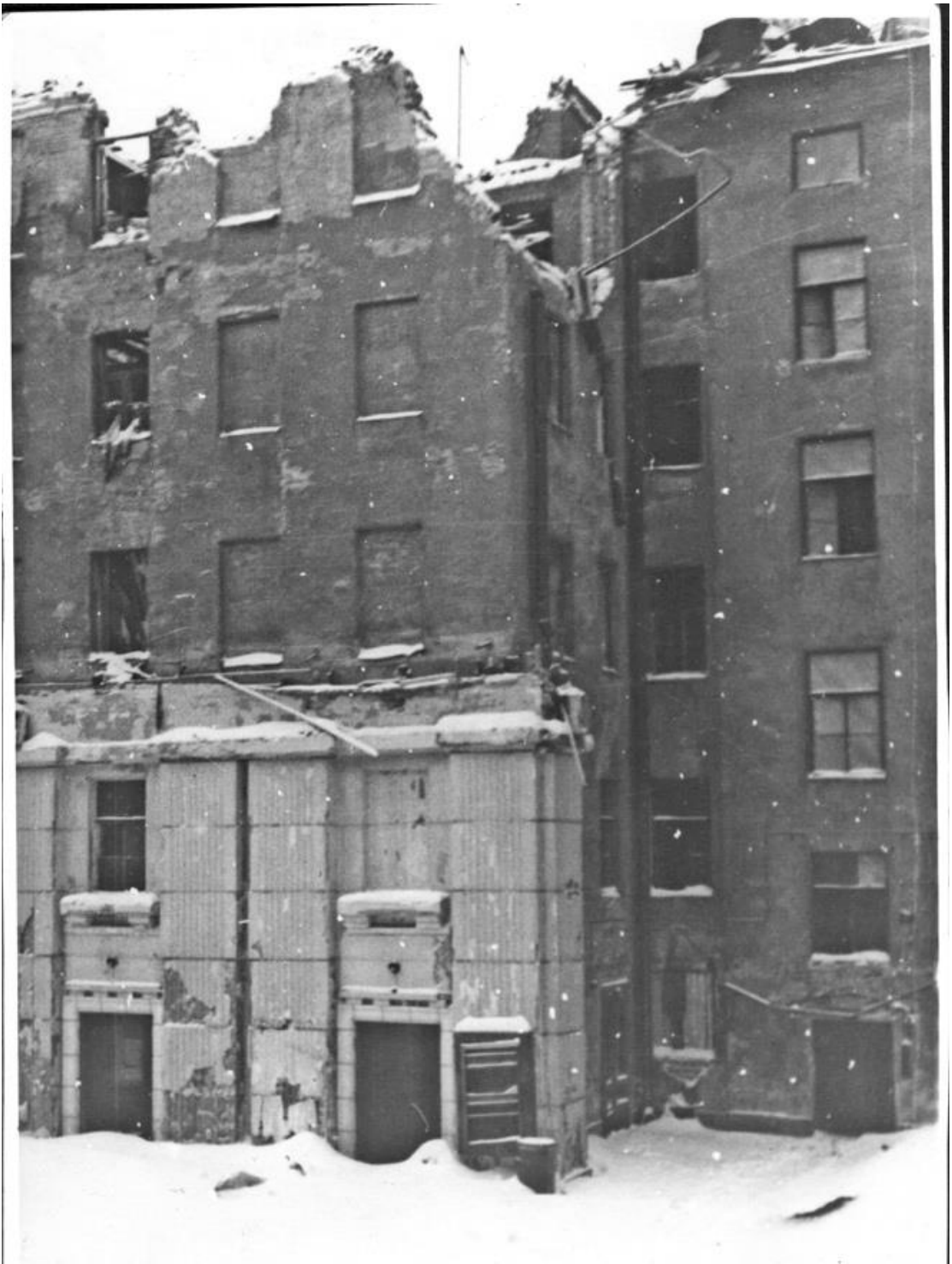
Илл. 18. Театр имени ЛОСПС, разрушенный авиабомбой. Дата съемки 26 декабря 1941 г.
