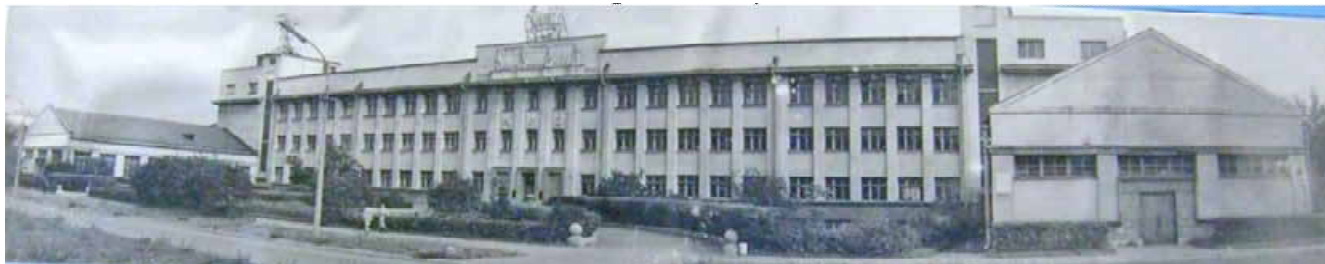
Илл.29. ВНИИГ им. Веденева Лицевой корпус. Фото 1971 г. По материалам музея ОАО ВНИИГ им. Б.Е. Веденева.
