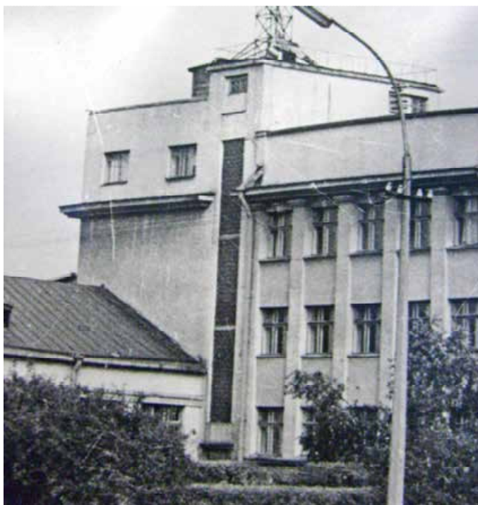
Илл.31. ВНИИГ им. Веденева Лицевой корпус. Фото 1971 г. По материалам музея ОАО ВНИИГ им. Б.Е. Веденева.
