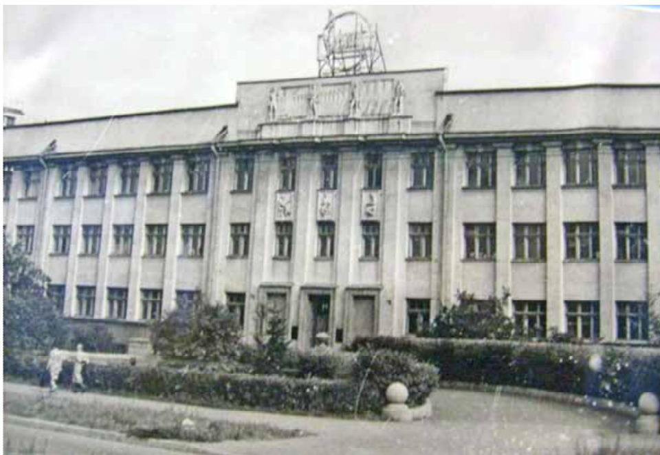
Илл.30. ВНИИГ им. Веденева Лицевой корпус. Фото 1971 г. По материалам музея ОАО ВНИИГ им. Б.Е. Веденева.
