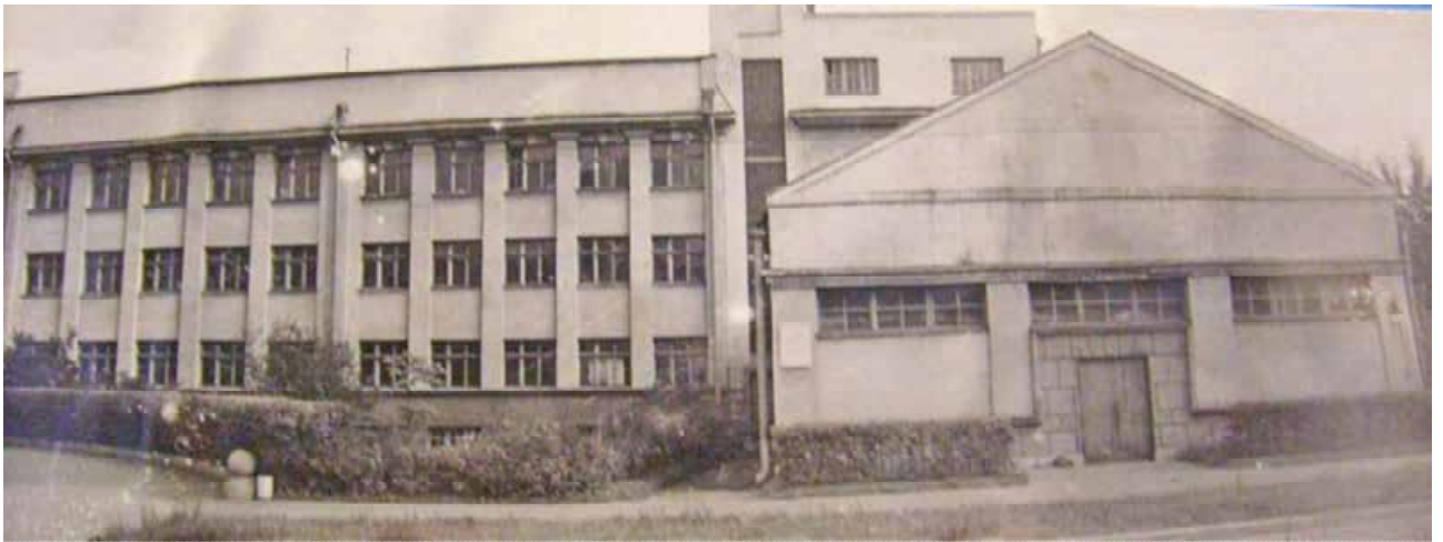
Илл.27. ВНИИГ им. Веденева Лицевой корпус. Фото 1960-х гг. По материалам музея ОАО ВНИИГ им. Б.Е. Веденева.
