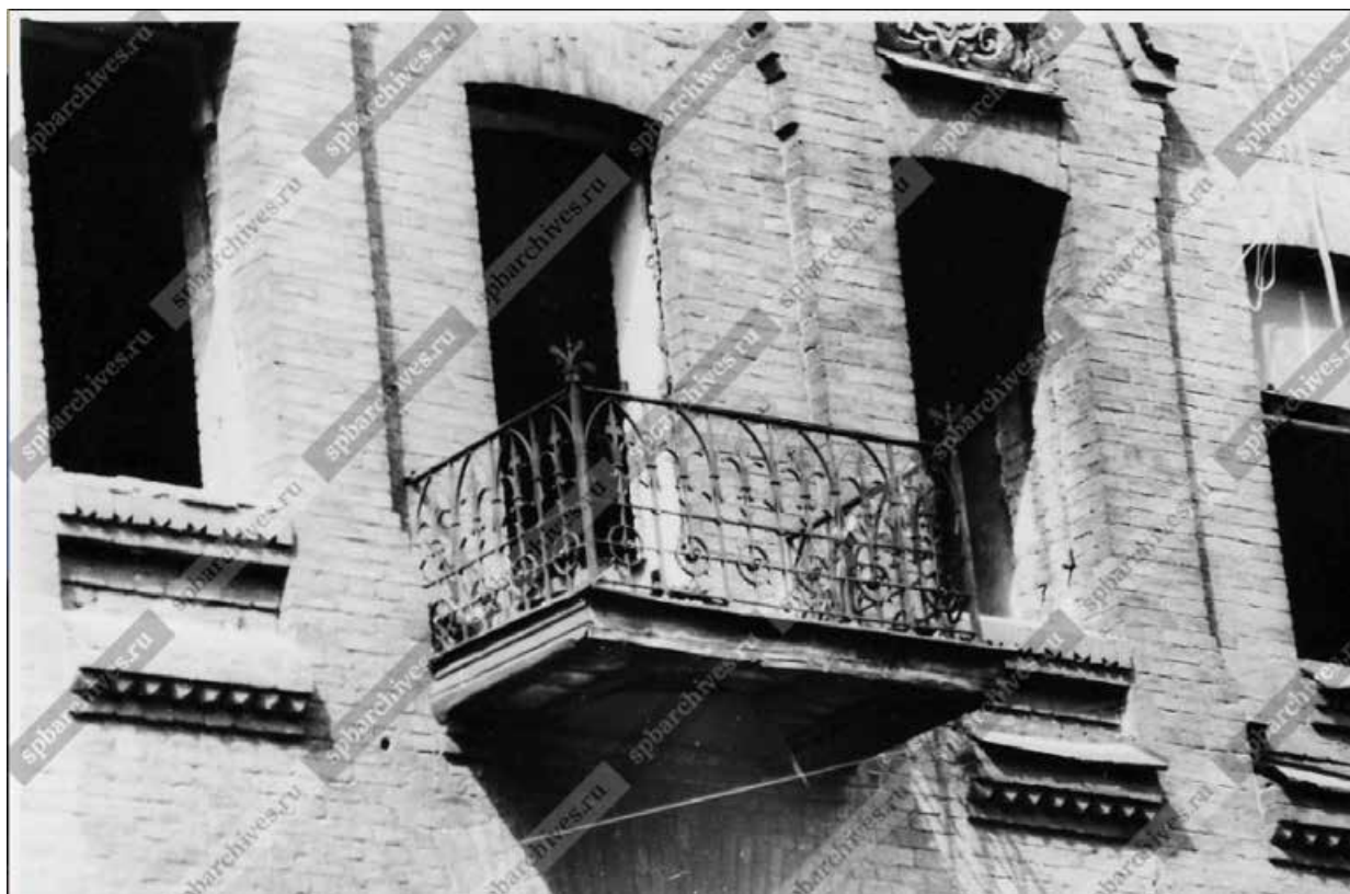
16. Вид балкона, оформленного ажурной решеткой, на фасаде жилого дома № 3 в Зоологическом переулке во время капитального ремонта (бывший дом А.А.Шретера, архитектор В.А.Шретер, 1881-1882 гг.). ЦГАКФФД СПб. Фотодокумент Ар 222335. Дата съёмки: 30 мая 1986 г.
