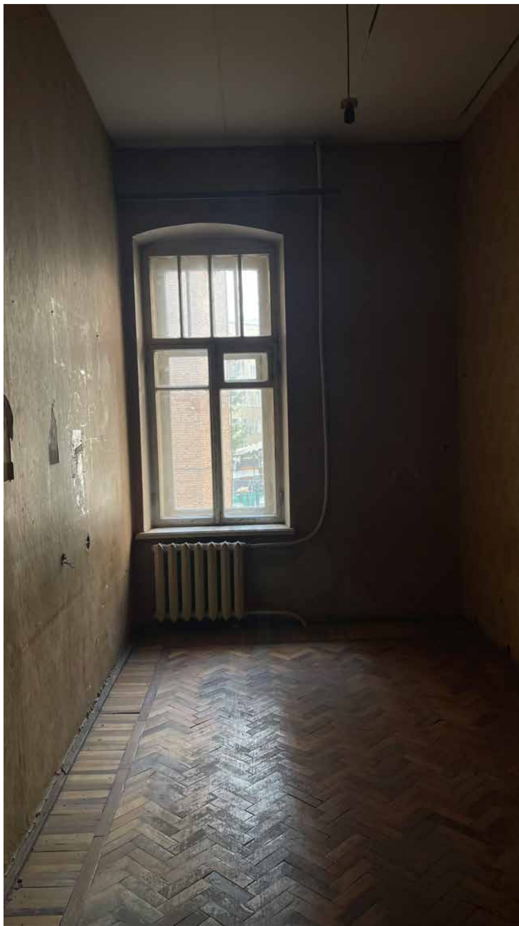
9. Фрагмент интерьера комнаты (помещение 3/13.6);
