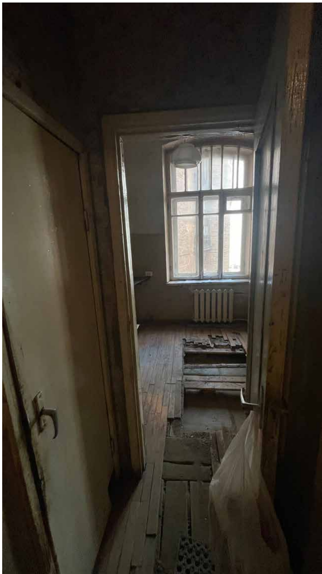
12.Фрагмент интерьера коридора (помещение 1/14.7);
