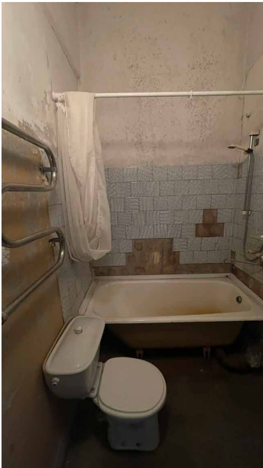
13. Фрагмент интерьера санузла (помещение 7);
