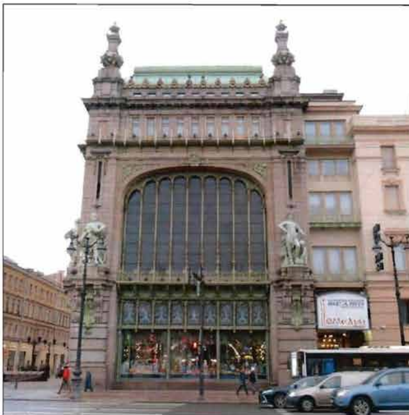
2. Лицевой фасад объекта культурного наследия по Невскому пр.
