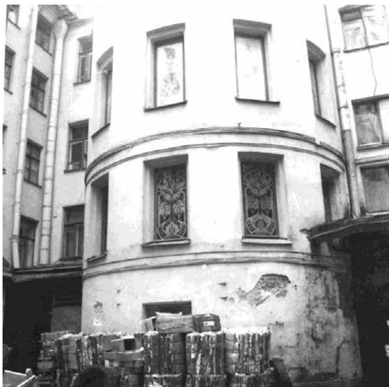
Илл. 32. Фасад здания театра (вид со двора) по Малой Садовой улице (дом №8). Автор съемки не установлен, 1983 г. ЦГАКФФД СПб. Бр 69103
