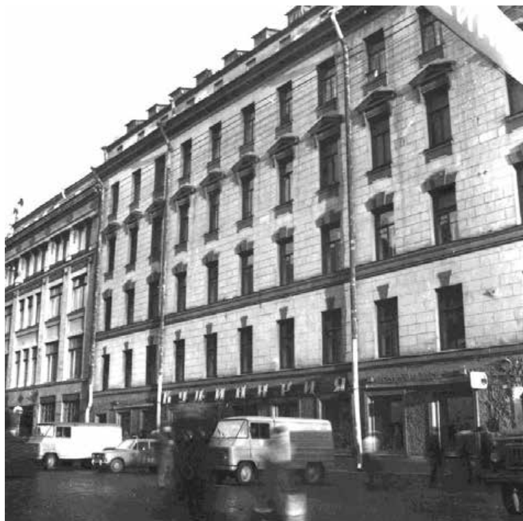
Илл. 29. Общий вид главного фасада дома №8 на Малой Садовой улице. Автор съемки не установлен, 1983 г. ЦГАКФФД СПб. Бр 68956
