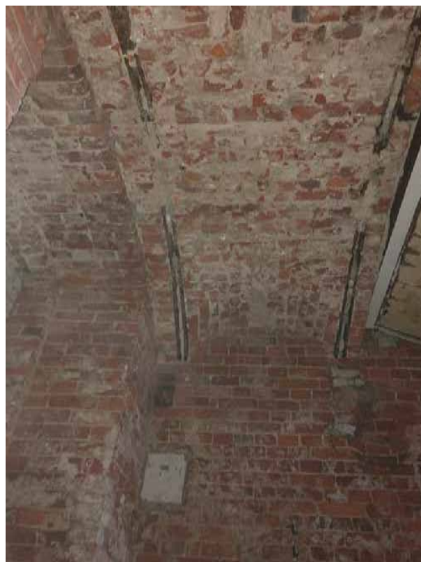
Фото 14. Вид на помещение № 13.
