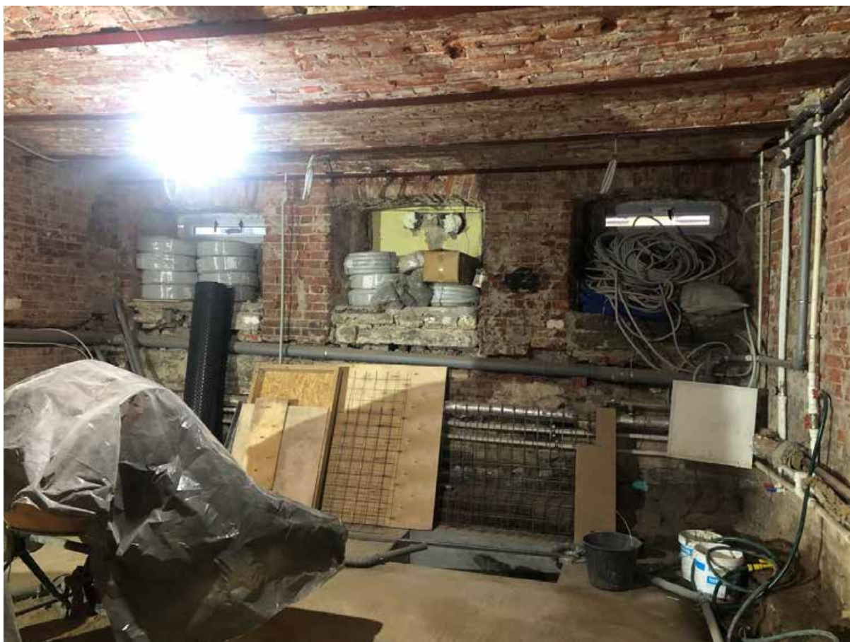
Фото 17. Вид на помещения №№ 17 и 18.
