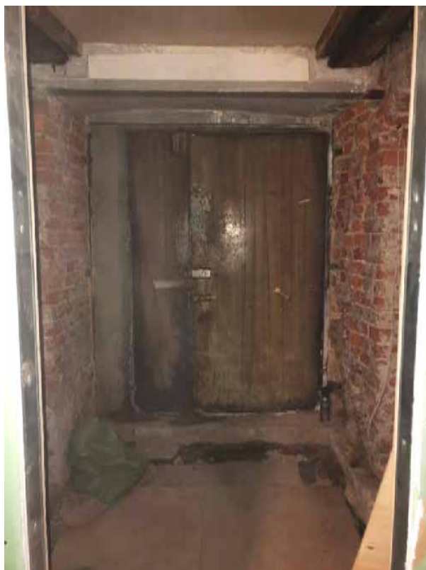
Фото 13. Вид на наружную входную дверь (вход со стороны двора).
