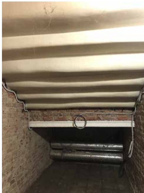
Фото 20. Вид на помещение под лестницей.
