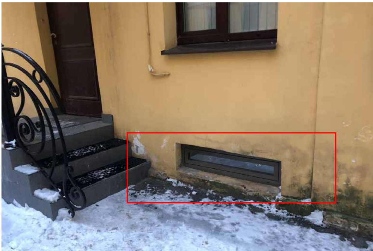
Фото 10. Вид на фрагмент дворового фасада.
