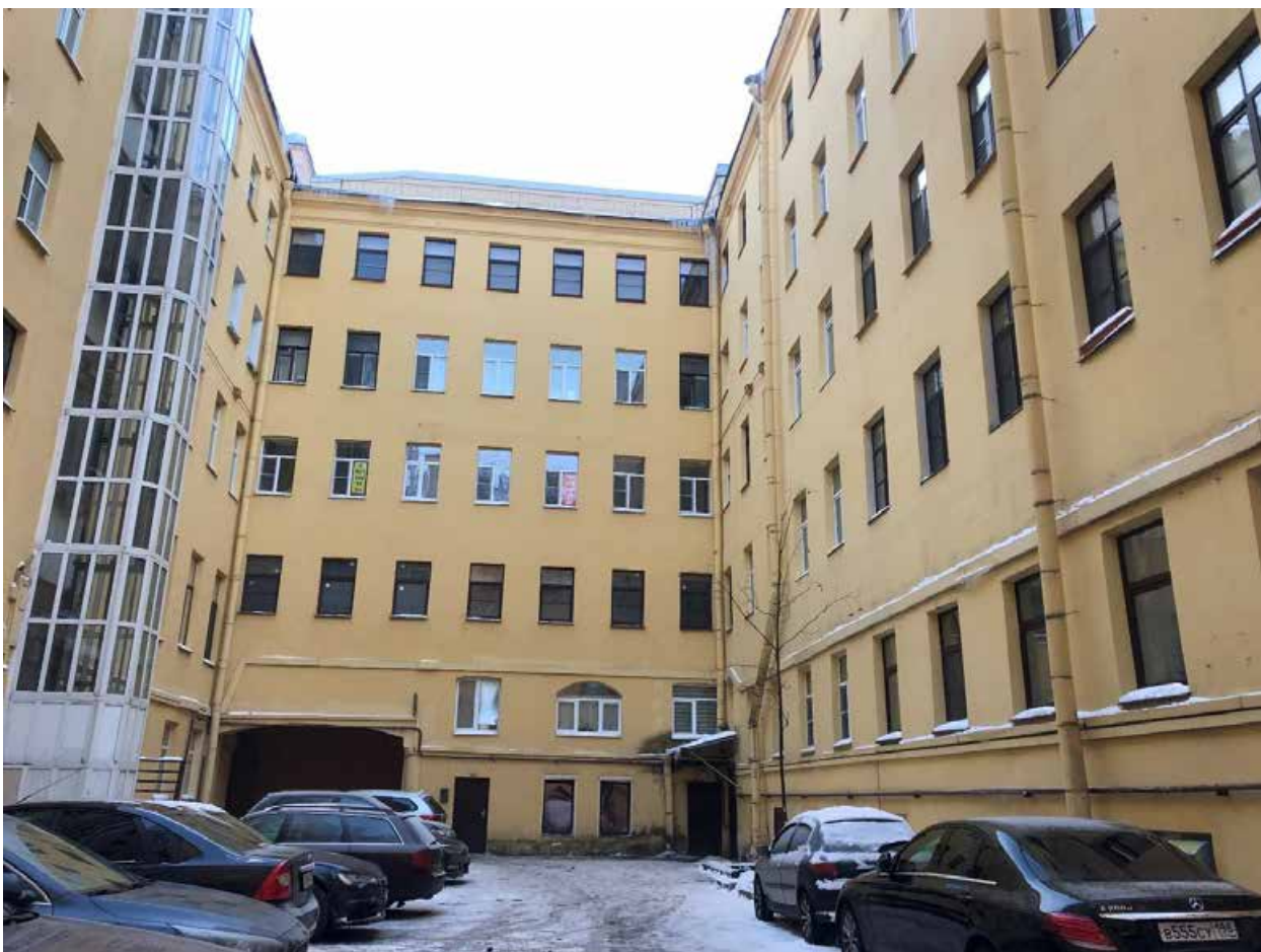
Фото 8. Вид на дворовые фасады.
