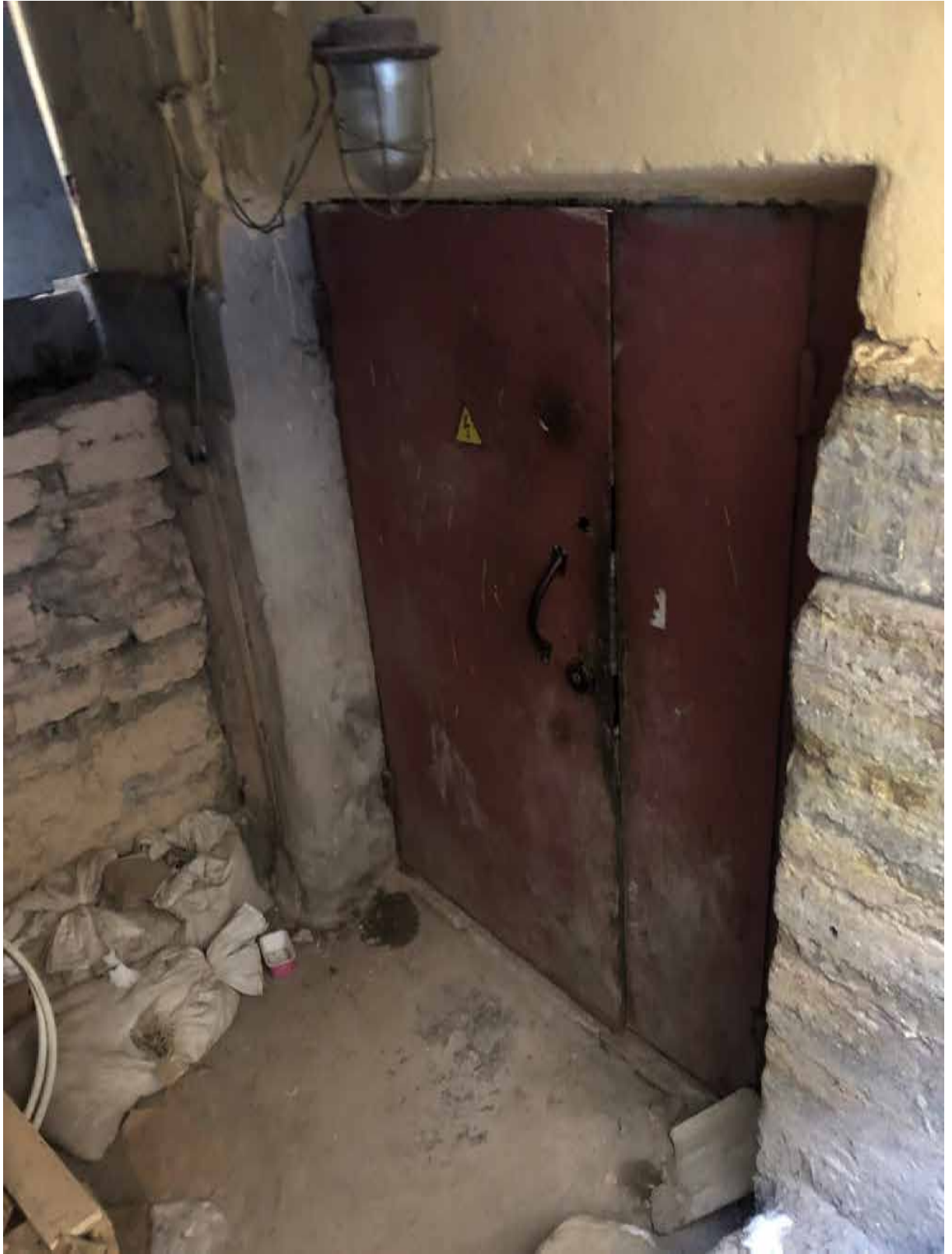
Фото 12. Вид на входную дверь со стороны дворового фасада.
