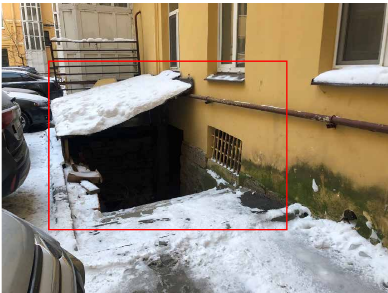
Фото 11. Вид на фрагмент дворового фасада.
