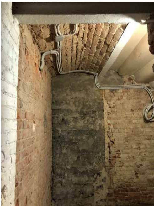
Фото 19. Вид на помещение под лестницей.
