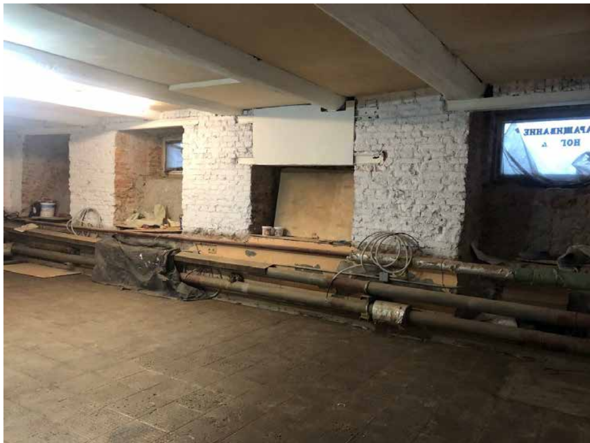
Фото 18. Вид на помещение № 24.
