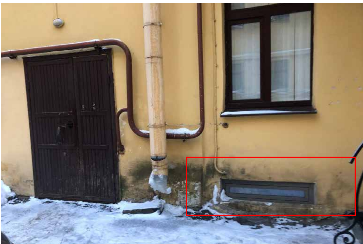
Фото 9. Вид на фрагмент дворового фасада.
