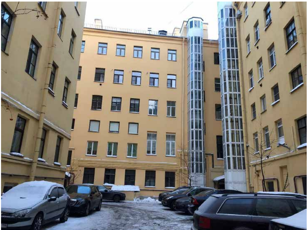
Фото 7. Вид на дворовые фасады..
