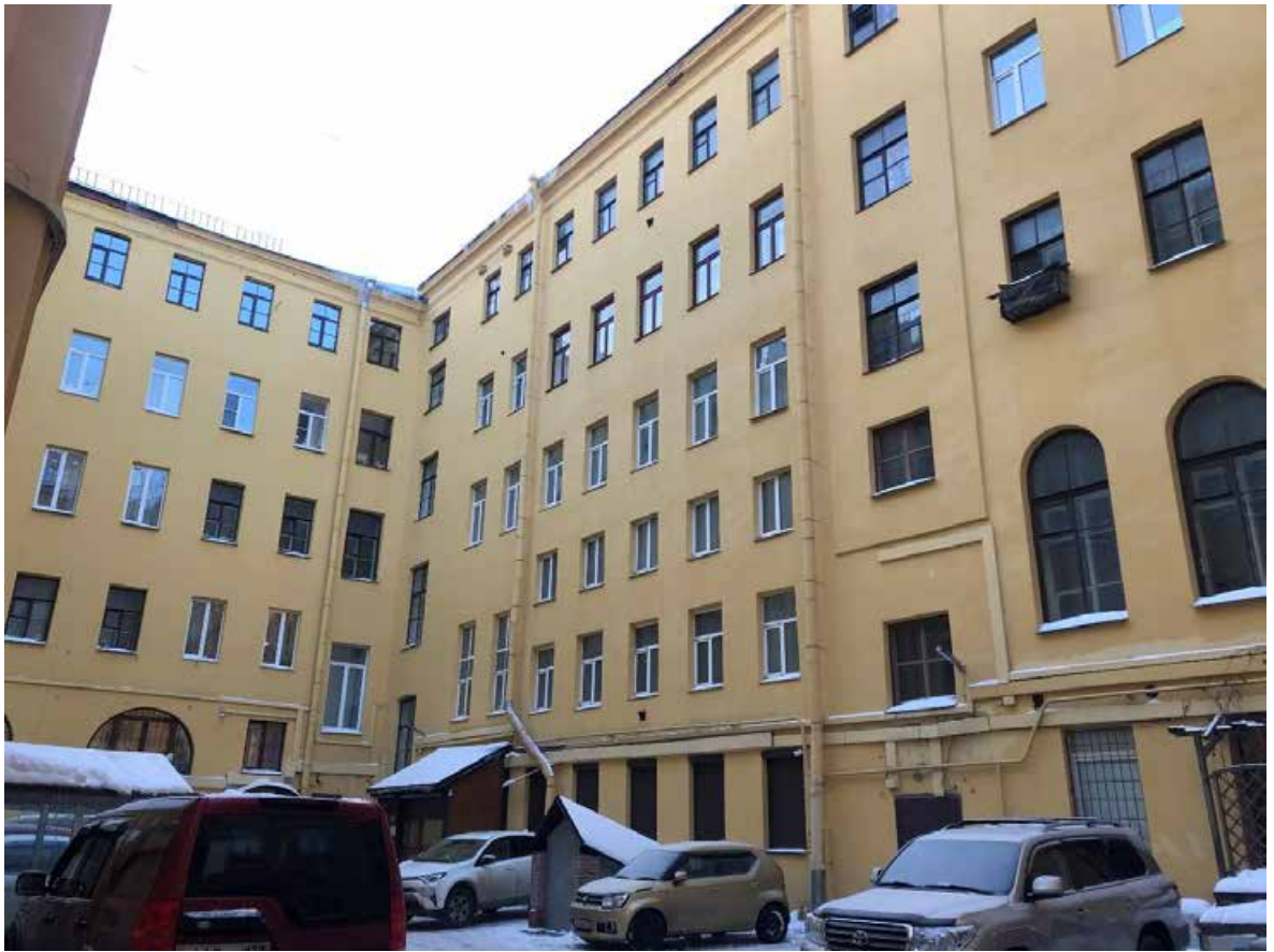
Фото 6. Вид на дворовые фасады.
