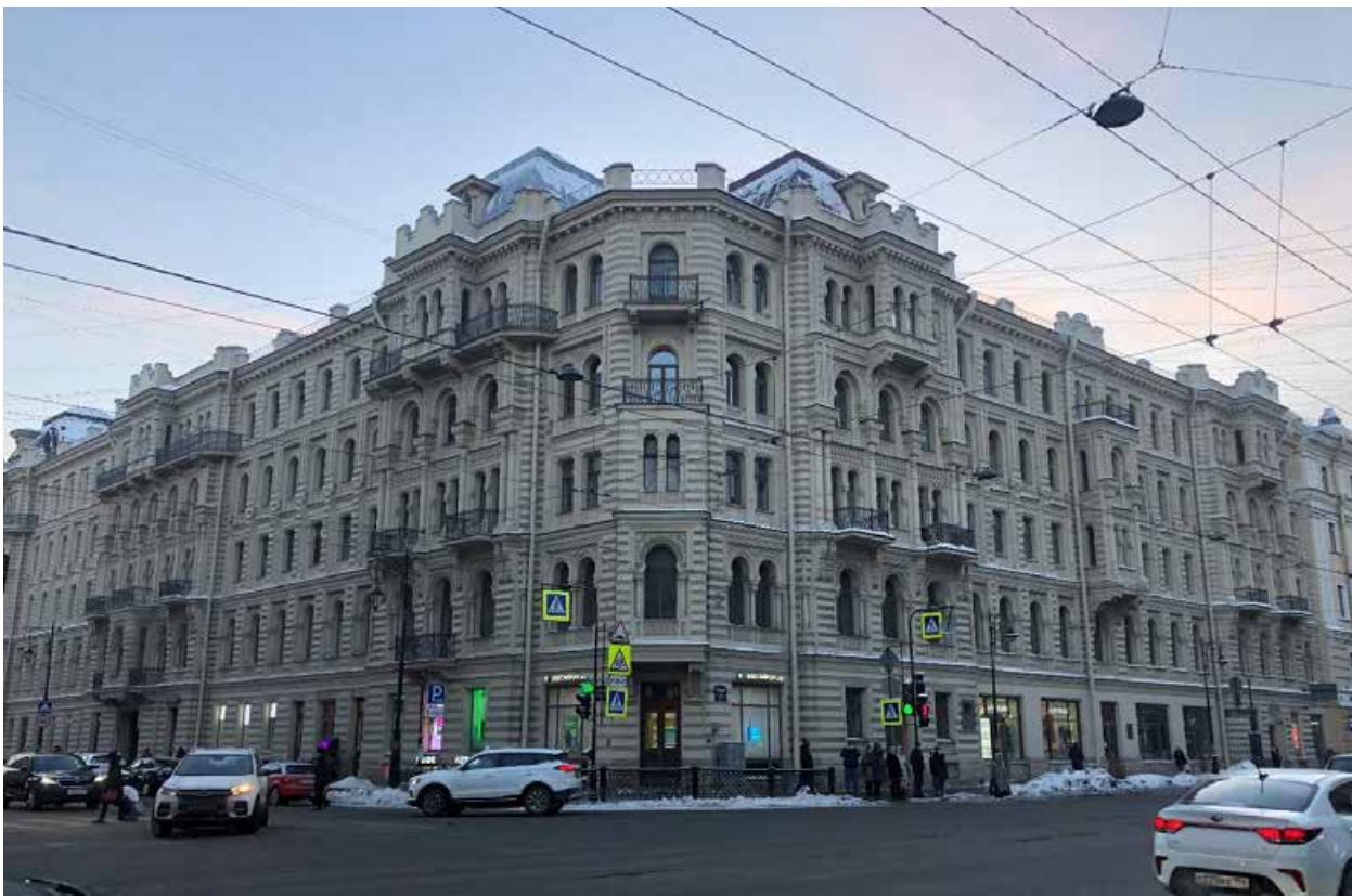
Фото 1. Вид на угол исследуемого здания на пересечении Литейного проспекта и улицы Пестеля.
