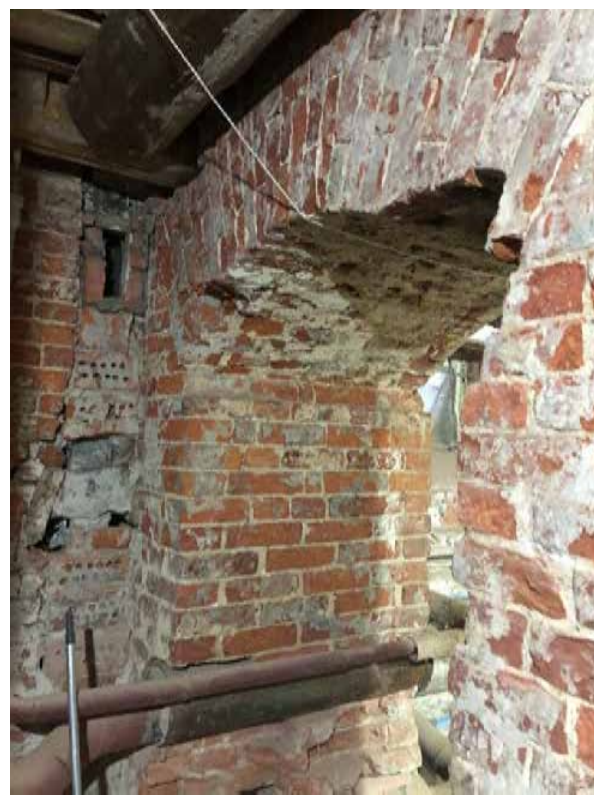
Фото 6. Проем между помещениями №№ 5 и 7.
