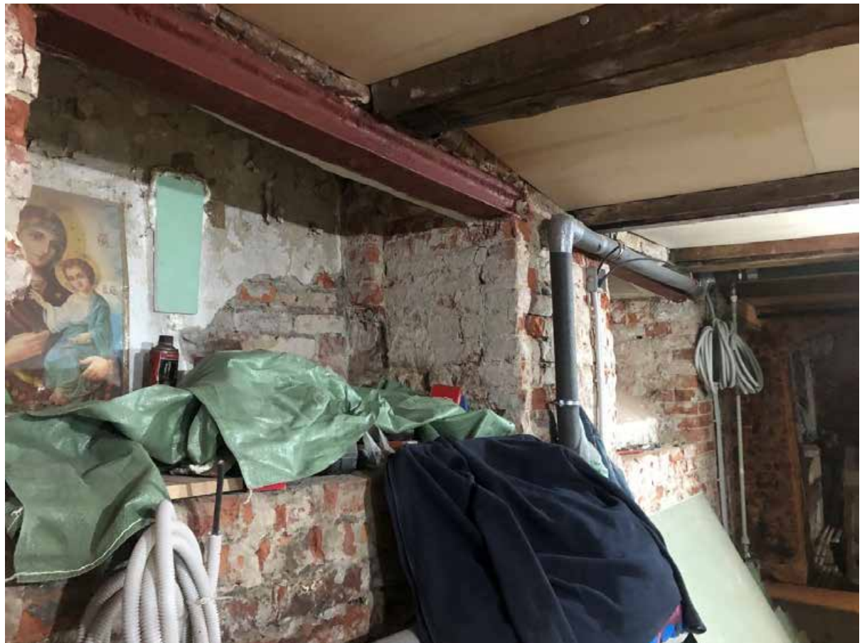
Фото 12. Оконные проемы в помещениях №№ 9, 10, 11.
