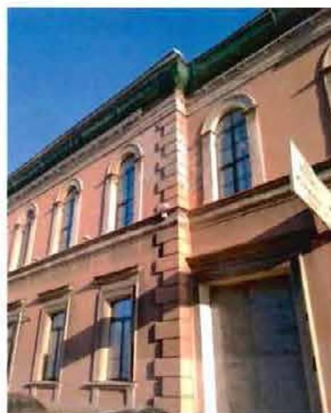
3. Фрагмент западного фасада. Воротный проем.
