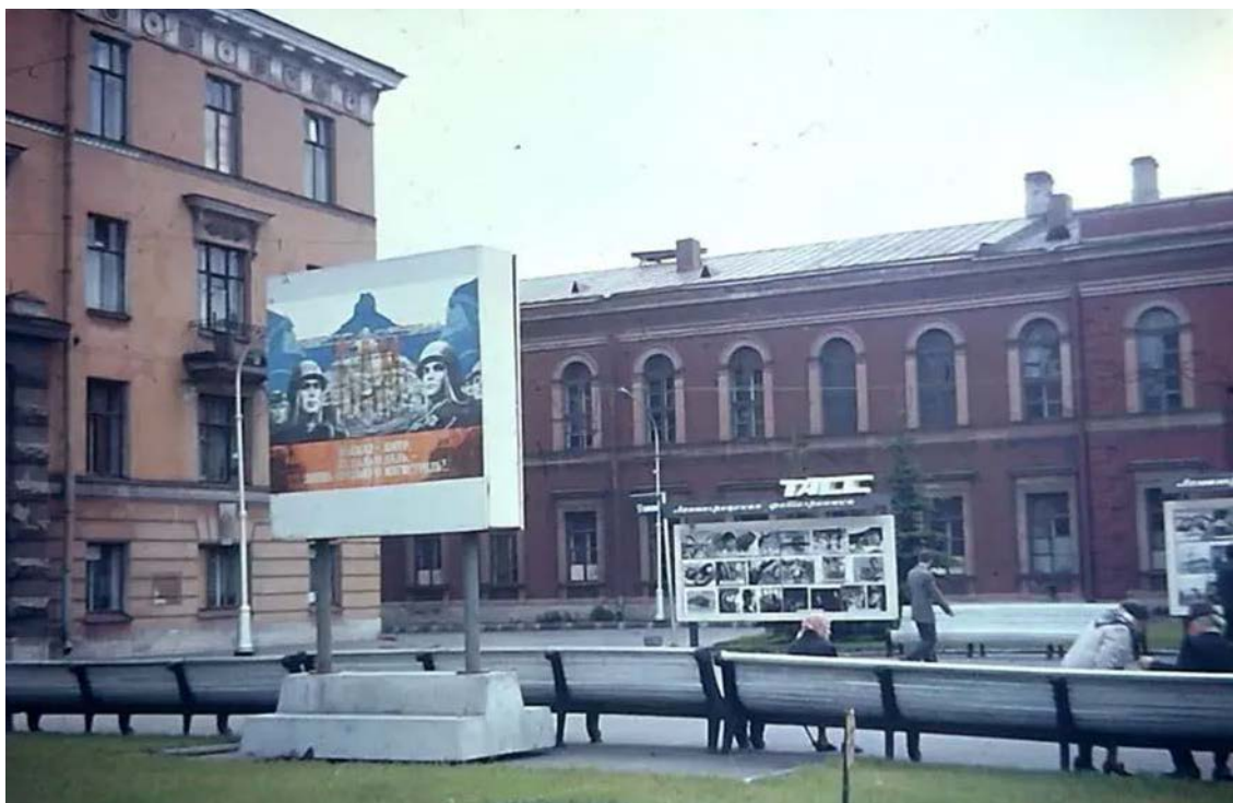
17. Фото 1975 год. Объект культурного наследия «Казармы с конюшнями». (СПб., Большая Морская ул., д. 67 лит. А)
