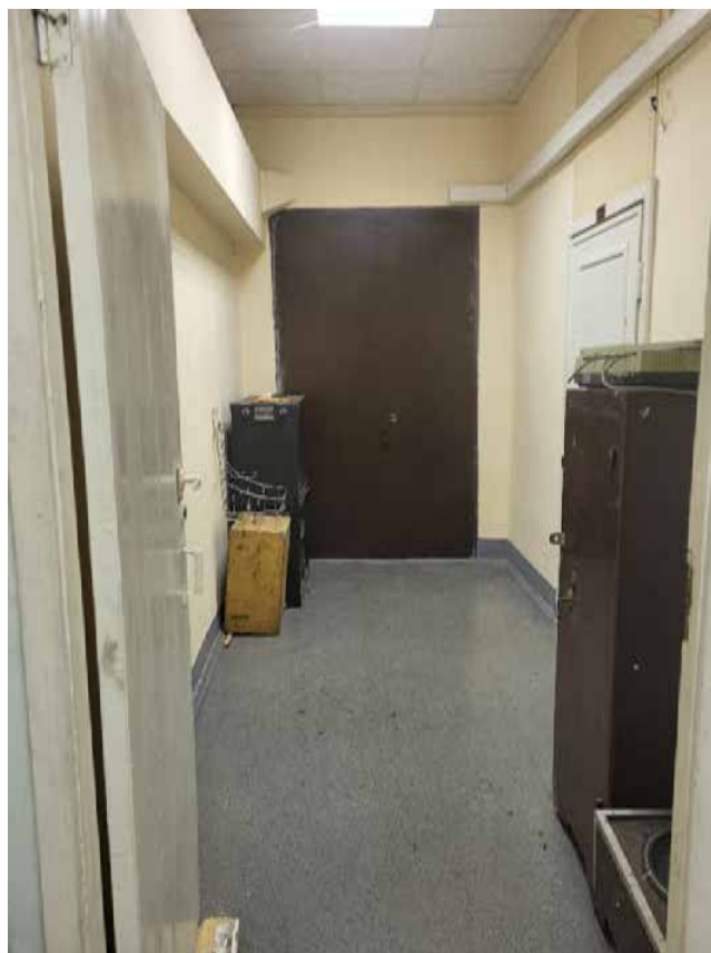
Фото 9. Объект культурного наследия федерального значения «Казармы с конюшнями», входящего в состав «Казармы лейб-гвардии конного полка» (г. Санкт-Петербург, Большая Морская ул., 67; Труда ул., 8-10; Якубовича ул., 26; Конногвардейский пер., 3-5). Актный зал.
