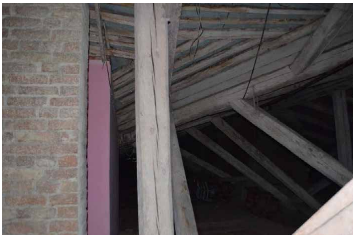
Фото 2. Объект культурного наследия федерального значения «Казармы с конюшнями», входящего в состав «Казармы лейб-гвардии конного полка» (г. Санкт-Петербург, Большая Морская ул., 67; Труда ул., 8-10; Якубовича ул., 26; Конногвардейский пер., 3-5). Чердачное пространство.
