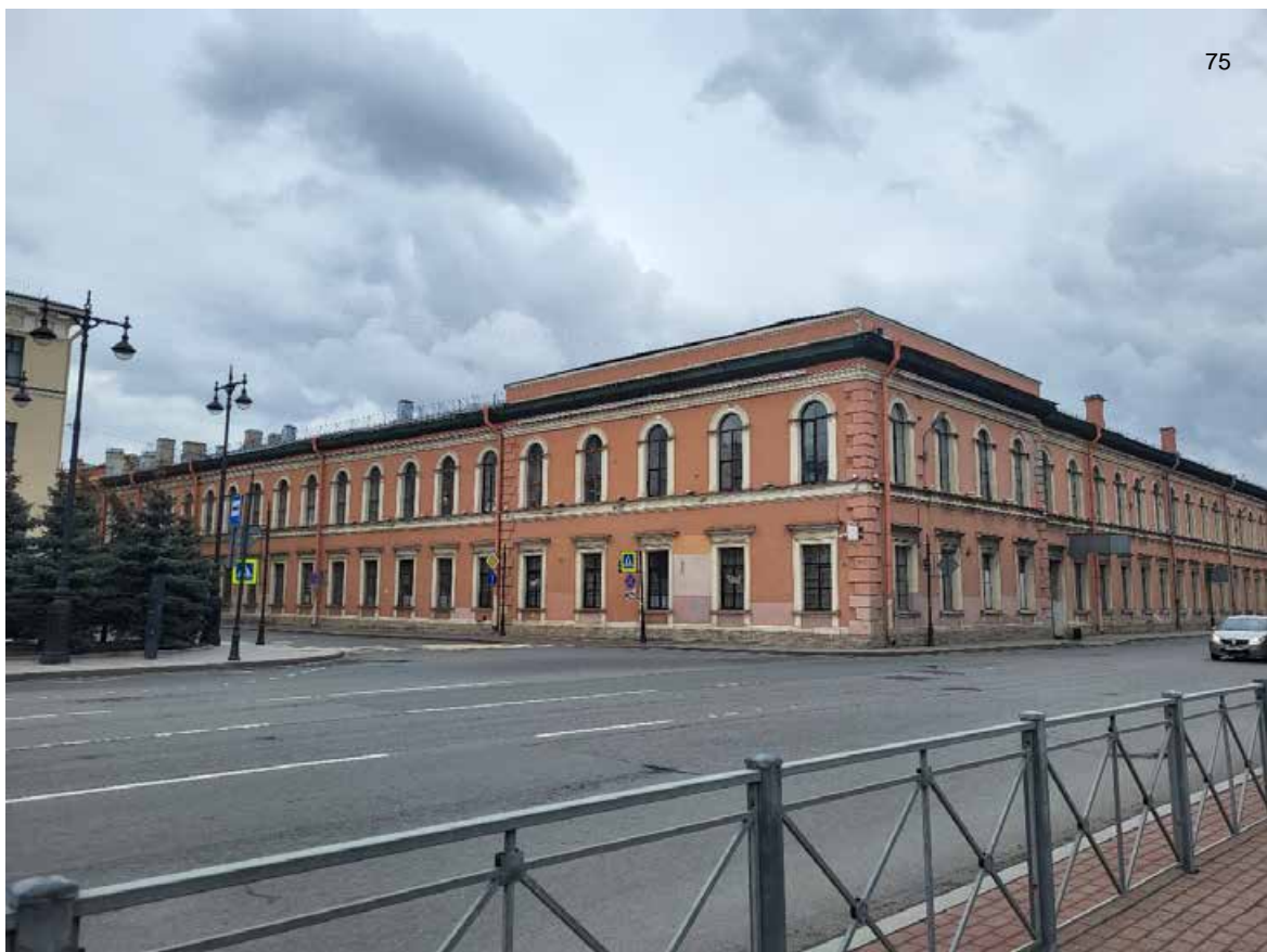
Фото 3. Объект культурного наследия федерального значения «Казармы с конюшнями», входящего в состав «Казармы лейб-гвардии конного полка» (г. Санкт-Петербург, Большая Морская ул., 67; Труда ул., 8-10; Якубовича ул., 26; Конногвардейский пер., 3-5) Дата съемки:01.03.2024
