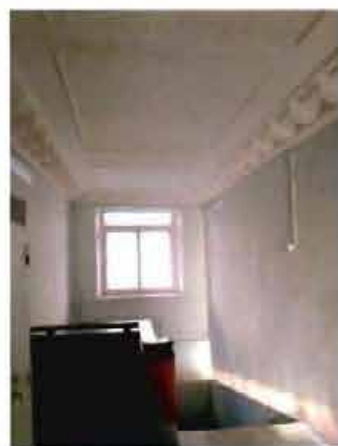
9. Лестница 1-го этажа.
