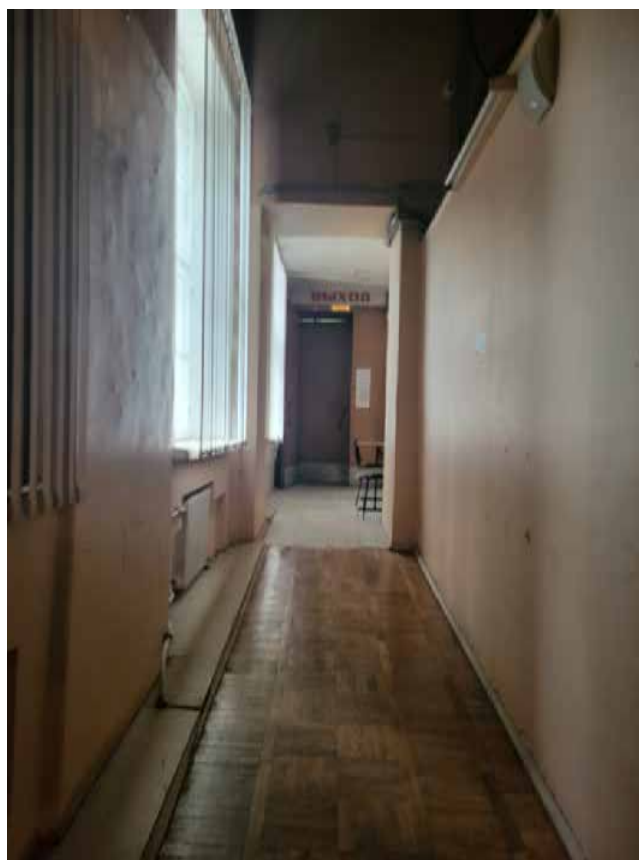
Фото 10. Объект культурного наследия федерального значения «Казармы с конюшнями», входящего в состав «Казармы лейб-гвардии конного полка» (г. Санкт-Петербург, Большая Морская ул., 67; Труда ул., 8-10; Якубовича ул., 26; Конногвардейский пер., 3-5). Актный зал.
