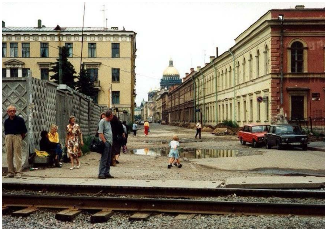
19. Фото 1997 год. Объект культурного наследия «Казармы с конюшнями». Улица Якубовича со стороны площади Труда – угол здания. https://www.pastvu.com
