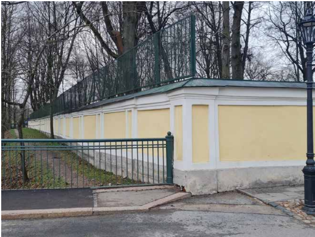
Фото 5. Объект культурного наследия федерального значения «Кладбище Тихвинское (Некрополь мастеров искусств)» в составе объекта культурного наследия федерального значения «Александрo-Невская лавра». Вид на каменную ограду кладбища (северо-восточный участок со стороны р. Монастырки).
