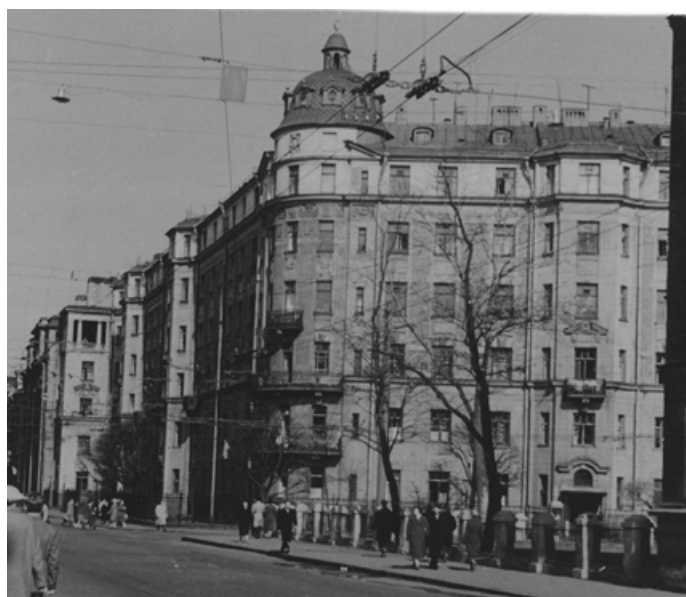
Илл. 18. Общий вид угловой части здания на пересечении Большой Пушкарской и Кронверкской улиц. 1962 г. Фрагмент. Интернет-ресурс https://pastvu.com/p/1330831 .
