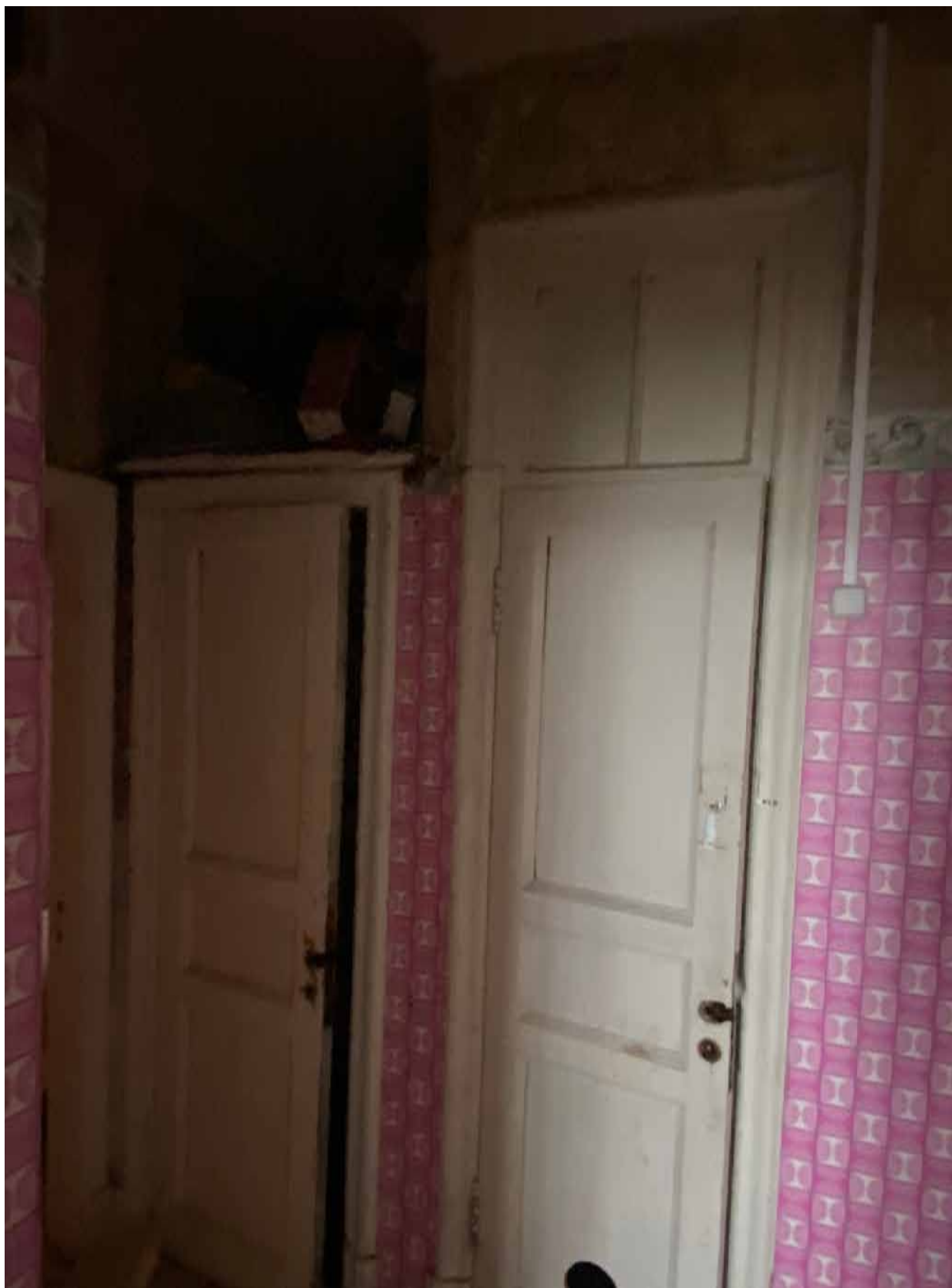
16.Фрагмент интерьера коридора (помещение 6/3.9);
