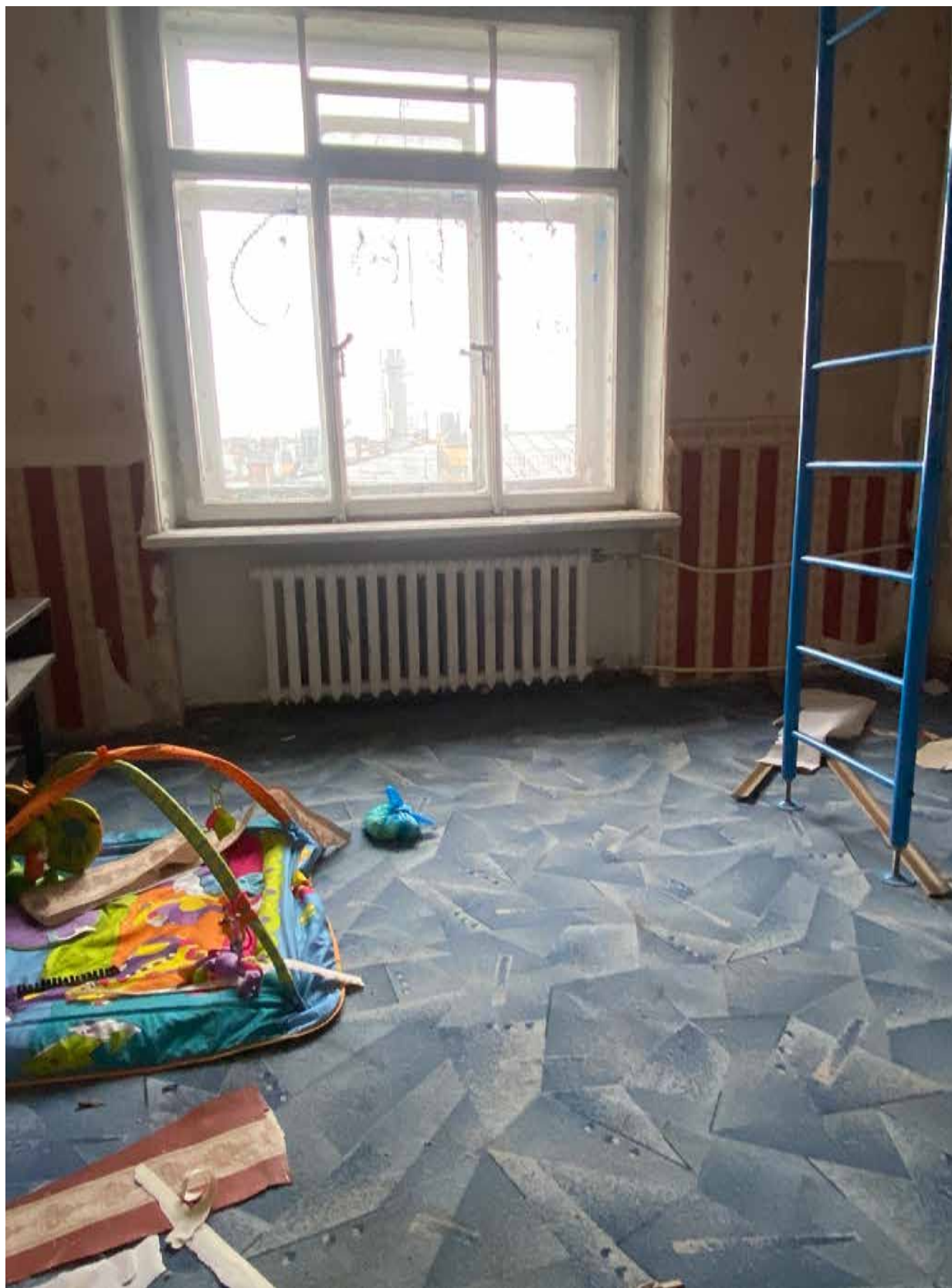
10.Фрагмент интерьера комнаты (помещение 1/28.7);
