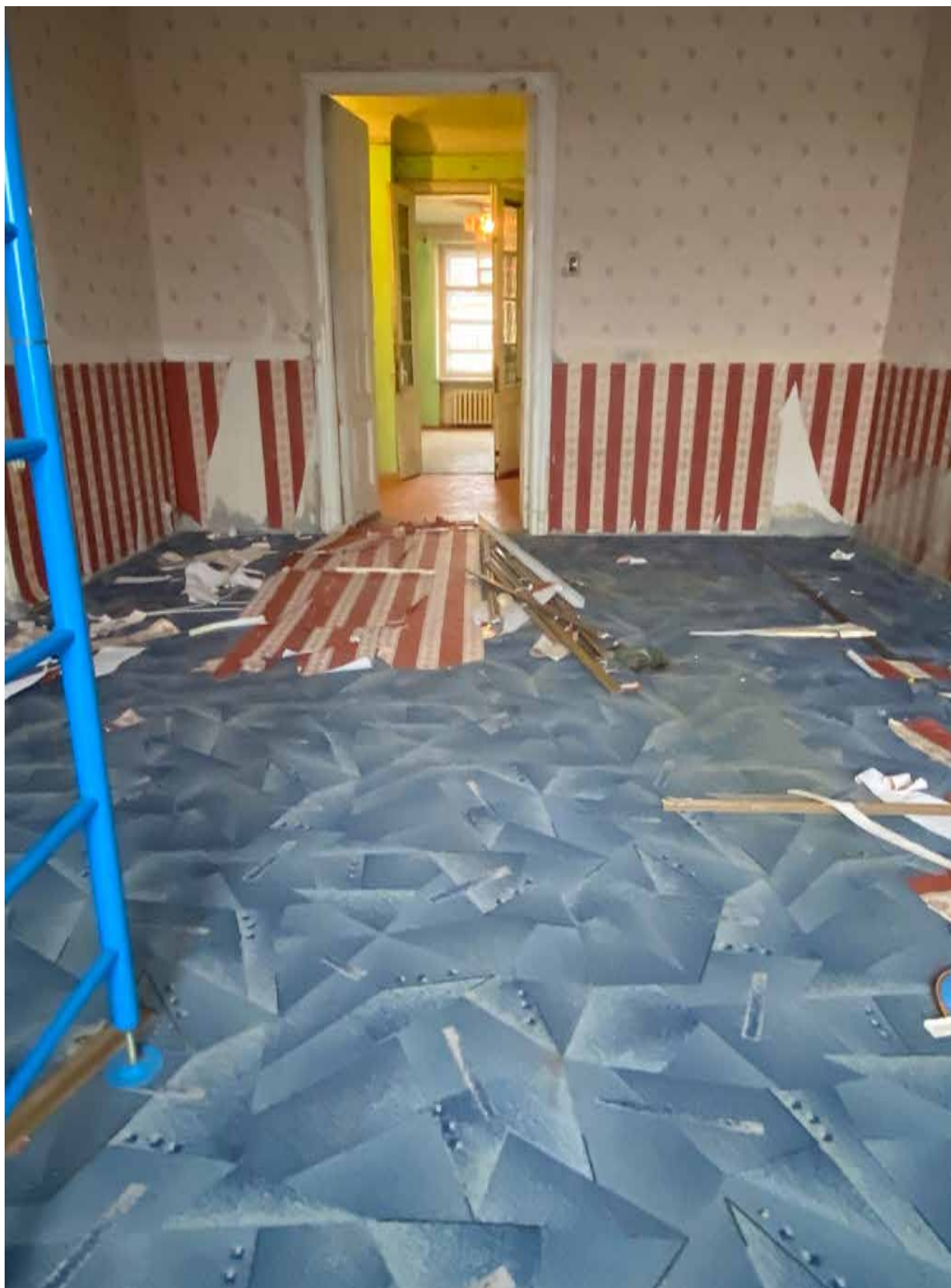
11.Фрагмент интерьера комнаты (помещение 1/28.7);
