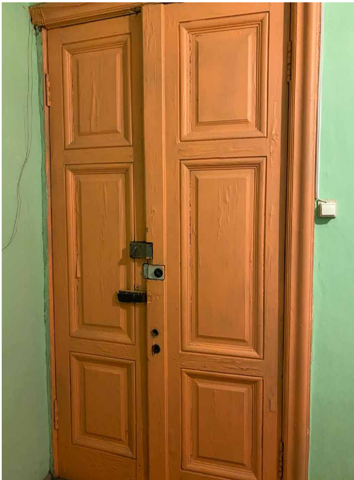
4. Вид на входную дверь в квартире;
