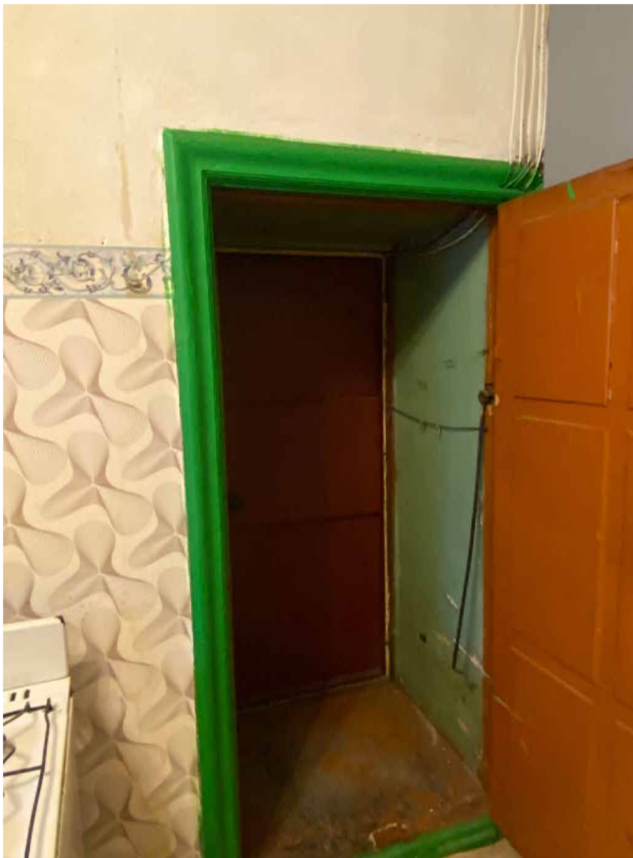
30. Вид на входную дверь в квартире;
