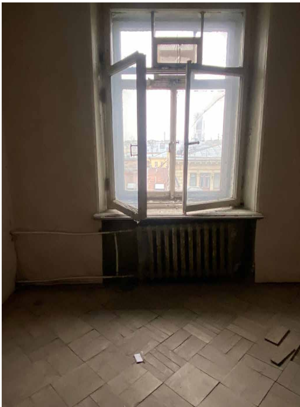
22.Фрагмент интерьера комнаты (помещение 2/22.7);
