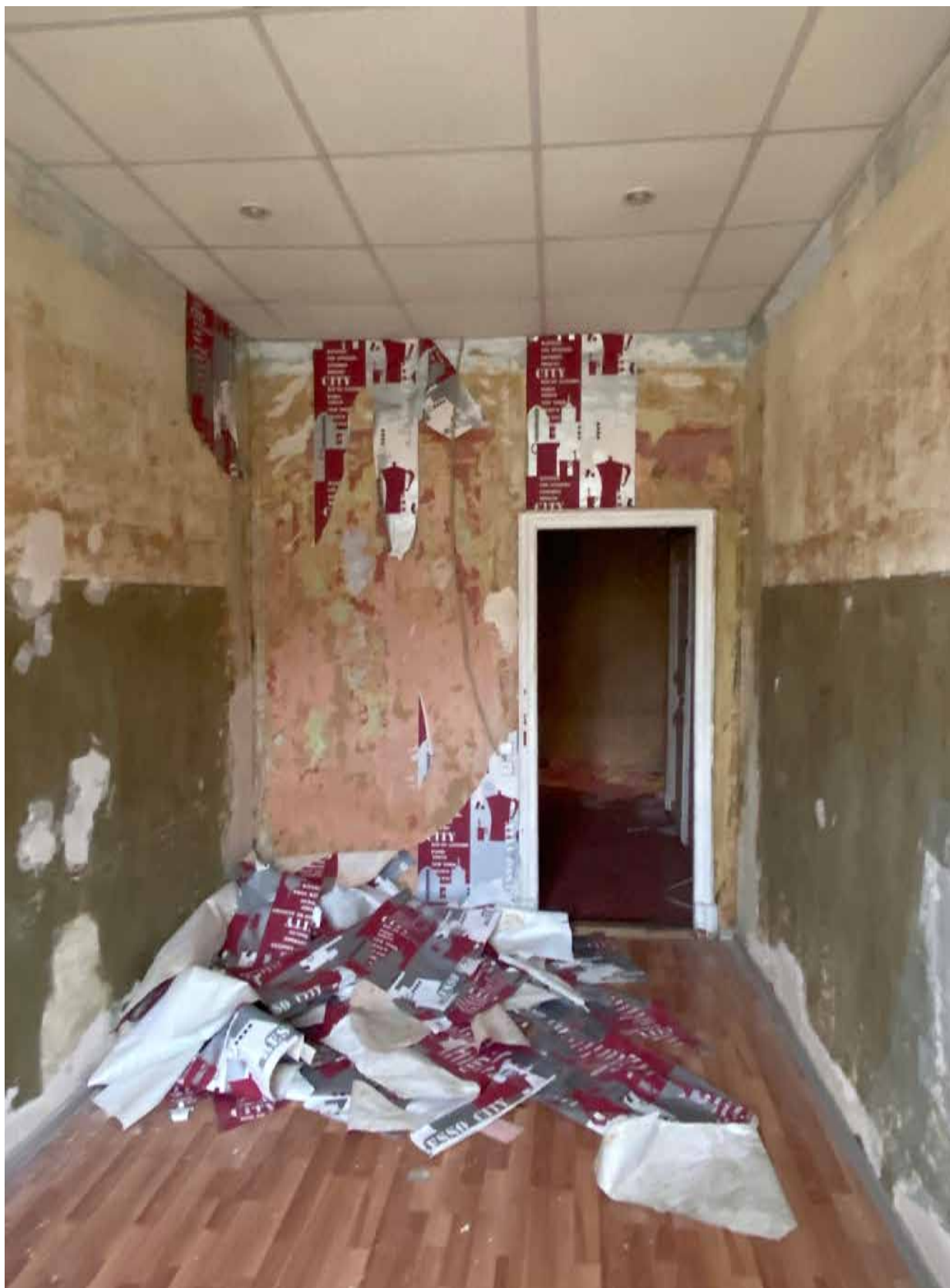
15.Фрагмент интерьера комнаты (помещение 13/10.4);
