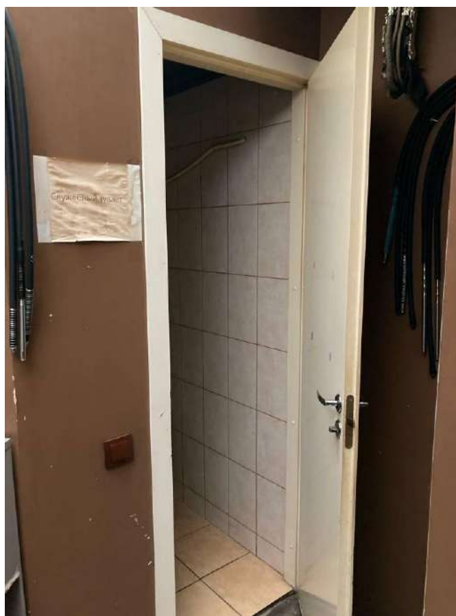
Фото 42. Интерьер 2 этажа пом. 13-Н выявленного объекта культурного наследия «Дом О.П. Кушелевой»
