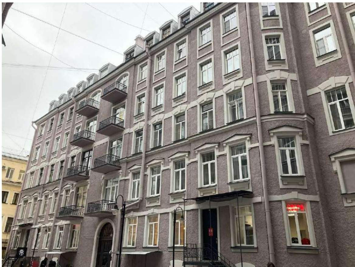
Фото 7. Фрагмент дворового фасада выявленного объекта культурного наследия «Дом О.П. Кушелевой»
