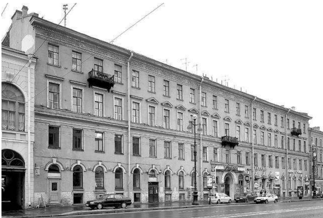
30. Доходный дом О.П. Кушелевой. 2004 г. – Доходный дом О.П. Кушелевой // Citywalls.ru – архитектурный сайт Петербурга [Электронный ресурс]. URL: https://www.citywalls.ru/house1160.html .
