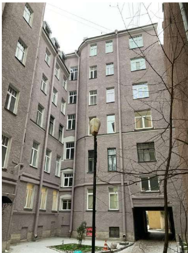
Фото 17. Фрагмент дворового фасада выявленного объекта культурного наследия «Дом О.П. Кушелевой»
