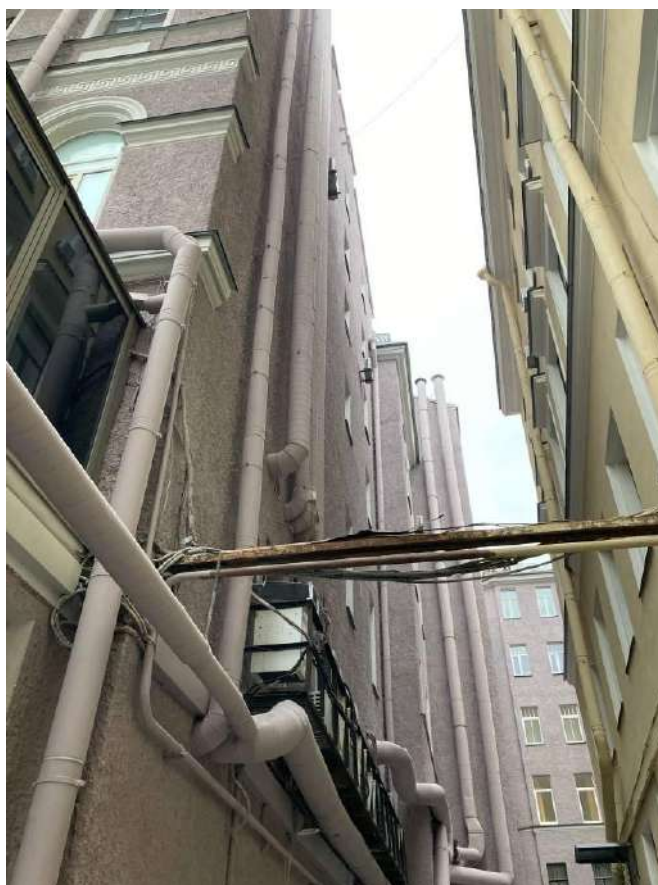
Фото 18. Фрагмент дворового фасада выявленного объекта культурного наследия «Дом О.П. Кушелевой»
