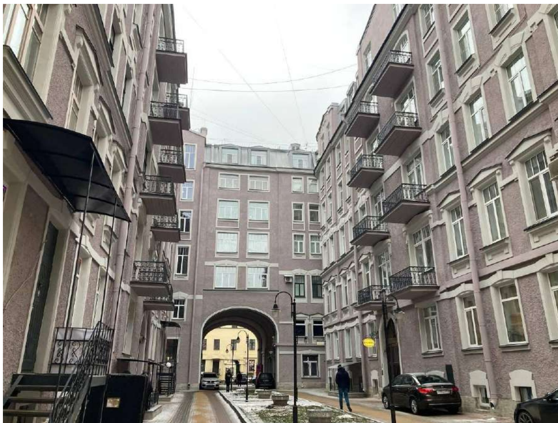
Фото 9. Фрагмент дворового фасада выявленного объекта культурного наследия «Дом О.П. Кушелевой»
