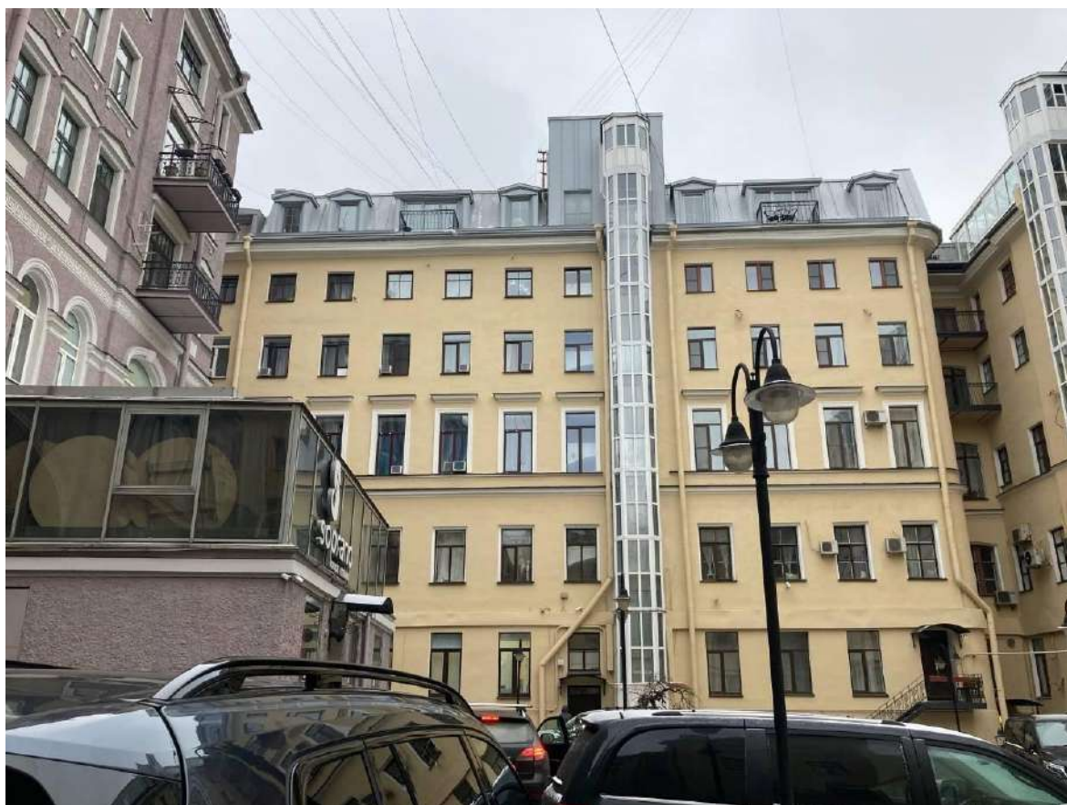
Фото 4. Фрагмент дворового фасада выявленного объекта культурного наследия «Дом О.П. Кушелевой»
