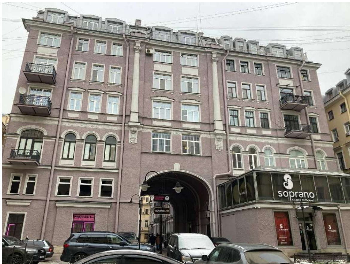
Фото 3. Фрагмент дворового фасада выявленного объекта культурного наследия «Дом О.П. Кушелевой»
