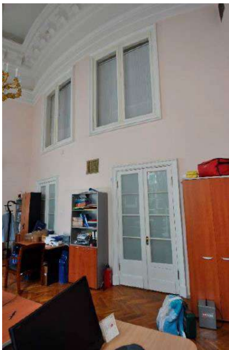
21. Помещение № 541 в уровне 2-го этажа объекта культурного наследия федерального значения «Дворец Таврический. Дворец», расположенного по адресу: г. Санкт-Петербург, ул. Шпалерная, д. 47, лит. А. 01.11.2023
