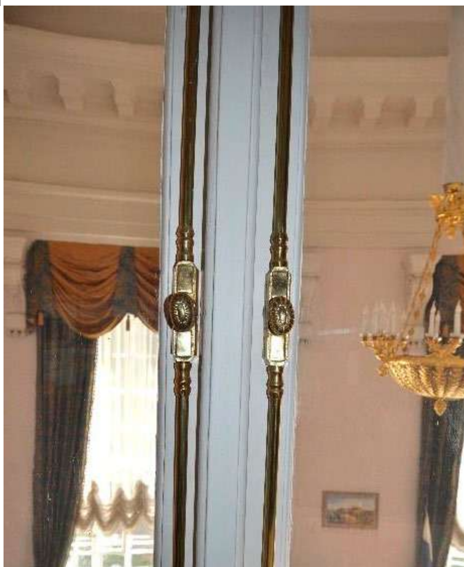
8. Помещение № 538 в уровне 2-го этажа объекта культурного наследия федерального значения «Дворец Таврический. Дворец», расположенного по адресу: г. Санкт-Петербург, ул. Шпалерная, д. 47, лит. А. 01.11.2023
