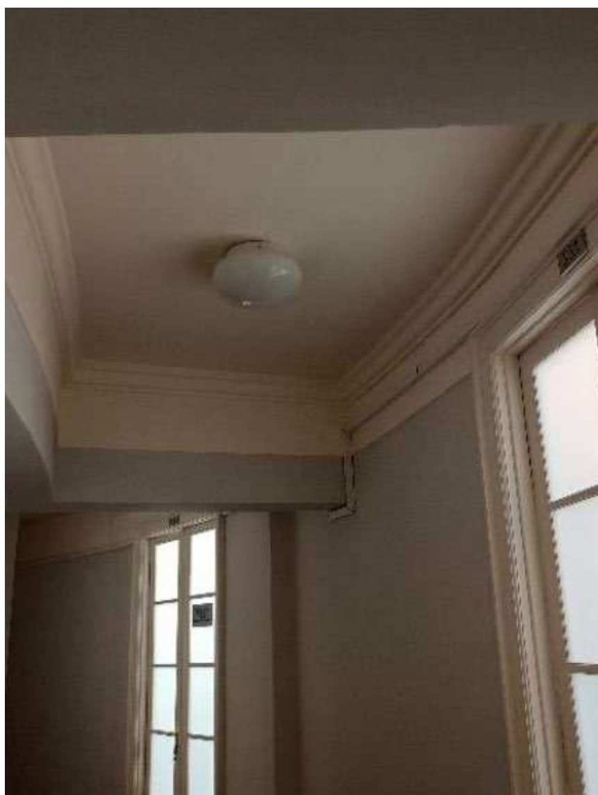
13. Помещение № 539 в уровне 2-го этажа объекта культурного наследия федерального значения «Дворец Таврический. Дворец», расположенного по адресу: г. Санкт-Петербург, ул. Шпалерная, д. 47, лит. А. 01.11.2023
