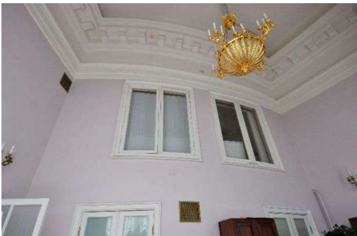
6. Помещение № 538 в уровне 2-го этажа объекта культурного наследия федерального значения «Дворец Таврический. Дворец», расположенного по адресу: г. Санкт-Петербург, ул. Шпалерная, д. 47, лит. А. 01.11.2023
