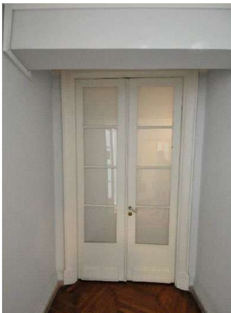
2. Помещение № 537 в уровне 2-го этажа объекта культурного наследия федерального значения «Дворец Таврический. Дворец», расположенного по адресу: г. Санкт-Петербург, ул. Шпалерная, д. 47, лит. А. 01.11.2023
