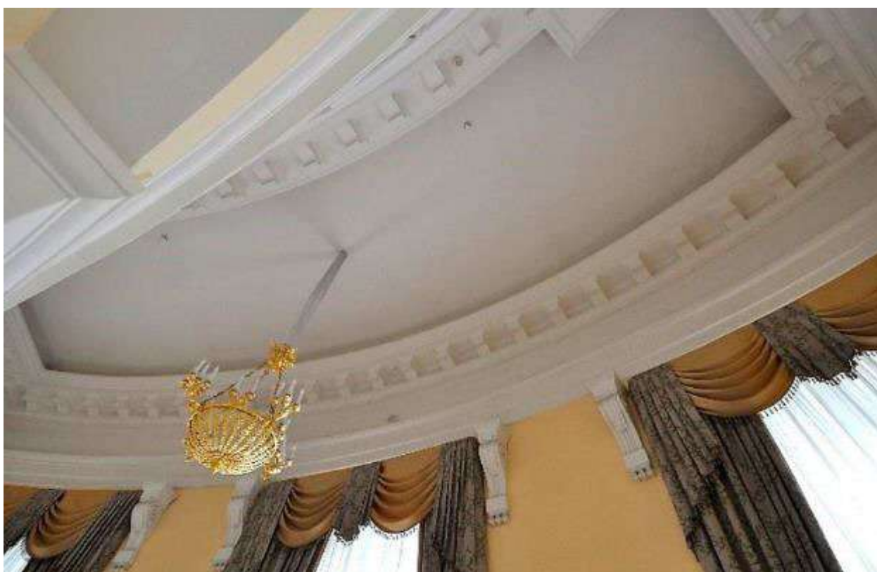
15. Помещение № 540 в уровне 2-го этажа объекта культурного наследия федерального значения «Дворец Таврический. Дворец», расположенного по адресу: г. Санкт-Петербург, ул. Шпалерная, д. 47, лит. А. 01.11.2023
