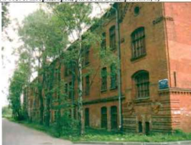
Фото 1. Западный фасад. Общий вид.
