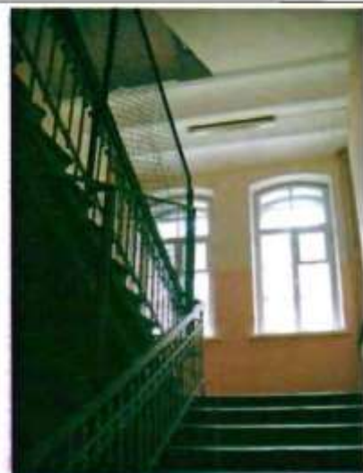
Фото 56. Лестница в центральной части здания. Фрагмент.
