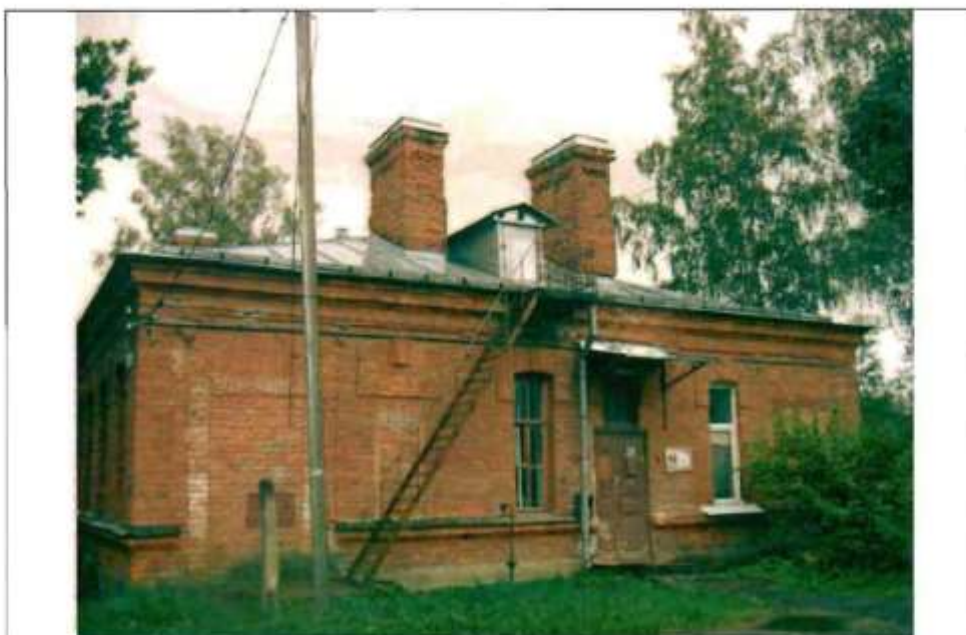
Фото189. Северный фасад. Общий вид.
