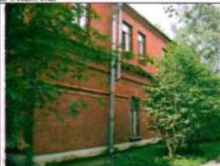
Фото 80. Северный фасад. Фрагмент.
