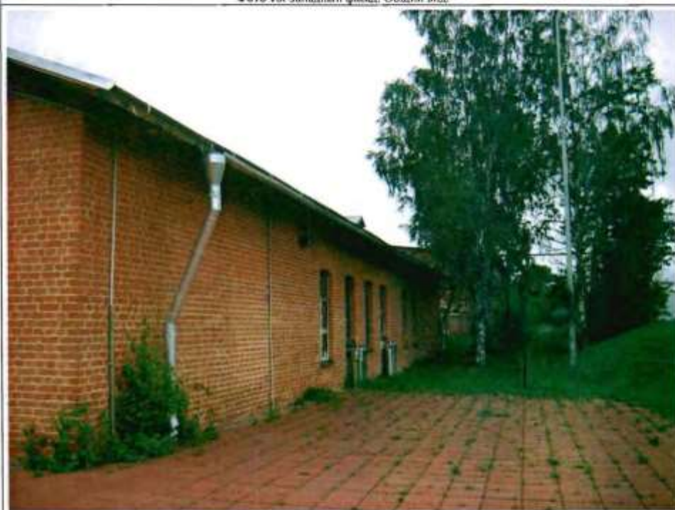
Фото 19. Восточный фасад. Общий вид.
