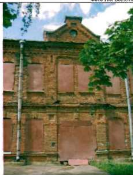
Фото 117. Восточный фасад. Фрагмент центральной части фасада.
