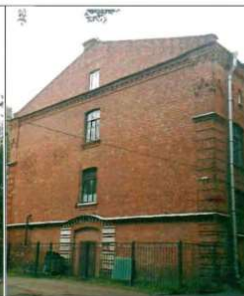
Фото 50. Южный фасад. Общий вид.
