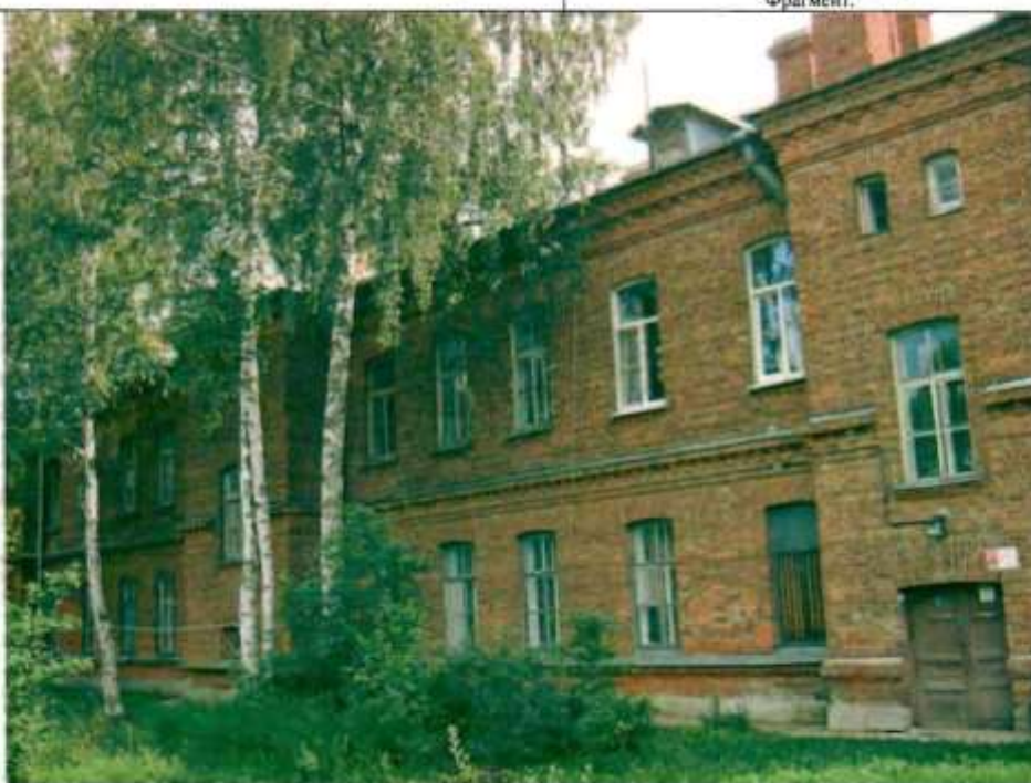
Фото 179. Западный фасад. Общий вид.
