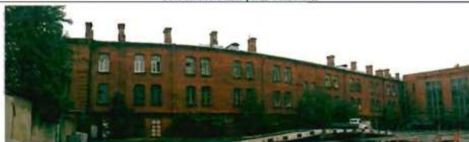
Фото 29. Западный фасад. Общий вид.
