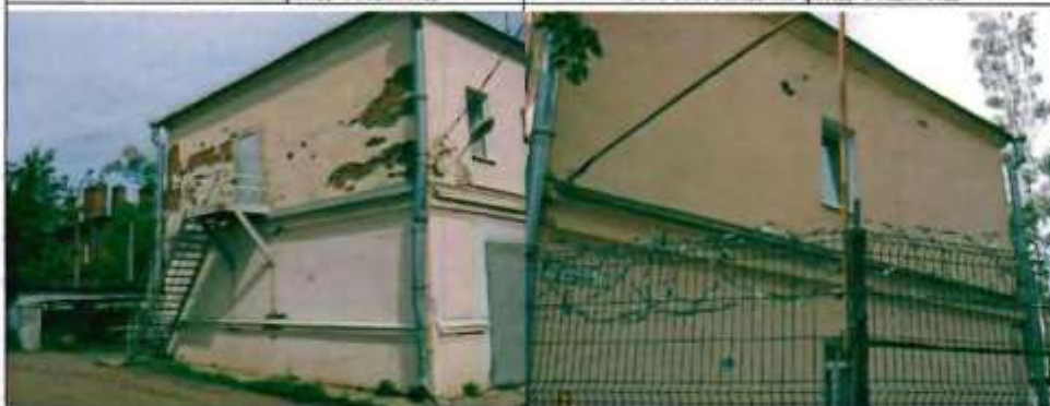
Фото 112. Южный фасад. Общий вид.
