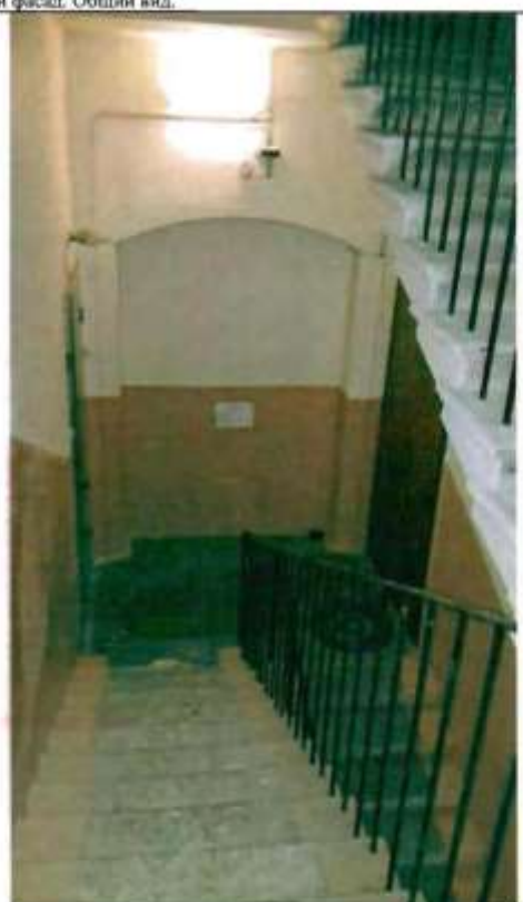
Фото 173. Лестница № 1 в северной части здания. Фрагмент.
