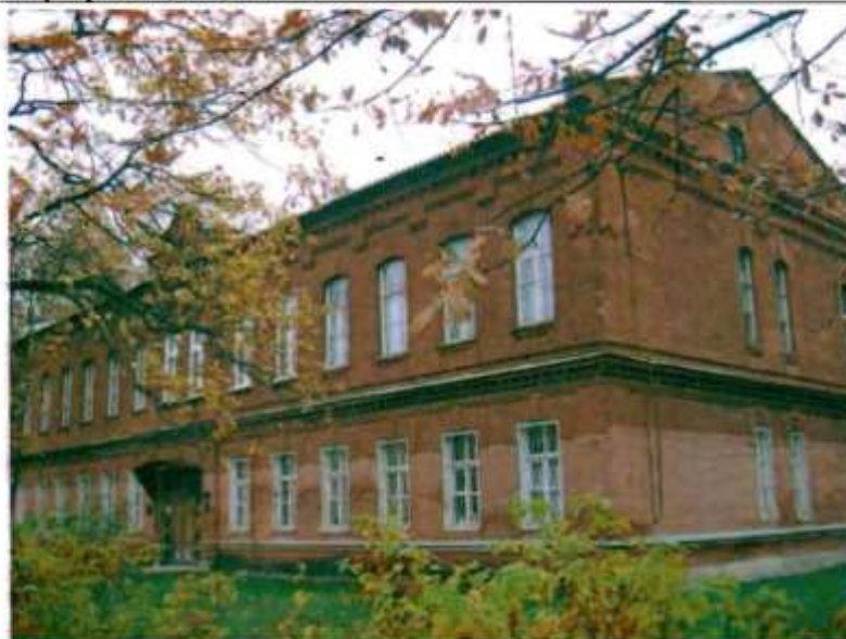
Фото 89. Западный, южный фасады. Общий вид.
