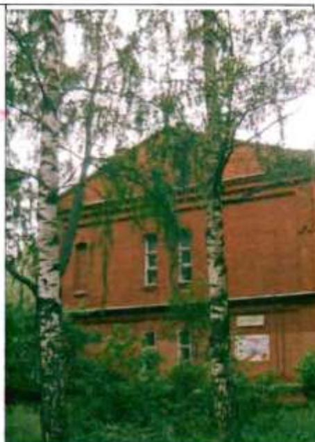
Фото 91. Северный фасад. Общий вид.
