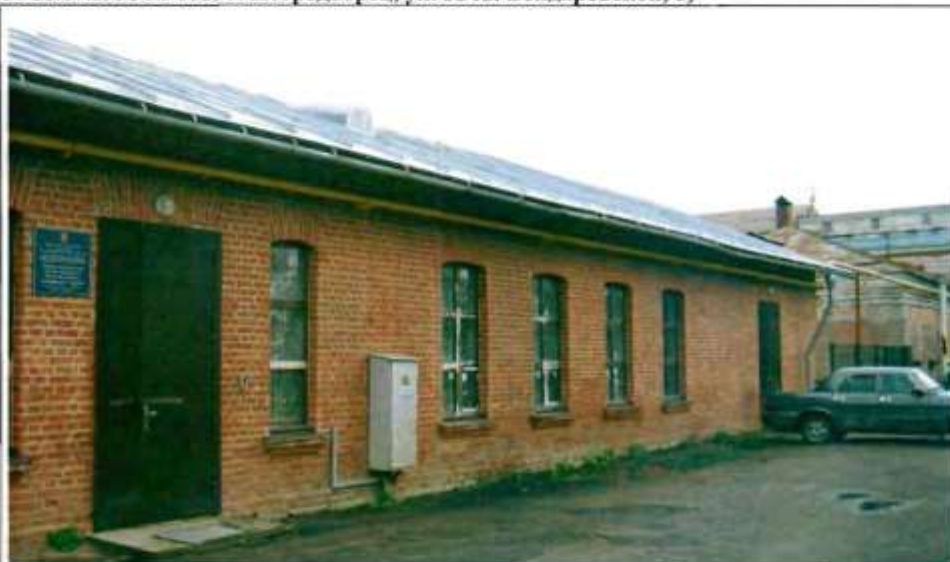
Фото 18. Западный фасад. Общий вид.
