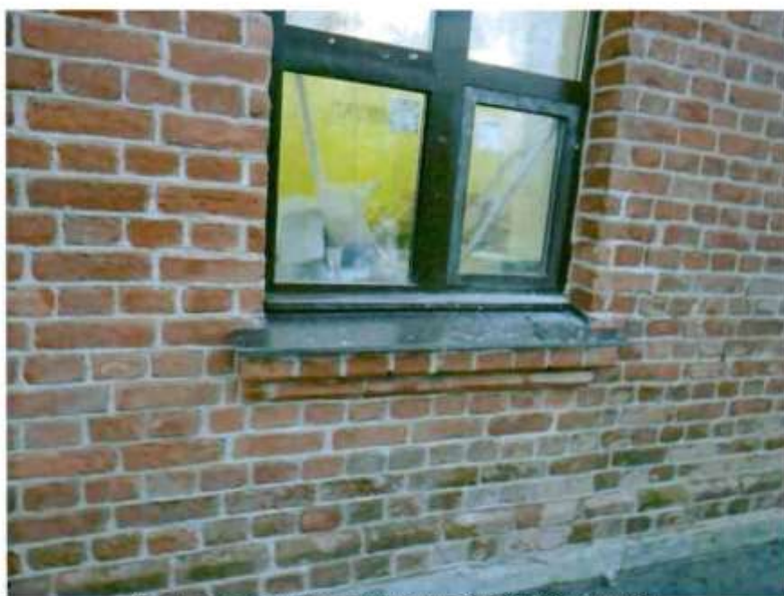
Ступенчатые подоконные доски. Съемка 20.11.2012, Воронина Н.В.
