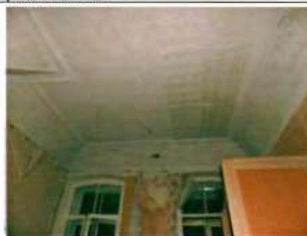
Фото 121. Помещение 1-го этажа.
