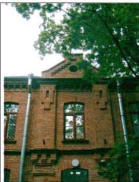
Фото 40. Восточный фасад. Фрагмент центральной части фасада.
