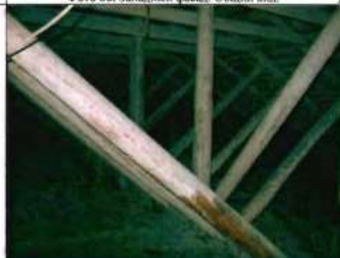
Фото 88. Конструкция крыши. Общий вид.
