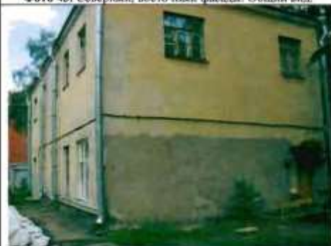
Фото 45. Южный, западный фасад. Общий вид.
