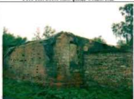
Фото 187. Северный фасад. Общий вид.
