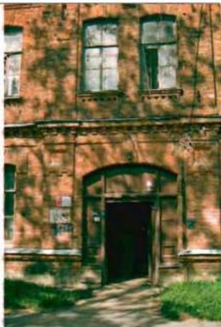
Фото 178. Восточный фасад. Центральная часть. Фрагмент.
