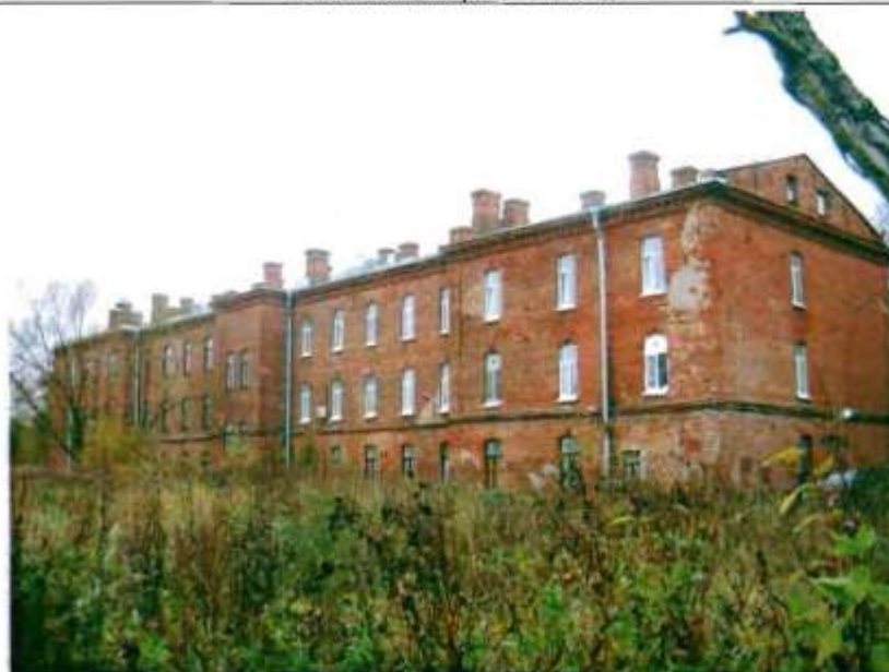
Фото 14. Восточный фасад. Общий вид.
