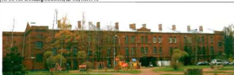
Фото 28. Восточный фасад. Общий вид.
