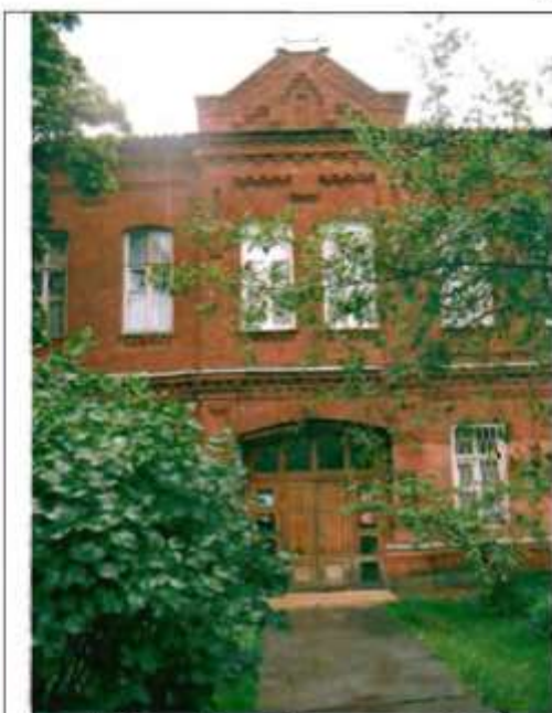
Фото 90. Восточный фасад. Центральная часть. Общий вид.
