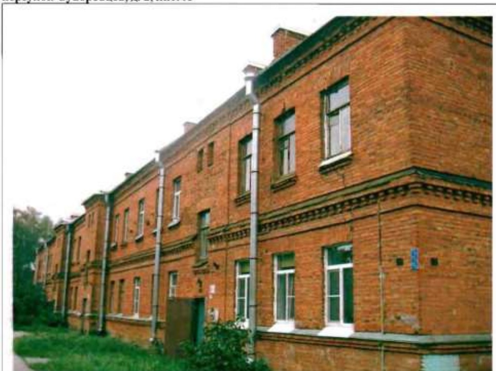
Фото 83. Северный фасад. Общий вид.
