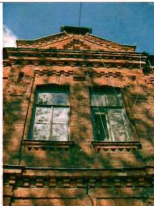
Фото 177. Восточный фасад. Центральная часть. Фрагмент.
