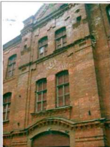
Фото 3. Западный фасад. Фрагмент центральной части фасада.
