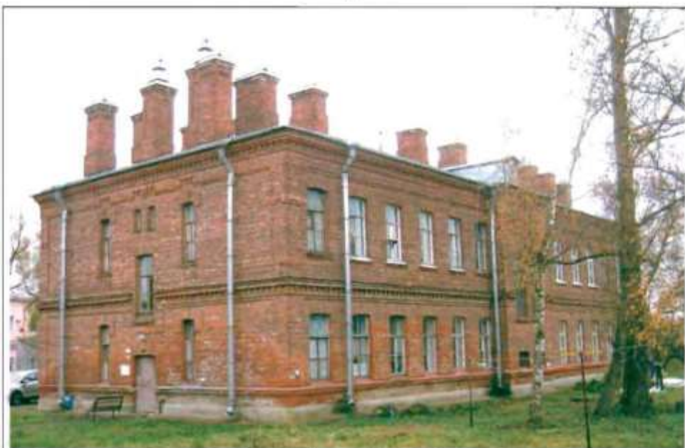
Фото 129. Западный, северный фасады. Общий вид.
