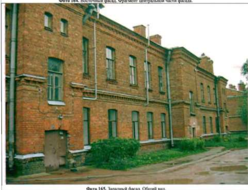
Фото 165. Западный фасад. Общий вид.
