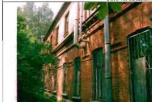
Фото 79. Восточный фасад. Общий вид.
