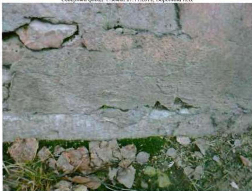
Цоколь, облицованный известняковой скобой. Съемка 27.11.2012, Воронина Н.В.
