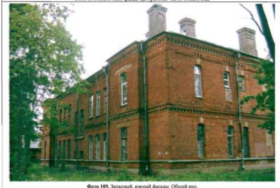
Фото 105. Западный, южный фасады. Общий вид.
