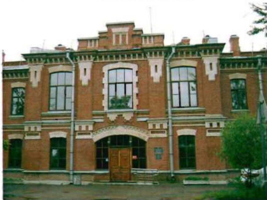
Фото 65. Северный фасад. Фрагмент центральной части фасада.
