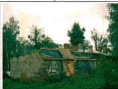
Фото 186. Западный, северный фасады. Общий вид.
