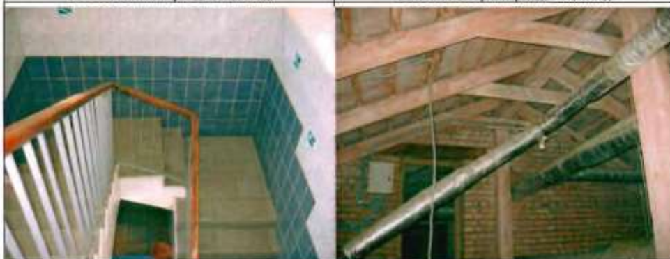
Фото 114. Лестница. Общий вид.
