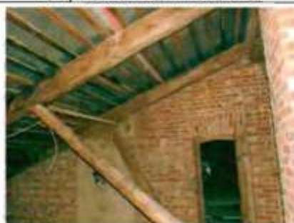
Фото 127. Конструкции крыши. Общий вид.
