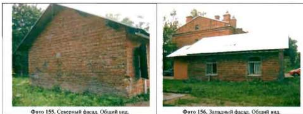
Фото 155. Северный фасад. Общий вид.
