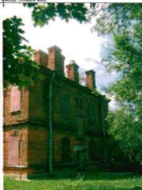
Фото 118. Северный фасад. Общий вид.
