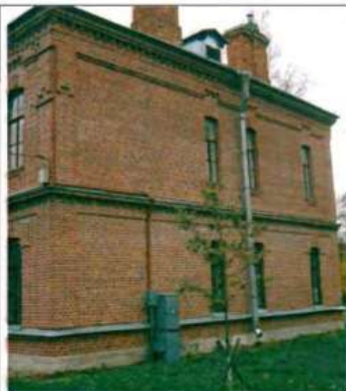
Фото 134. Южный фасад. Общий вид.
