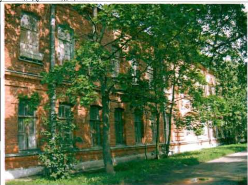
Фото 136. Восточный фасад. Общий вид.
