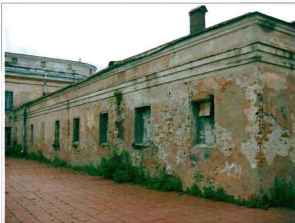
Фото 25. Восточный фасад. Общий вид.
