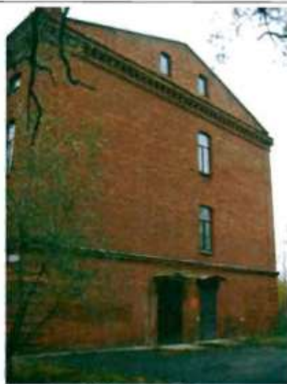
Фото 16. Южный фасад. Общий вид.
