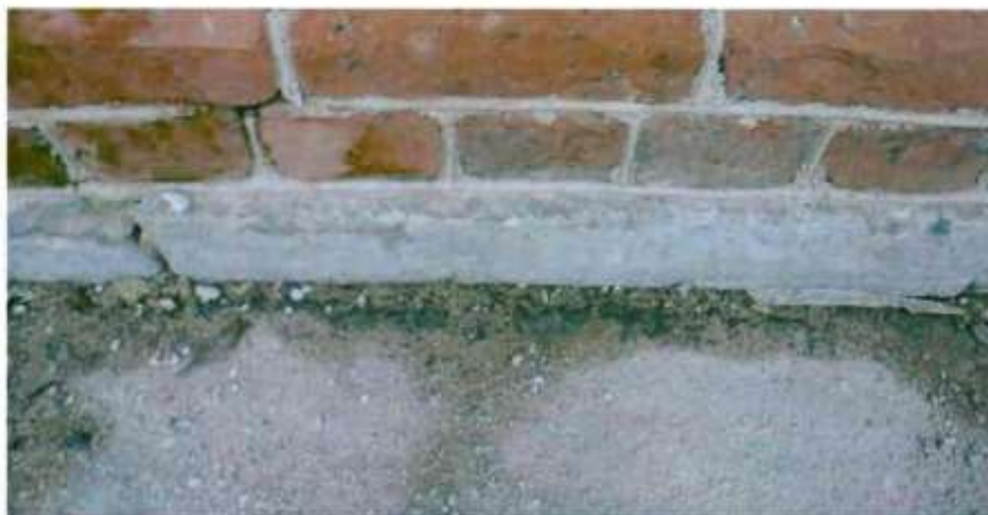
Цоколь, облицованный известняковой скобой. Съемка 20.11.2012, Воронина Н.В.
