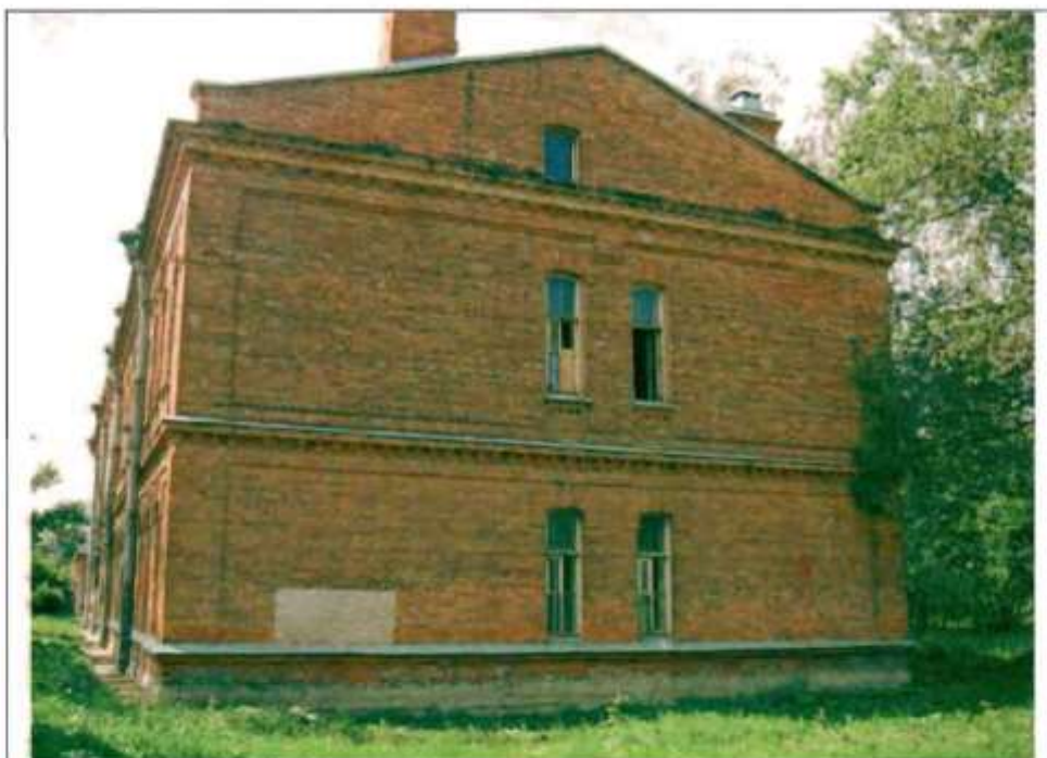
Фото 180. Северный фасад. Общий вид.
