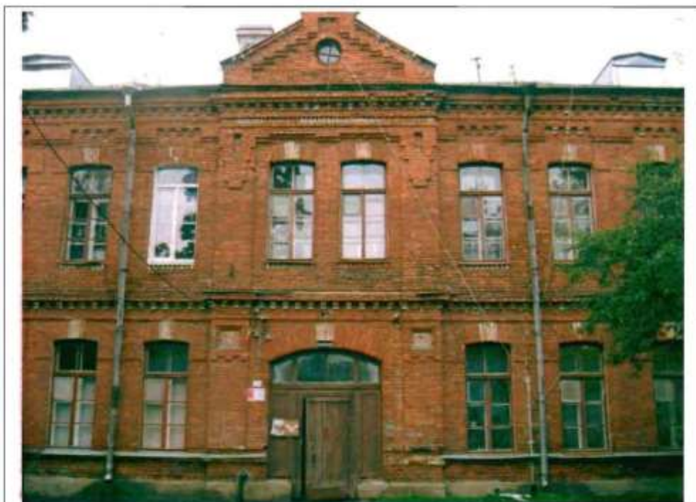
Фото 104. Восточный фасад. Центральная часть. Общий вид.
