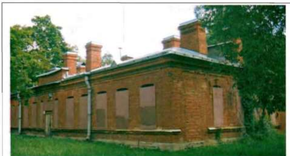
Фото 98. Западный фасад. Общий вид.
