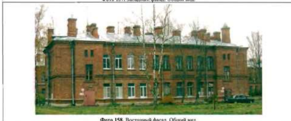
Фото 158. Восточный фасад. Общий вид.
