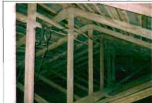
Фото 81. Конструкция крыши. Общий вид.
