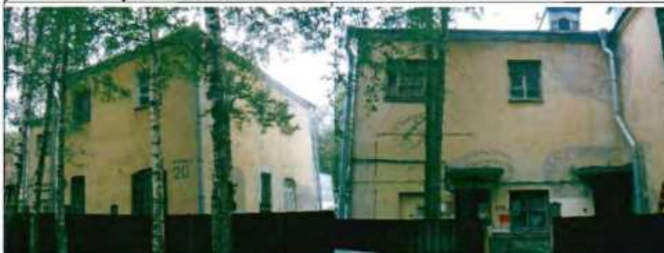
Фото 43. Северный, восточный фасады. Общий вид.
