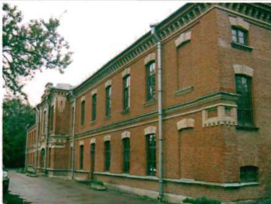
Фото 64. Северный фасад. Общий вид.
