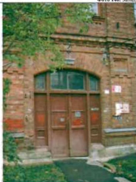
Фото 147. Дверной проем западного фасада. Общий вид.
