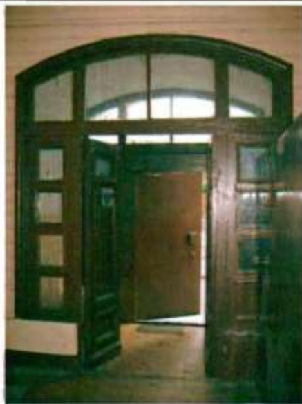
Фото 107. Дверной проем тамбура. Общий вид.
