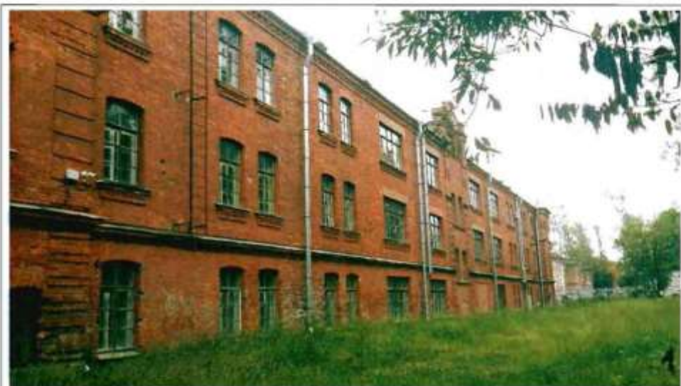
Фото 48. Западный фасад. Общий вид.
