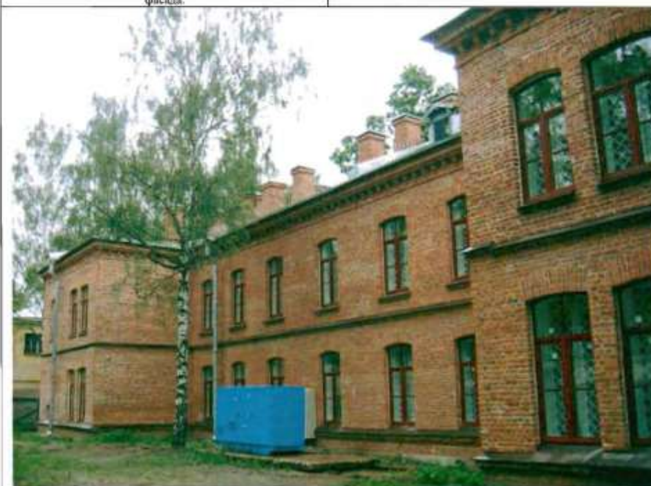
Фото 42. Западный фасад. Общий вид.
