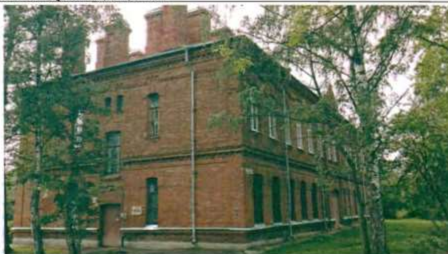
Фото 170. Северный, западный фасады. Общий вид.
