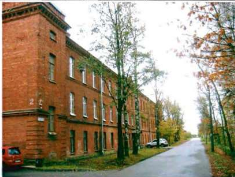
Фото 13. Западный фасад. Общий вид.
