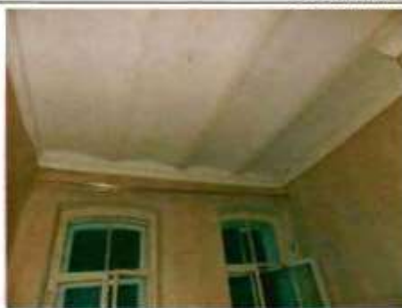
Фото 120. Помещение 1-го этажа. Общий вид.
