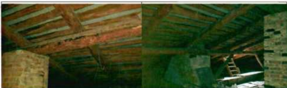
Фото 62. Конструкции крыши. Общий вид.
