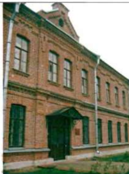
Фото 135. Западный фасад. Фрагмент центральной части фасада.
