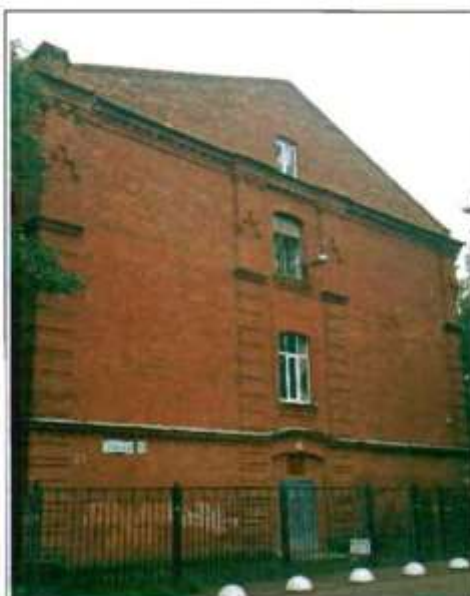
Фото 49. Северный фасад. Общий вид.
