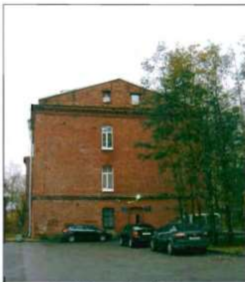
Фото 15. Северный фасад. Общий вид.
