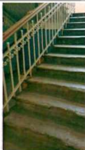
Фото 57. Лестница в центральной части здания. Фрагмент.
