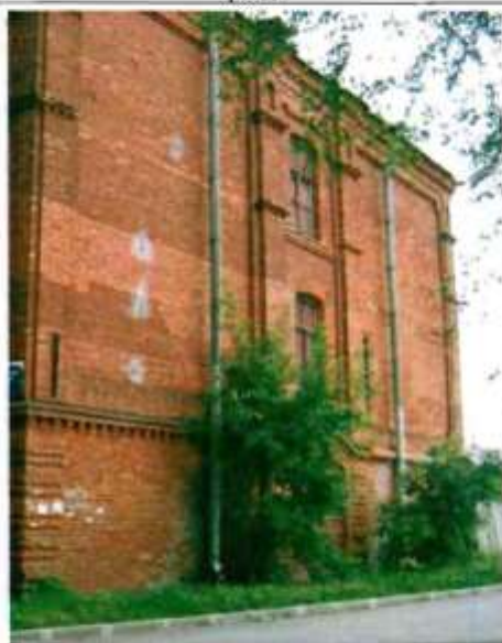
Фото 5. Южный фасад. Общий вид.
