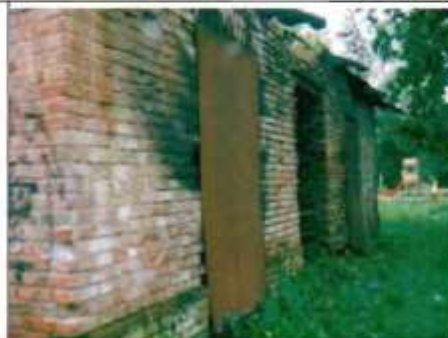
Фото 95. Северный фасад. Общий вид.
