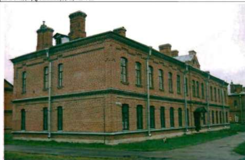
Фото 132. Западный, северный фасады. Общий вид.
