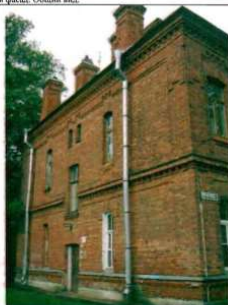
Фото 148. Северный фасад. Общий вид.
