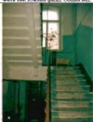
Фото 168. Лестница в южной части здания. Общий вид.
