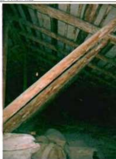
Фото 27. Конструкции крыши. Фрагмент.
