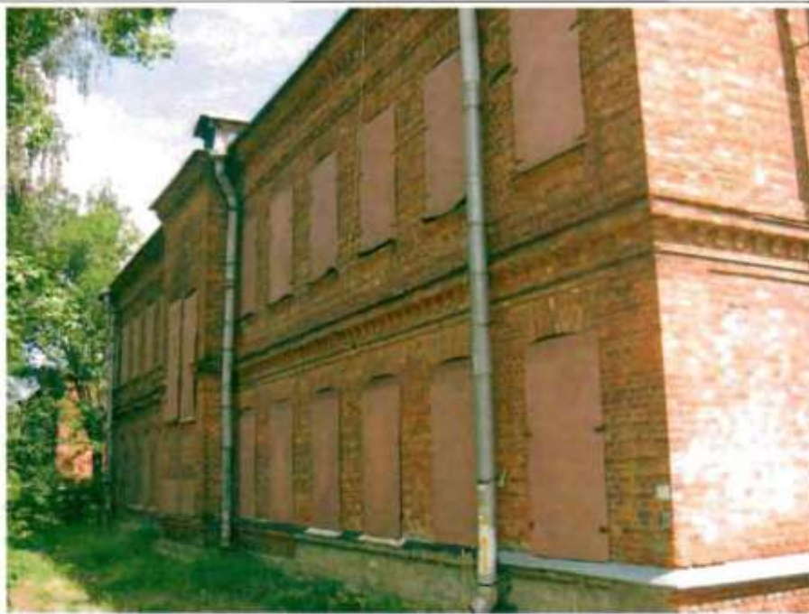
Фото 119. Западный фасад. Общий вид.
