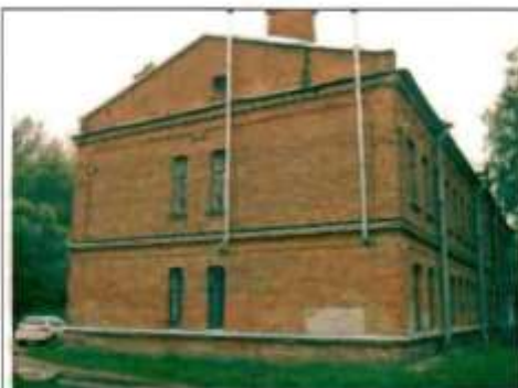
Фото 166. Южный фасад. Общий вид.
