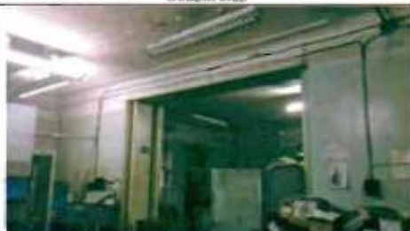
Фото 33. Интерьер. Помещение в уровне 1-го этажа. Общий вид.
