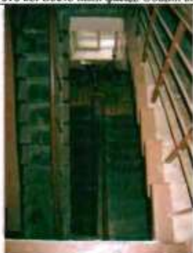
Фото 87. Лестница № 1. Общий вид.
