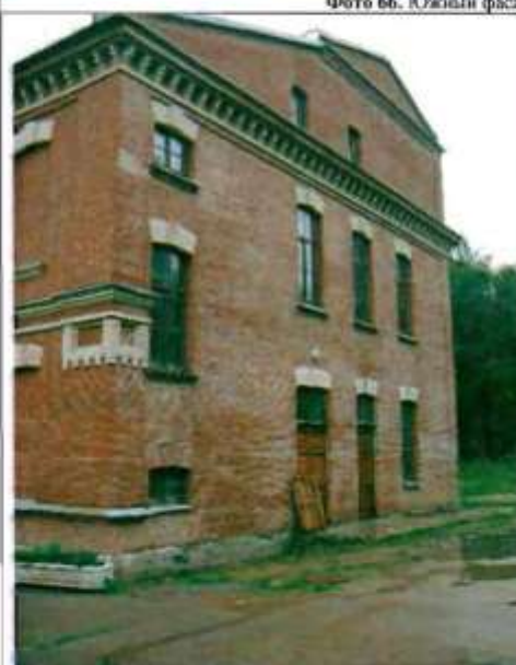
Фото 67. Западный фасад. Общий вид.
