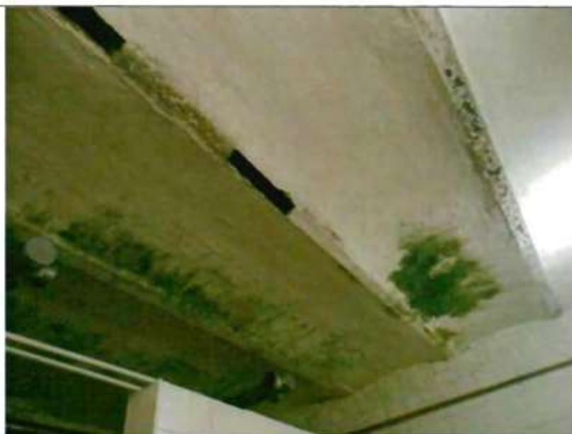
Своды по металлическим балкам. Съемка 27.11.2012, Воронина Н.В.
