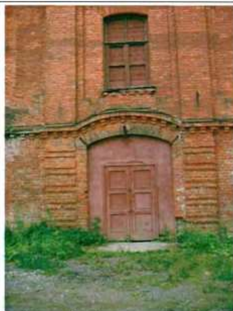
Фото 4. Западный фасад. Фрагмент центральной части фасада.
