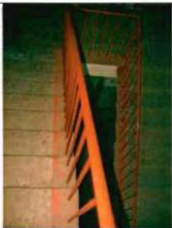
Фото 149. Лестница № 1 в северной части здания. Общий вид.
