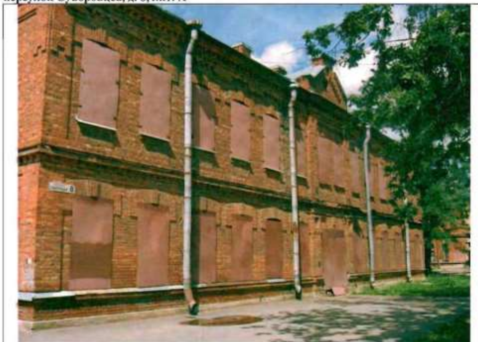
Фото 116. Восточный фасад. Общий вид.
