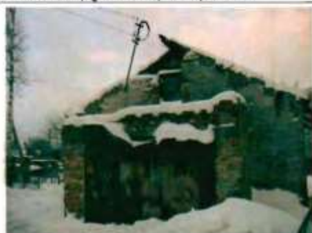
Фото 184. Восточный фасад. Общий вид. 14.01.2015.
