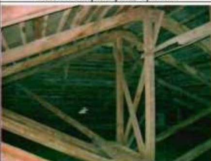
Фото 82. Конструкция крыши. Общий вид.
