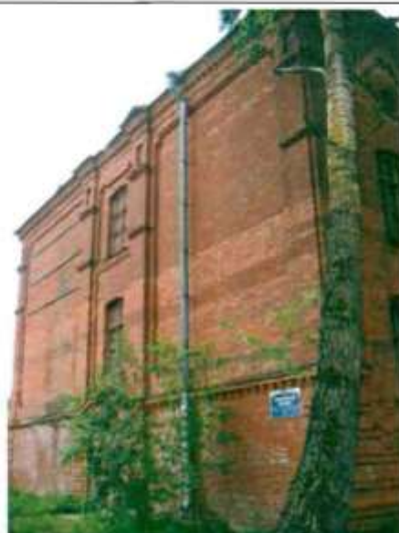
Фото 6. Северный фасад. Общий вид.
