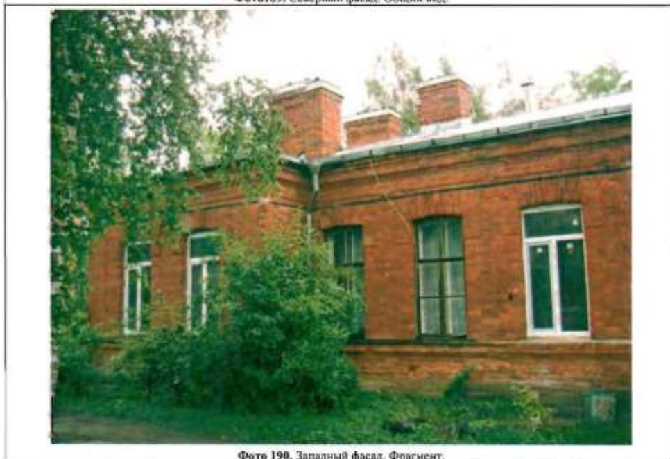
Фото 190. Западный фасад. Фрагмент.
