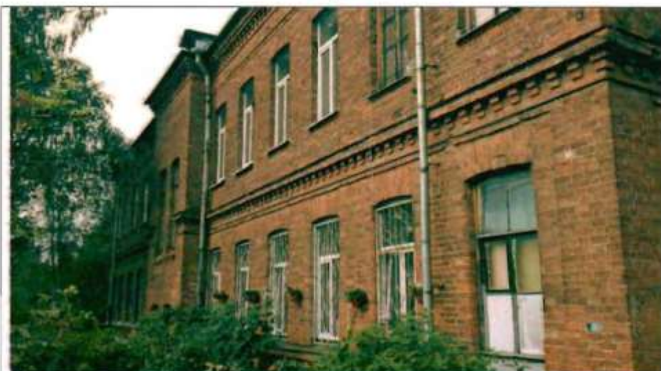
Фото 171. Восточный фасад. Общий вид.
