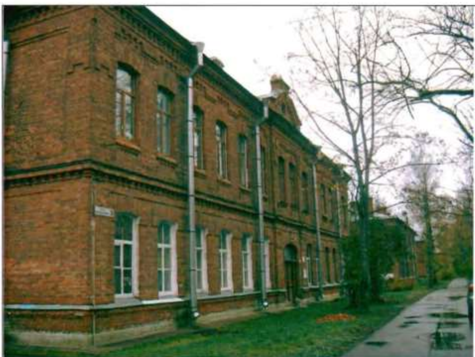
Фото 146. Западный фасад. Общий вид.
