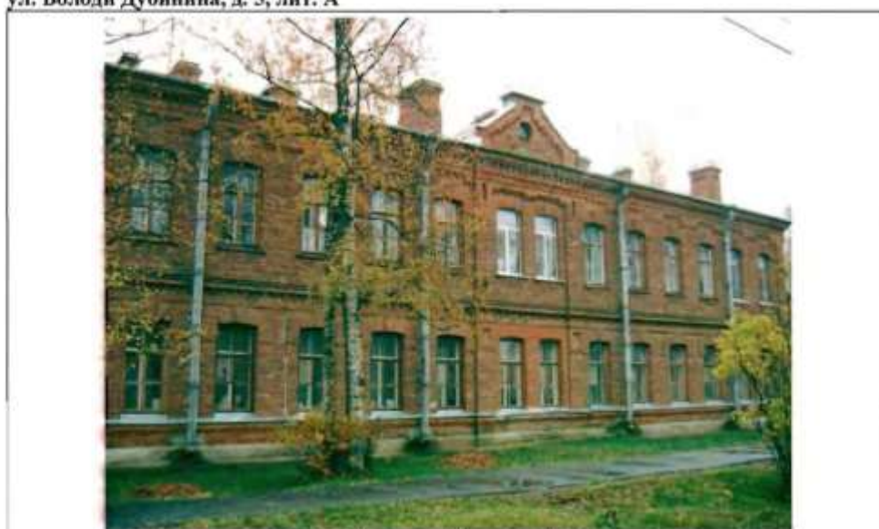
Фото 157. Западный фасад. Общий вид.
