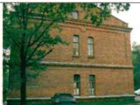
Фото 167. Северный фасад. Общий вид.
