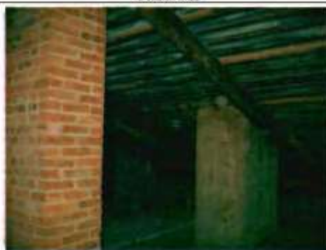
Фото 152. Конструкции крыши. Фрагмент.
