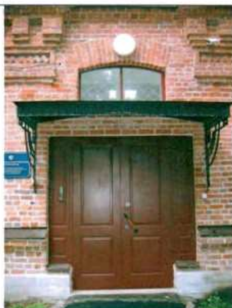
Фото 41. Деревянный проем восточного фасада. Общий вид.
