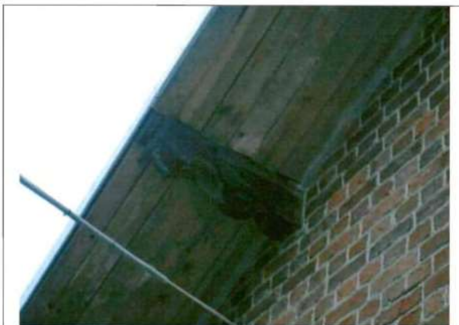
Деревянные кобылки. Съемка 20.11.2012, Воронина Н.В.
