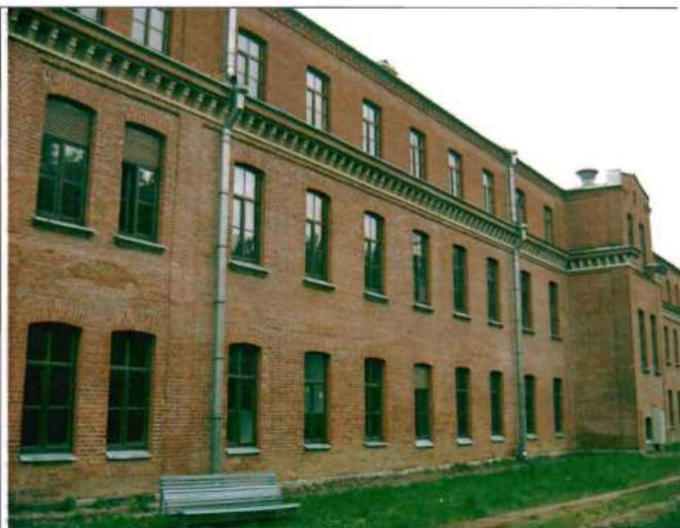
Фото 66. Южный фасад. Общий вид. 05.07.2016.
