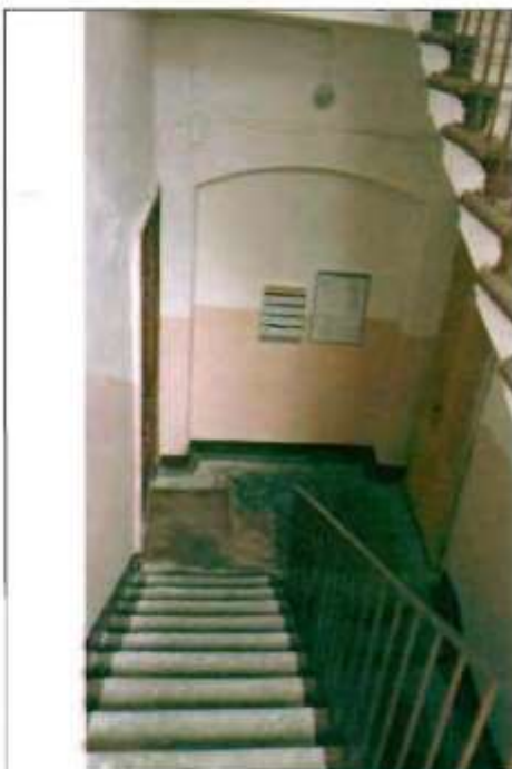
Фото 130. Лестница № 1 в южной части здания. Общий вид.
