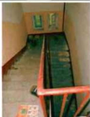
Фото 124. Лестница в южной части здания. Общий вид.
