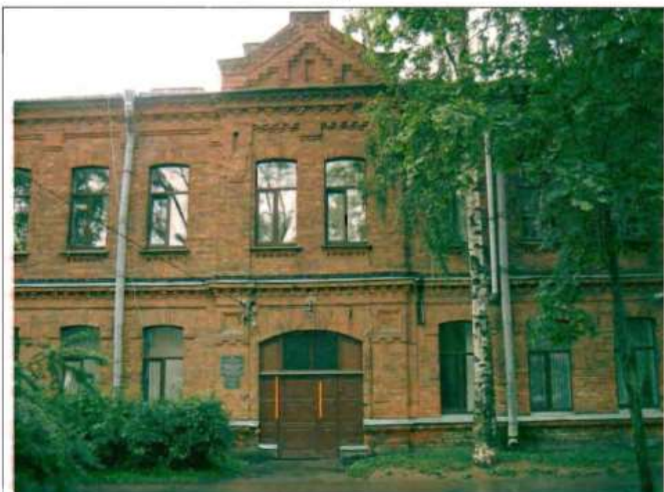
Фото 164. Восточный фасад. Фрагмент центральной части фасада.
