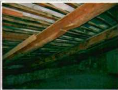
Фото 151. Конструкции крыши. Фрагмент.
