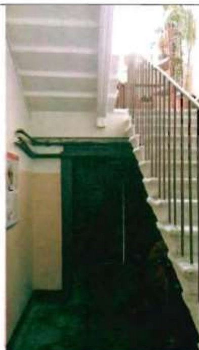
Фото 131. Лестница № 2 в северной части здания. Общий вид.
