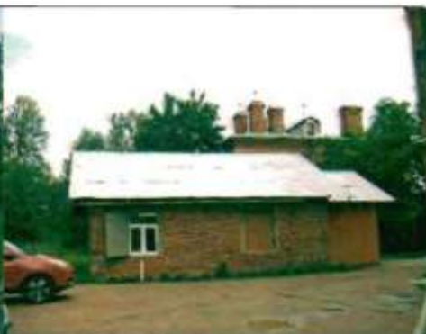
Фото 154. Южный фасад. Общий вид.
