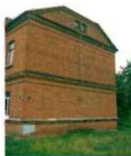
Фото 86. Западный фасад. Общий вид.
