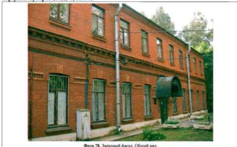
Фото 78. Западный фасад. Общий вид.
