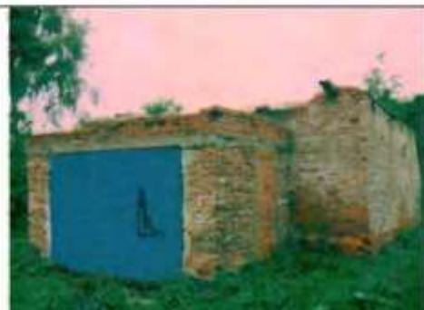
Фото 185. Восточный фасад. Общий вид.
