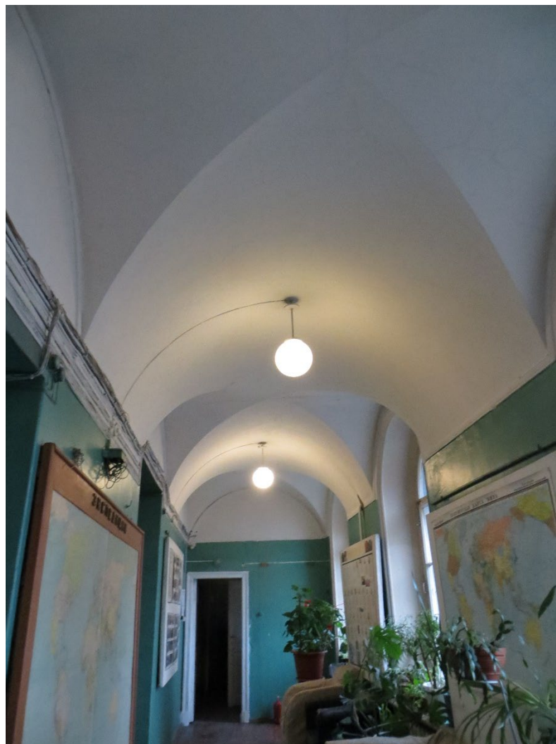
23. Помещение №9 (35Н) объекта культурного наследия федерального значения «Дом министра государственных имуществ», расположенного по адресу: г. Санкт-Петербург, Большая Морская ул., д. 44, литера А. 26.10.2021
