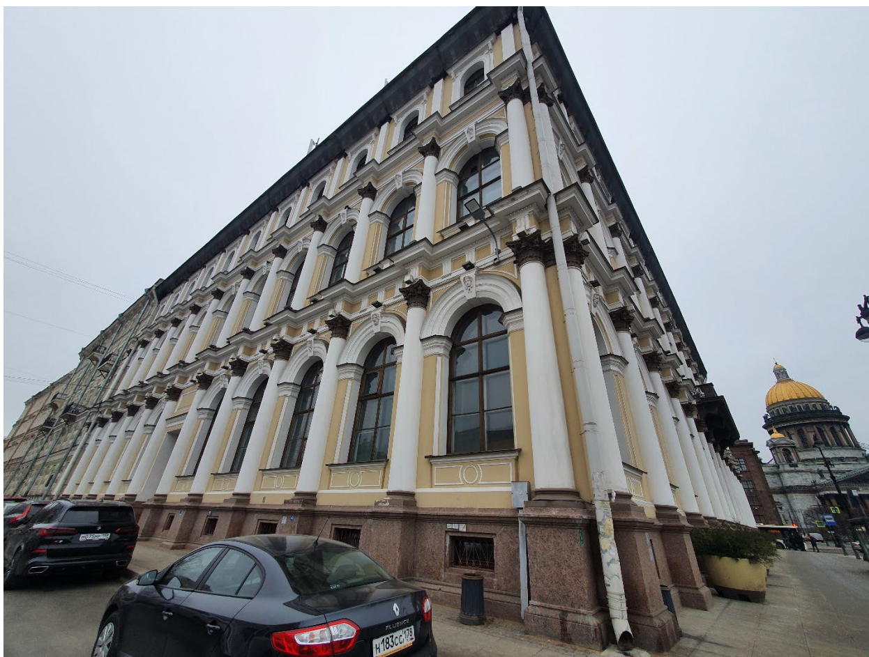
1. Юго-восточный и северо-восточный лицевые фасады объекта культурного наследия федерального значения «Дом министра государственных имуществ», расположенного по адресу: г. Санкт-Петербург, Большая Морская ул., д. 44, литера А. 26.10.2021
