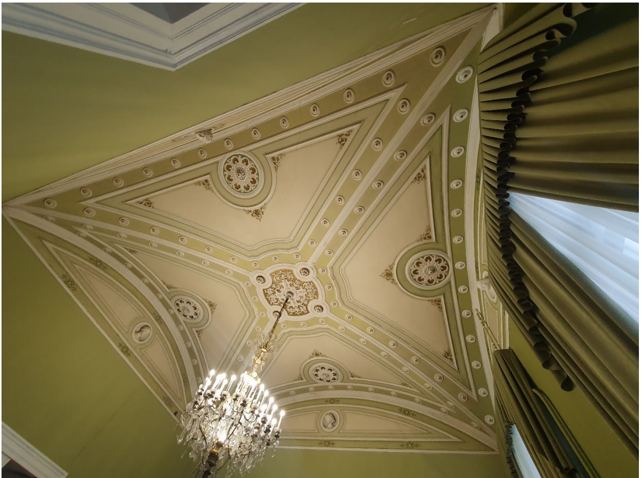
17. Помещение №10 (27Н) объекта культурного наследия федерального значения «Дом министра государственных имуществ», расположенного по адресу: г. Санкт-Петербург, Большая Морская ул., д. 44, литера А. 26.10.2021
