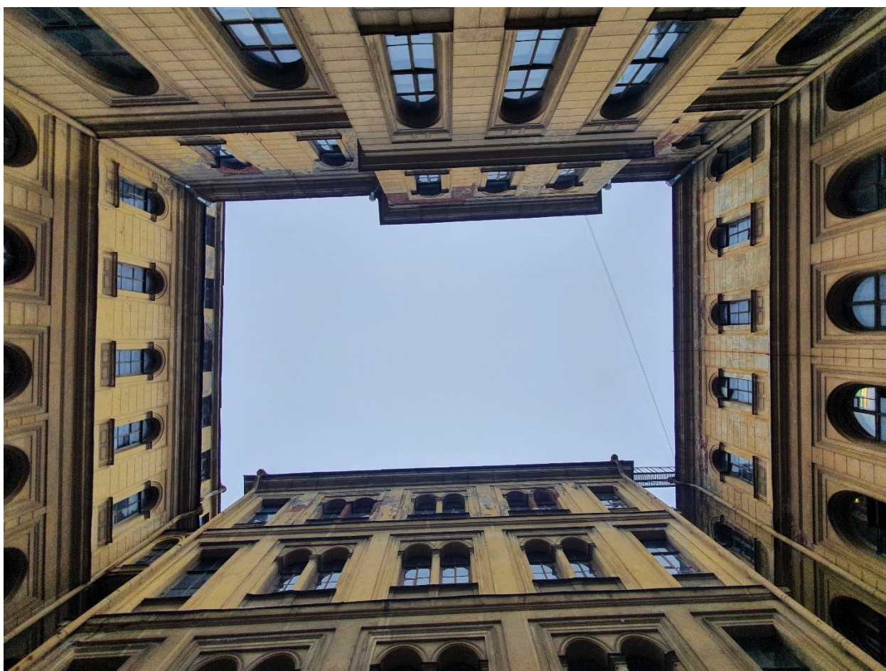
2. Дворовые фасады объекта культурного наследия федерального значения «Дом министра государственных имуществ», расположенного по адресу: г. Санкт-Петербург, Большая Морская ул., д. 44, литера А. 26.10.2021
