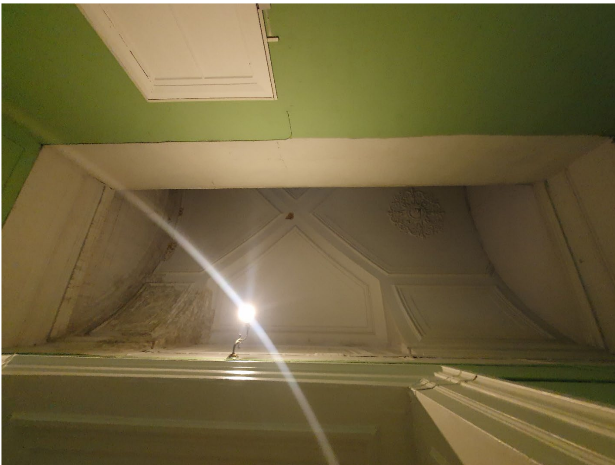
18. Помещение №11 (27H) объекта культурного наследия федерального значения «Дом министра государственных имуществ», расположенного по адресу: г. Санкт-Петербург, Большая Морская ул., д. 44, литера А. 26.10.2021
