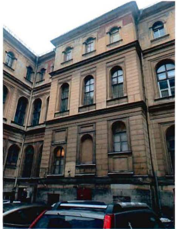
6. Вид на западный (дворовый) фасад объекта культурного наследия.
