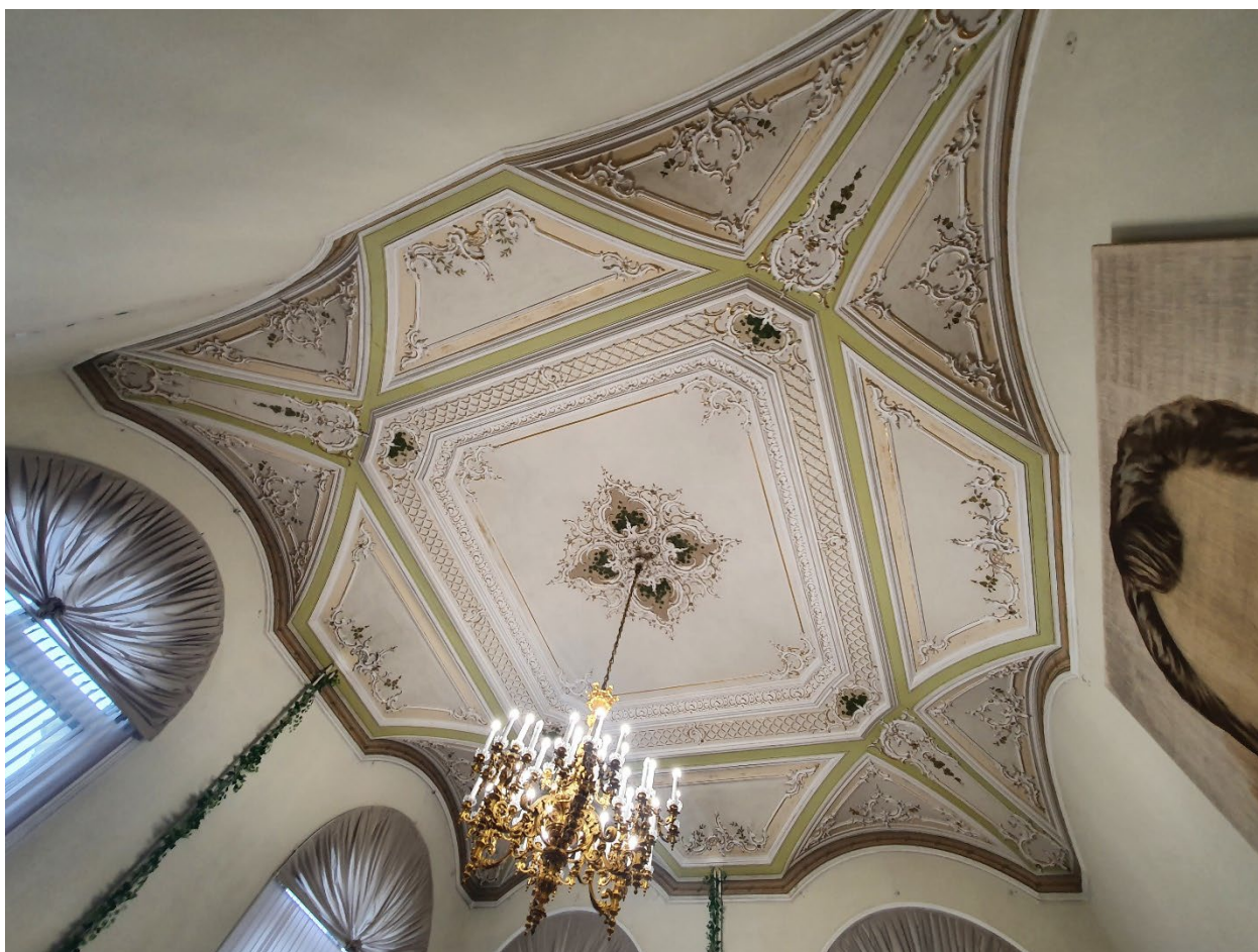
15. Помещение №8 (27Н) объекта культурного наследия федерального значения «Дом министра государственных имуществ», расположенного по адресу: г. Санкт-Петербург, Большая Морская ул., д. 44, литера А. 26.10.2021
