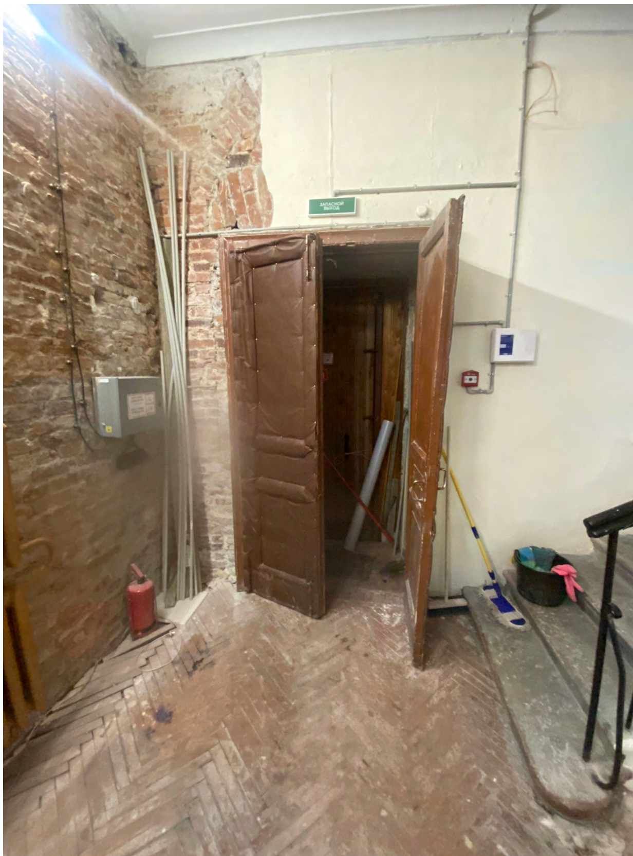
10. Вид на входную дверь в помещение 17-Н;
