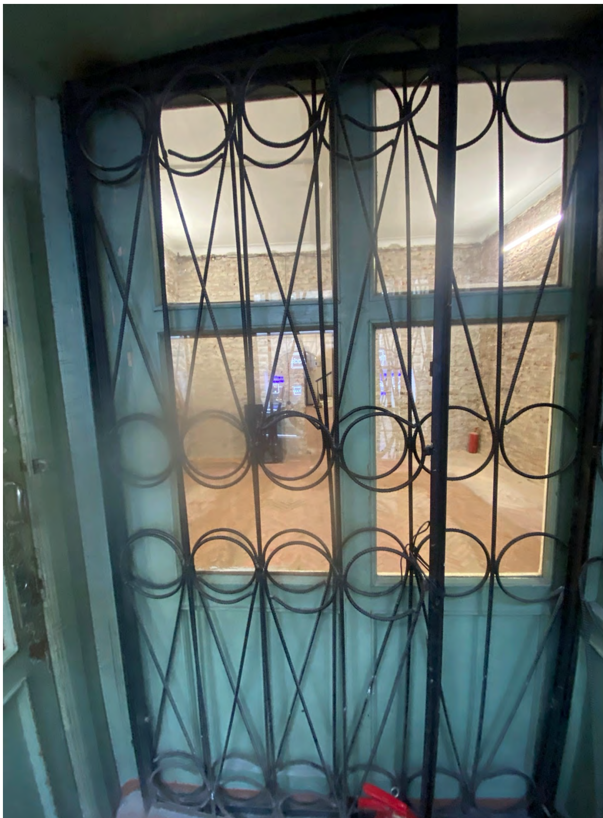
4. Фрагмент интерьера тамбура (помещение 1/2);
