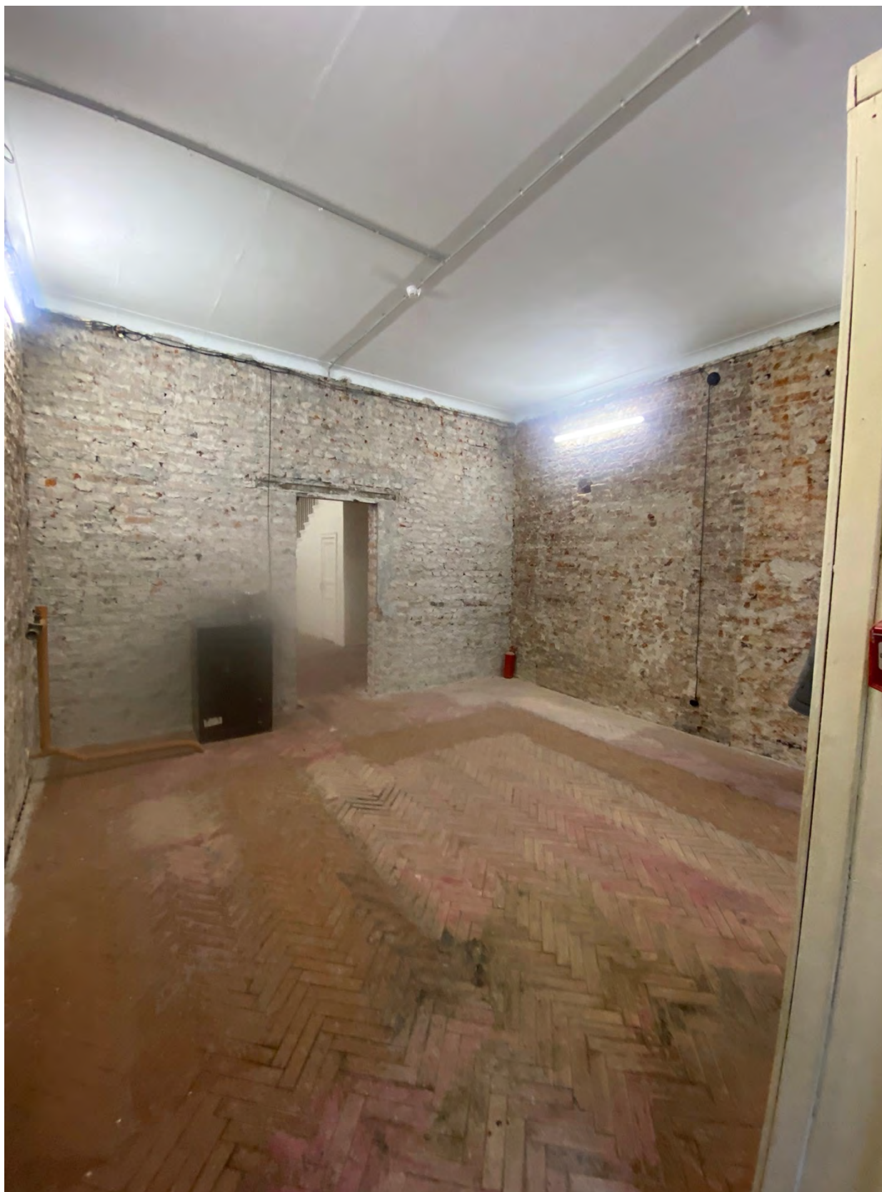
5. Фрагмент интерьера торгового зала (помещение 2/29.1);
