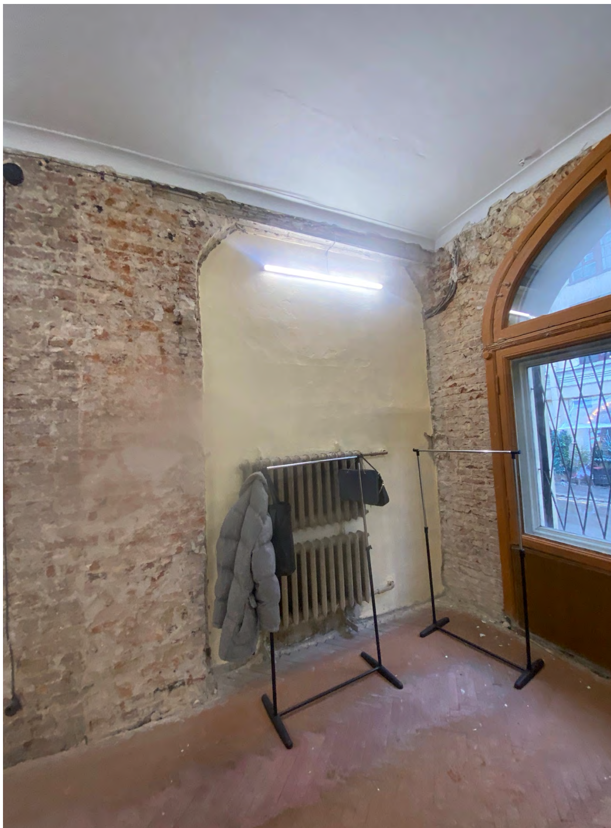
7. Фрагмент интерьера торгового зала (помещение 2/29.1);
