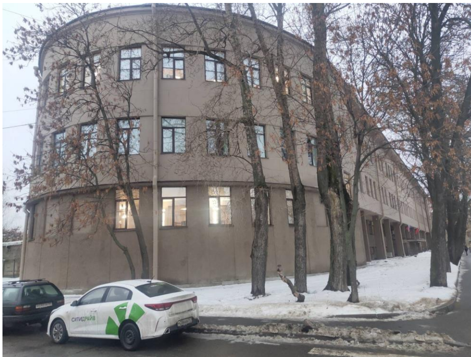
5. Объект культурного наследия «Здание школы» по адресу: Санкт-Петербург, Балтийская ул., д. 35, лит. А (Балтийская ул., 35). Вид на южный и восточный фасады.
