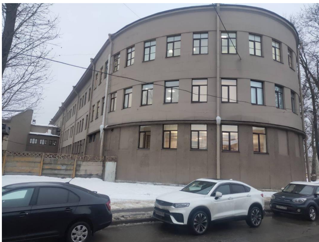
6. Объект культурного наследия «Здание школы» по адресу: Санкт-Петербург, Балтийская ул., д. 35, лит. А (Балтийская ул., 35). Вид на южный и западный фасады.
