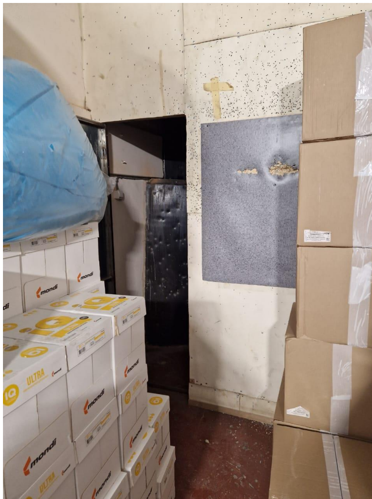
33. Объект культурного наследия «Здание школы» по адресу: Санкт-Петербург, Балтийская ул., д. 35, лит. А (Балтийская ул., 35). Столовая. Помещение №23. Фрагмент интерьера.
