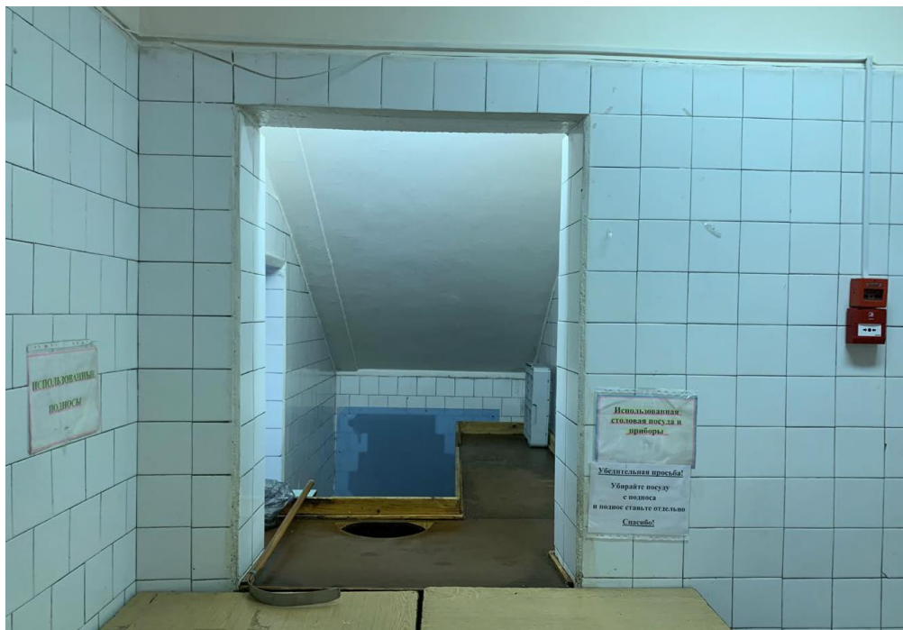
11. Объект культурного наследия «Здание школы» по адресу: Санкт-Петербург, Балтийская ул., д. 35, лит. А (Балтийская ул., 35). Столовая. Вид на окно для приема грязной посуды (помещение №57).
