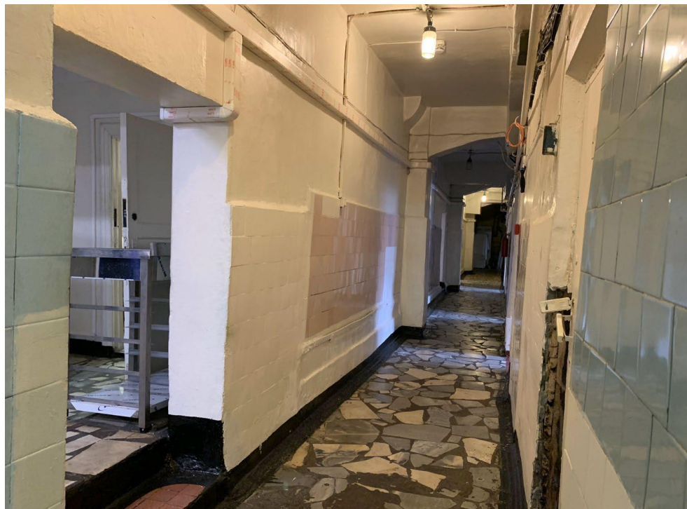
18. Объект культурного наследия «Здание школы» по адресу: Санкт-Петербург, Балтийская ул., д. 35, лит. А (Балтийская ул., 35). Столовая. Вид на вход в помещение раздачи №1 (помещение №32) и арки с опорой на пилоны.
