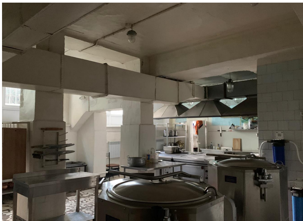
27. Объект культурного наследия «Здание школы» по адресу: Санкт-Петербург, Балтийская ул., д. 35, лит. А (Балтийская ул., 35). Столовая. Горячий цех (помещение №35). Общий вид.
