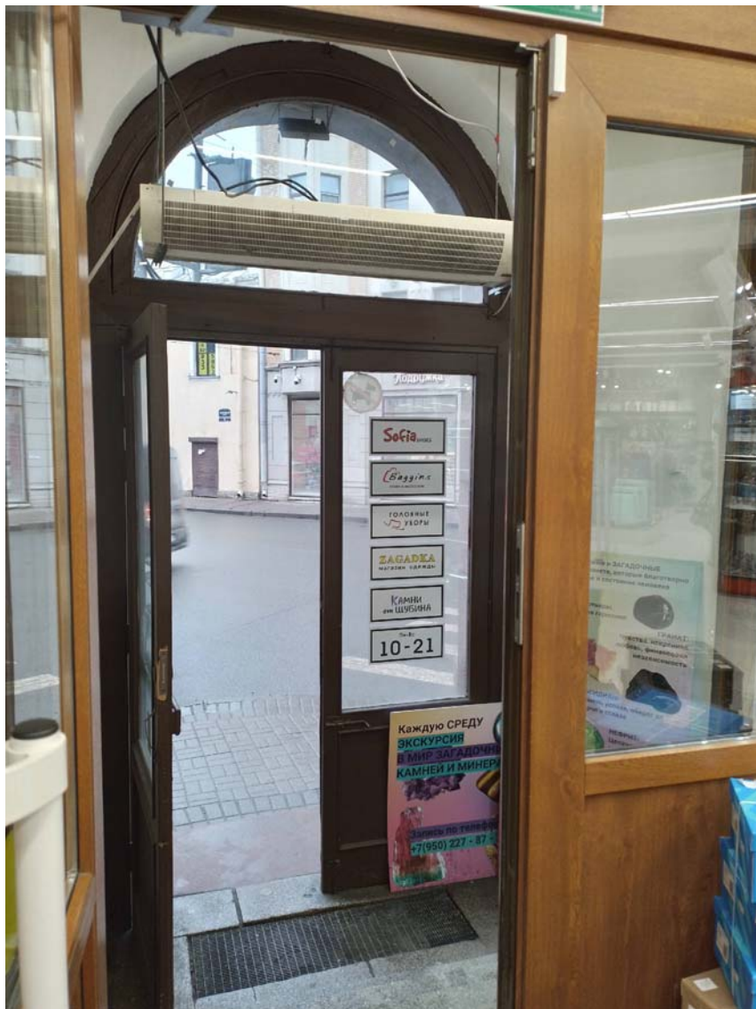
Фото 6. Выявленный объект культурного наследия «Дом М.А. Стенбок-Фермор». Входной тамбур (помещение 1-Н). Съемка 01.03.2024 г. Трушковский В. Э.
