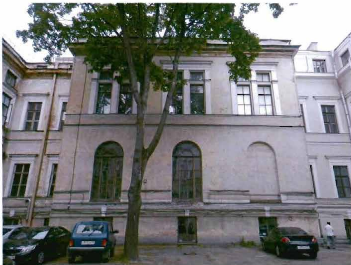
5. Восточный фасад внутреннего двора
