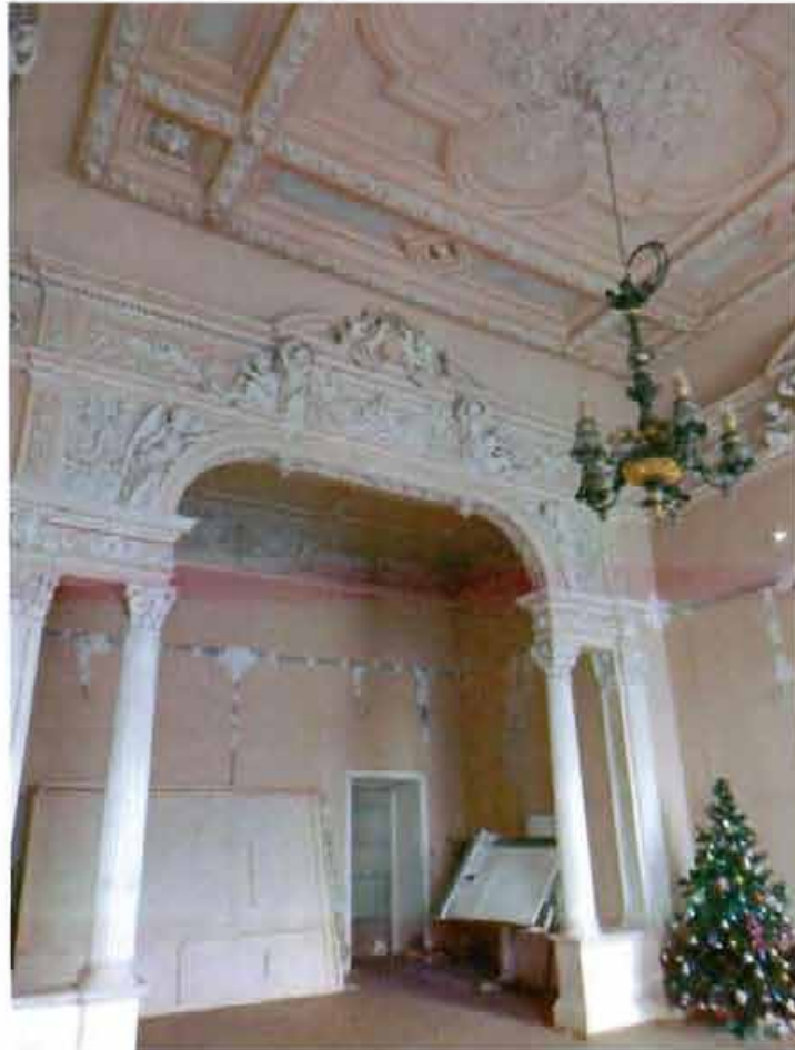
16. Интерьеры (помещение 1-Н(168)).
