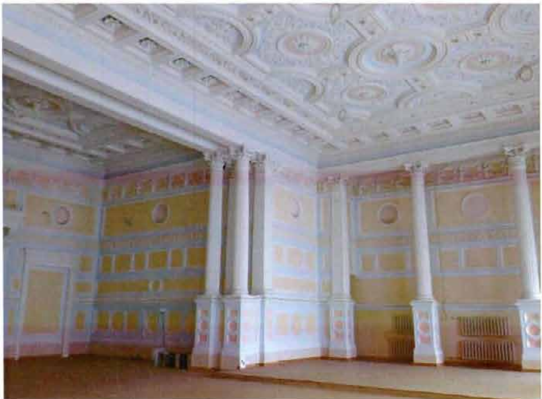
12. Интерьеры (помещение 1-Н(163)).
