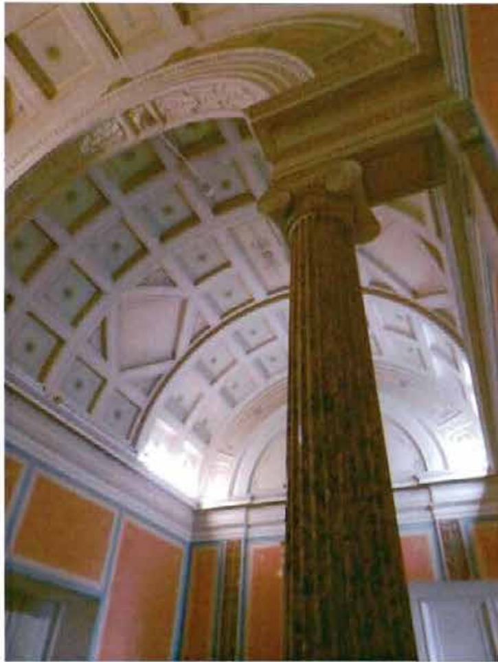
13. Интерьеры (помещение 1-Н(172)).
