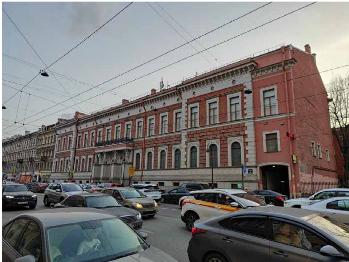
Фото 2 Лицевой фасад объекта культурного наследия федерального значения «Главное здание», входящего в состав объекта культурного наследия федерального значения «Дом Пашкова И.В. (дом Департамента уделов)»
