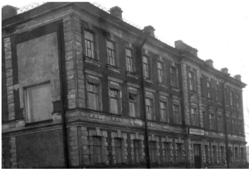
Илл. 13. Фасад здания больницы им. В.В.Цимбалина. 1936 г. ЦГАКФФД СПб Гр 59040.
