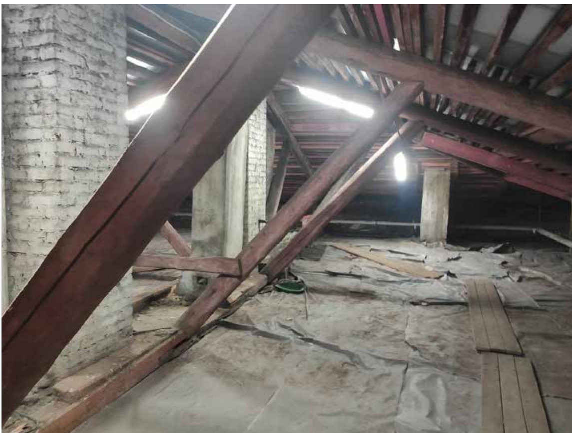
Илл. 165. Помещения чердака.
