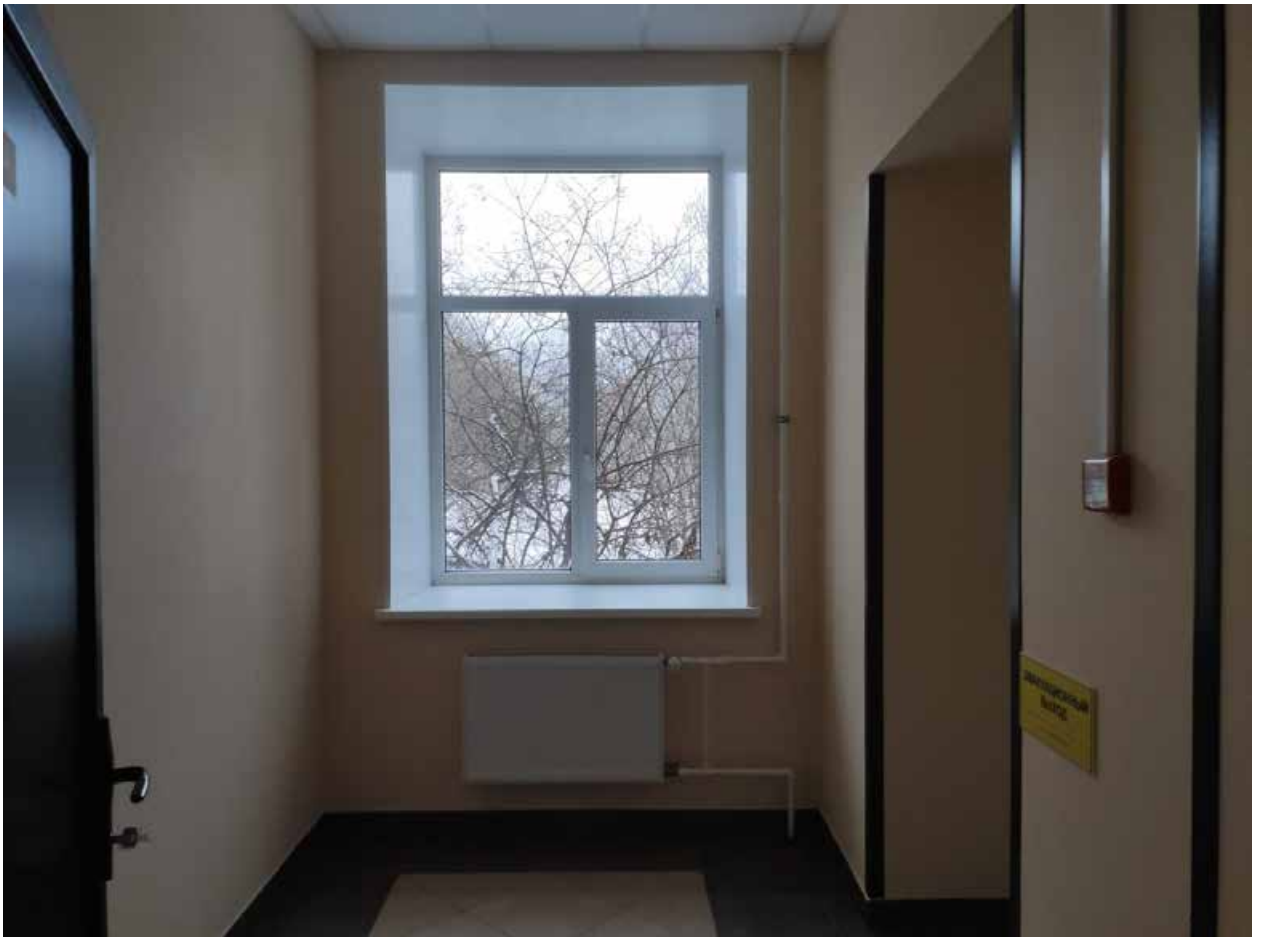
Илл. 67. Окно коридора 1 этажа в восточном объеме здания.
