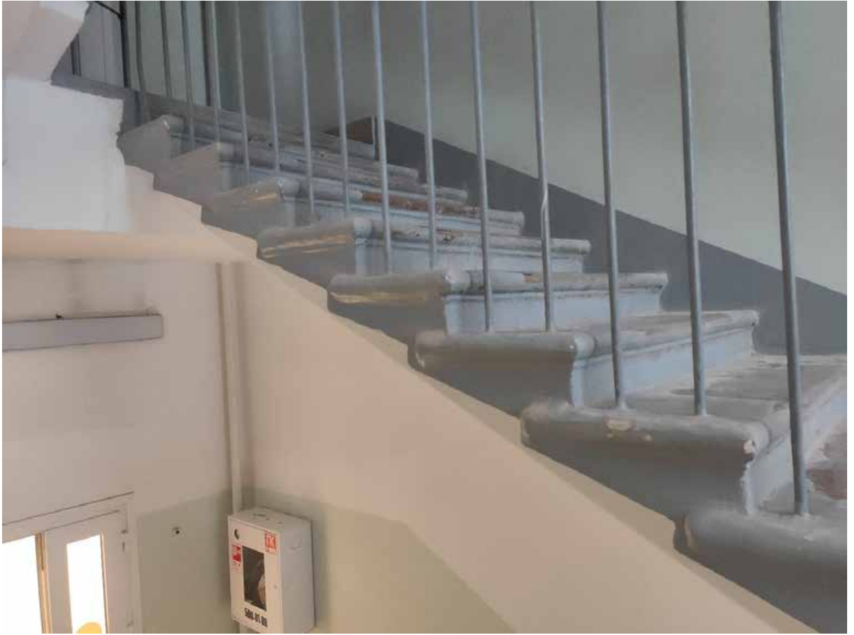
Илл. 152. Лестница в западном объеме здания.
