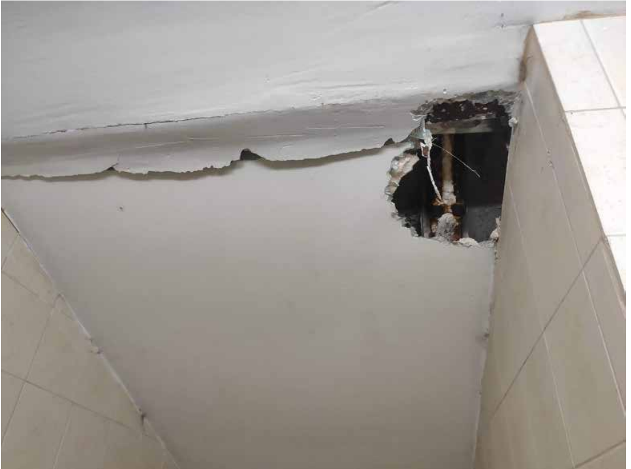
Илл. 18. Перекрытие подвального помещения в западной части здания.
