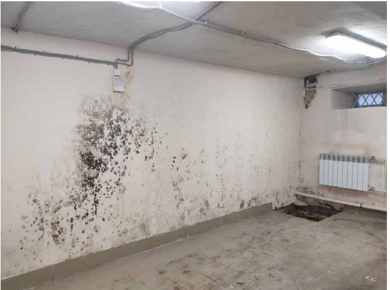
Илл. 21. Стена подвального помещения в западной части здания.
