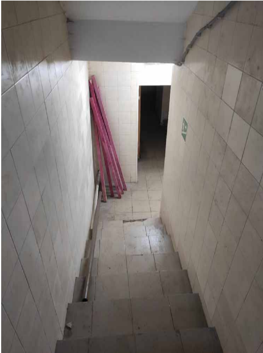
Илл. 16. Лестница в подвальное помещение в западной части здания.
