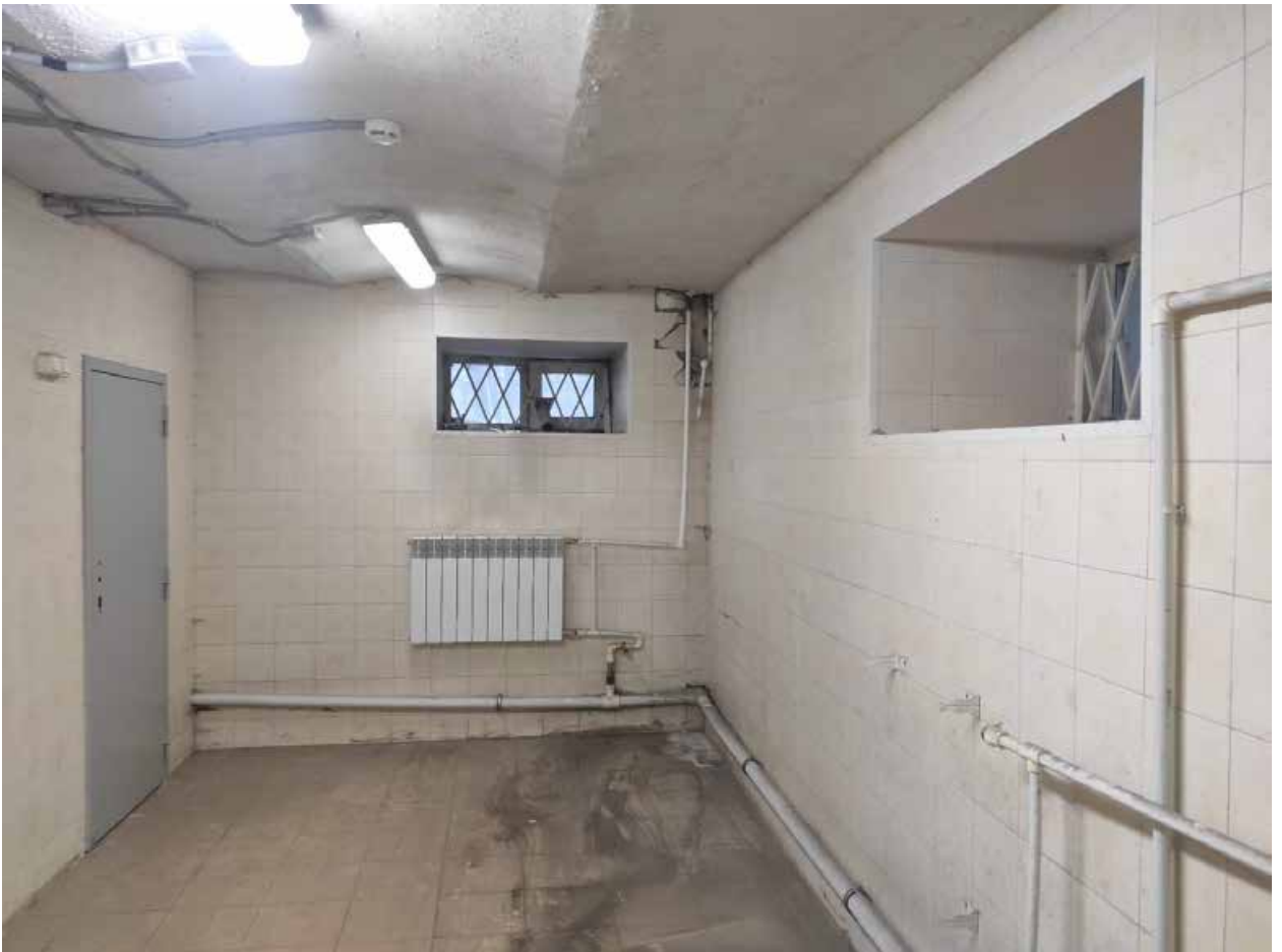
Илл. 37. Подвальное помещение в восточной части здания.
