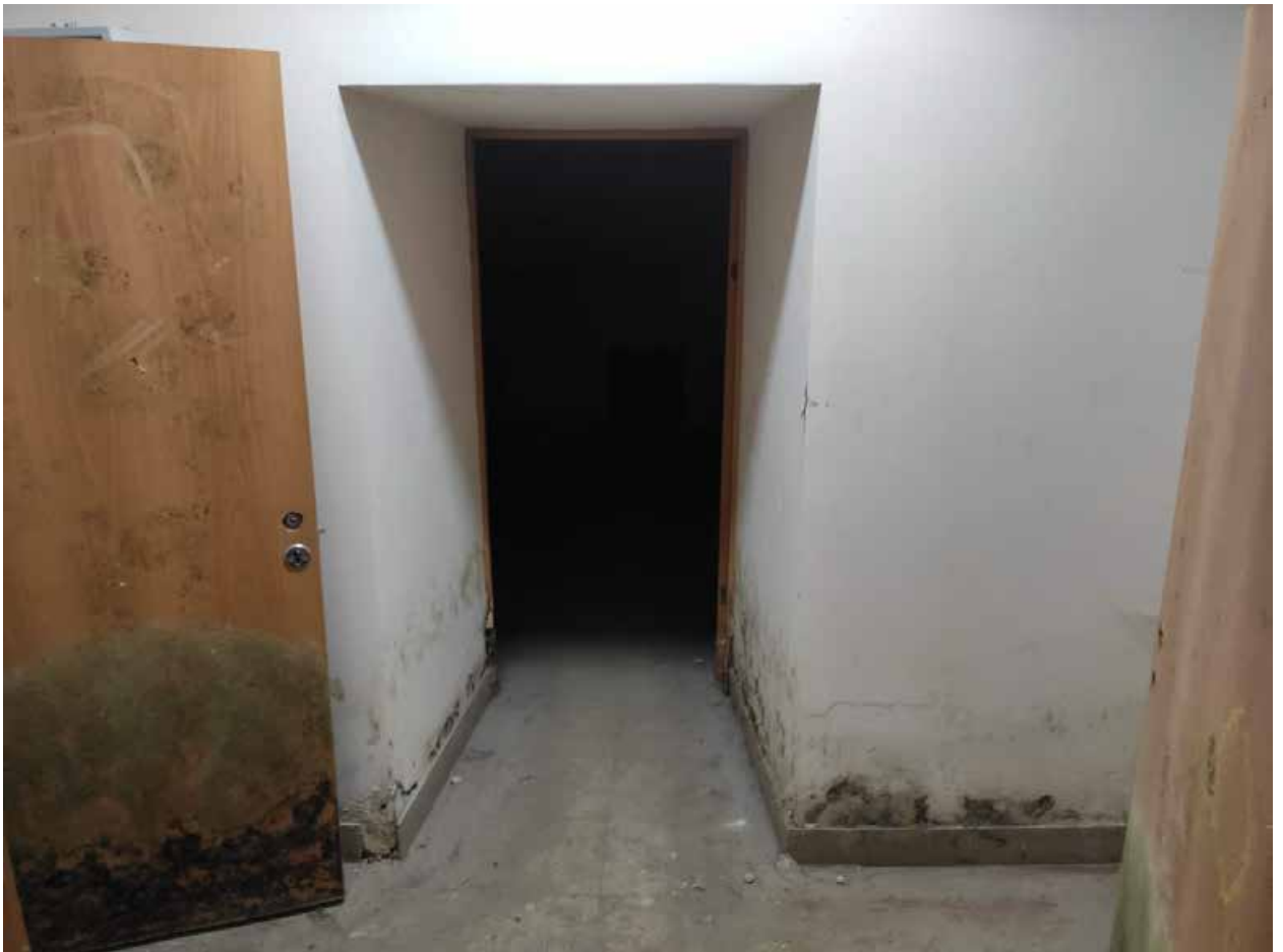
Илл. 26. Дверь в подвальном помещении в восточной части здания.
