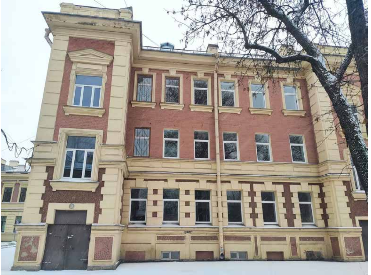
Илл. 9. Дворовый фасад здания.
