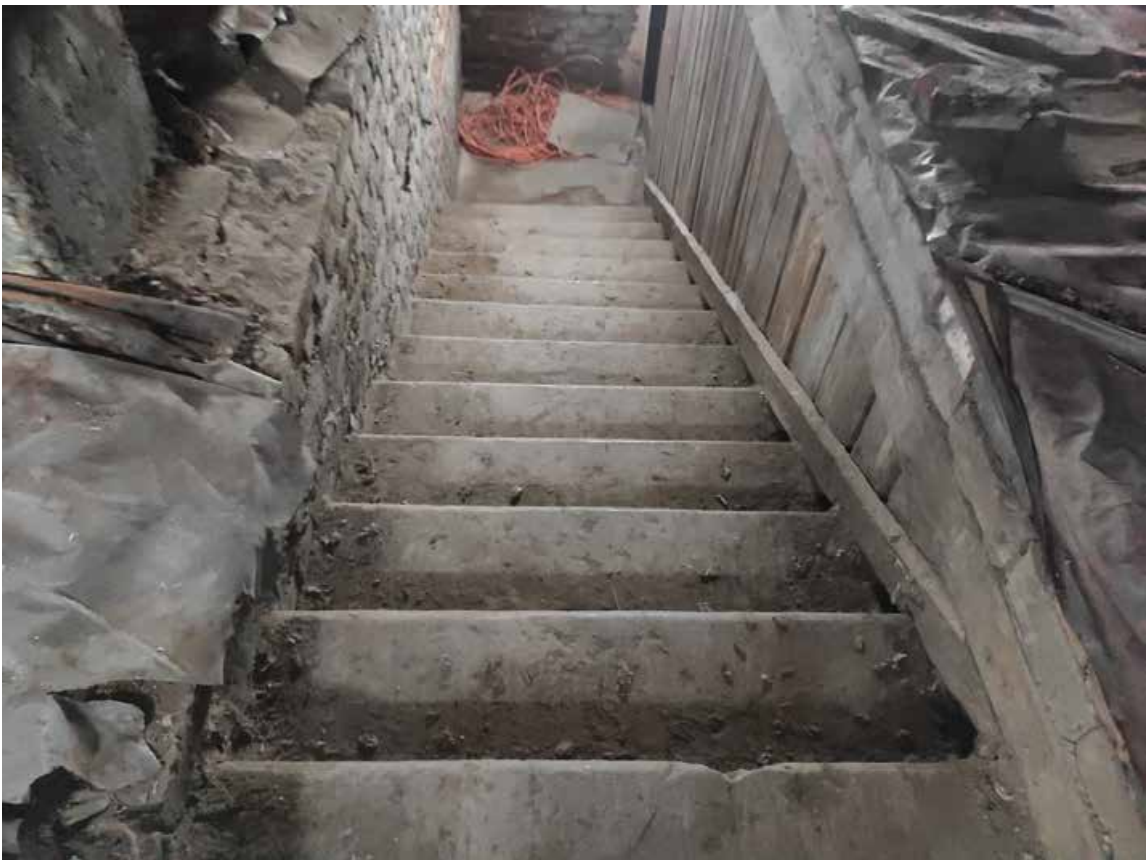
Илл. 170. Помещения чердака.
