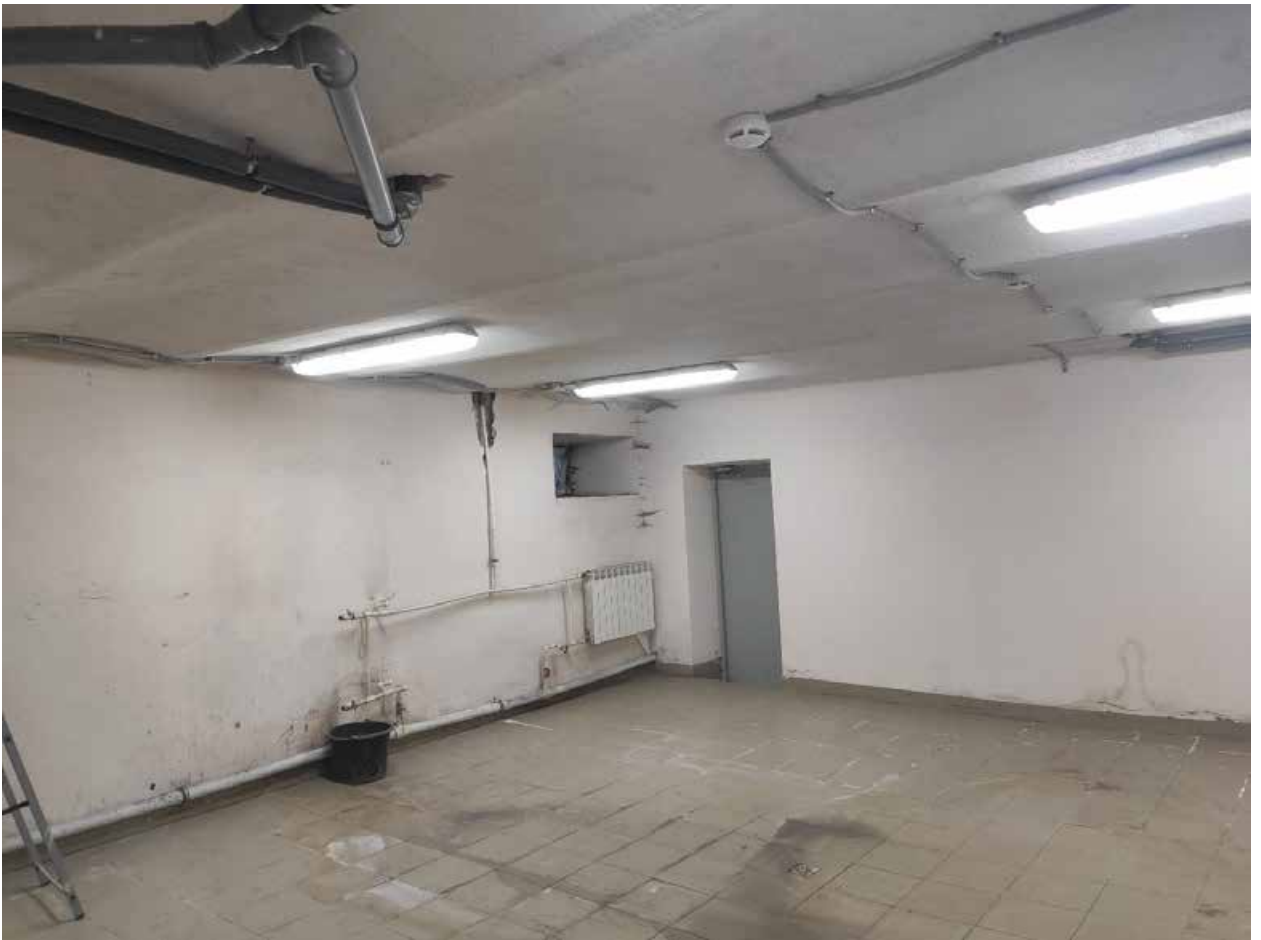
Илл. 31. Подвальное помещение в восточной части здания.
