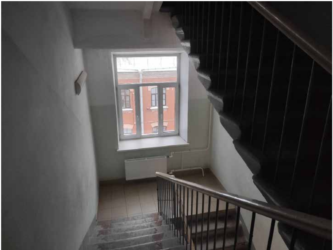
Илл. 155. Лестница в западном объеме здания.
