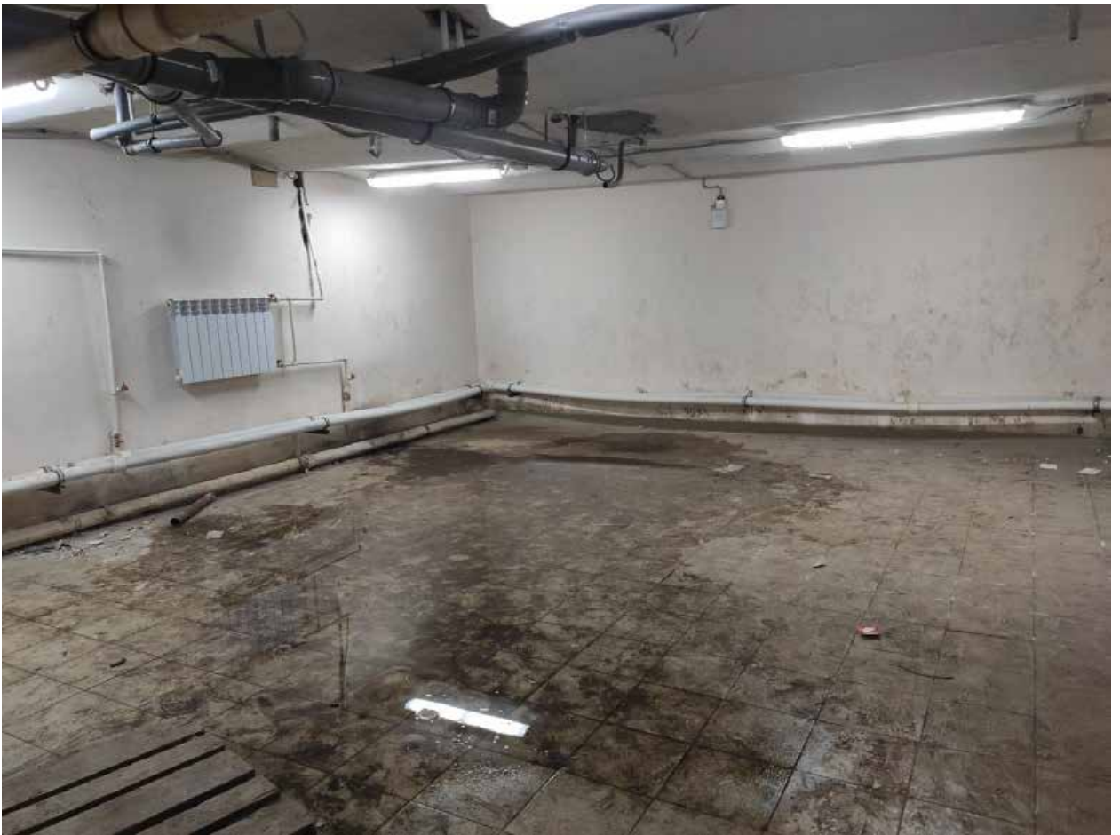
Илл. 24. Подвальное помещение в западной части здания.
