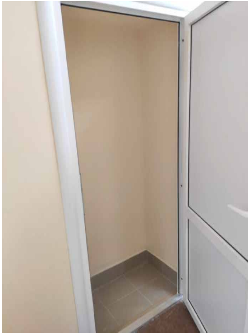
Илл. 129. Ниша в помещении 3 этажа в восточном объеме здания.
