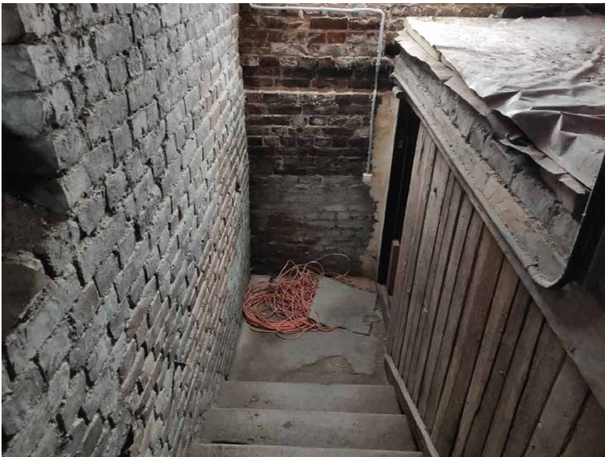
Илл. 171. Помещения чердака.
