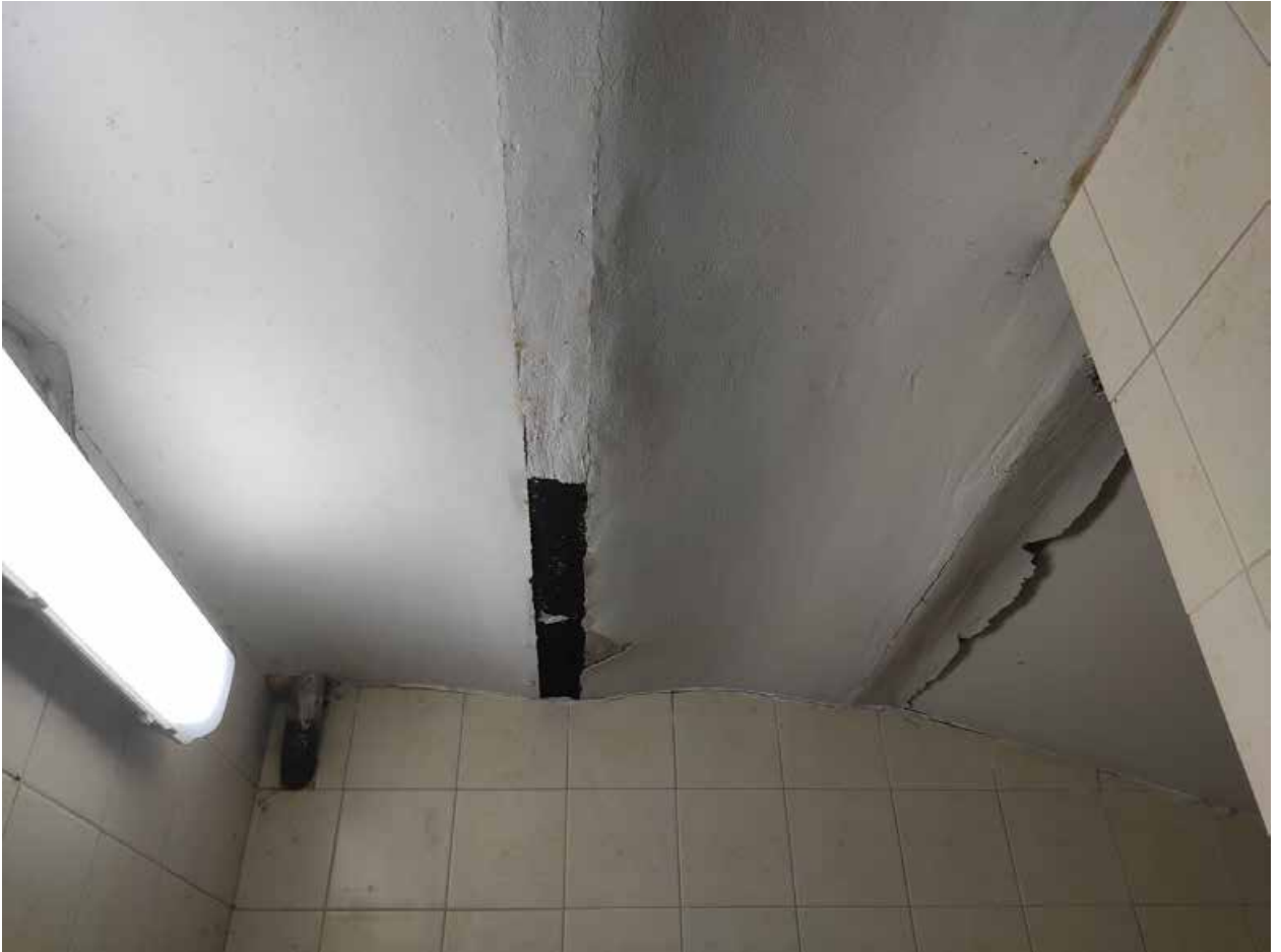
Илл. 19. Перекрытие подвального помещения в западной части здания.
