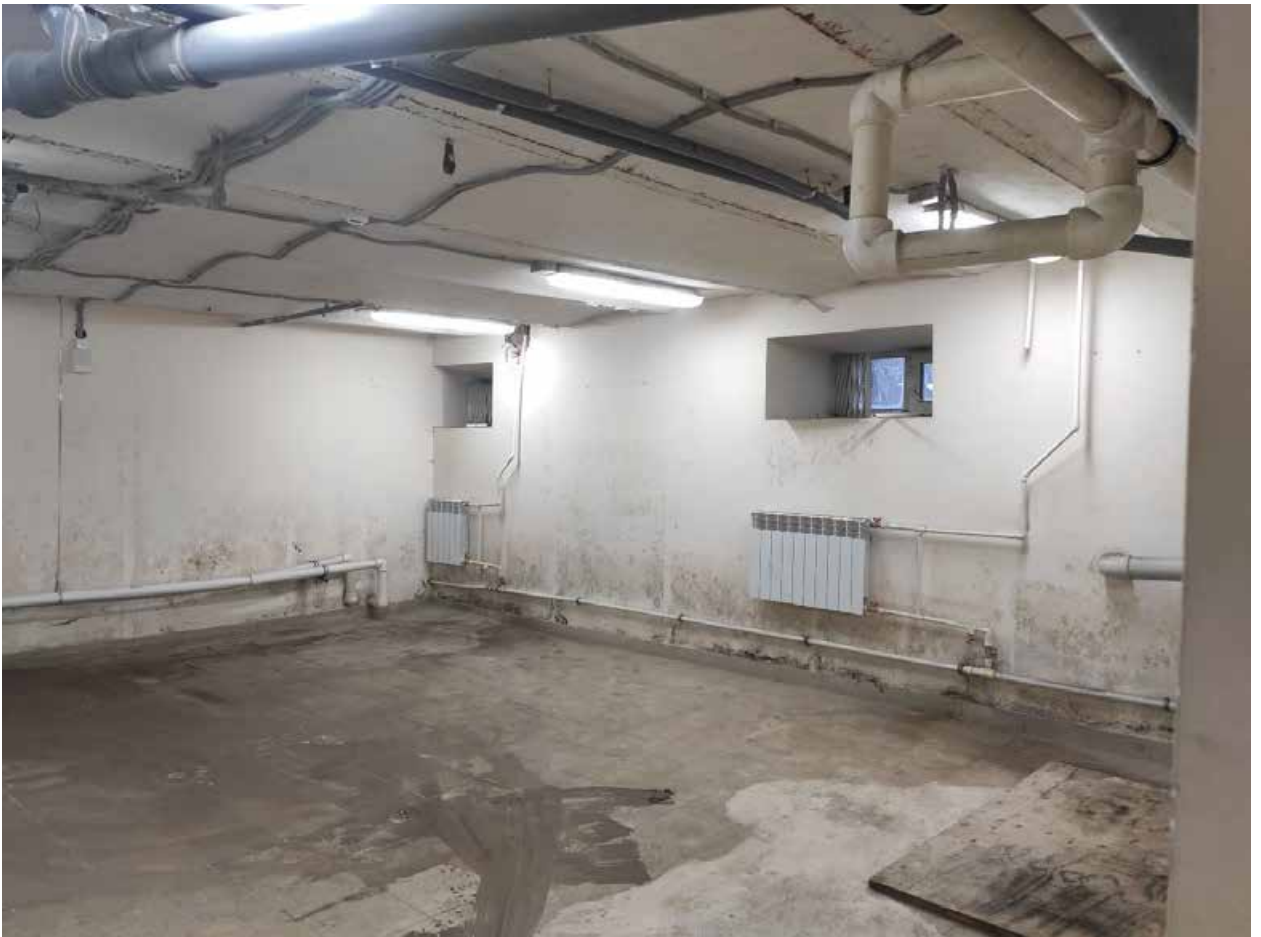
Илл. 23. Подвальное помещение в западной части здания.
