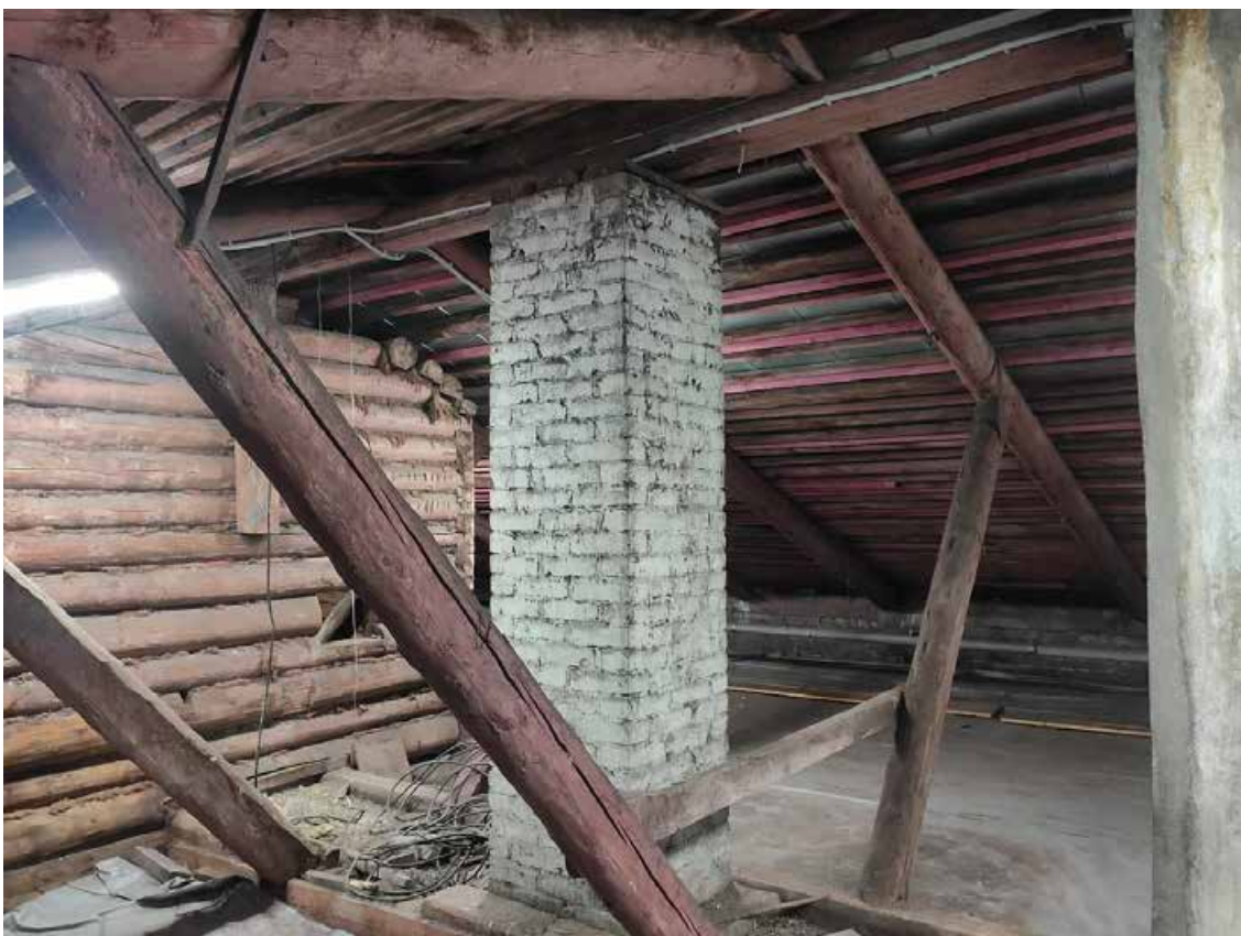
Илл. 167. Помещения чердака.
