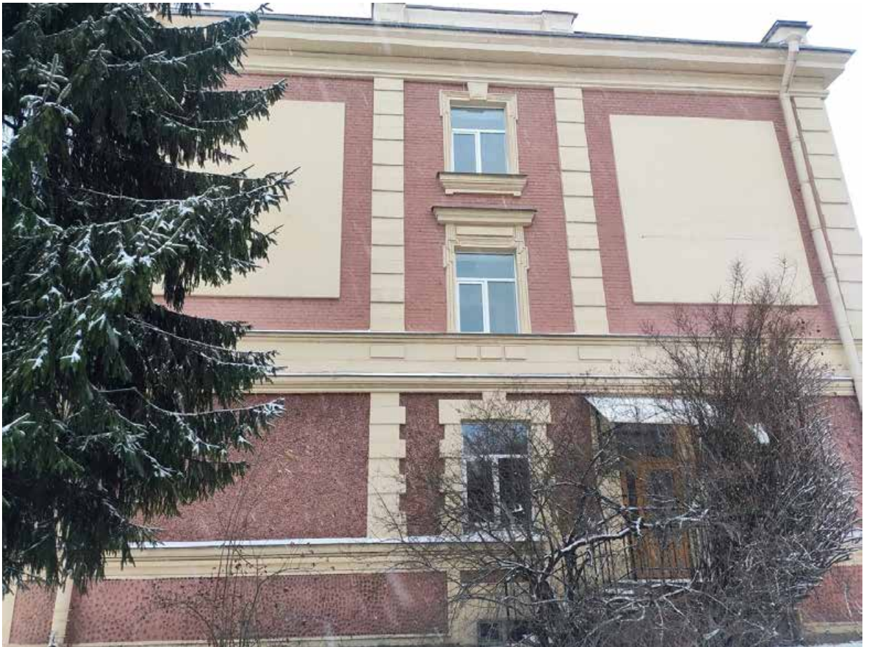
Илл. 14. Торцевой фасад здания.
