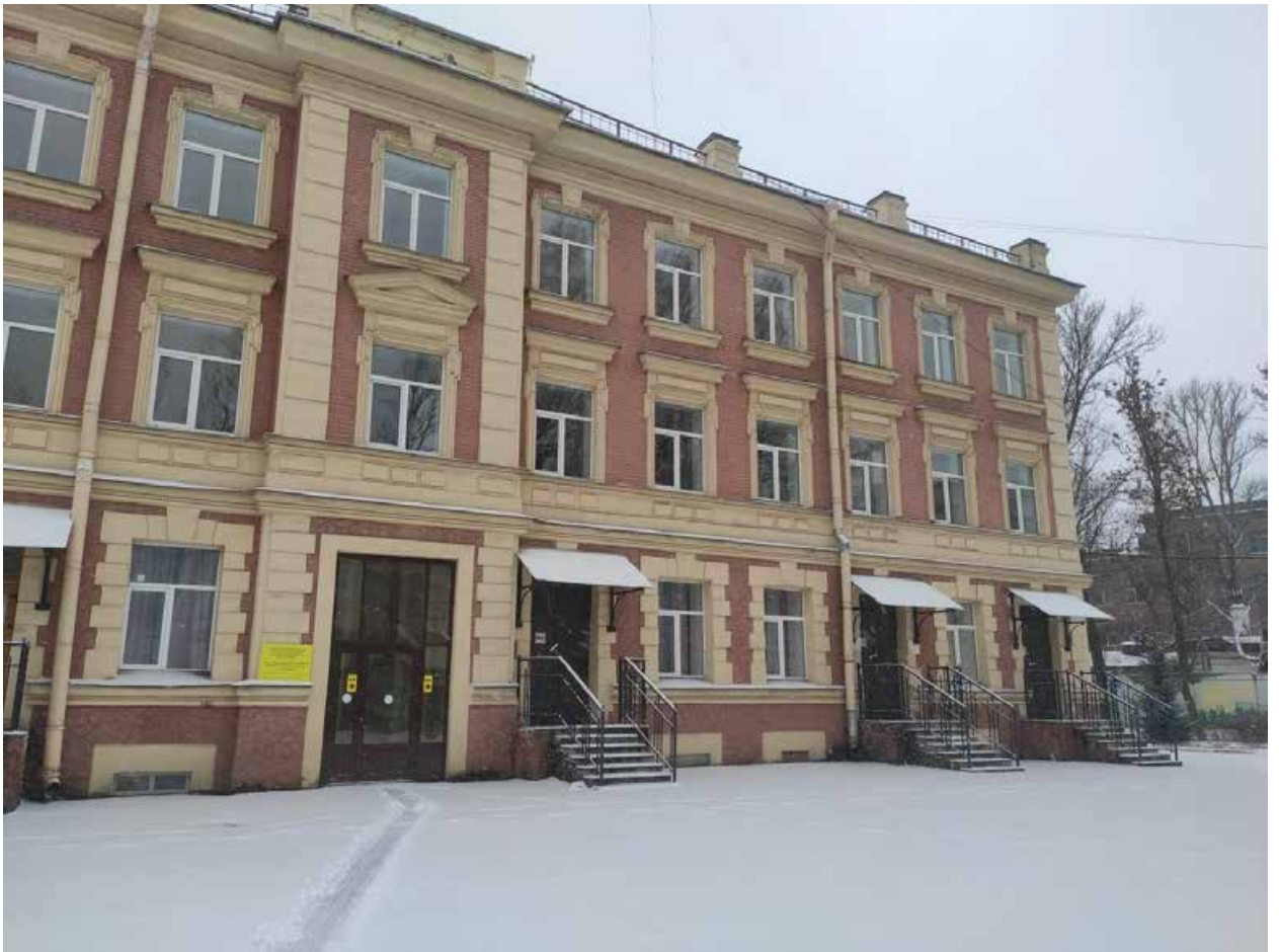
Илл. 2. Лицевой фасад здания.
