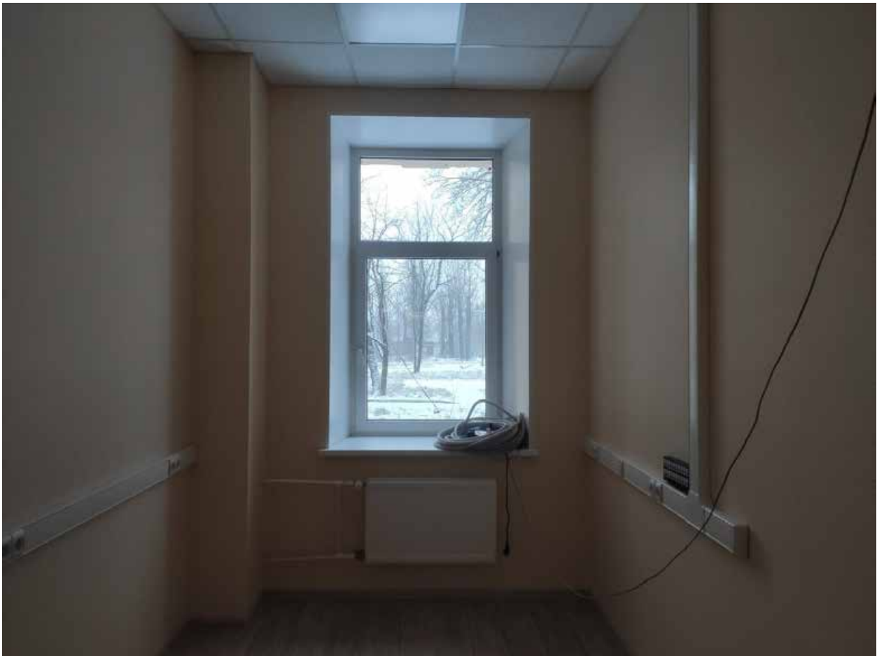
Илл. 69. Помещение 1 этажа в восточном объеме здания.
