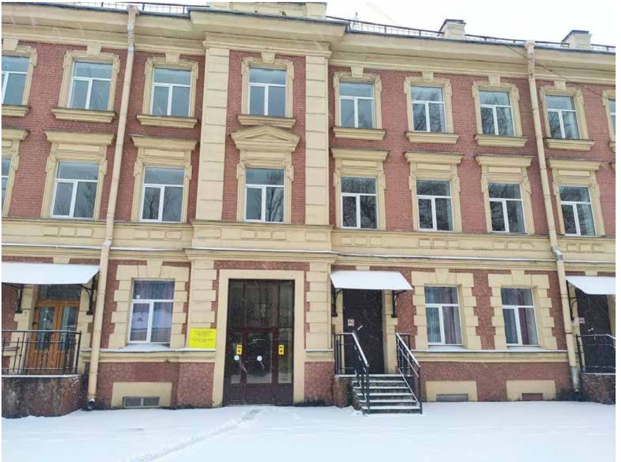
Илл. 3. Лицевой фасад здания.
