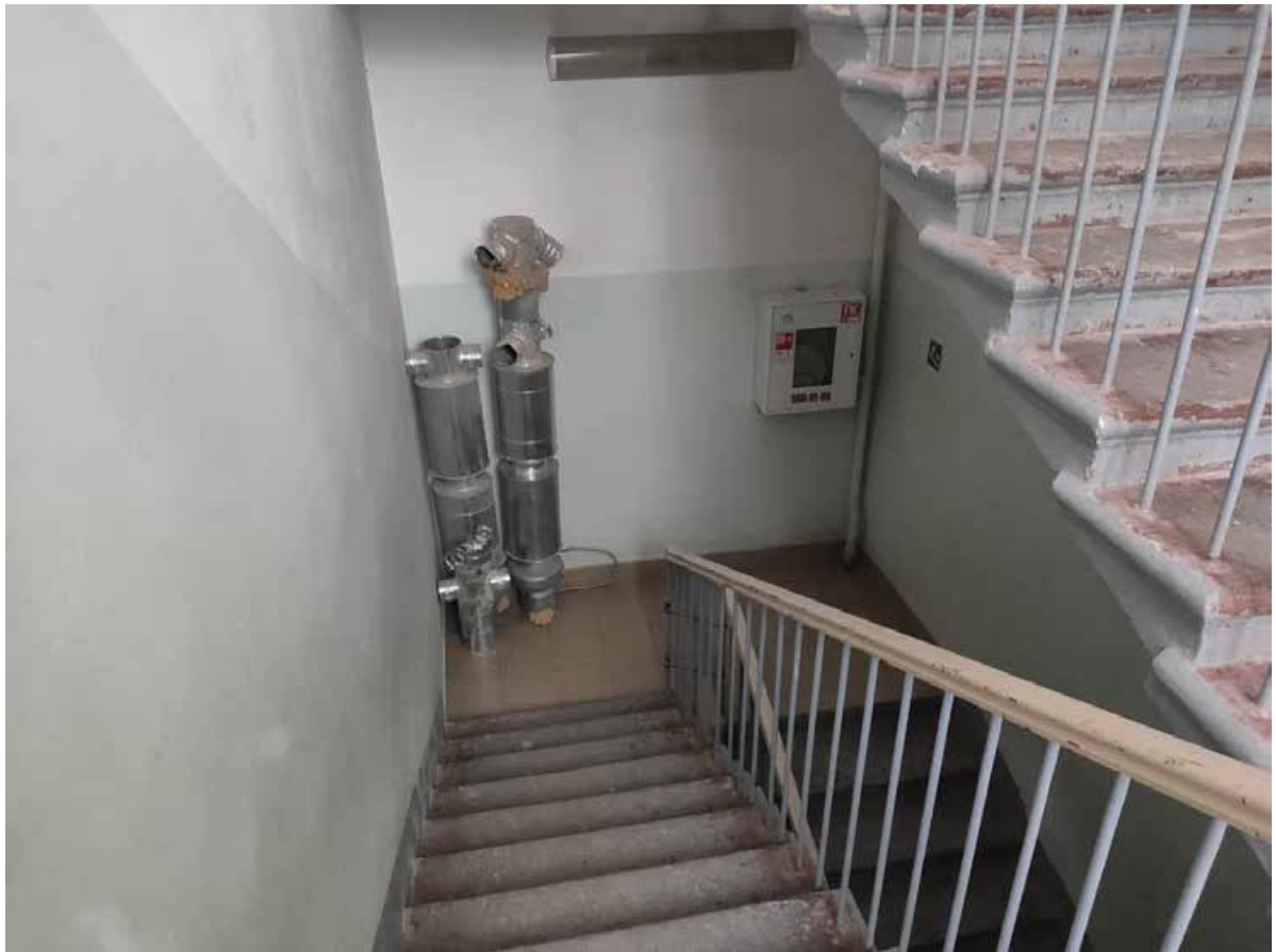
Илл. 148. Лестница в западном объеме здания.
