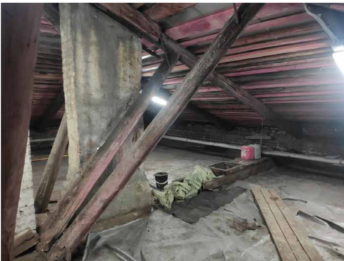
Илл. 166. Помещения чердака.
