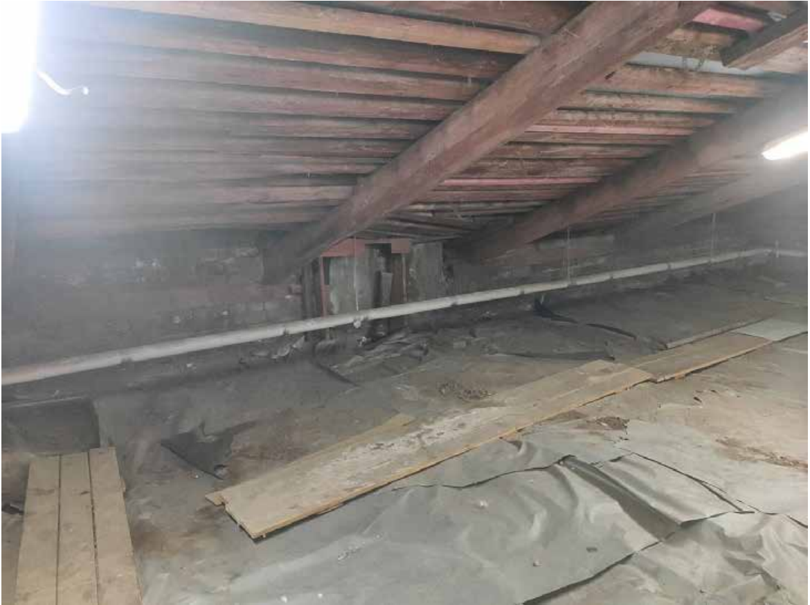
Илл. 169. Помещения чердака.
