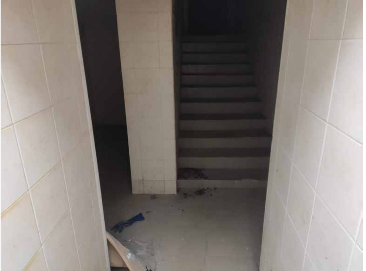
Илл. 35. Лестница в подвальном помещении в восточной части здания.
