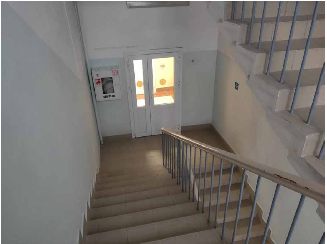
Илл. 160. Лестница в восточном объеме здания.
