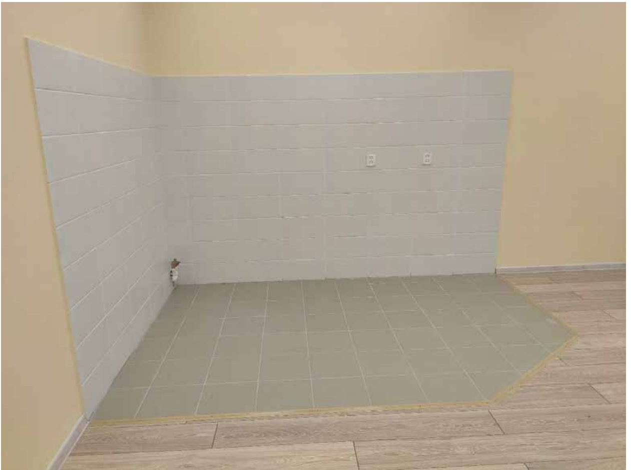
Илл. 128. Фрагмент помещения 3 этажа в восточном объеме здания.
