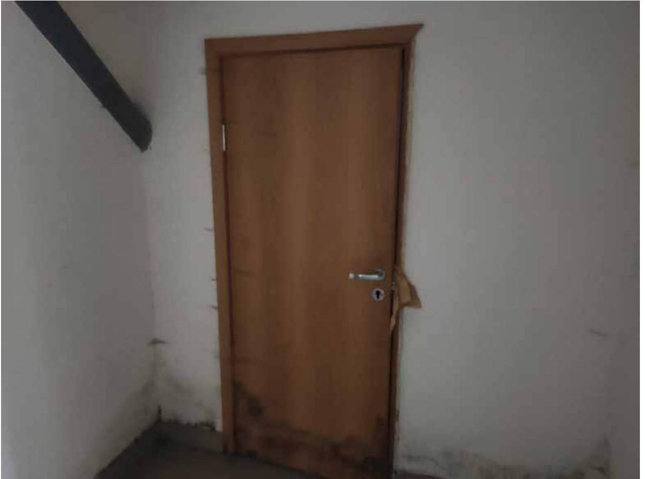
Илл. 34. Дверь в подвальном помещении в восточной части здания.
