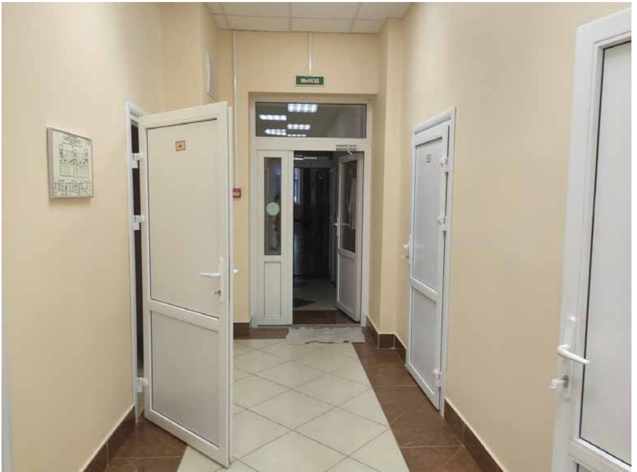
Илл. 90. Фрагмент коридора 2 этажа в восточном объеме здания.
