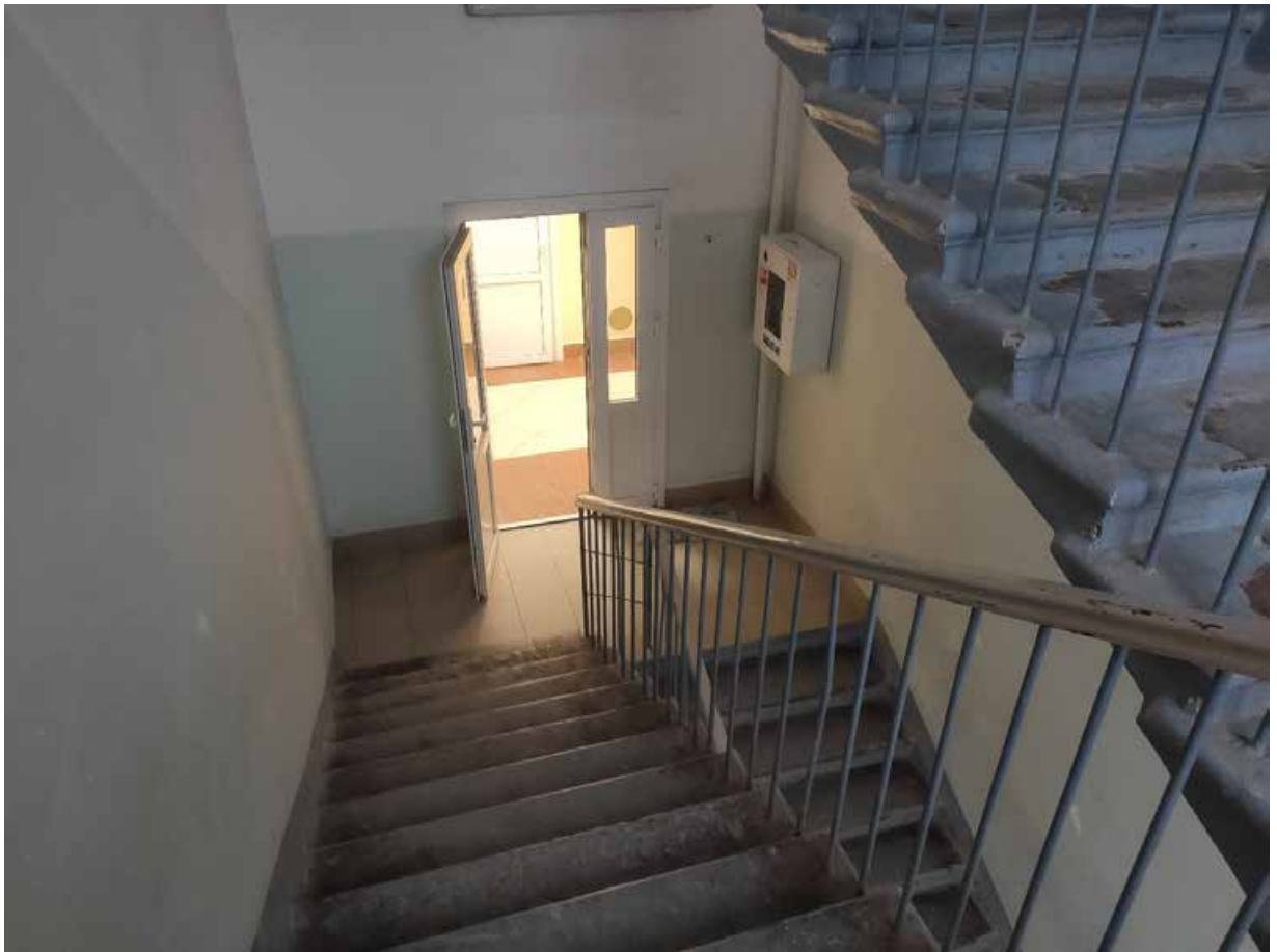
Илл. 153. Лестница в западном объеме здания.
