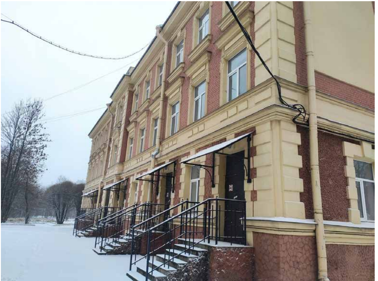
Илл. 5. Лицевой фасад здания.
