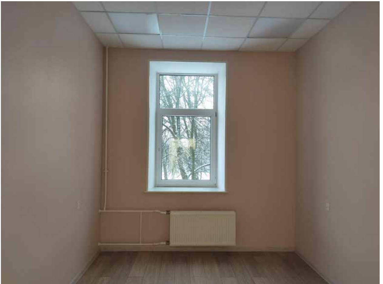
Илл. 82. Помещение 2 этажа в восточном объеме здания.
