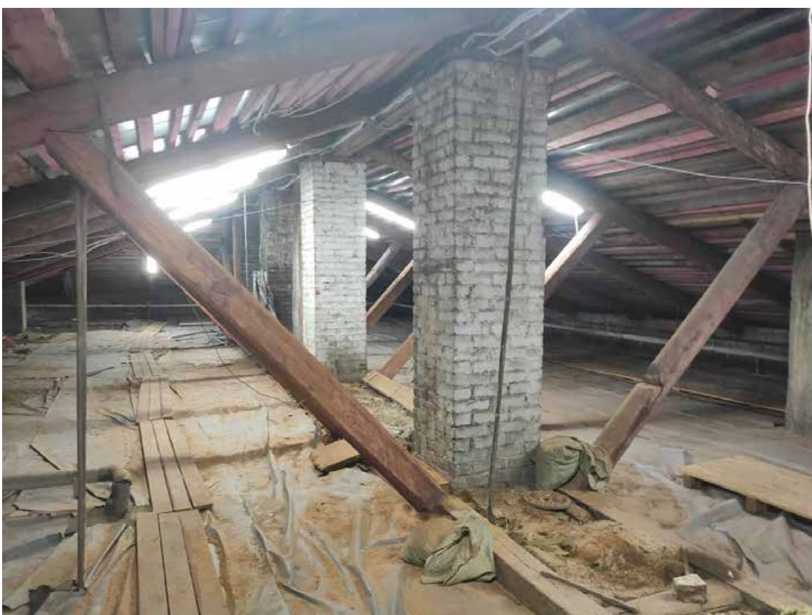
Илл. 168. Помещения чердака.
