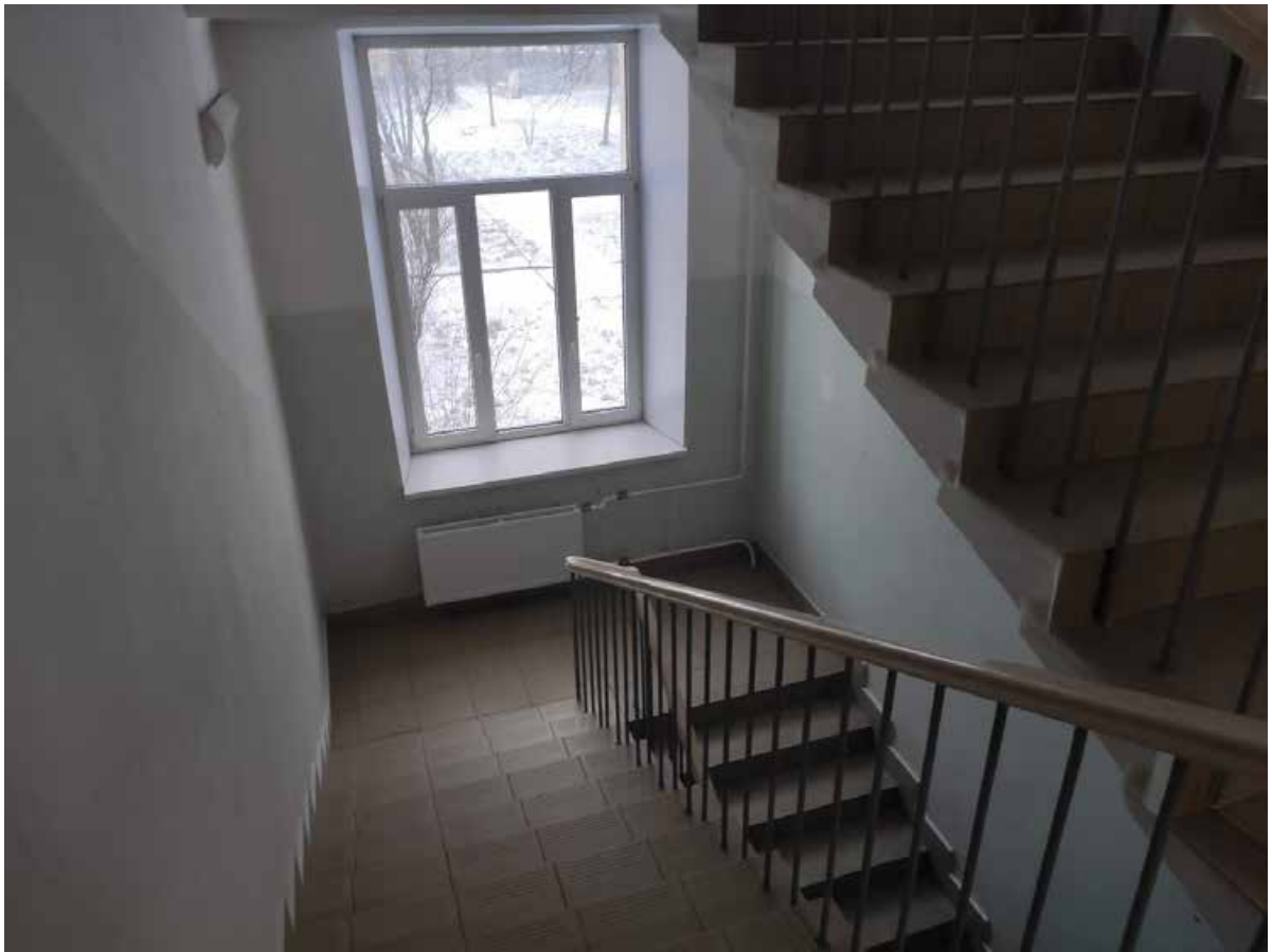
Илл. 159. Лестница в восточном объеме здания.
