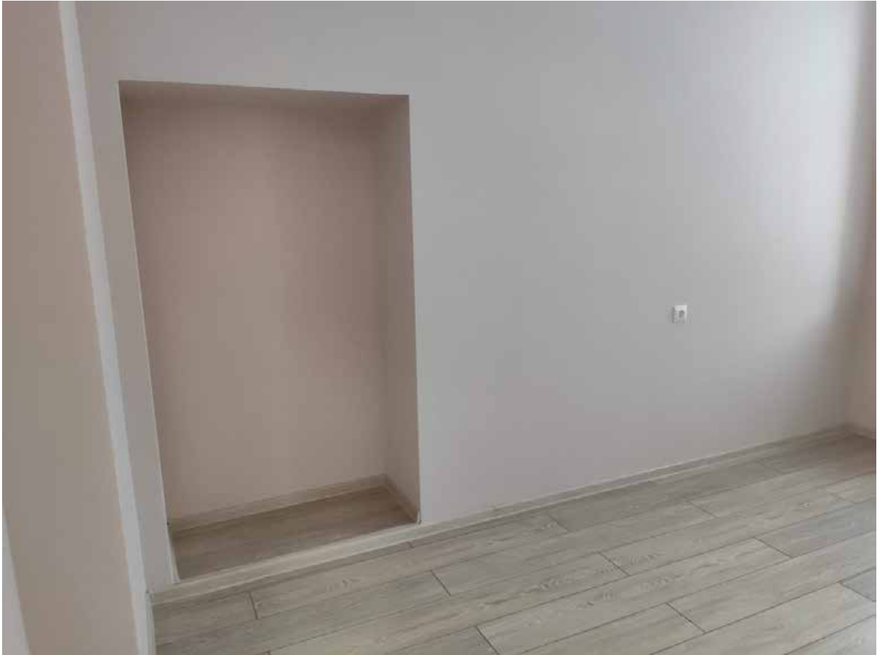
Илл. 55. Ниша в помещении 1 этажа в западном объеме здания.
