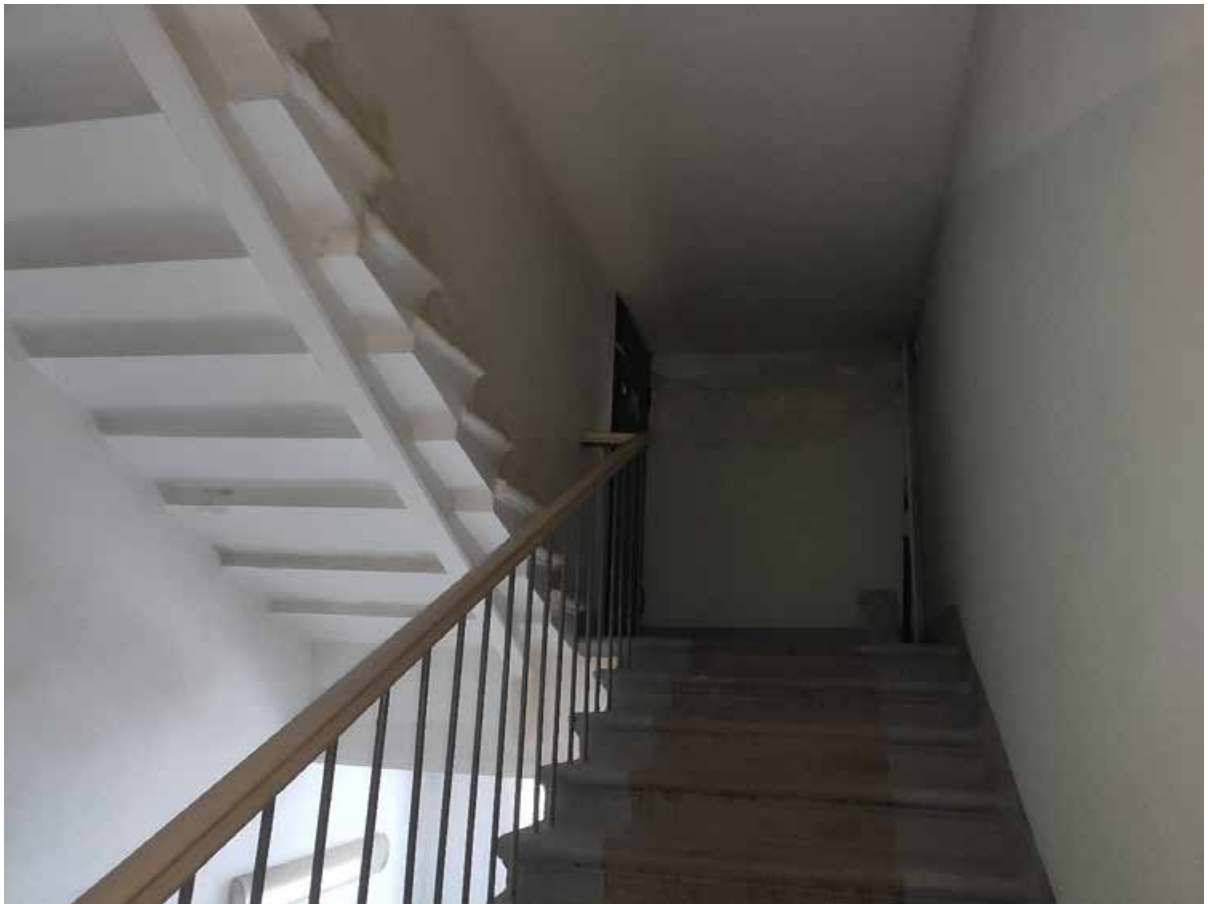
Илл. 156. Лестница в западном объеме здания.
