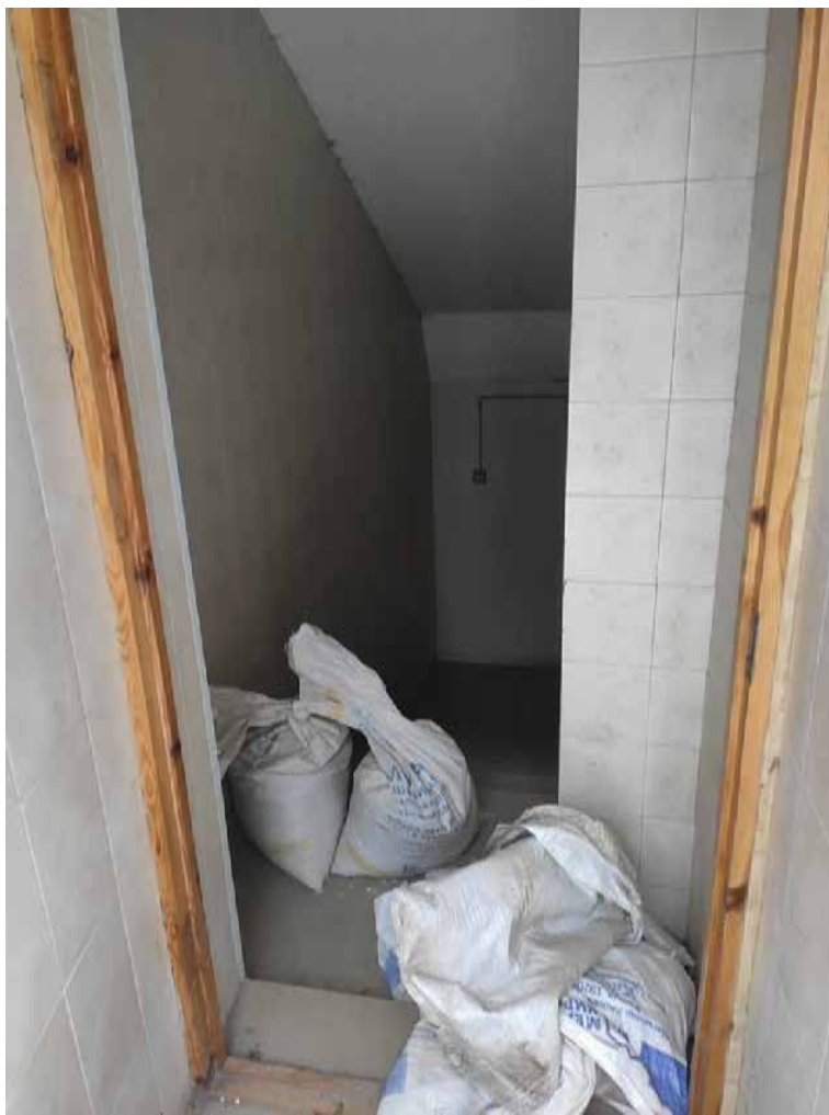
Илл. 25. Подвальное помещение в восточной части здания.
