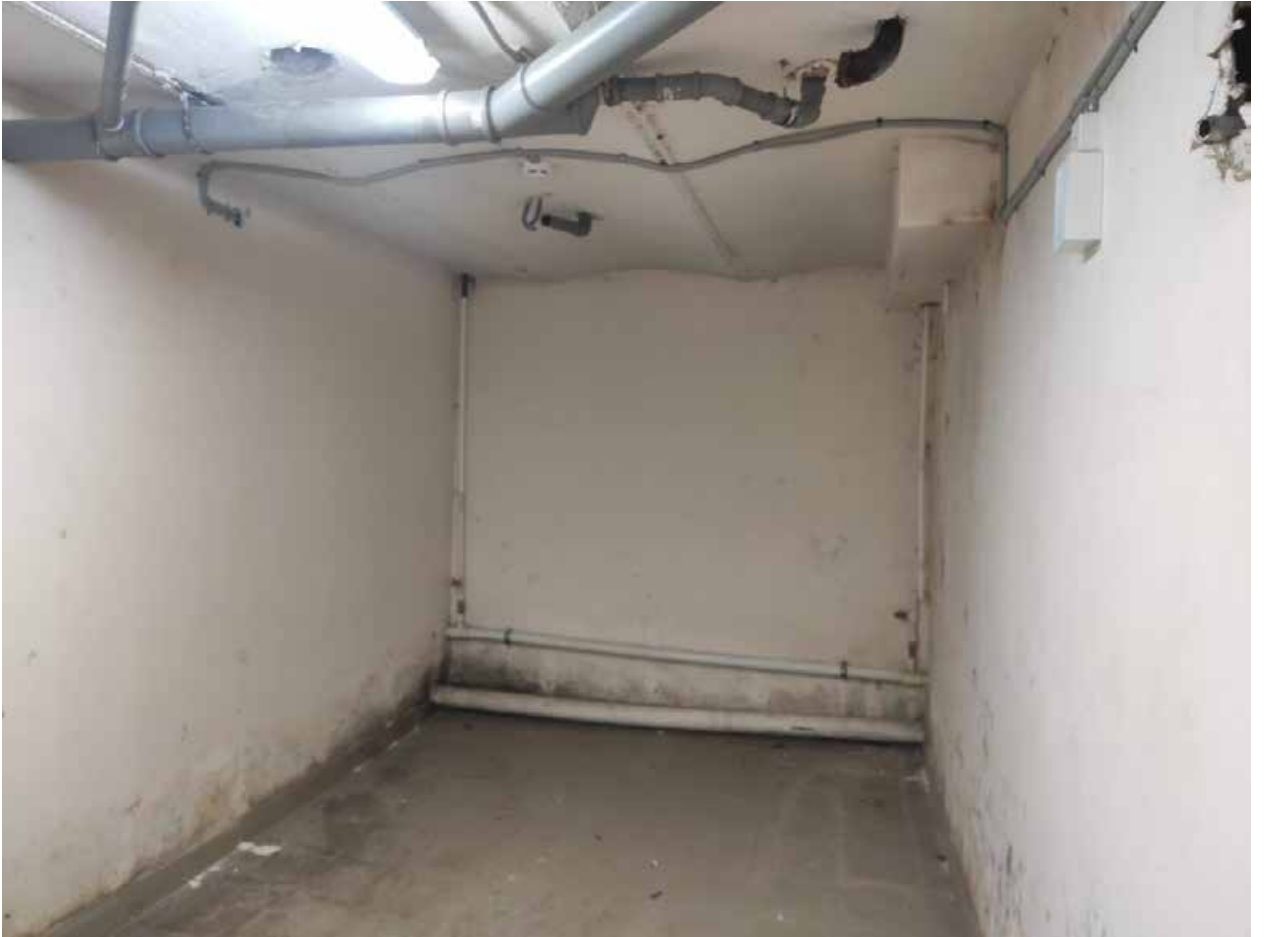
Илл. 29. Подвальное помещение в восточной части здания.
