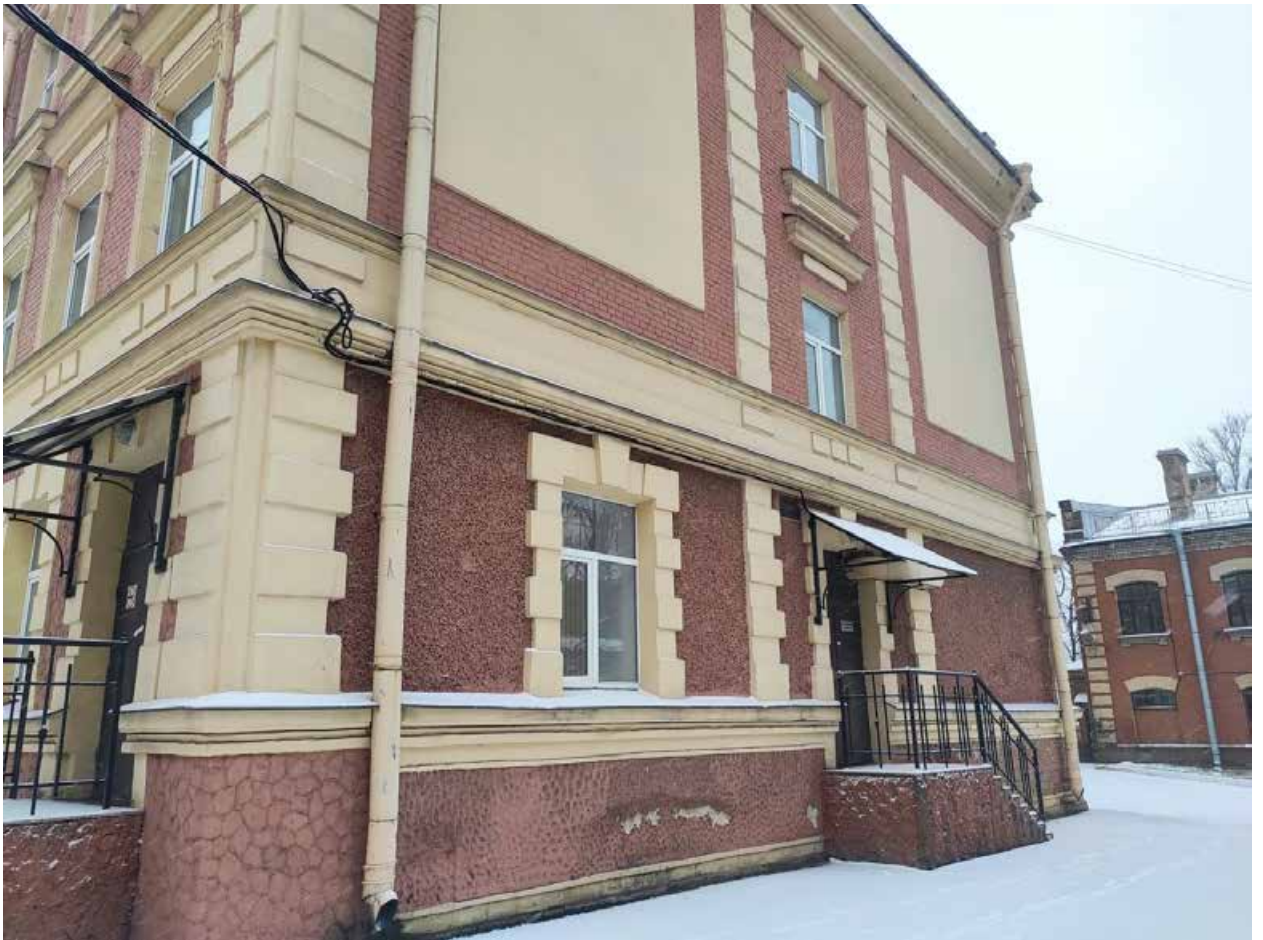
Илл. 4. Торцевой фасад здания.
