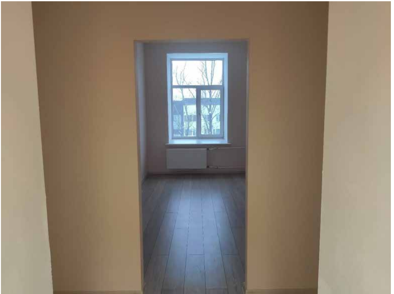
Илл. 123. Помещение 3 этажа в восточном объеме здания.
