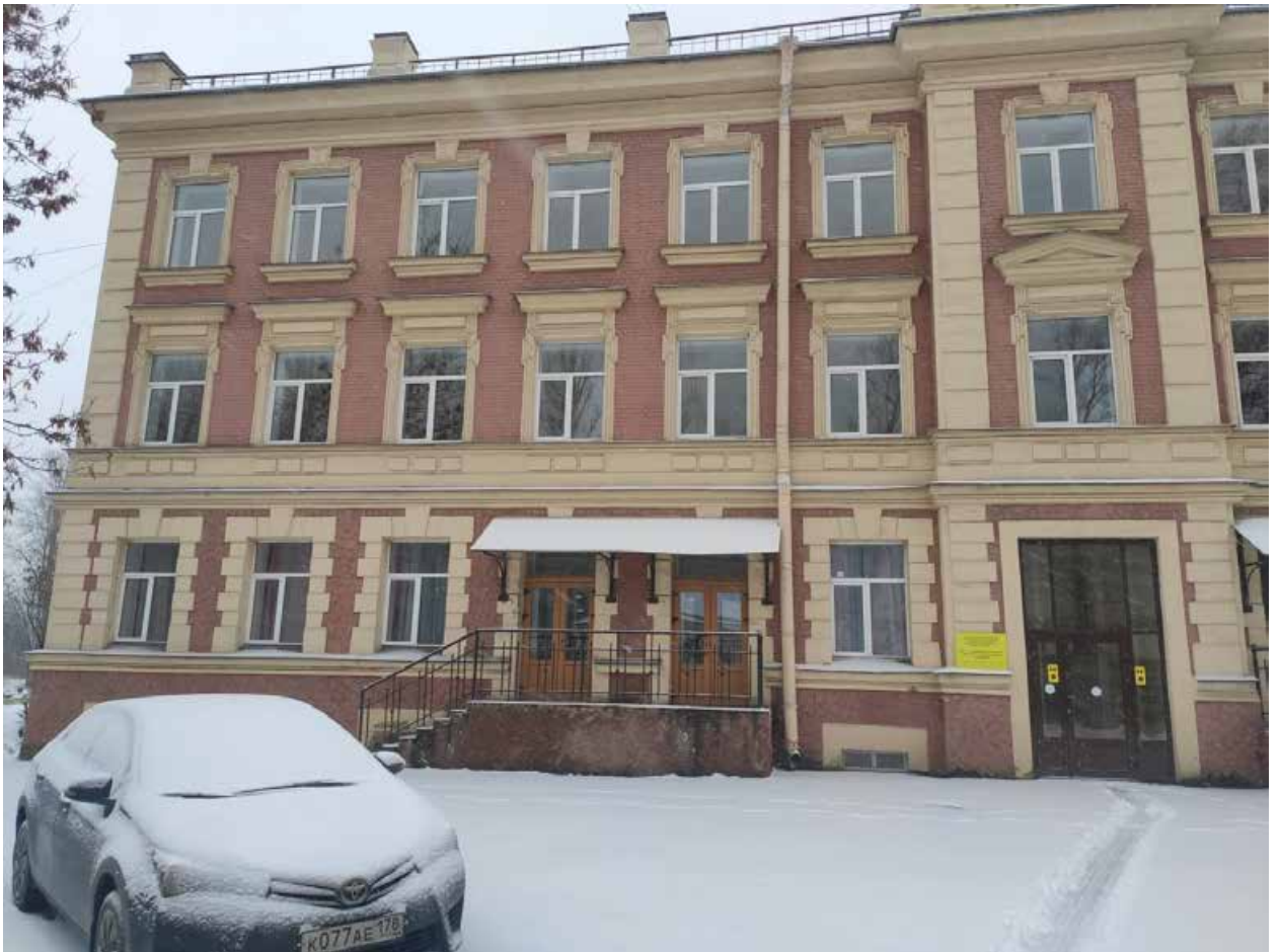
Илл. 1. Лицевой фасад здания.
