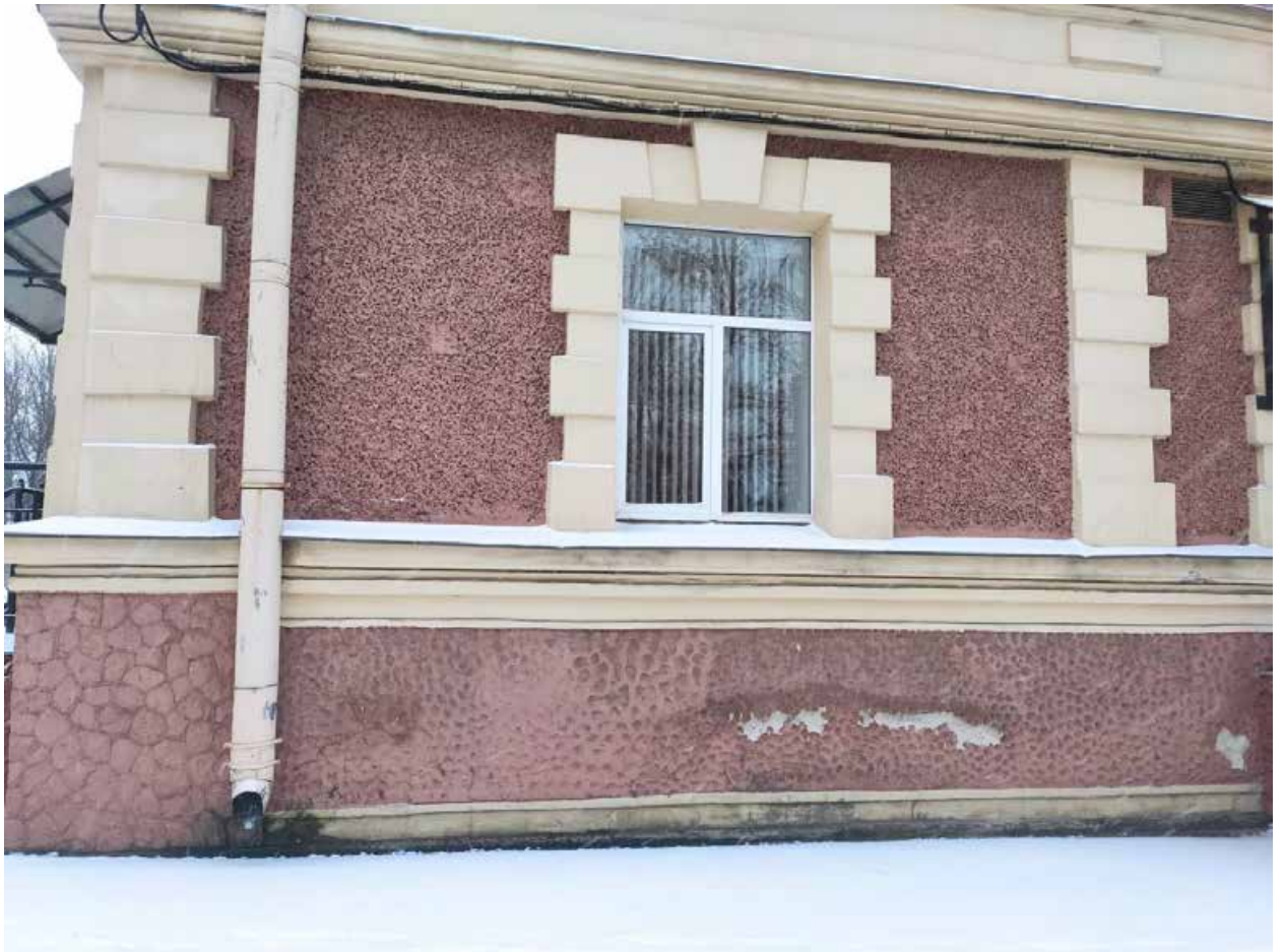
Илл. 6. Торцевой фасад здания.
