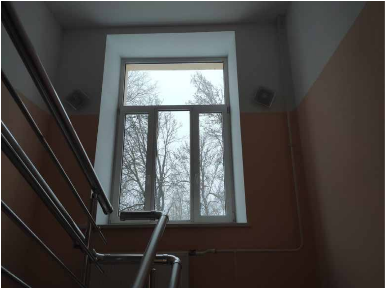
Илл. 77. Окно лестничной клетки в центральном объеме здания.
