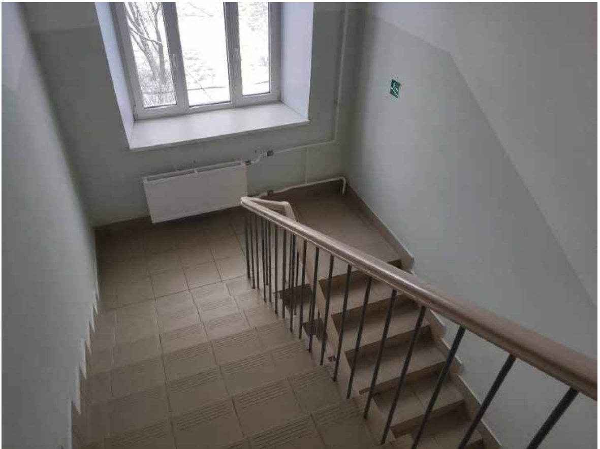
Илл. 161. Лестница в восточном объеме здания.
