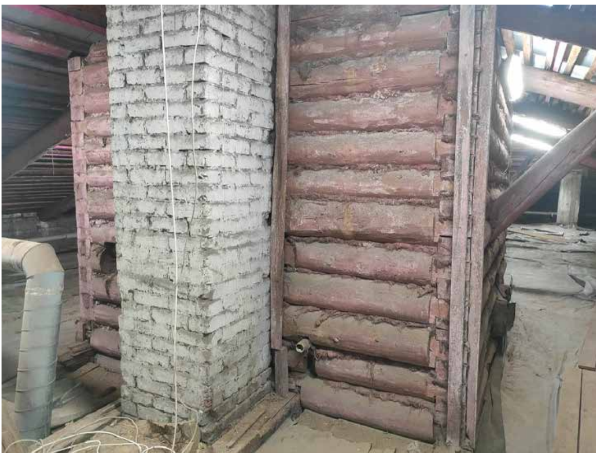
Илл. 164. Помещения чердака.
