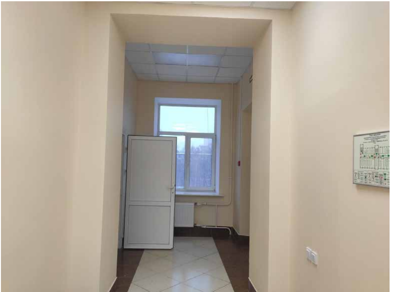
Илл. 117. Фрагмент коридора 3 этажа в восточном объеме здания.
