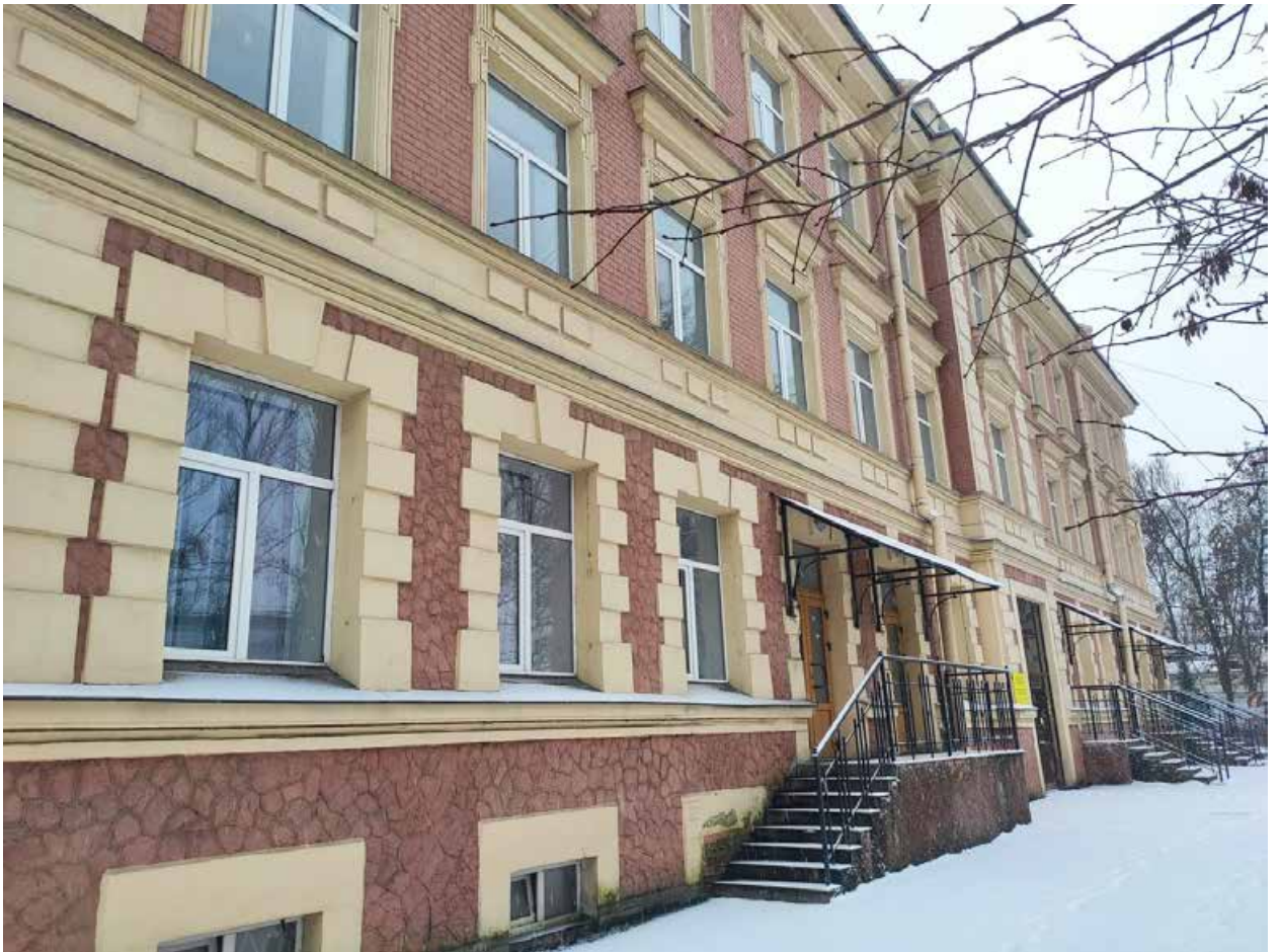
Илл. 15. Лицевой фасад здания.
