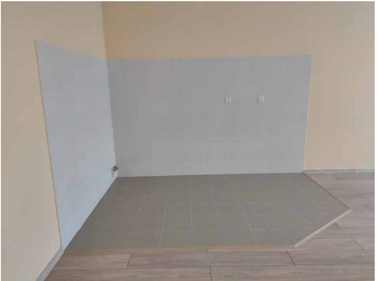
Илл. 92. Фрагмент помещения 2 этажа в восточном объеме здания.
