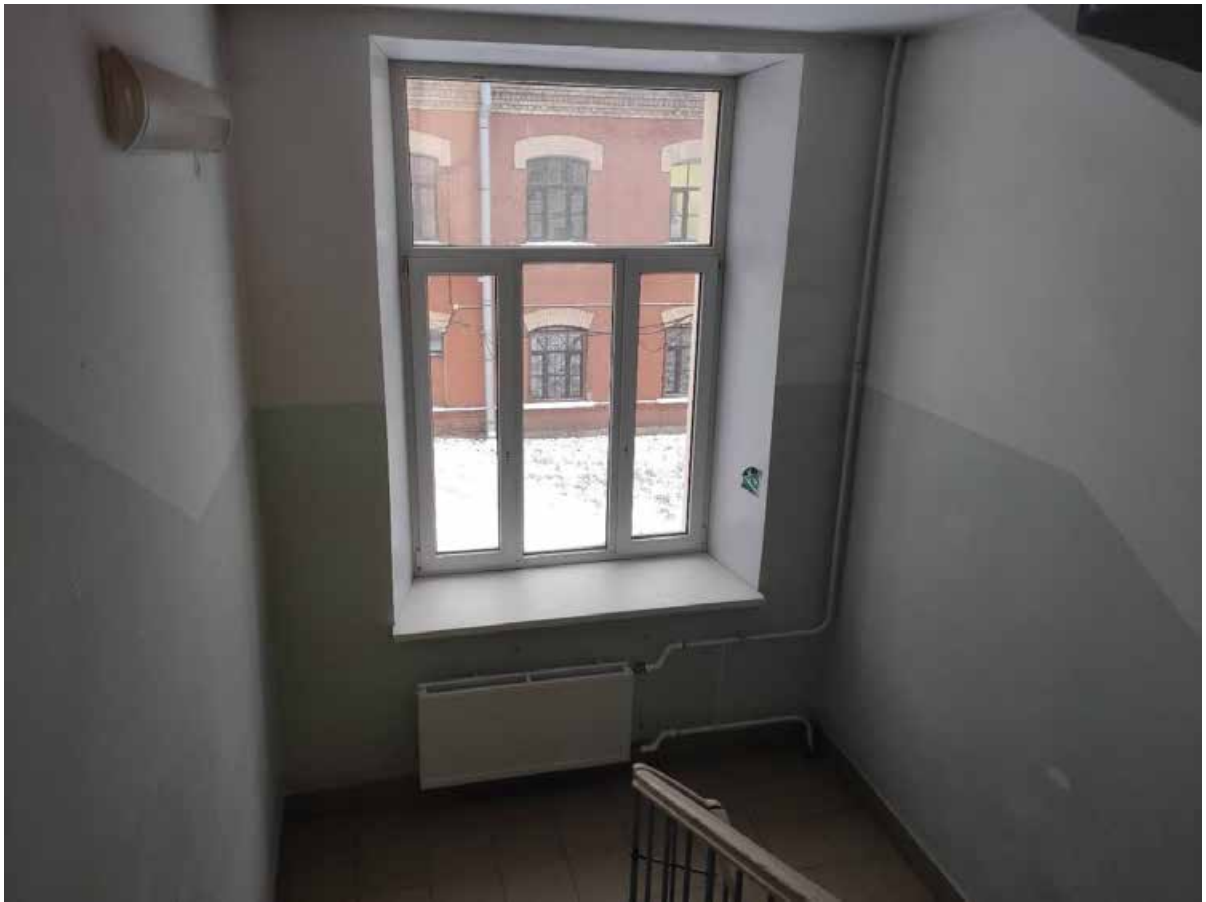
Илл. 149. Окно на лестнице в западном объеме здания.
