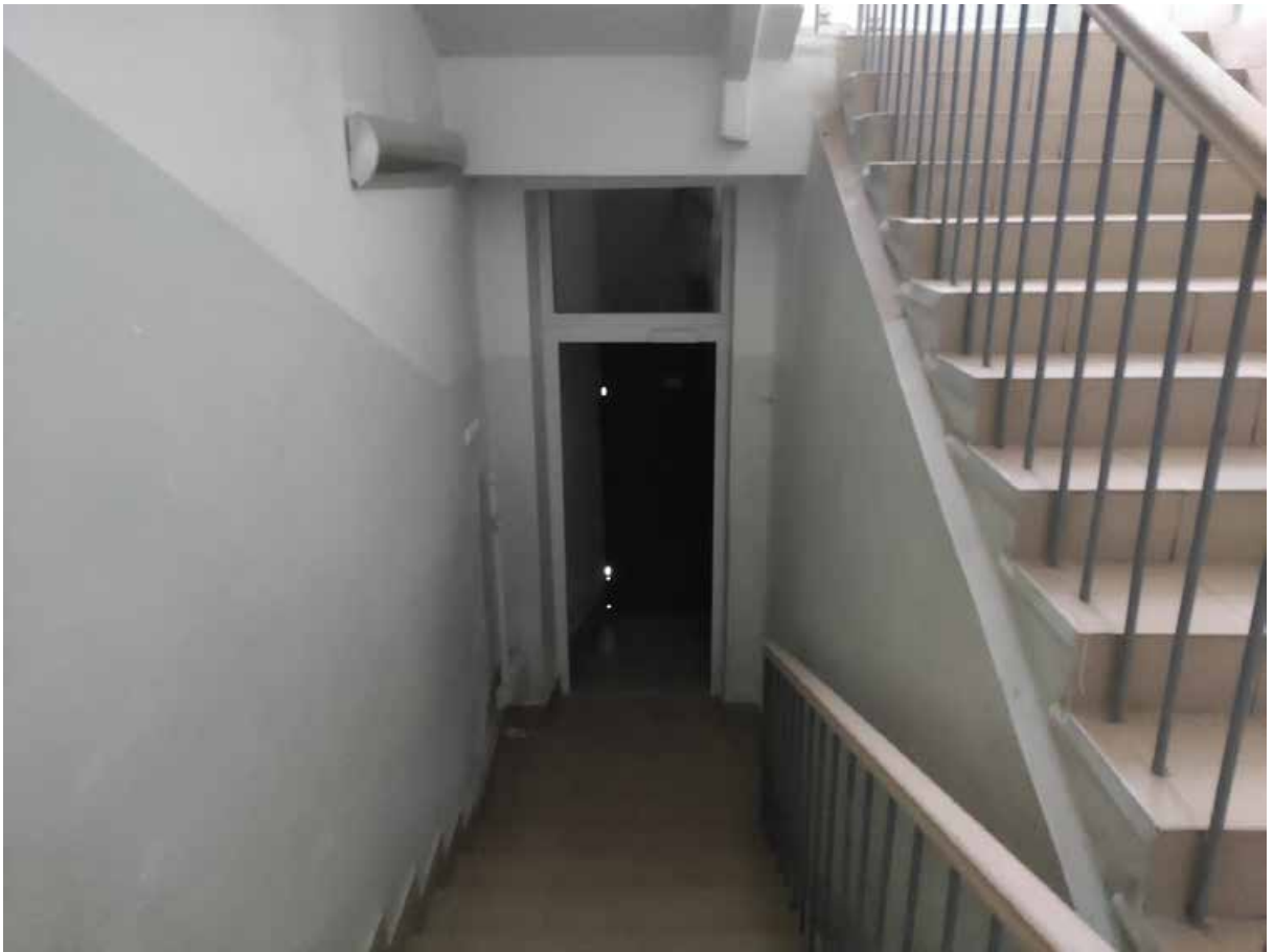
Илл. 157. Лестница в восточном объеме здания.
