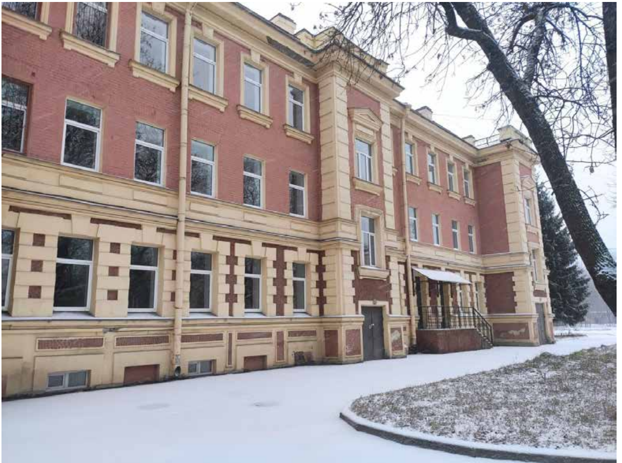
Илл. 8. Дворовый фасад здания.
