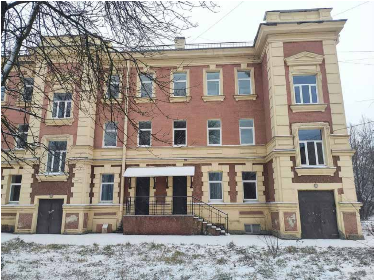
Илл. 11. Дворовый фасад здания.
