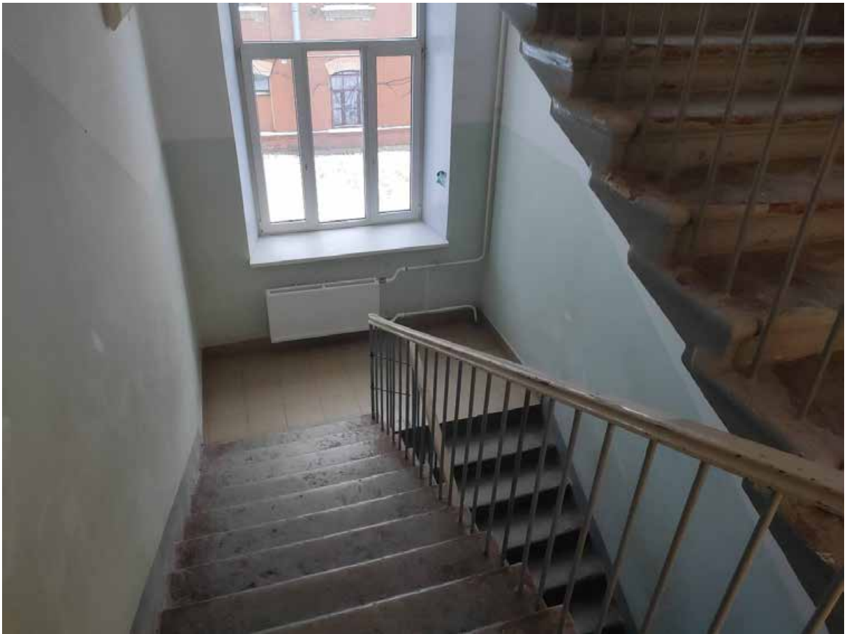
Илл. 151. Окно на лестнице в западном объеме здания.
