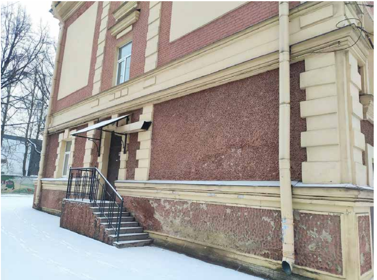
Илл. 7. Торцевой фасад здания.
