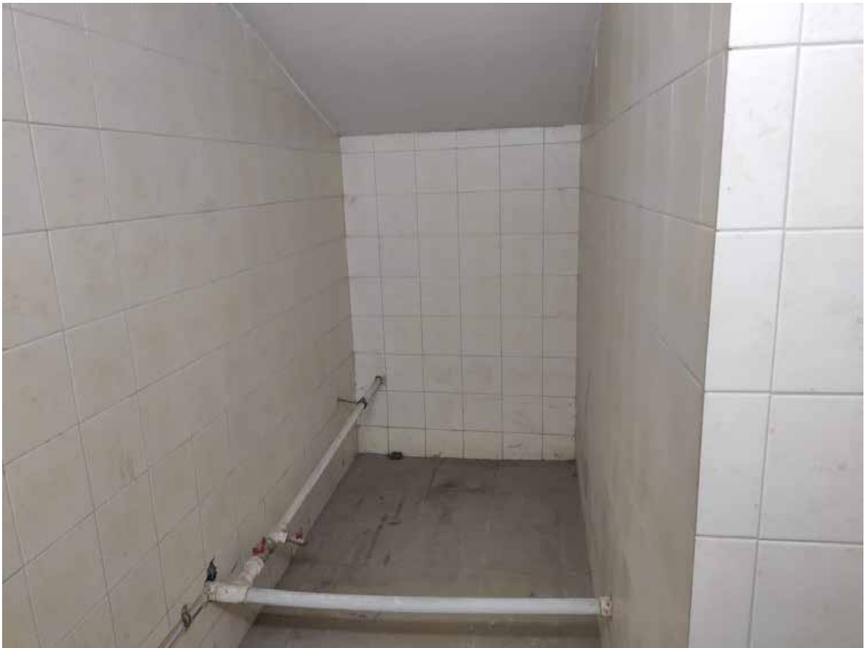
Илл. 17. Фрагмент подвального помещения в западной части здания.
