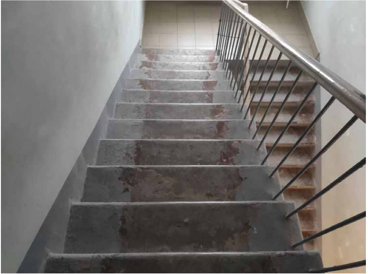
Илл. 154. Лестница в западном объеме здания.
