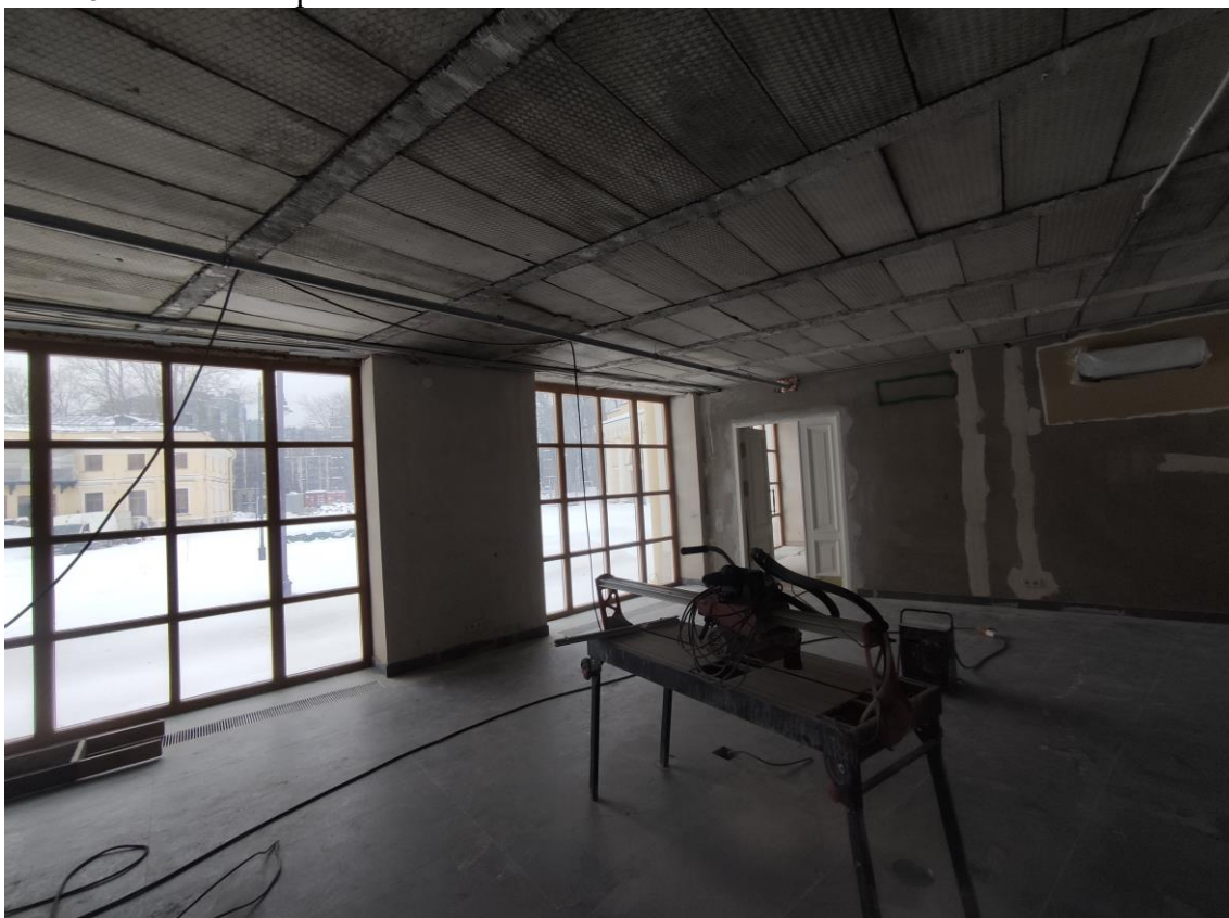
Фото 18. Объект культурного наследия федерального значения «Корпус служебный», расположенный по адресу: Санкт-Петербург, Уткин проспект, дом 2, литера Б. Общий вид пом. № 1.10 в отметке первого этажа.
