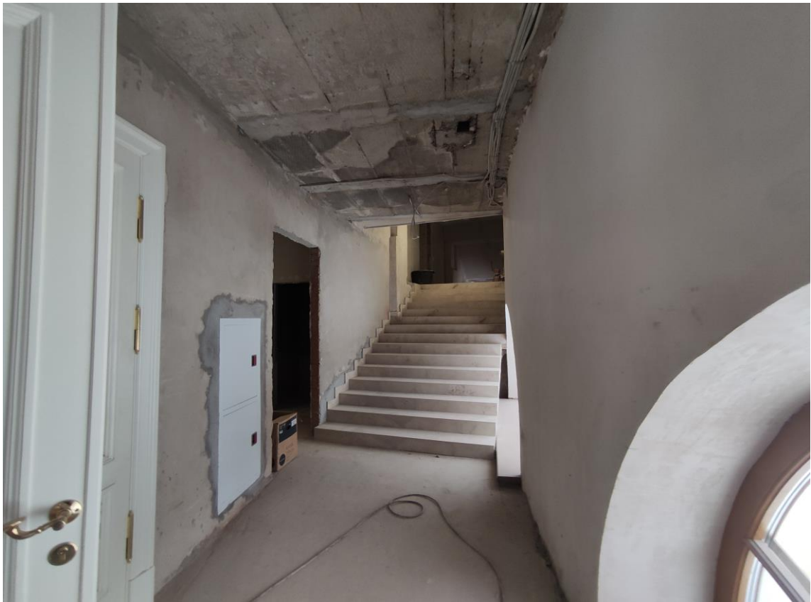
Фото 39. Объект культурного наследия федерального значения «Корпус служебный», расположенный по адресу: Санкт-Петербург, Уткин проспект, дом 2, литера Б. Общий вид пом. № 2.01 в отметке второго этажа.
