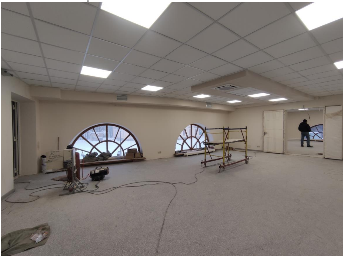
Фото 34. Объект культурного наследия федерального значения «Корпус служебный», расположенный по адресу: Санкт-Петербург, Уткин проспект, дом 2, литера Б. Общий вид пом. № 2.05 в отметке второго этажа.
