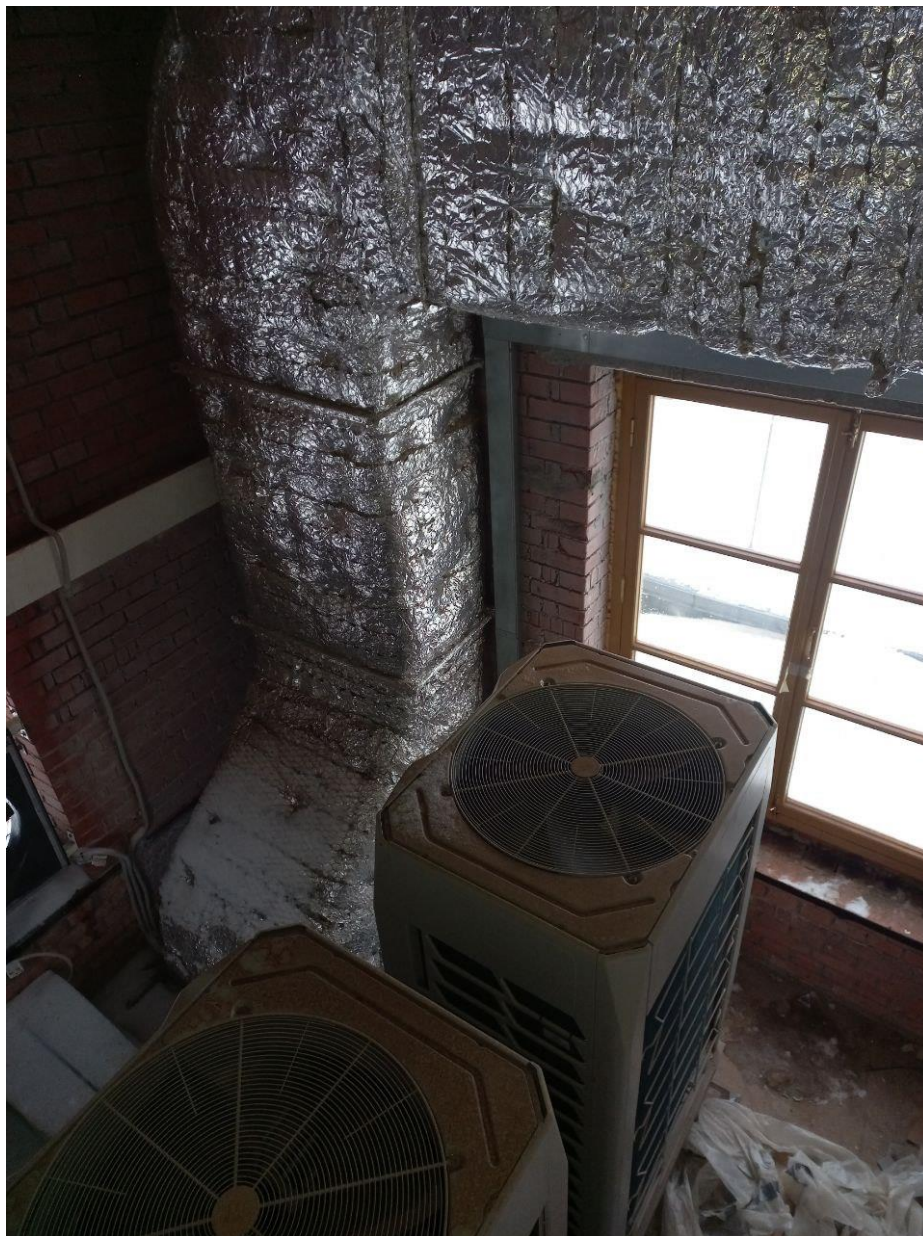
Фото 47. Объект культурного наследия федерального значения «Корпус служебный», расположенный по адресу: Санкт-Петербург, Уткин проспект, дом 2, литера Б. Фрагмент пом. № 3.01 (флагшточная башня) на отметке +8.560.
