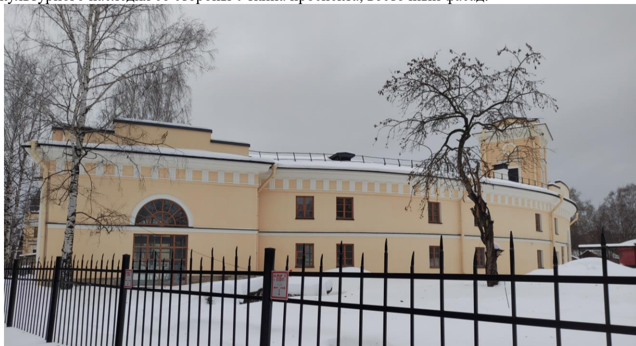
Фото 2. Объект культурного наследия федерального значения «Корпус служебный», расположенный по адресу: Санкт-Петербург, Уткин проспект, дом 2, литера Б, входящий в состав объекта культурного наследия федерального значения «Уткина дача», расположенного по адресу: г. Санкт-Петербург, Уткин проспект, дом 2, литеры А и Б 2 . Общий вид объекта культурного наследия со стороны Уткина проспекта, восточный фасад.
