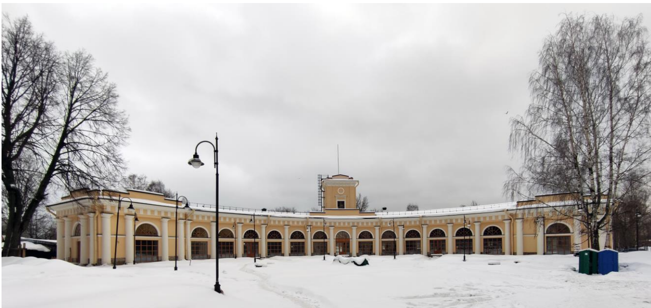
Фото 5. Объект культурного наследия федерального значения «Корпус служебный», расположенный по адресу: Санкт-Петербург, Уткин проспект, дом 2, литера Б. Общий вид западного фасада со стороны сада.
