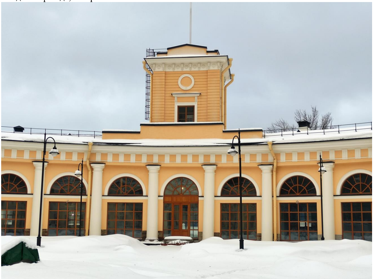
Фото 8. Объект культурного наследия федерального значения «Корпус служебный», расположенный по адресу: Санкт-Петербург, Уткин проспект, дом 2, литера Б. Фрагмент западного фасада, центральная часть.
