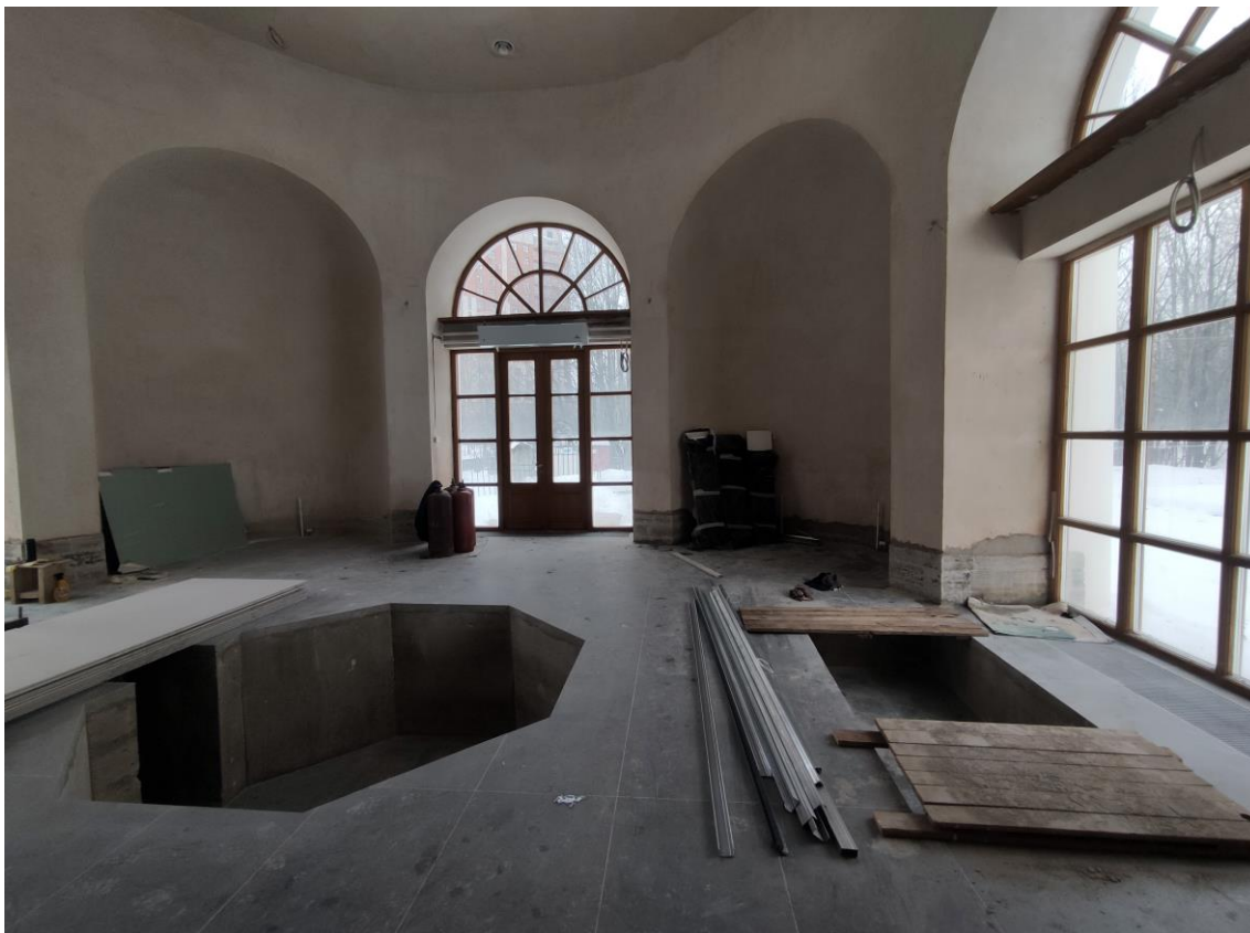
Фото 13. Объект культурного наследия федерального значения «Корпус служебный», расположенный по адресу: Санкт-Петербург, Уткин проспект, дом 2, литера Б. Общий вид пом. № 1.12 в отметке первого этажа.
