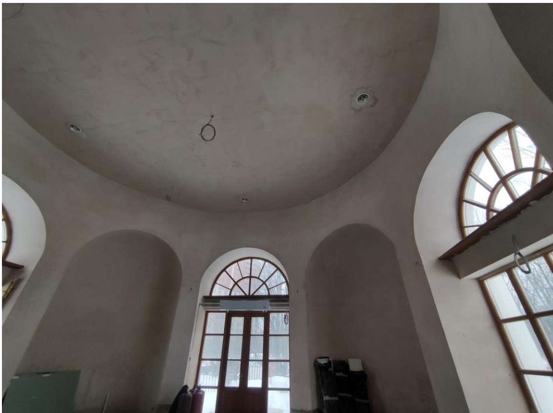
Фото 15. Объект культурного наследия федерального значения «Корпус служебный», расположенный по адресу: Санкт-Петербург, Уткин проспект, дом 2, литера Б. Общий вид пом. № 1.12 в отметке первого этажа.
