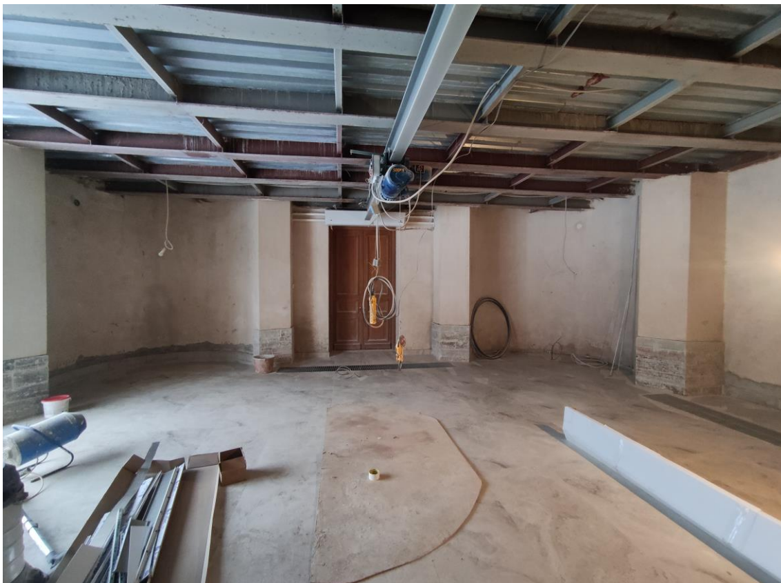
Фото 31. Объект культурного наследия федерального значения «Корпус служебный», расположенный по адресу: Санкт-Петербург, Уткин проспект, дом 2, литера Б. Общий вид пом. № 1.31 в отметке первого этажа.
