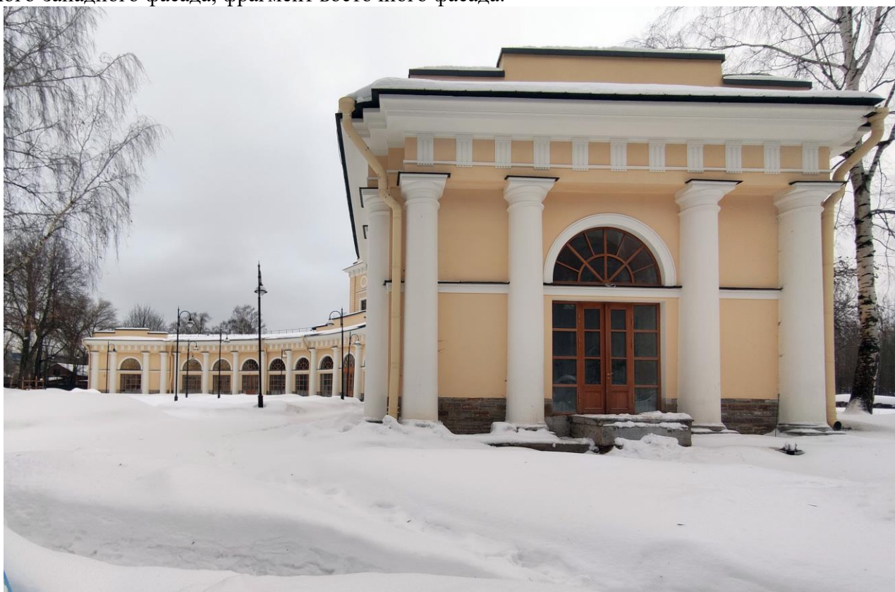
Фото 4. Объект культурного наследия федерального значения «Корпус служебный», расположенный по адресу: Санкт-Петербург, Уткин проспект, дом 2, литера Б. Общий вид юго-западного фасада, фрагмент западного фасада.
