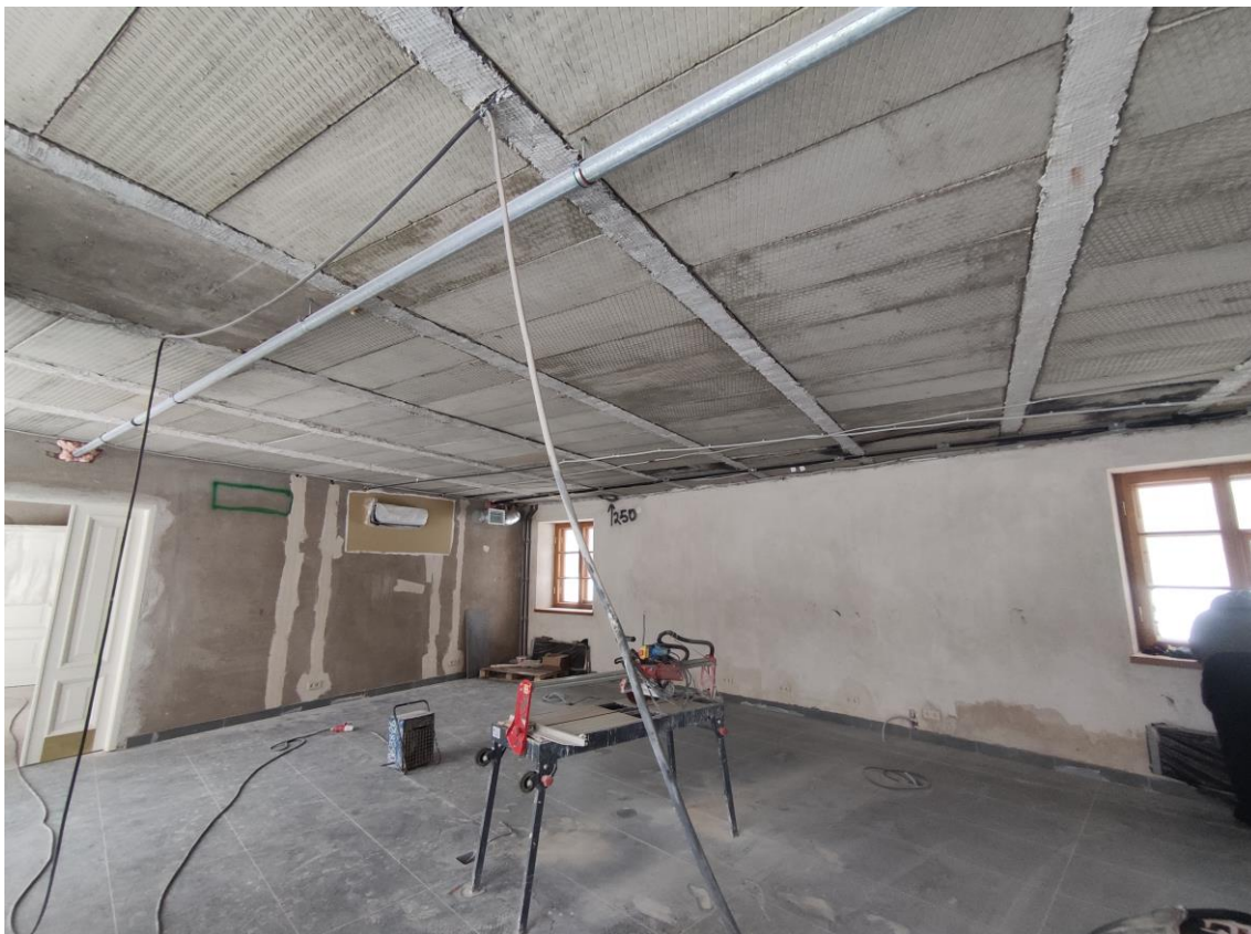
Фото 17. Объект культурного наследия федерального значения «Корпус служебный», расположенный по адресу: Санкт-Петербург, Уткин проспект, дом 2, литера Б. Общий вид пом. № 1.10 в отметке первого этажа.
