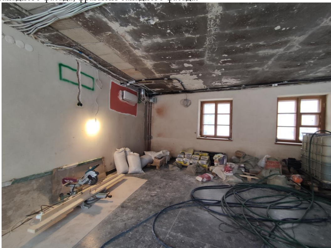
Фото 10. Объект культурного наследия федерального значения «Корпус служебный», расположенный по адресу: Санкт-Петербург, Уткин проспект, дом 2, литера Б. Общий вид пом. № 1.11 в отметке первого этажа 3 .
