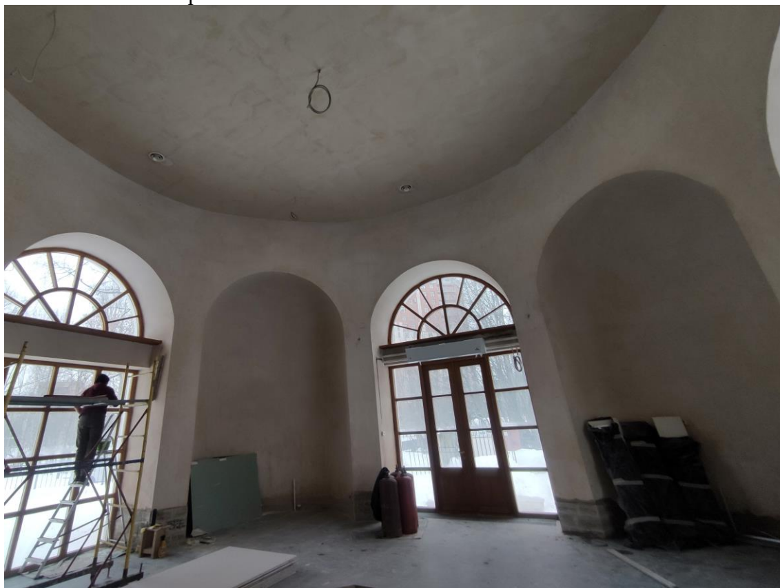
Фото 14. Объект культурного наследия федерального значения «Корпус служебный», расположенный по адресу: Санкт-Петербург, Уткин проспект, дом 2, литера Б. Общий вид пом. № 1.12 в отметке первого этажа.
