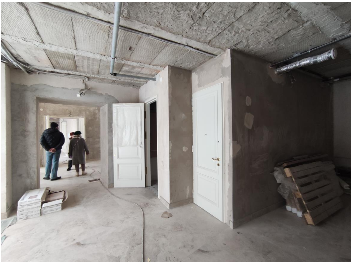
Фото 19. Объект культурного наследия федерального значения «Корпус служебный», расположенный по адресу: Санкт-Петербург, Уткин проспект, дом 2, литера Б. Общий вид пом. №№ 1.02, 1.04 в отметке первого этажа.
