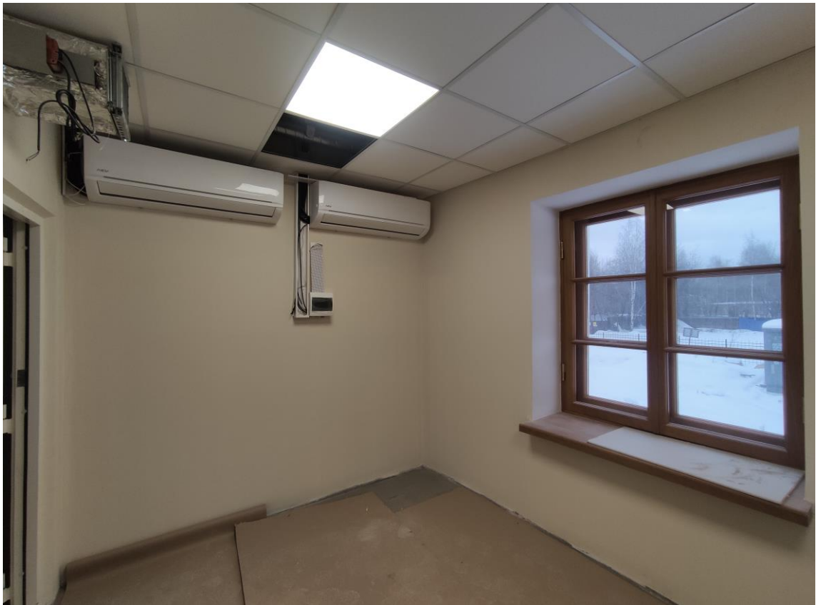
Фото 41. Объект культурного наследия федерального значения «Корпус служебный», расположенный по адресу: Санкт-Петербург, Уткин проспект, дом 2, литера Б. Общий вид пом. № 2.09 в отметке второго этажа.
