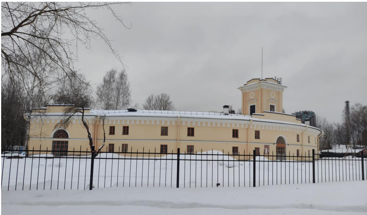
Фото 1. Объект культурного наследия федерального значения «Корпус служебный», расположенный по адресу: Санкт-Петербург, Уткин проспект, дом 2, литера Б, входящий в состав объекта культурного наследия федерального значения «Уткина дача», расположенного по адресу: г. Санкт-Петербург, Уткин проспект, дом 2, литеры А и Б 1 . Общий вид объекта культурного наследия со стороны Уткина проспекта, восточный фасад.
