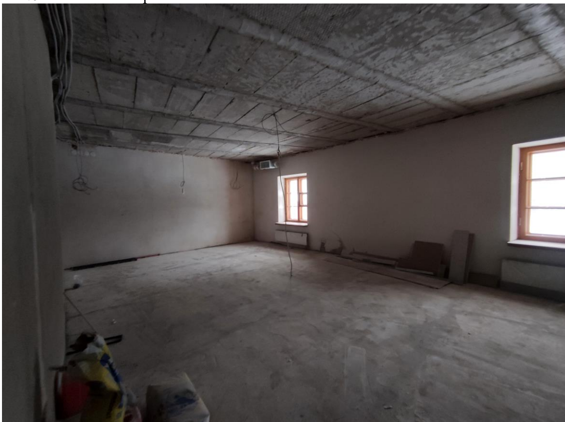
Фото 38. Объект культурного наследия федерального значения «Корпус служебный», расположенный по адресу: Санкт-Петербург, Уткин проспект, дом 2, литера Б. Общий вид пом. № 2.06 в отметке второго этажа.
