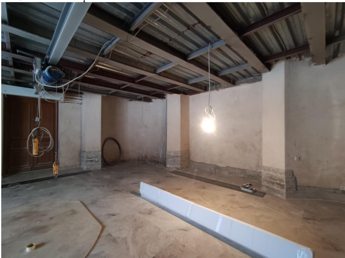
Фото 32. Объект культурного наследия федерального значения «Корпус служебный», расположенный по адресу: Санкт-Петербург, Уткин проспект, дом 2, литера Б. Общий вид пом. № 1.31 в отметке первого этажа.
