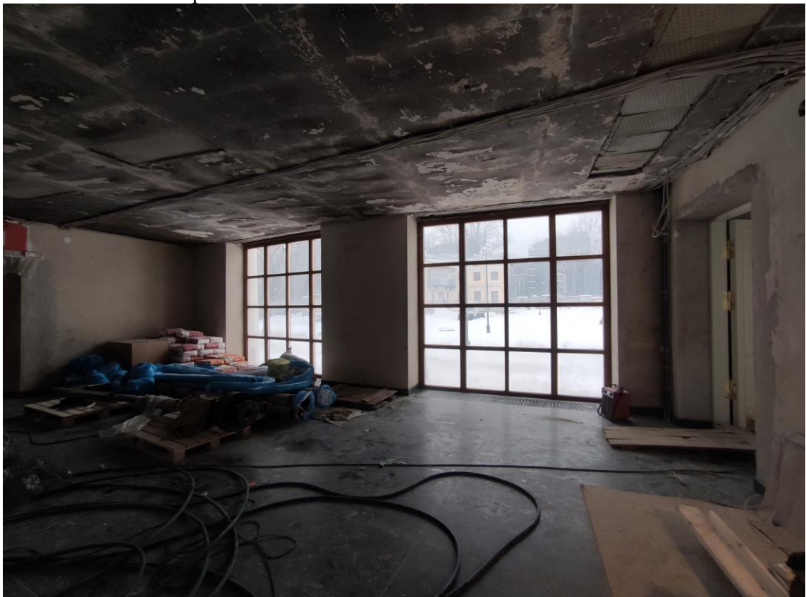
Фото 12. Объект культурного наследия федерального значения «Корпус служебный», расположенный по адресу: Санкт-Петербург, Уткин проспект, дом 2, литера Б. Общий вид пом. № 1.11 в отметке первого этажа.
