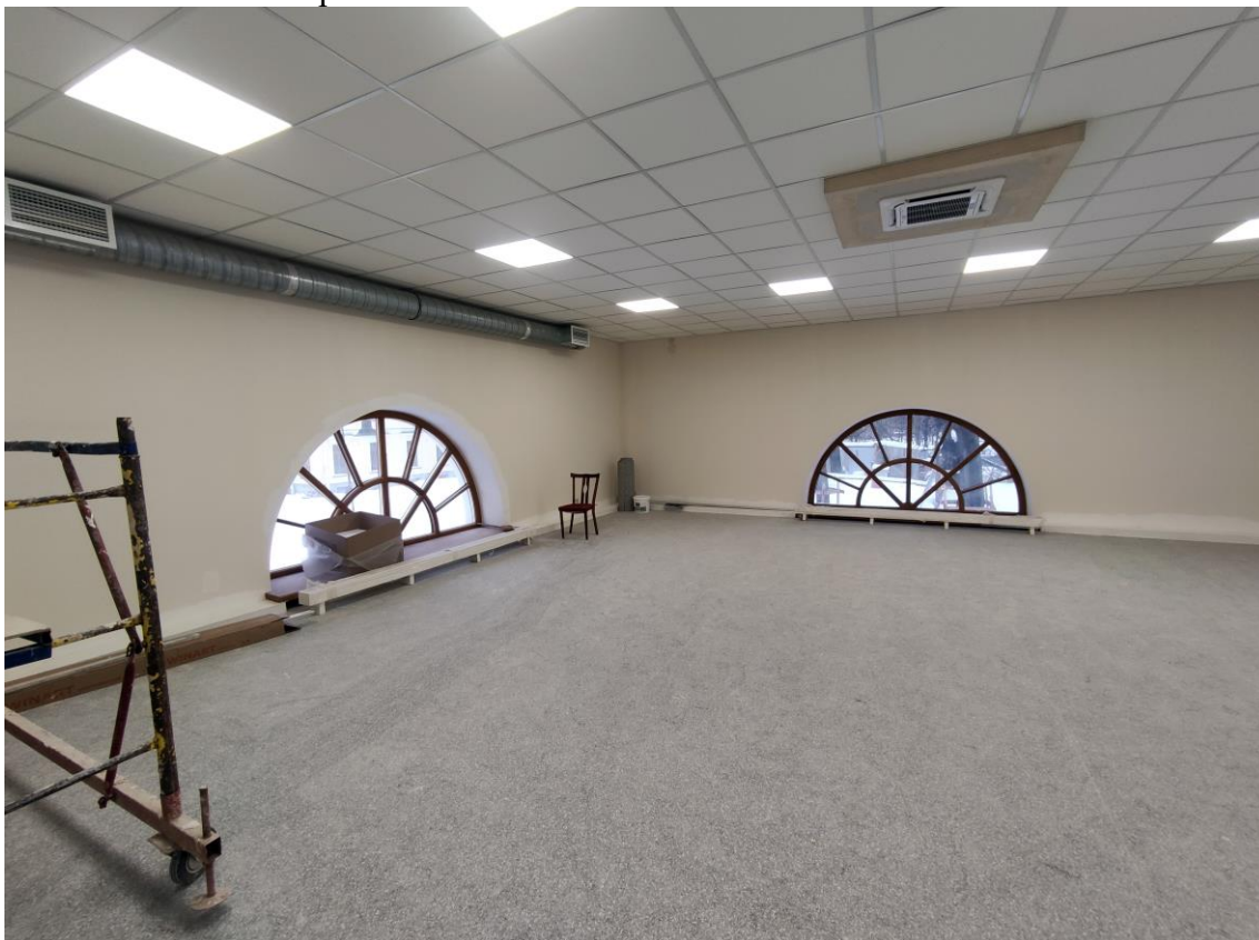
Фото 36. Объект культурного наследия федерального значения «Корпус служебный», расположенный по адресу: Санкт-Петербург, Уткин проспект, дом 2, литера Б. Общий вид пом. № 2.04 в отметке второго этажа.
