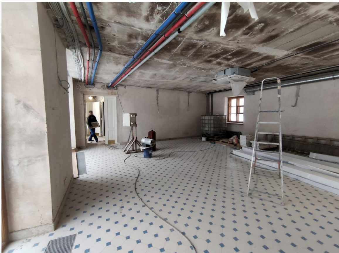
Фото 25. Объект культурного наследия федерального значения «Корпус служебный», расположенный по адресу: Санкт-Петербург, Уткин проспект, дом 2, литера Б. Общий вид пом. №№ 1.13, 1.14 в отметке первого этажа.
