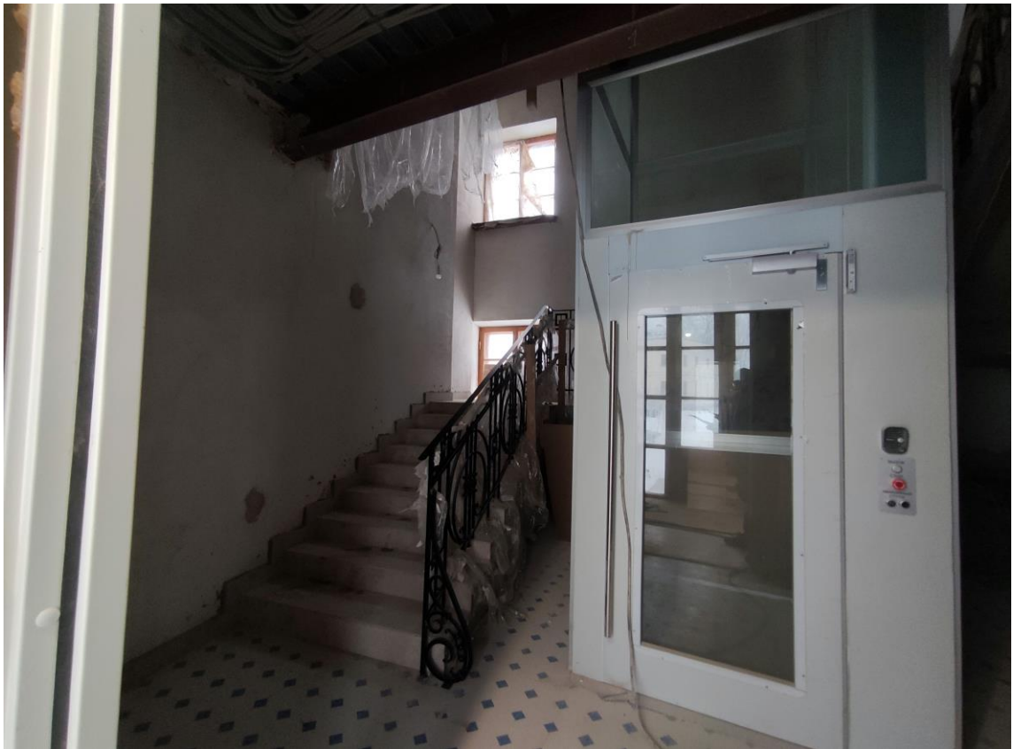
Фото 27. Объект культурного наследия федерального значения «Корпус служебный», расположенный по адресу: Санкт-Петербург, Уткин проспект, дом 2, литера Б. Общий вид пом. № 1.07 в отметке первого этажа.
