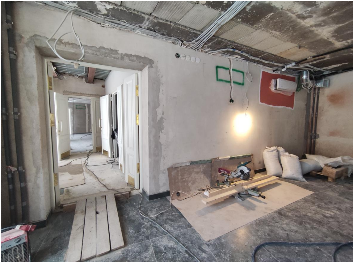
Фото 11. Объект культурного наследия федерального значения «Корпус служебный», расположенный по адресу: Санкт-Петербург, Уткин проспект, дом 2, литера Б. Общий вид пом. № 1.11 в отметке первого этажа.
