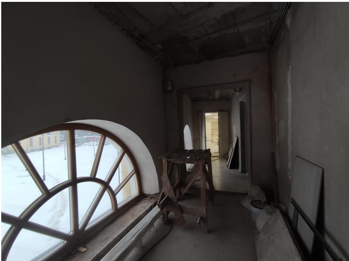
Фото 37. Объект культурного наследия федерального значения «Корпус служебный», расположенный по адресу: Санкт-Петербург, Уткин проспект, дом 2, литера Б. Общий вид пом. № 2.01 в отметке второго этажа.
