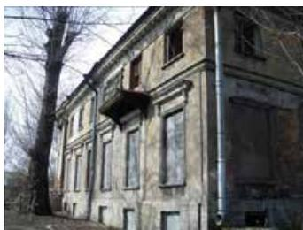
балкон - местоположение, габариты, два чугунных кронштейна и балконная плита;
