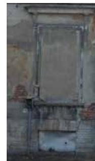
междуэтажная профилированная тяга; оформление оконных проемов в уровне 2-го этажа наружными подоконными досками из известняка;
