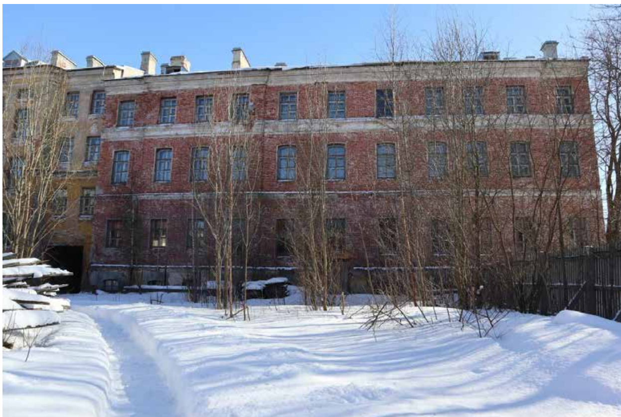
Фото 9. Северо-западный (дворовой) фасад. Общий вид.
