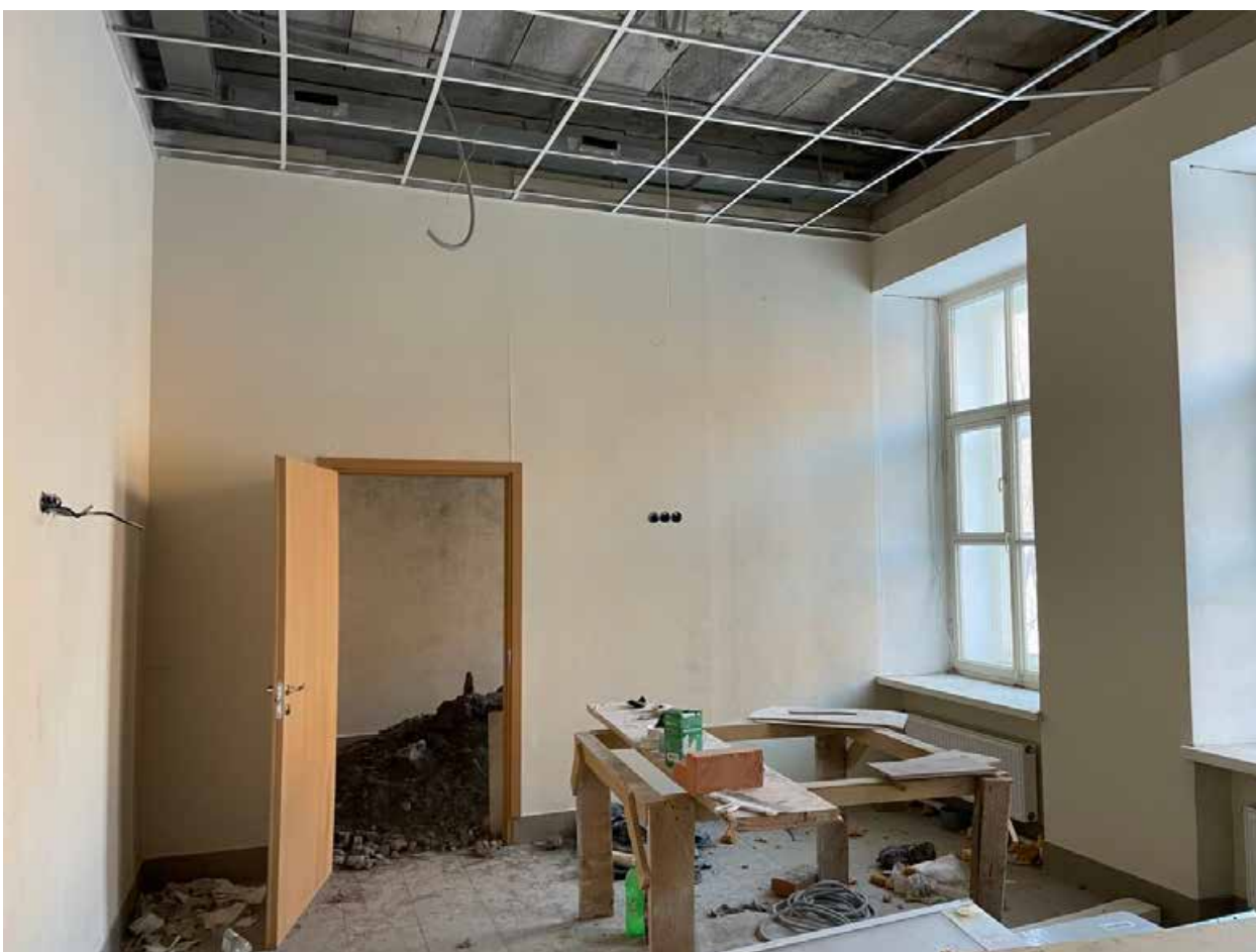
Фото 1.20. 1 этаж. Помещение по западному фасаду.
