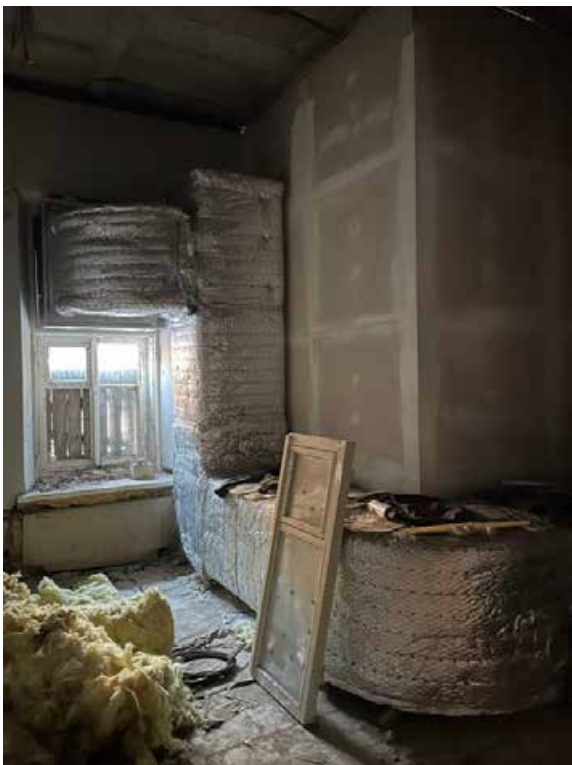
Фото 1.11. 1 этаж. Помещение по западному фасаду
