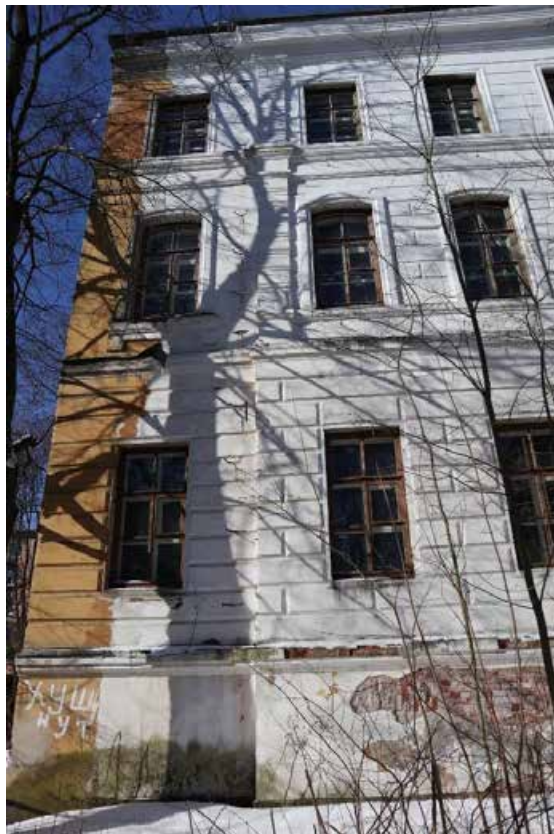
Фото 6. Юго-восточный фасад здания. Фрагмент.
