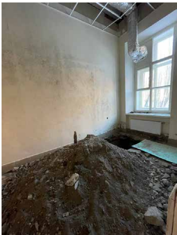
Фото 1.21. 1 этаж. Помещение по западному фасаду.
