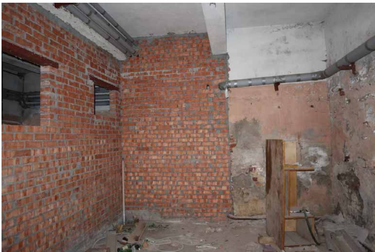
Фото п.4. Подвал, помещение 1.
