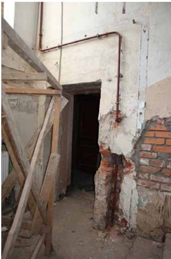
Фото 1.7. 1 этаж, лестничная площадка, лестница III.
