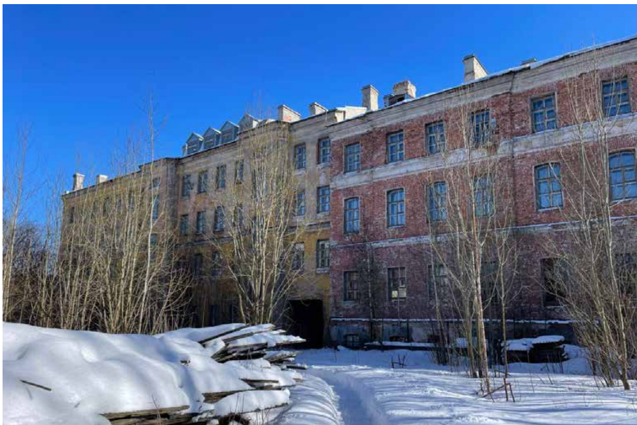
Фото 9. Северо-западный (дворовой) фасад. Общий вид.
