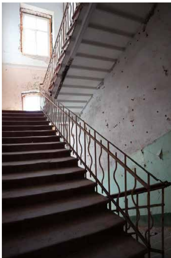
Фото 2.27. 2 этаж, лестница II.
