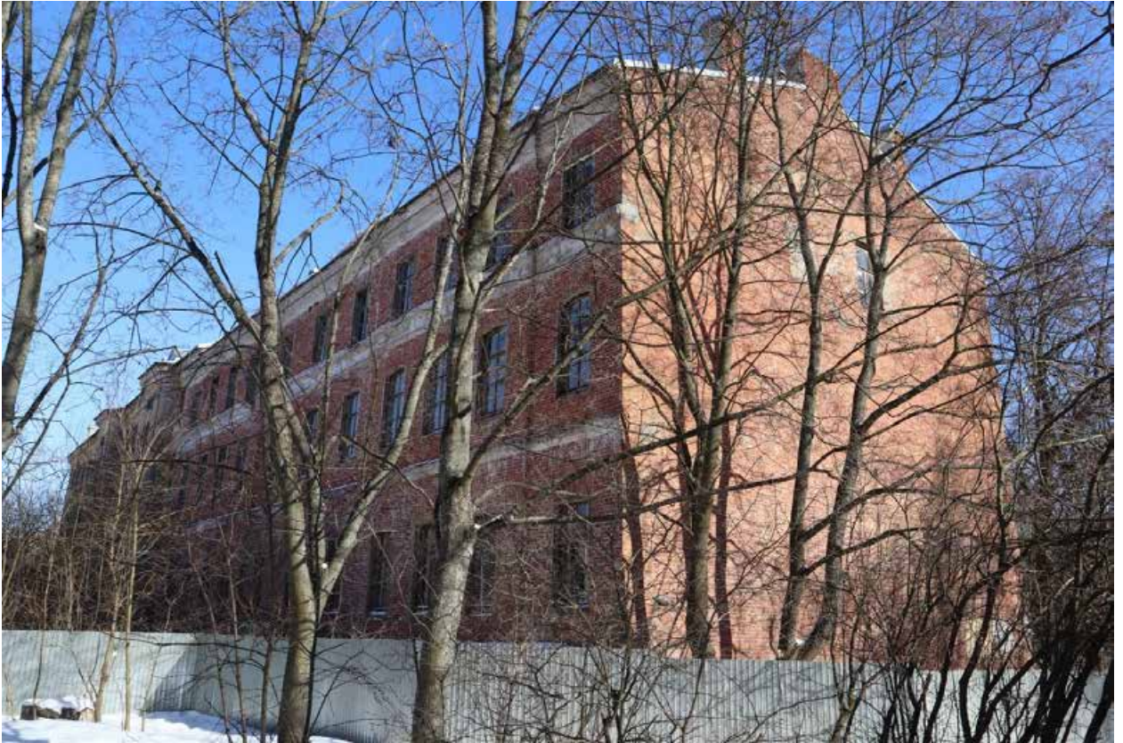
Фото 17. Юго-западный (торцевой) фасад. Общий вид.
