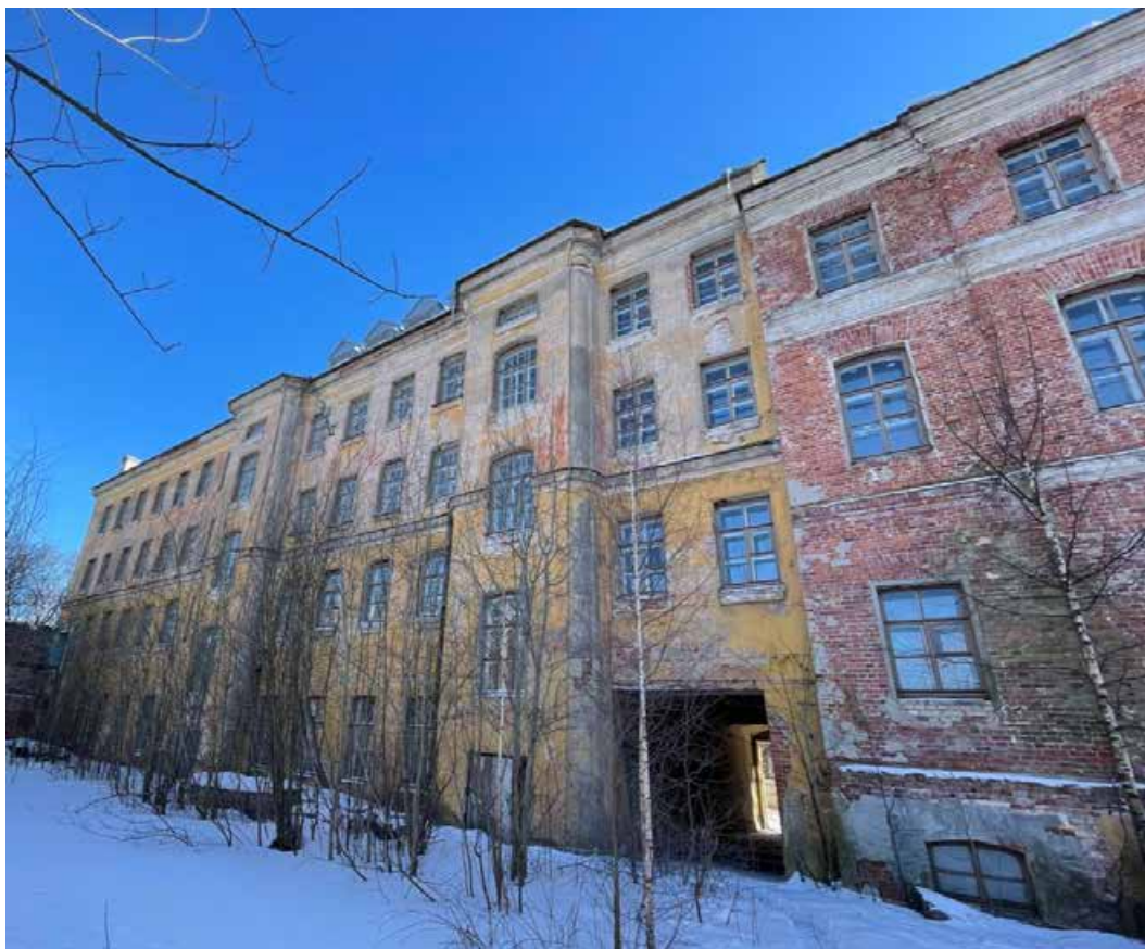
Фото 11. Северо-западный (дворовой) фасад. Общий вид
