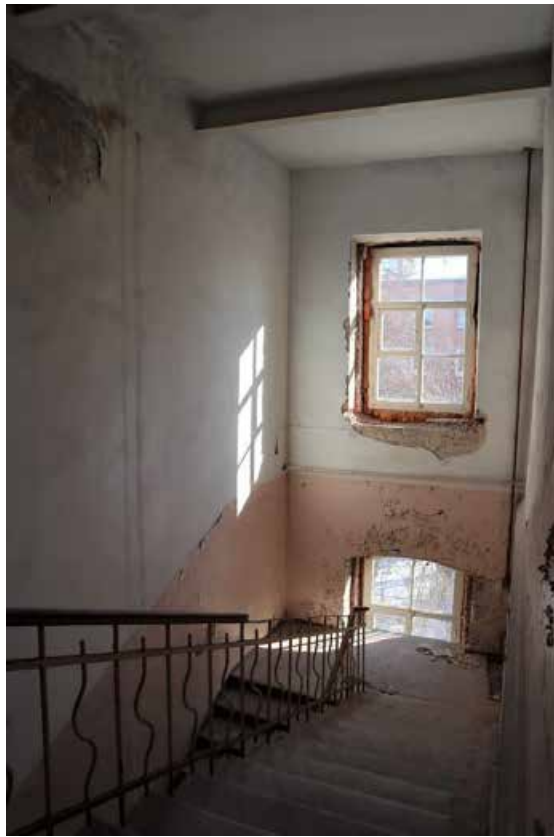
Фото 3.5. 3 этаж, лестница II.
