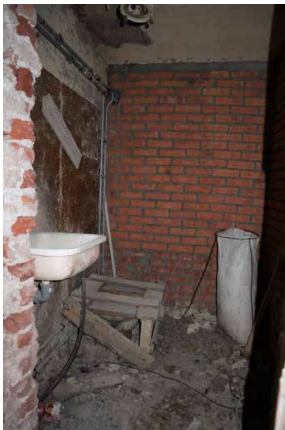
Фото п.7. Подвал, помещение 3.
