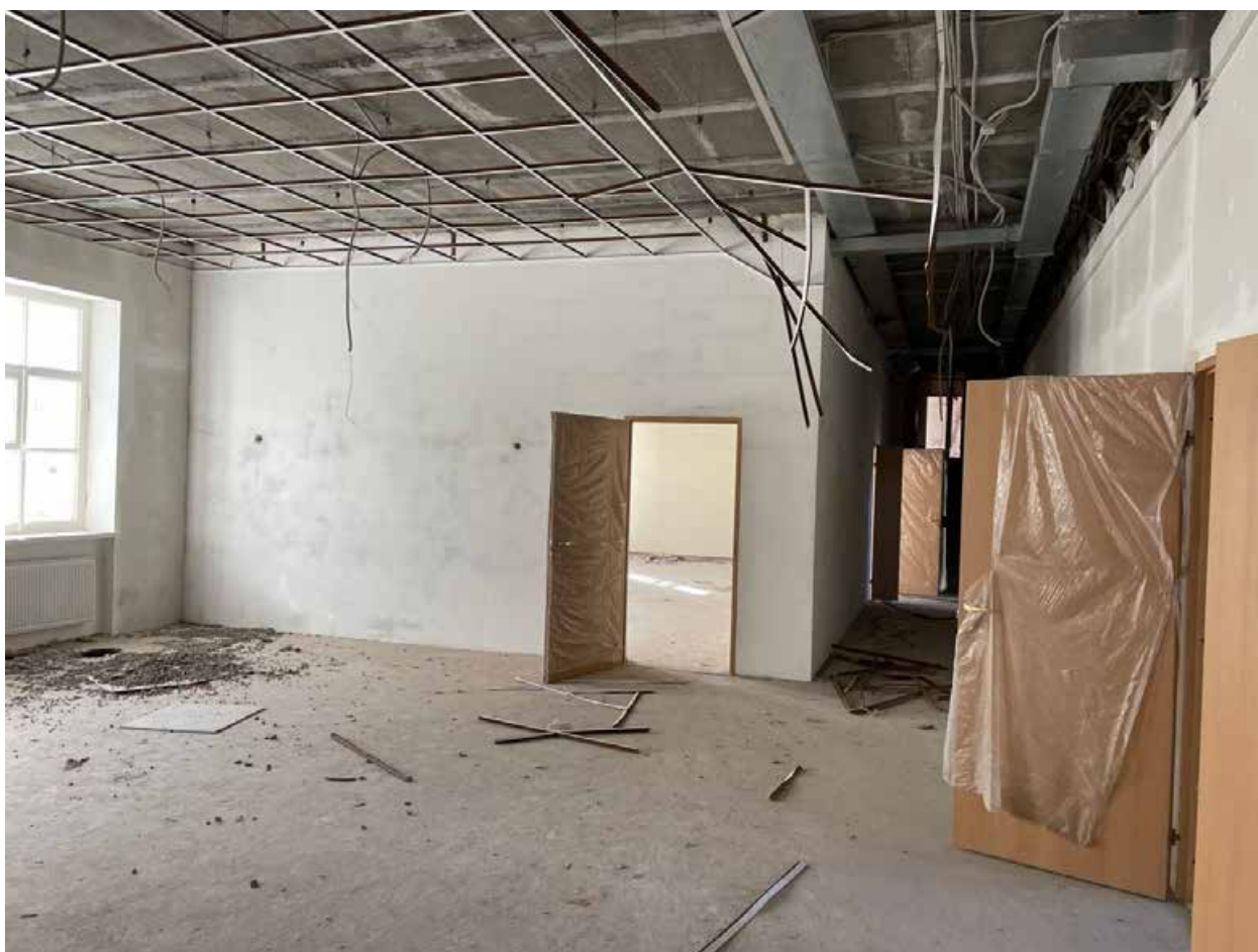
Фото 2.4. 2 этаж. Помещение по восточному фасаду
