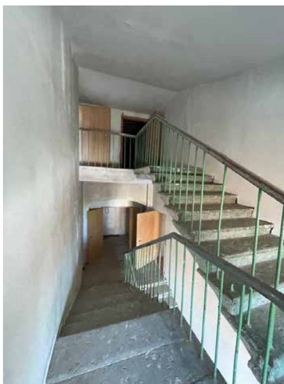
Фото 5.1. Лестница в южной части.
