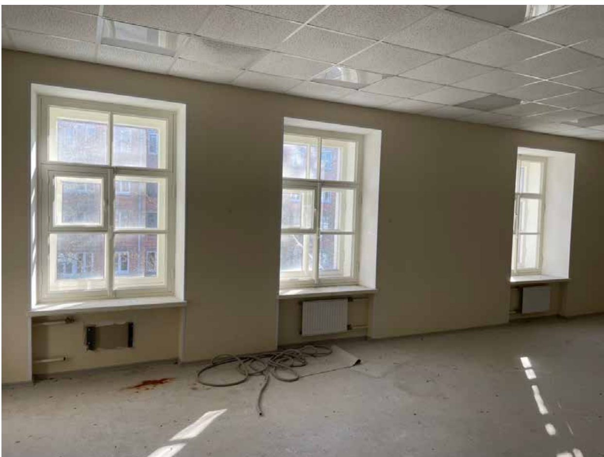
Фото 3.3. 3 этаж. Помещение по восточному фасаду.
