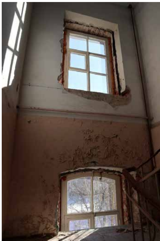
Фото 3.2. 3 этаж, лестничная площадка, лестница II.
