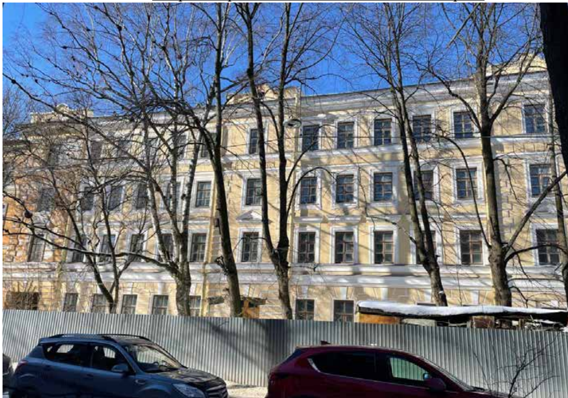
Фото 1. Юго-восточный фасад здания
