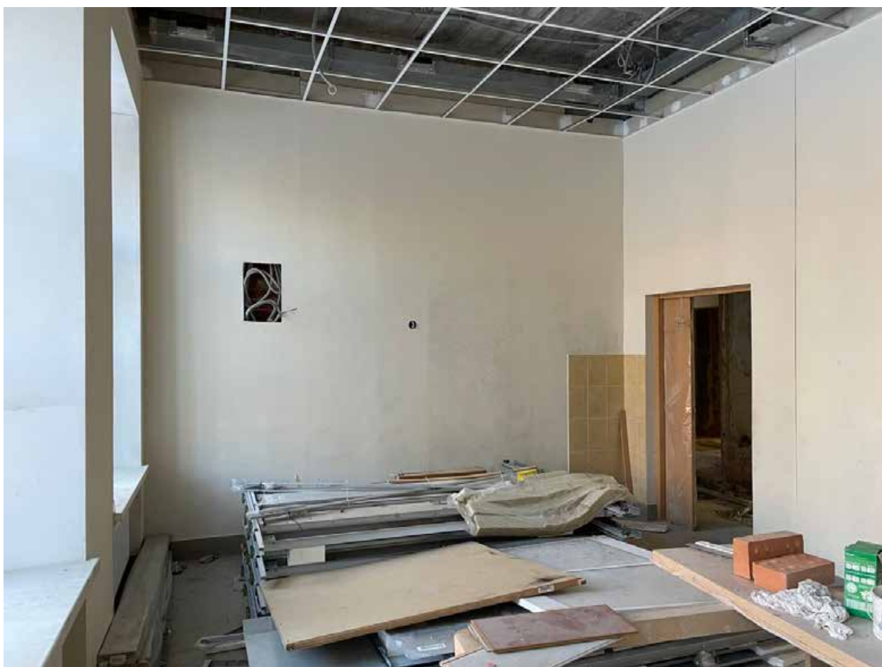
Фото 1.22. 1 этаж. Помещение по западному фасаду.
