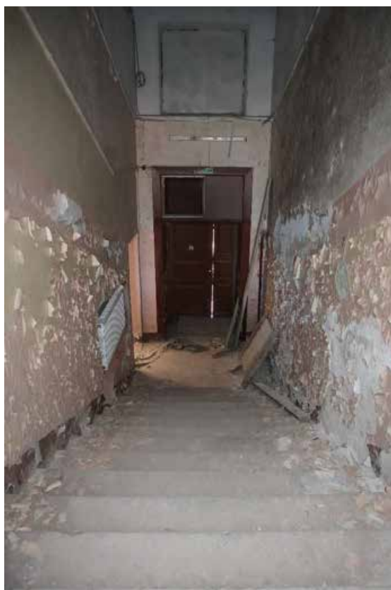
Фото 1.34. 1 этаж, лестница II.
