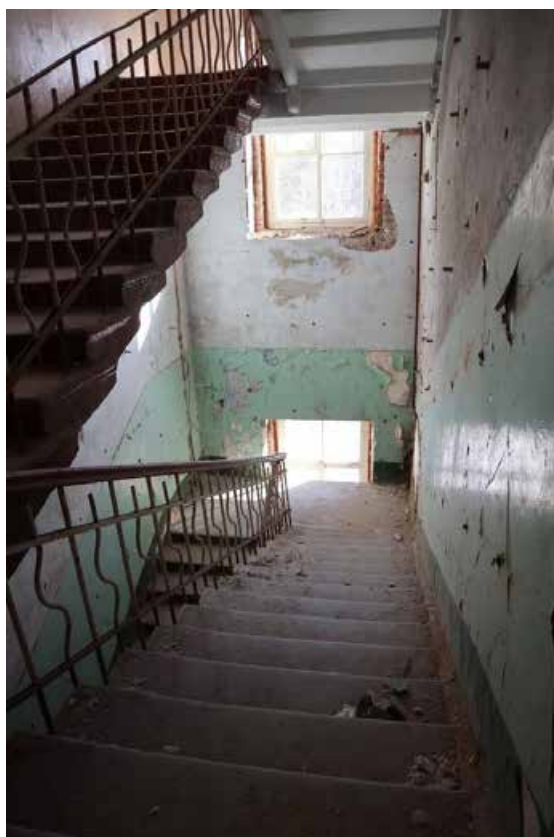
Фото 2.28. 2 этаж, лестница II.
