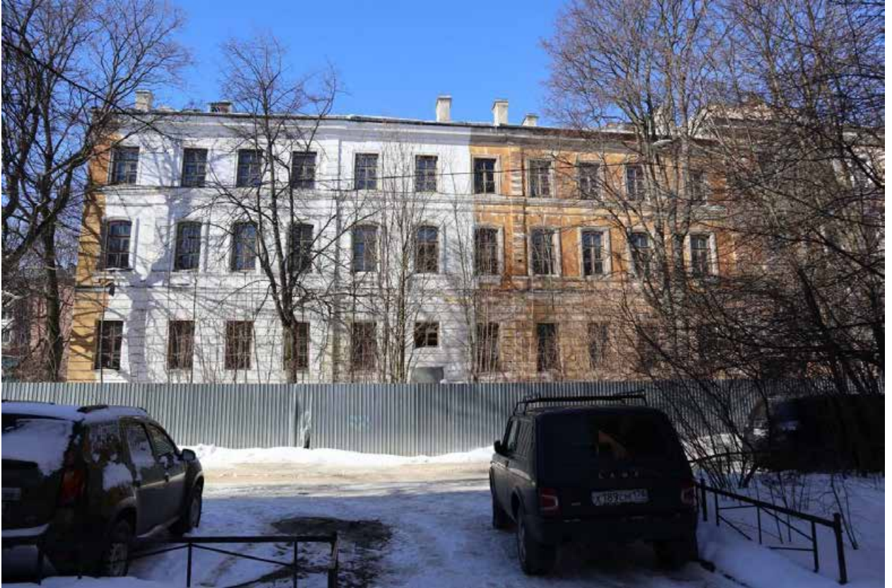
Фото 1. Юго-восточный фасад здания.
