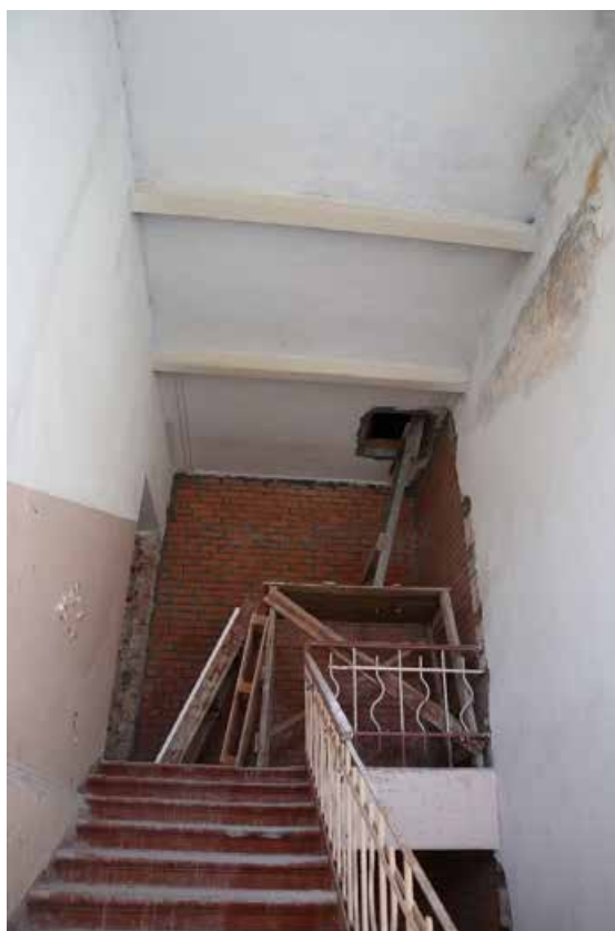
Фото 3.4. 3 этаж, лестница II.
