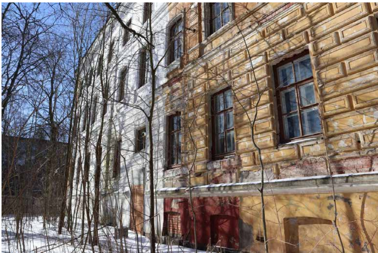
Фото 3. Юго-восточный фасад здания. Фрагмент.
