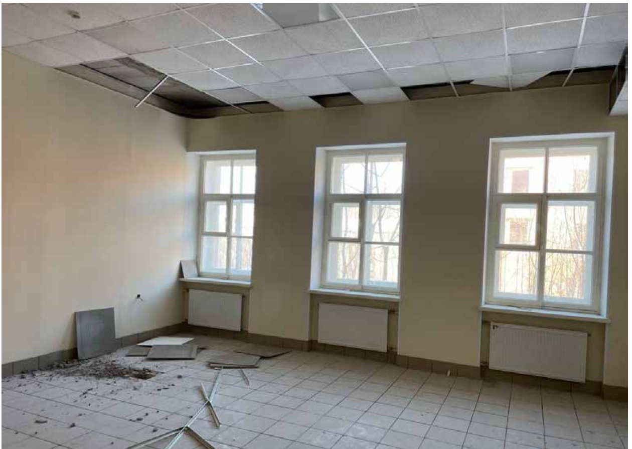
Фото 2.14. 2 этаж. Помещения по западному фасаду.
