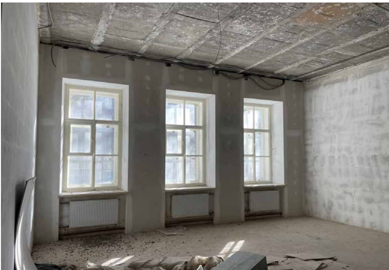
Фото 1.16. 1 этаж. Помещения по восточному фасаду.
