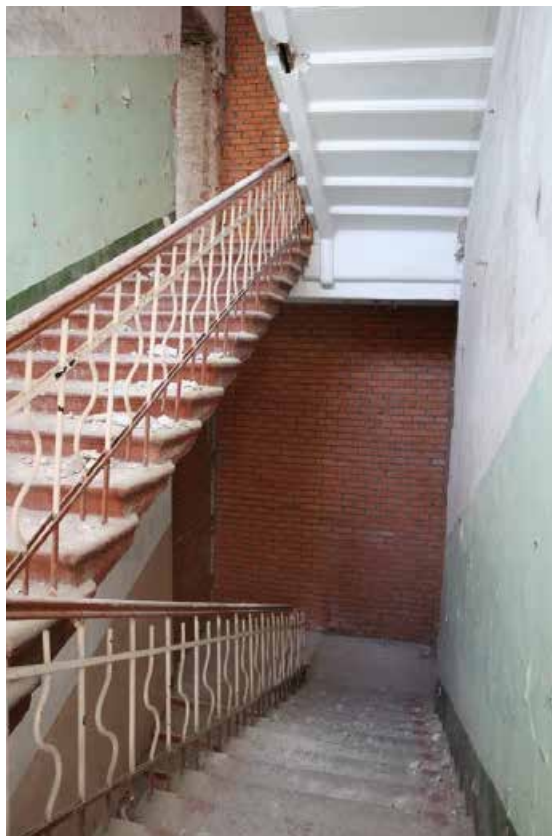
Фото 1.1. 1 этаж, лестница III.
