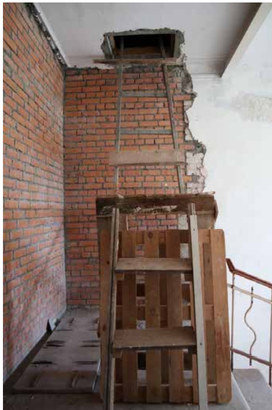
Фото 3.6. 3 этаж, лестничная площадка, лестница II.
