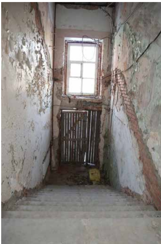
Фото 1.36. 1 этаж, лестница I.
