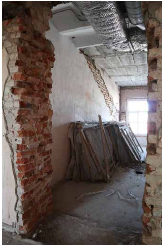
Фото 3.23. 3 этаж, лестничная клетка лестницы I*.
