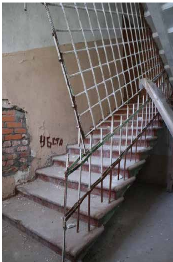
Фото 1.5. 1 этаж, лестница III.
