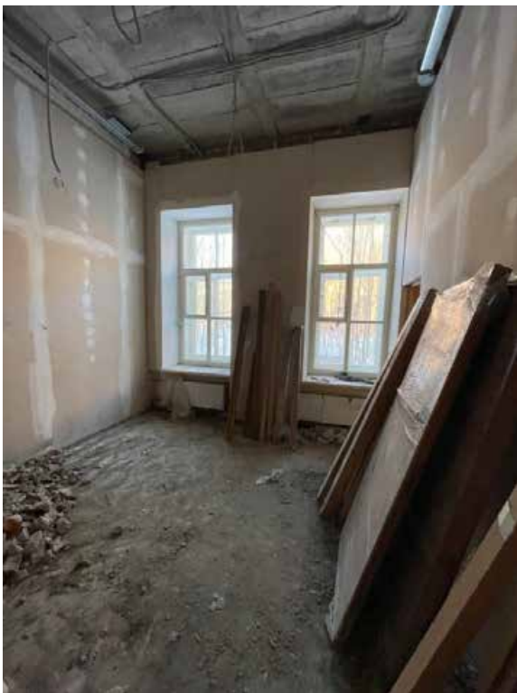
Фото 1.9, 1.10. 1 этаж. Помещения по западному фасаду.
