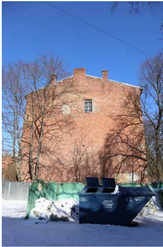
Фото 15. Юго-западный (торцевой) фасад. Общий вид.
