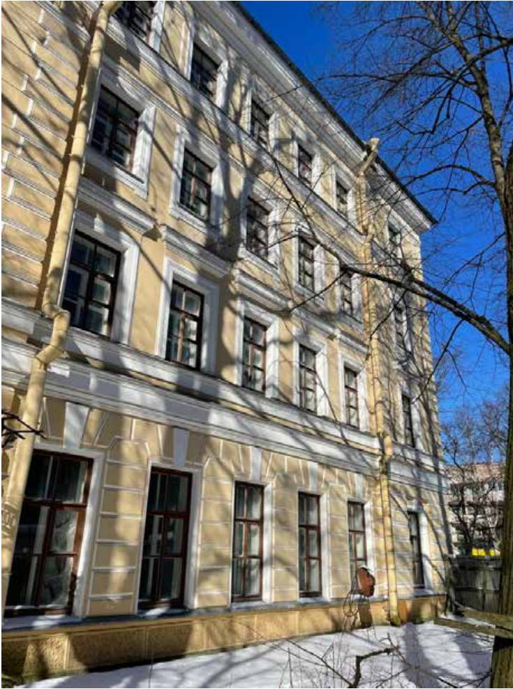
Фото 3. Юго-восточный фасад здания. Фрагмент.
