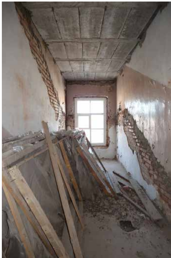
Фото 3.24. 3 этаж, лестничная клетка лестницы I*.
