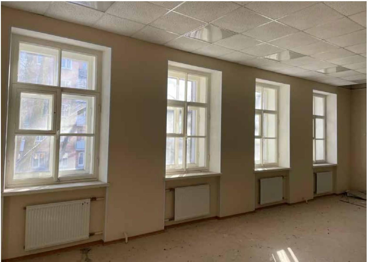
Фото 2.13. 2 этаж. Помещения по восточному фасаду.
