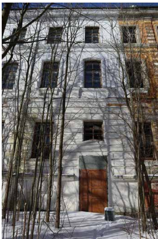
Фото 4. Юго-восточный фасад здания. Фрагмент.
