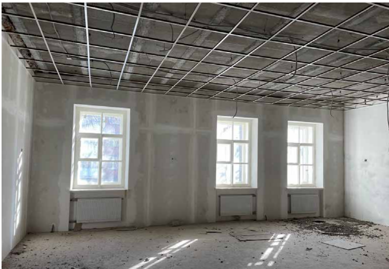
Фото 2.3. 2 этаж. Помещение по восточному фасаду.
