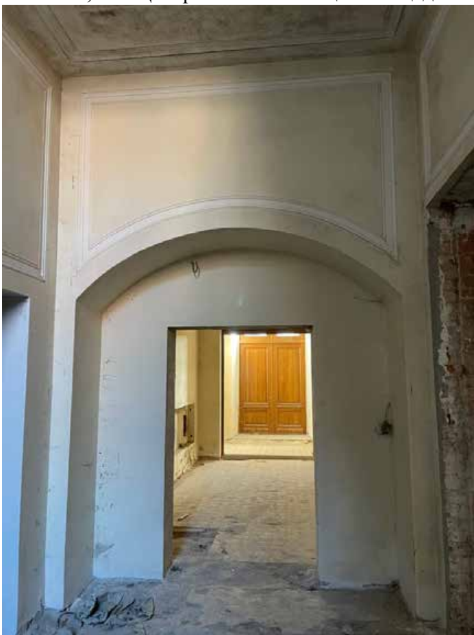
Фото 1.4. Площадка 1 этажа центральной лестницы.
