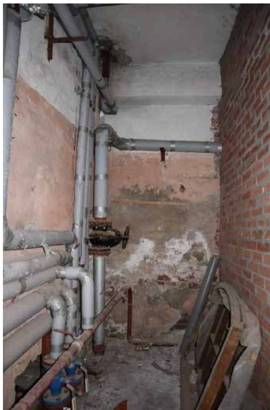
Фото п.2. Подвал, помещение 1.
