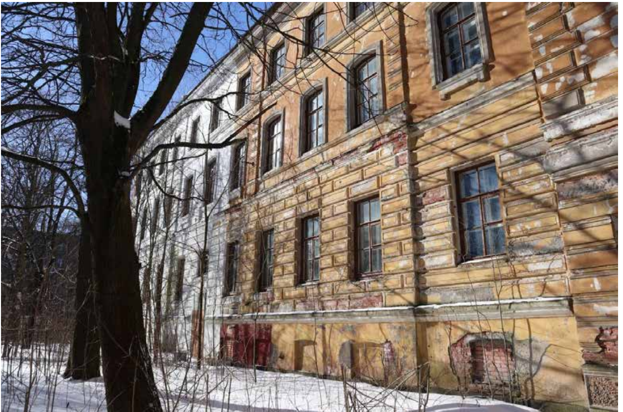
Фото 2. Юго-восточный фасад здания. Фрагмент.
