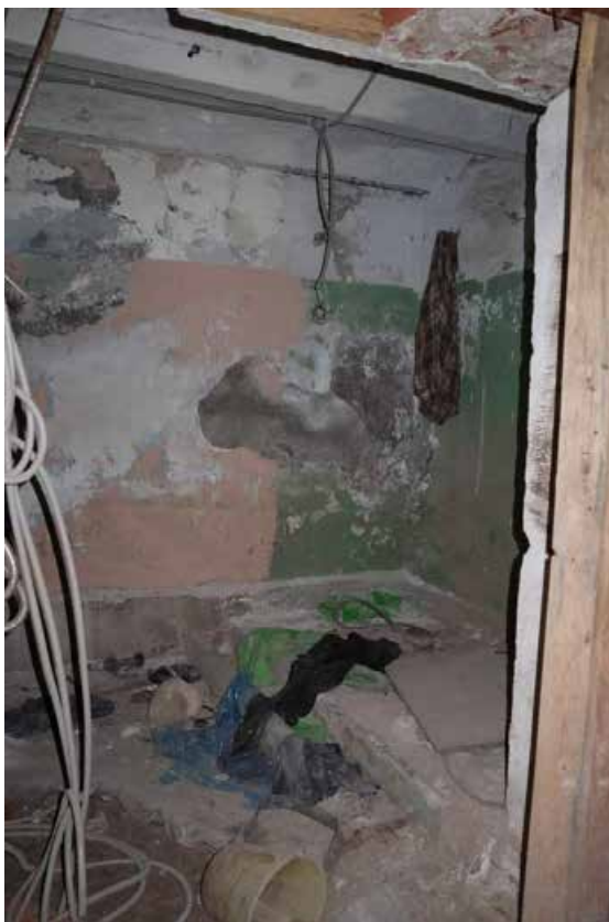
Фото п.6. Подвал, помещение 5.
