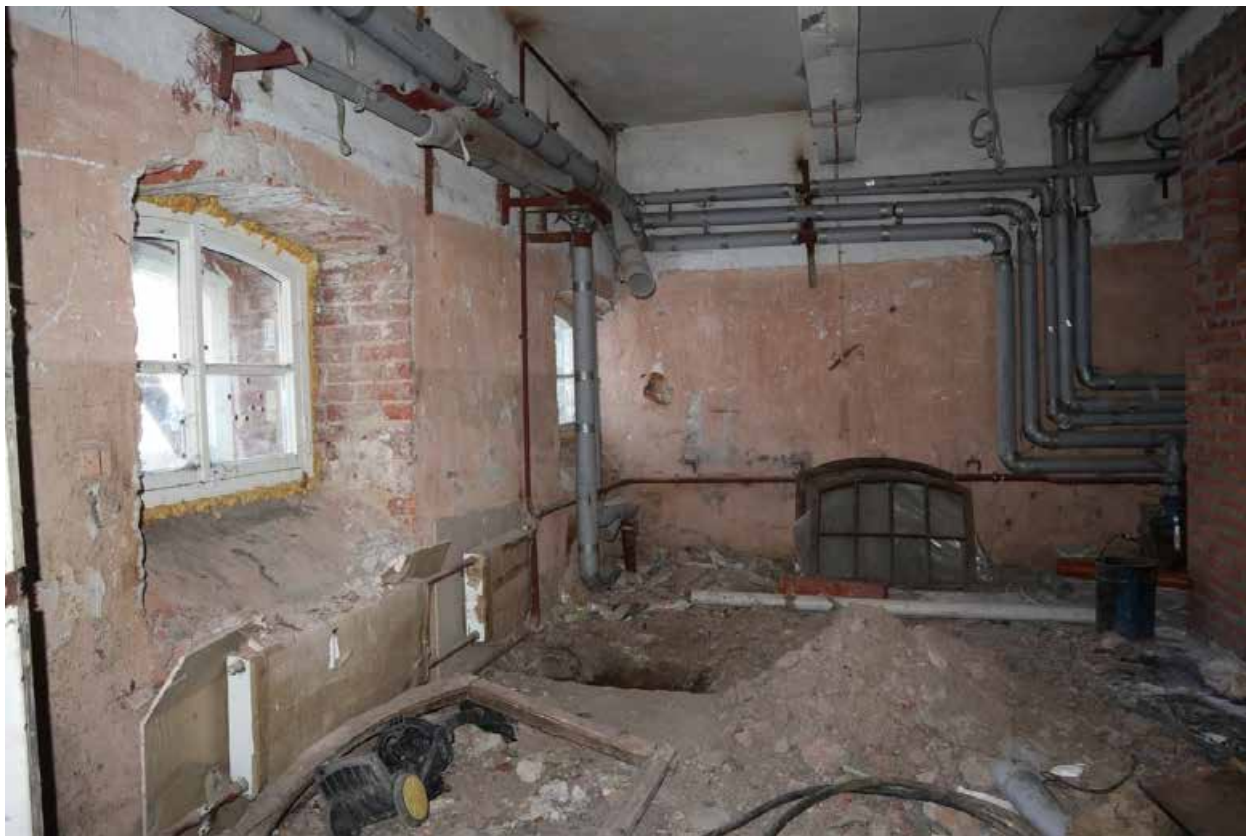
Фото п.1. Подвал, помещение 1.
