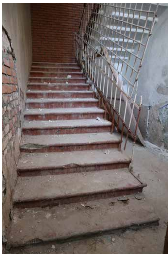
Фото 1.6. 1 этаж, лестница III.
