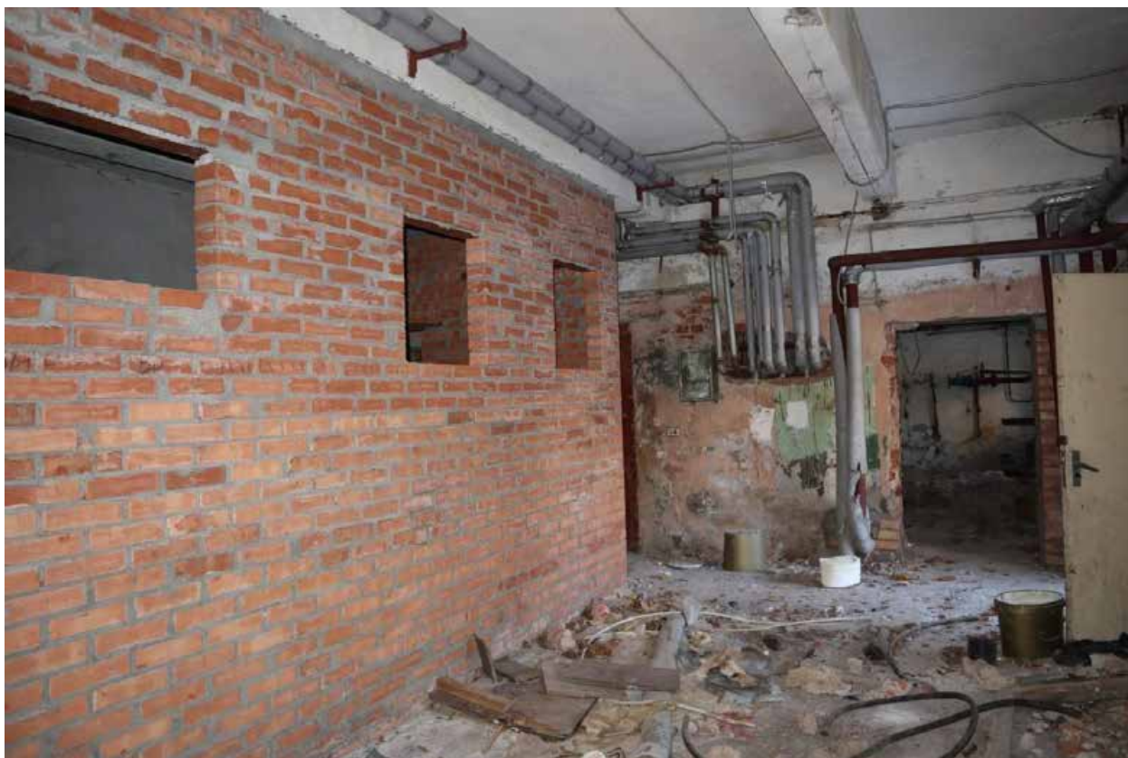
Фото п.3. Подвал, помещение 1.
