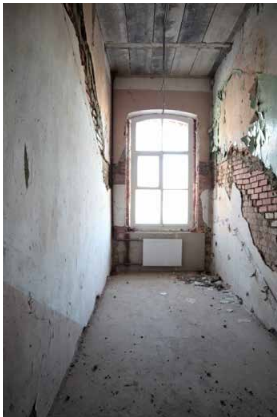
Фото 2.21. 2 этаж, лестничная клетка лестницы I*.
