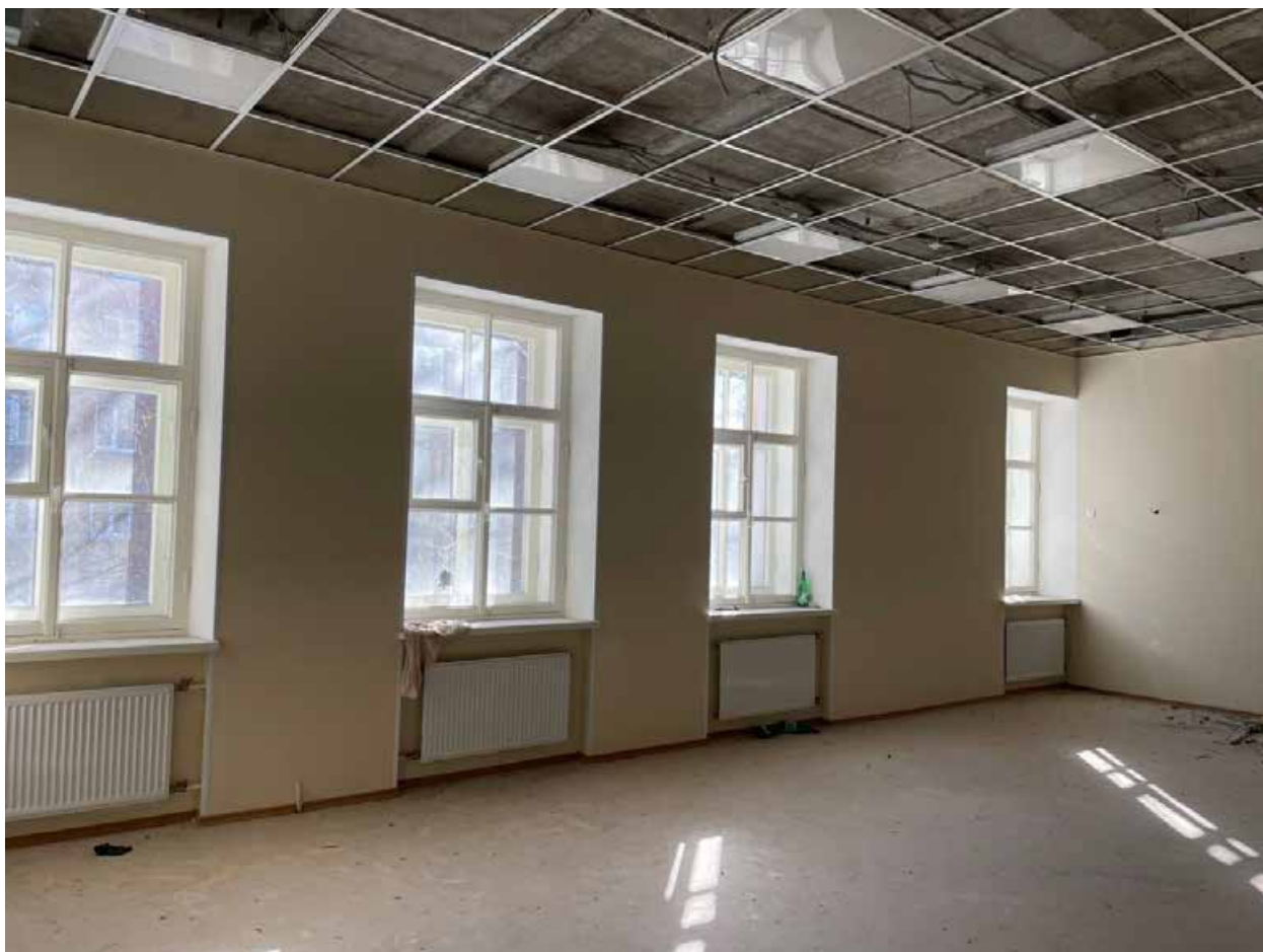
Фото 2.15. 2 этаж. Помещения по восточному фасаду.
