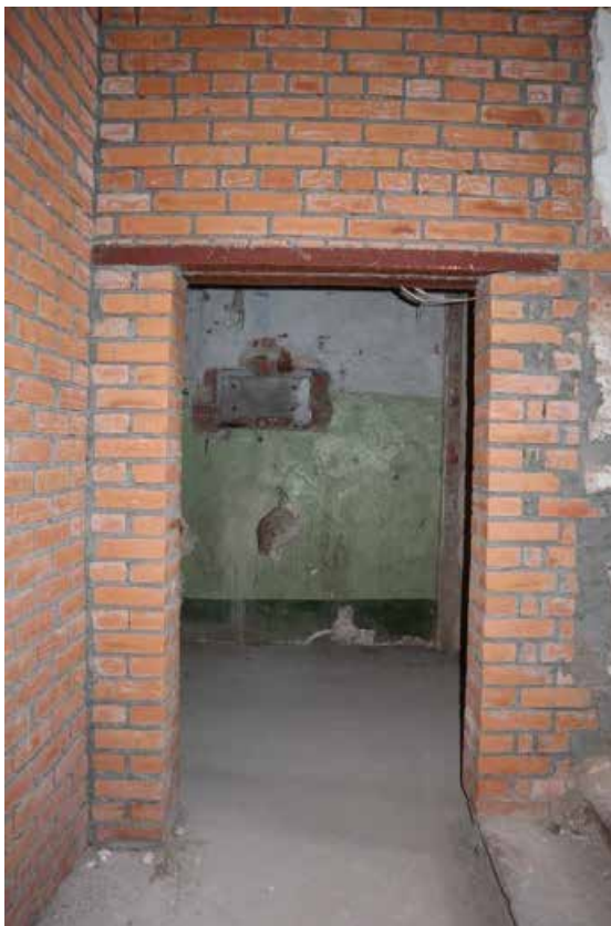
Фото 1.3. 1 этаж, лестничная площадка, лестница III.
