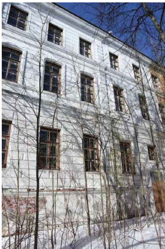
Фото 7. Юго-восточный фасад здания. Фрагмент.
