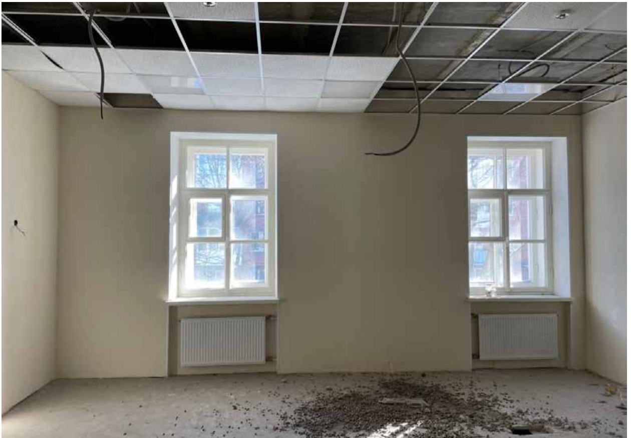
Фото 2.11. 2 этаж. Помещения по восточному фасаду.
