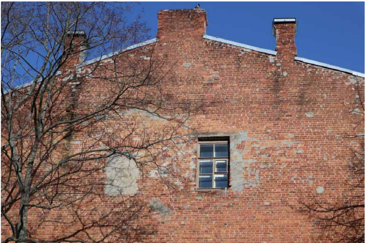
Фото 16. Юго-западный (торцевой) фасад. Фрагмент.
