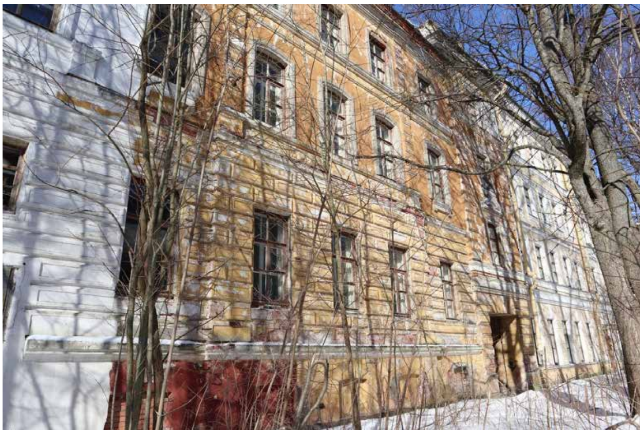
Фото 5. Юго-восточный фасад здания. Фрагмент.
