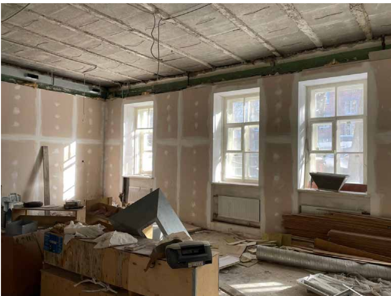
Фото 1.12. 1 этаж. Помещение по восточному фасаду.
