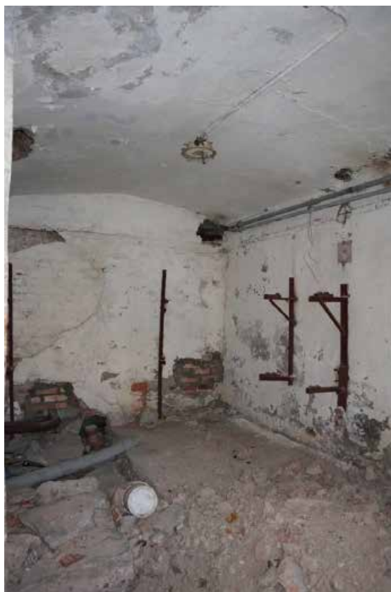
Фото п.9. Подвал, помещение 2.
