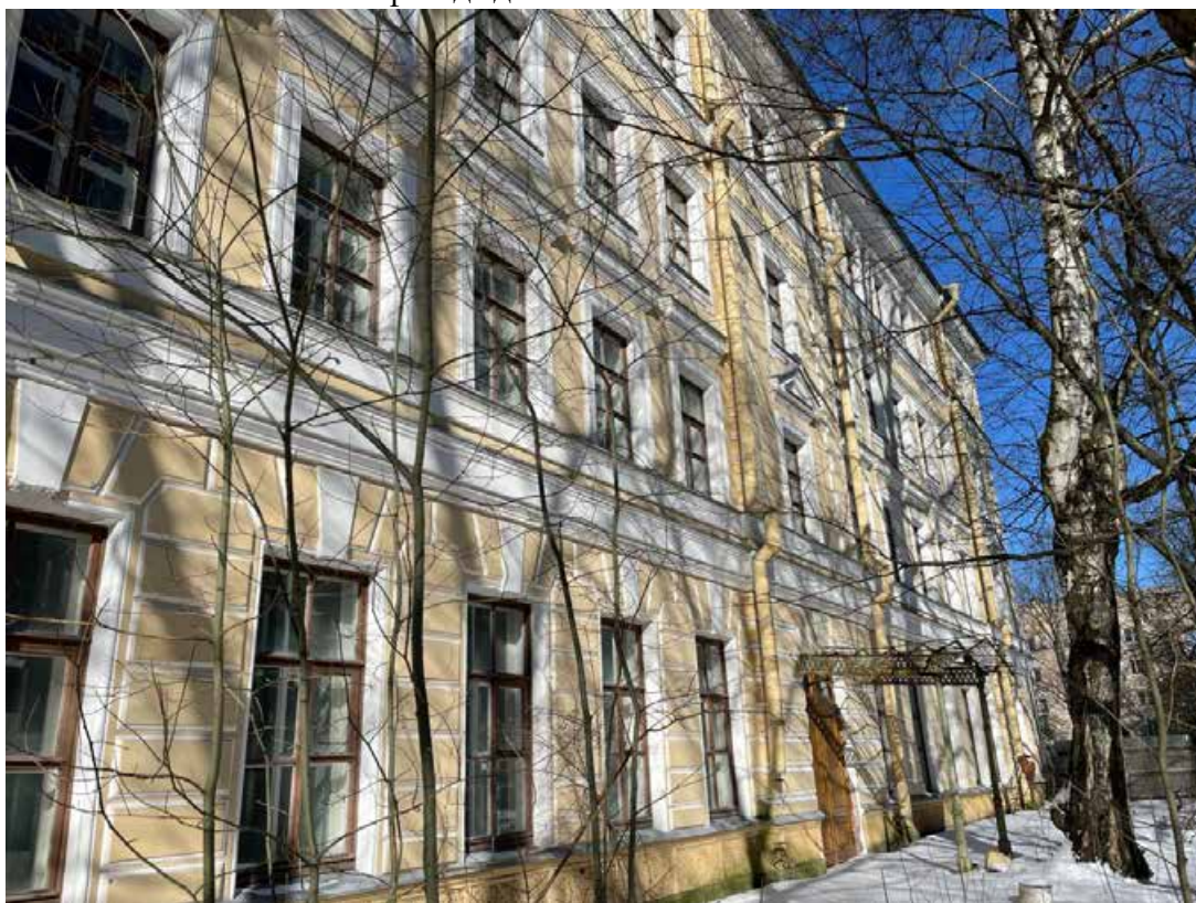
Фото 2. Юго-восточный фасад здания. Фрагмент.
