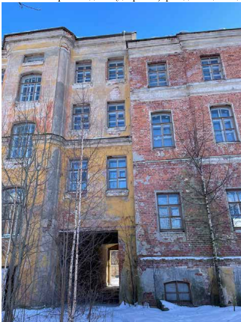
Фото 10. Место соединения двух зданий. Вид со стороны двора.
