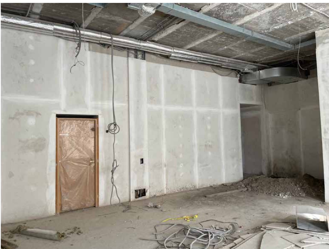
Фото 1.17. 1 этаж. Помещения по восточному фасаду.
