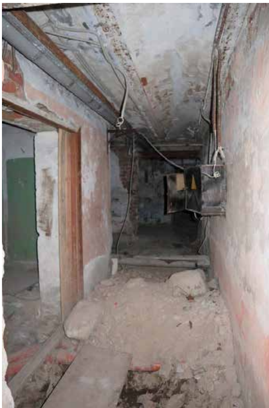
Фото п.5. Подвал, помещение 4.
