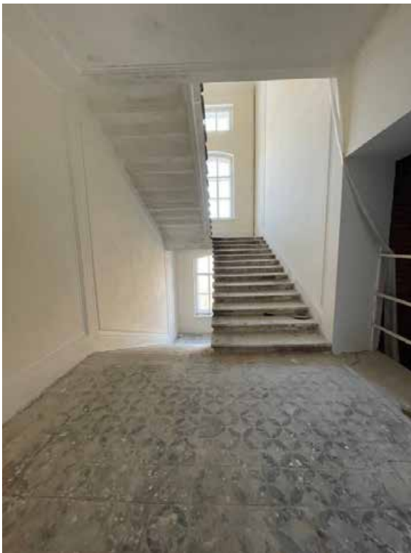
Фото 3.10. Площадка 3 этажа центральной лестницы.
