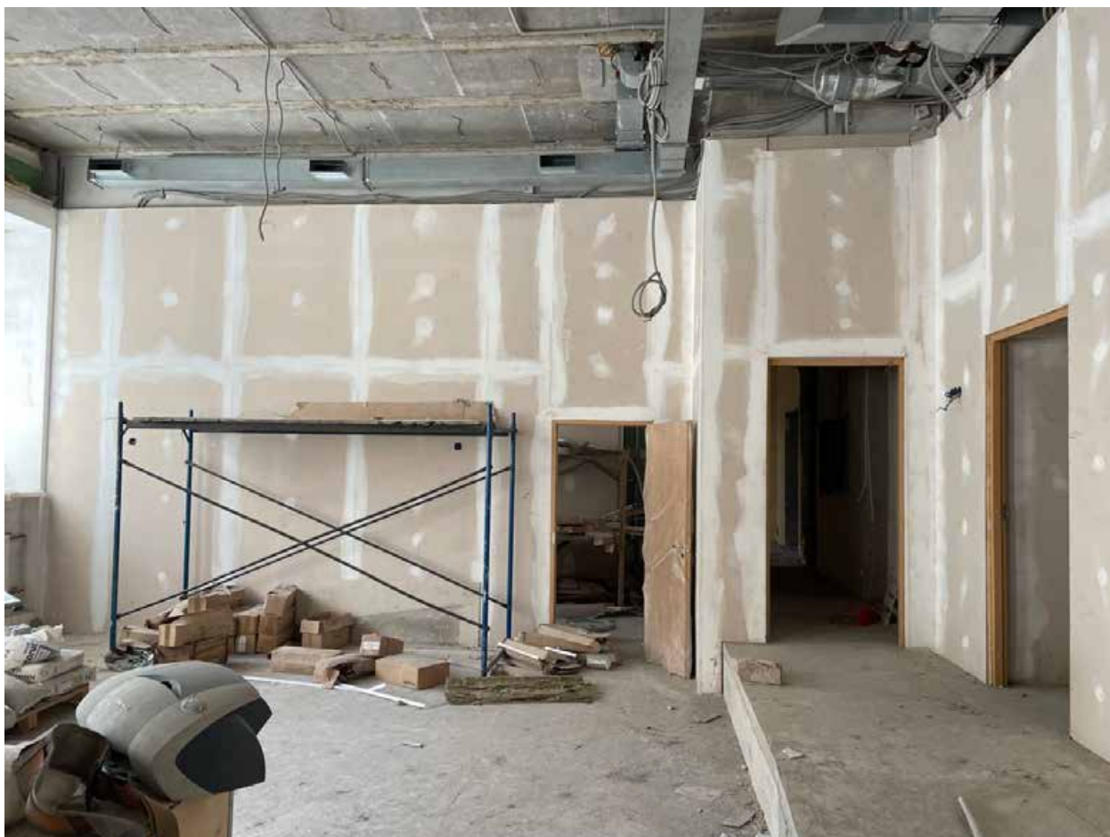
Фото 1.13. 1 этаж. Помещение по восточному фасаду
