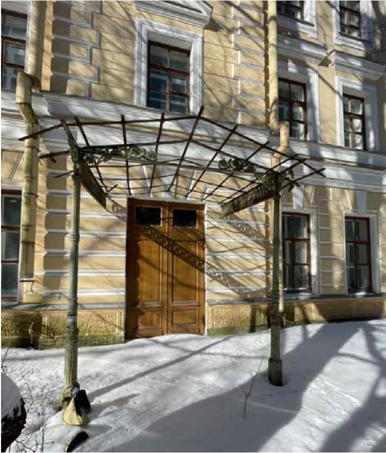
Фото 5. Навес над главным входом. Юго-восточный фасад.
