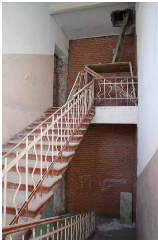
Фото 3.3. 3 этаж, лестница II.
