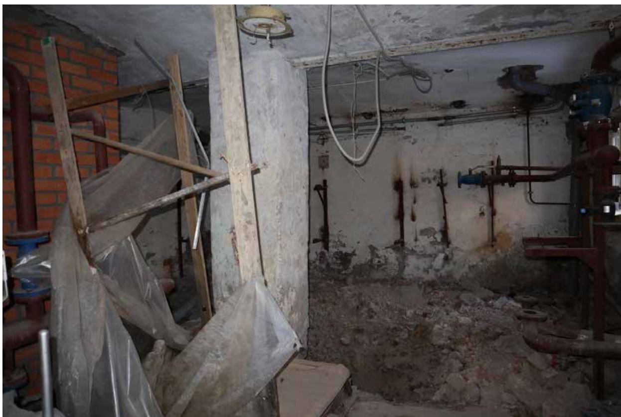
Фото п.8. Подвал, помещение 2.
