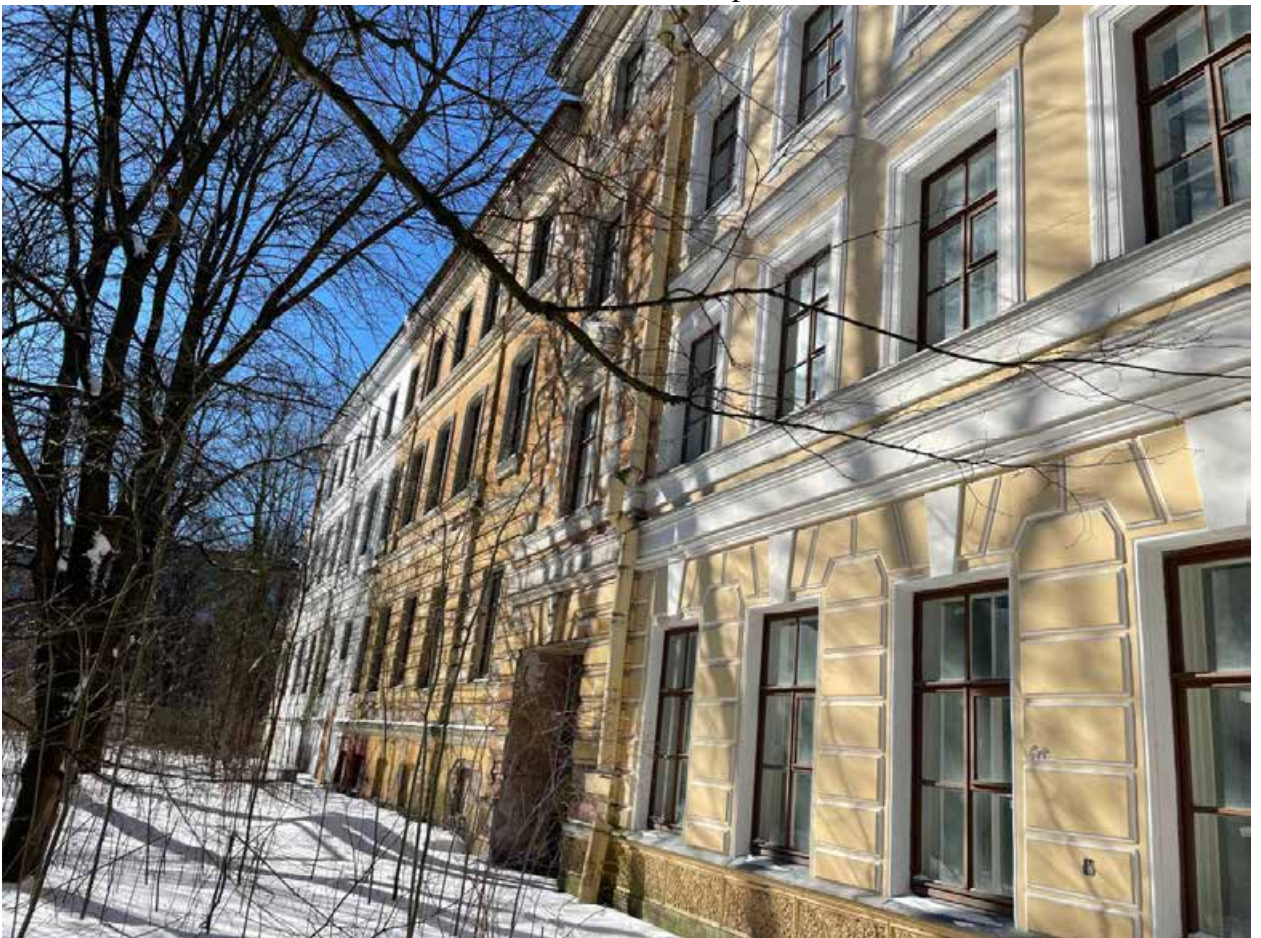
Фото 6. Юго-восточный фасад здания. Фрагмент
