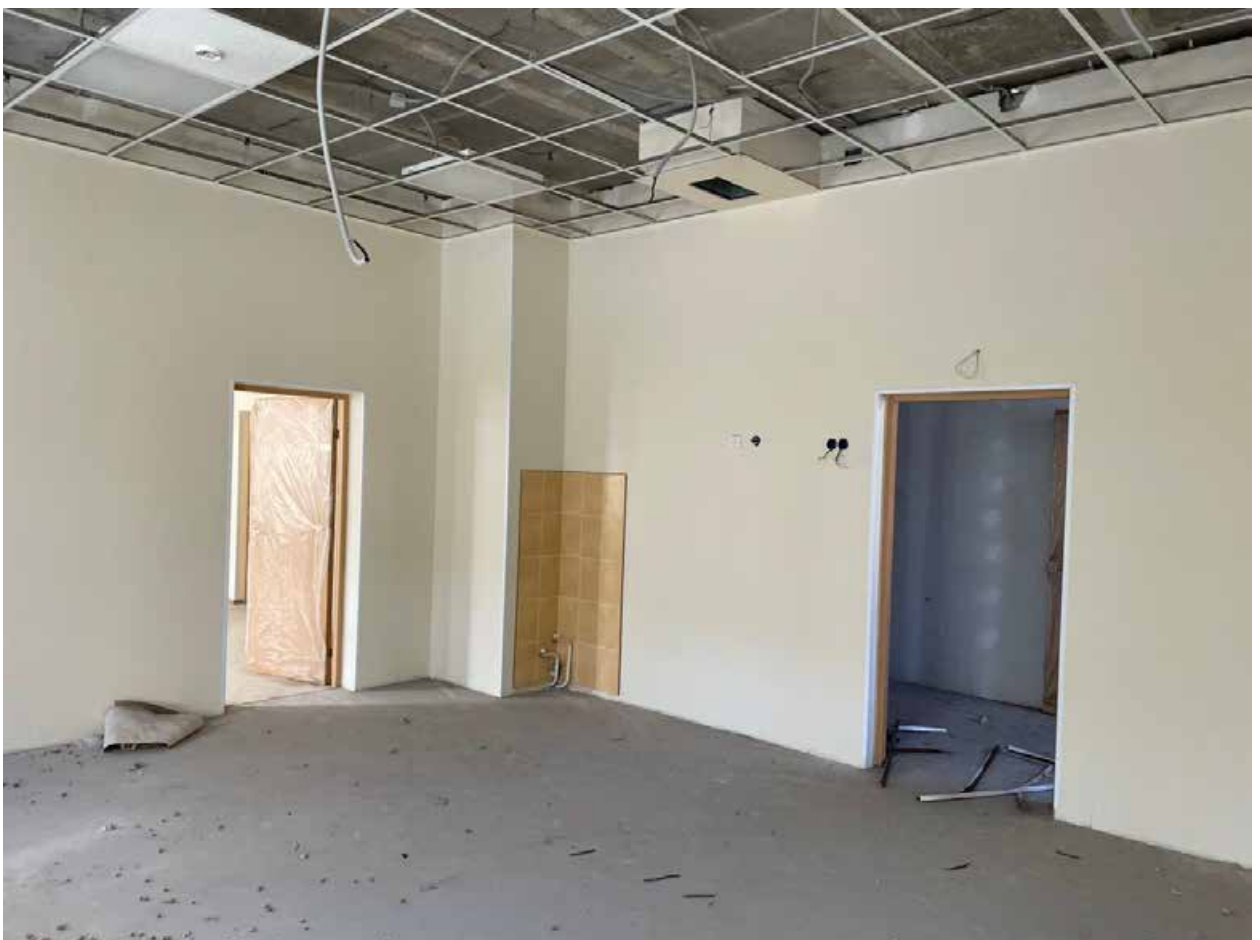
Фото 2.12. 2 этаж. Помещения по восточному фасаду.
