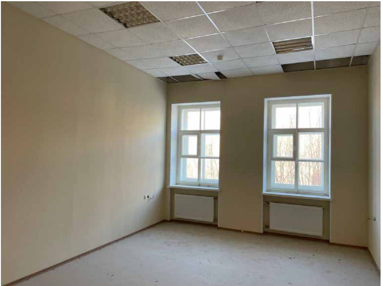
Фото 2.8. 2 этаж. Помещение по западному фасаду.
