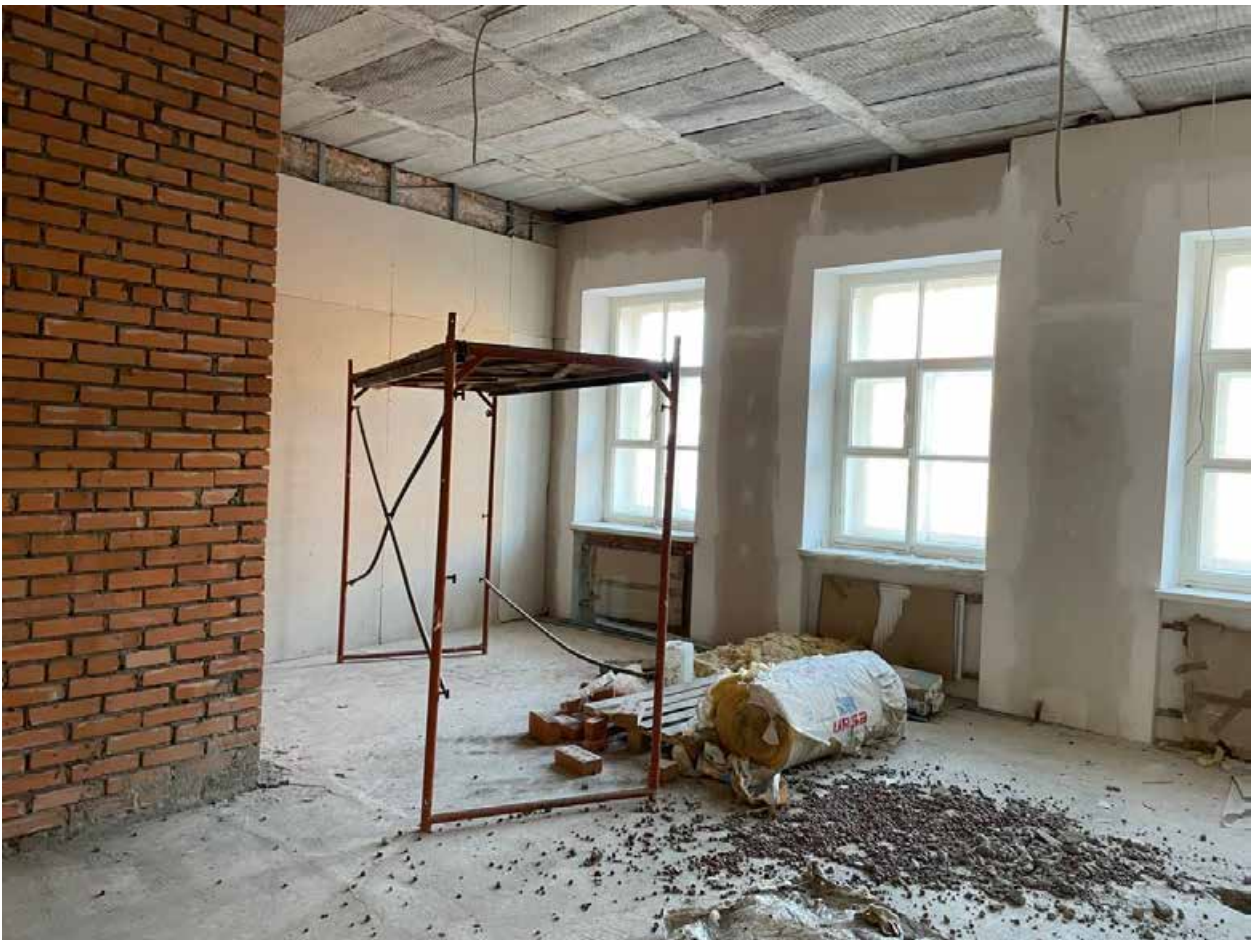
Фото 2.7. 2 этаж. Помещение по западному фасаду.
