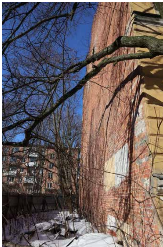
Фото 8. Юго-западный (торцевой) фасад. Фрагмент.
