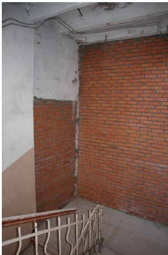
Фото 1.2. 1 этаж, лестничная площадка, лестница III.
