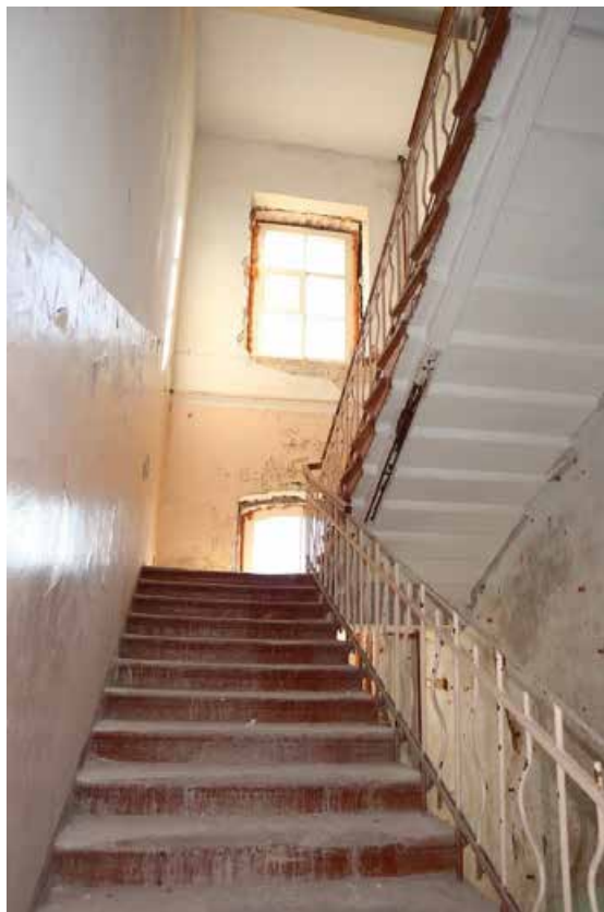
Фото 3.1. 3 этаж, лестница II.
