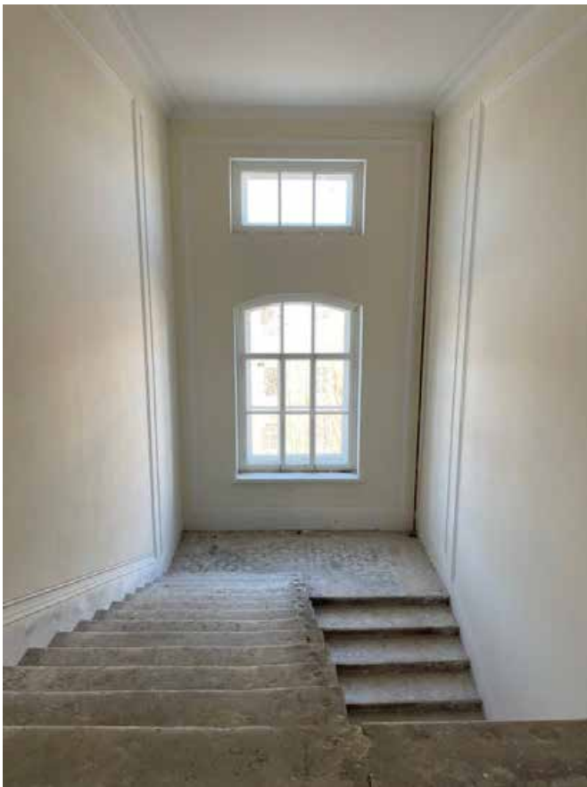
Фото 4.1. Центральная лестница. 4 этаж.
