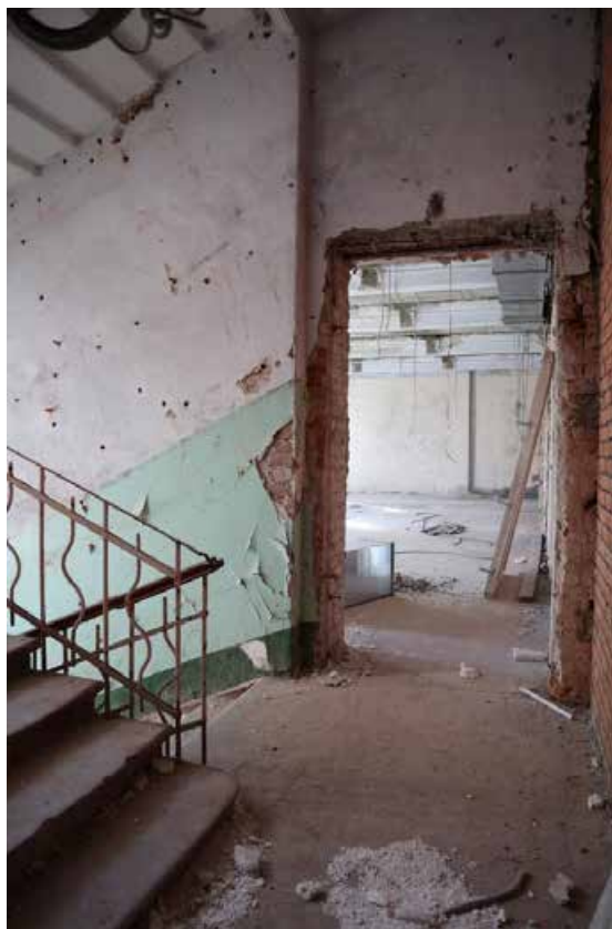
Фото 2.26. 2 этаж, лестничная площадка, лестница II.
