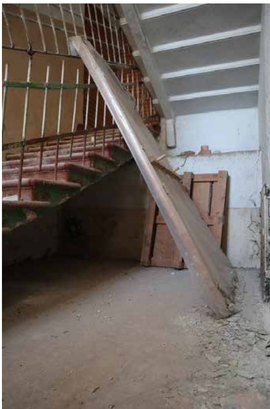
Фото 1.4. 1 этаж, лестница III.
