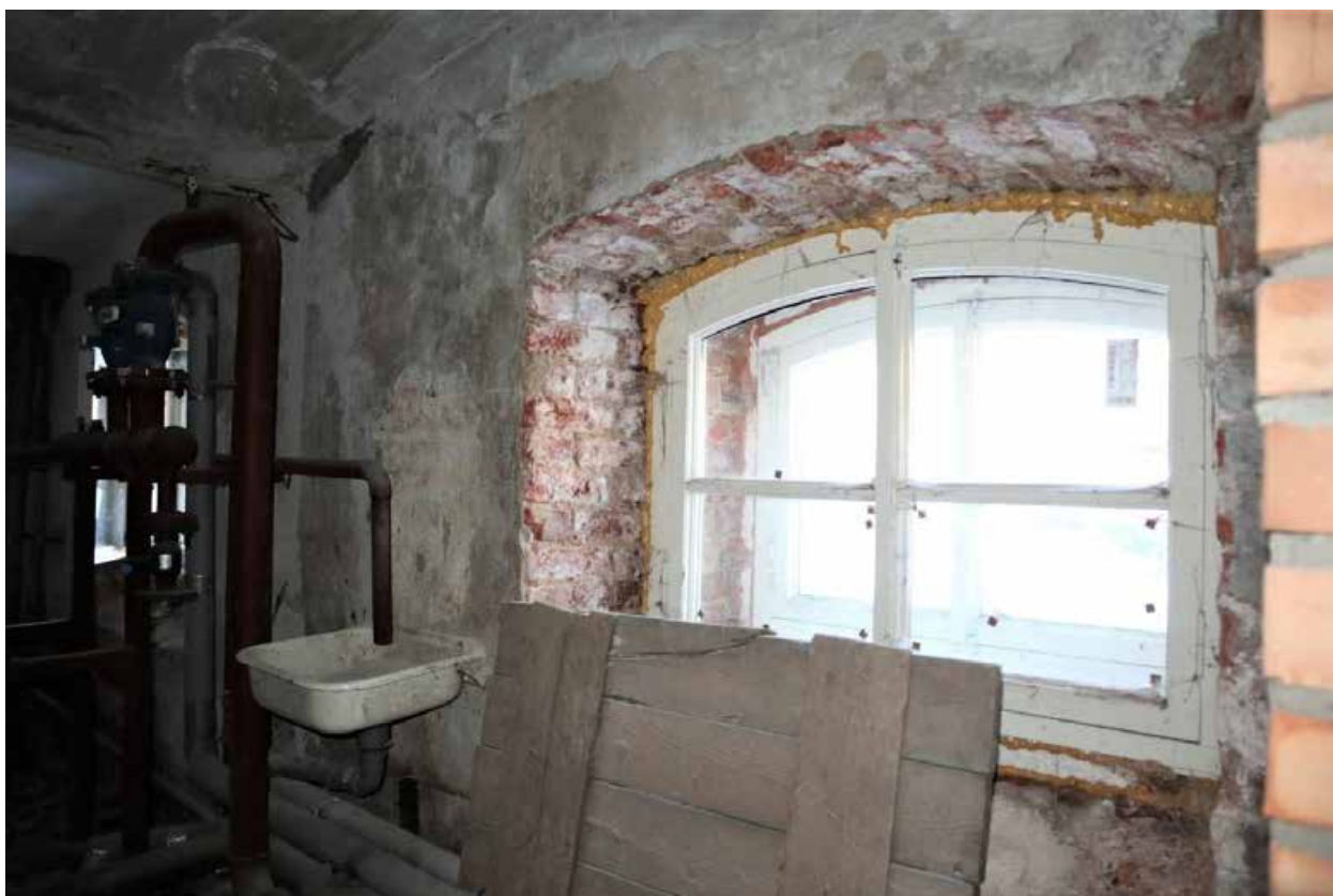
Фото п.10. Подвал, помещение 2.
