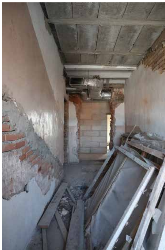
Фото 3.25. 3 этаж, лестничная клетка лестницы I*.
