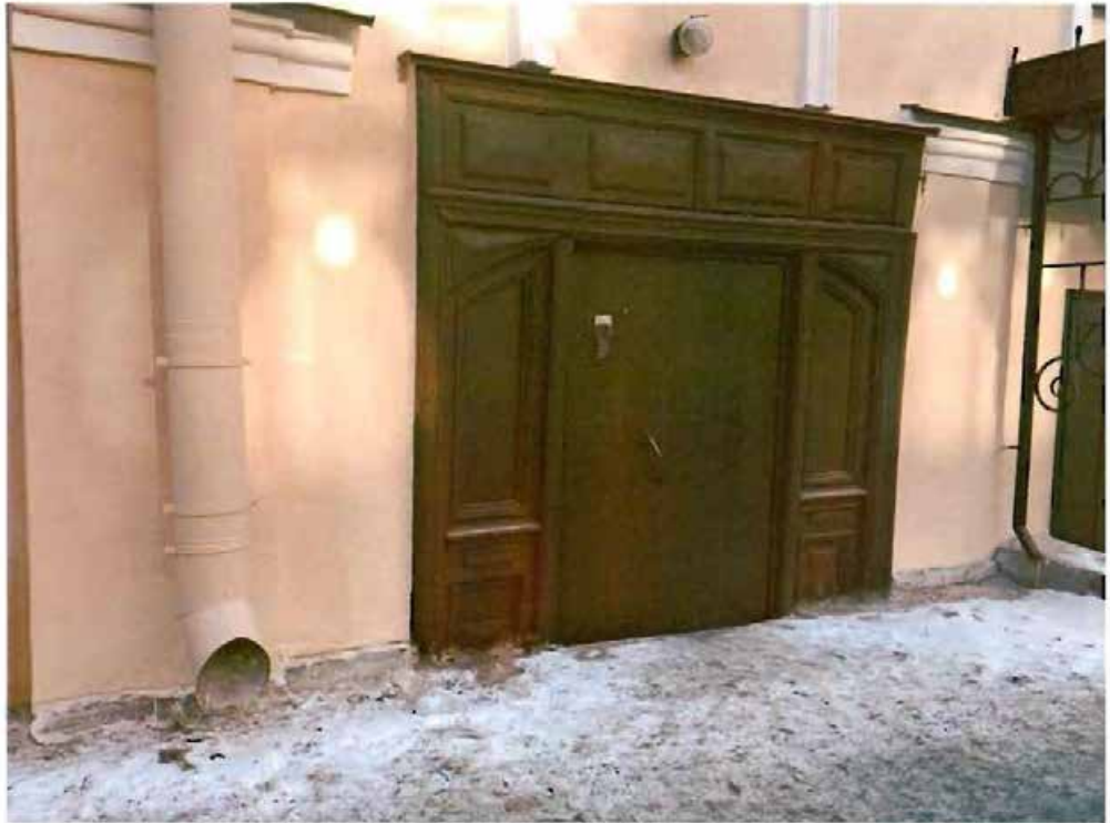
4. Дверной проем по крайней восточной оси.
