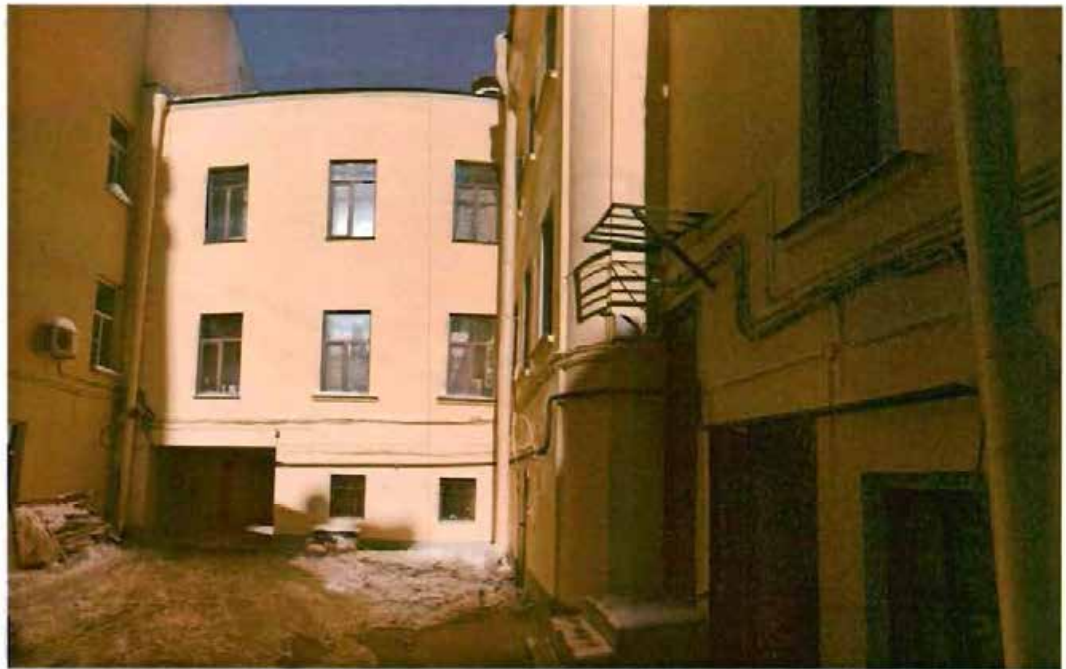
2. Дворовый фасад. Общий вид.
